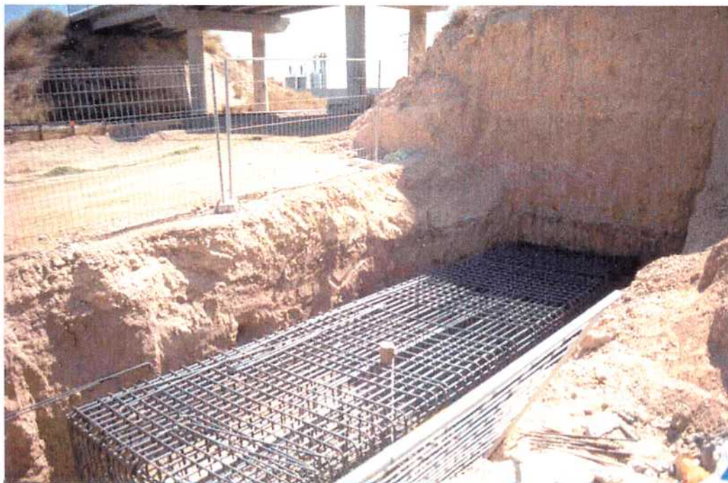
07/09/01 Ferrallado y encofrado de una de las zapatas de apoyo para las pilas del paso superior.
