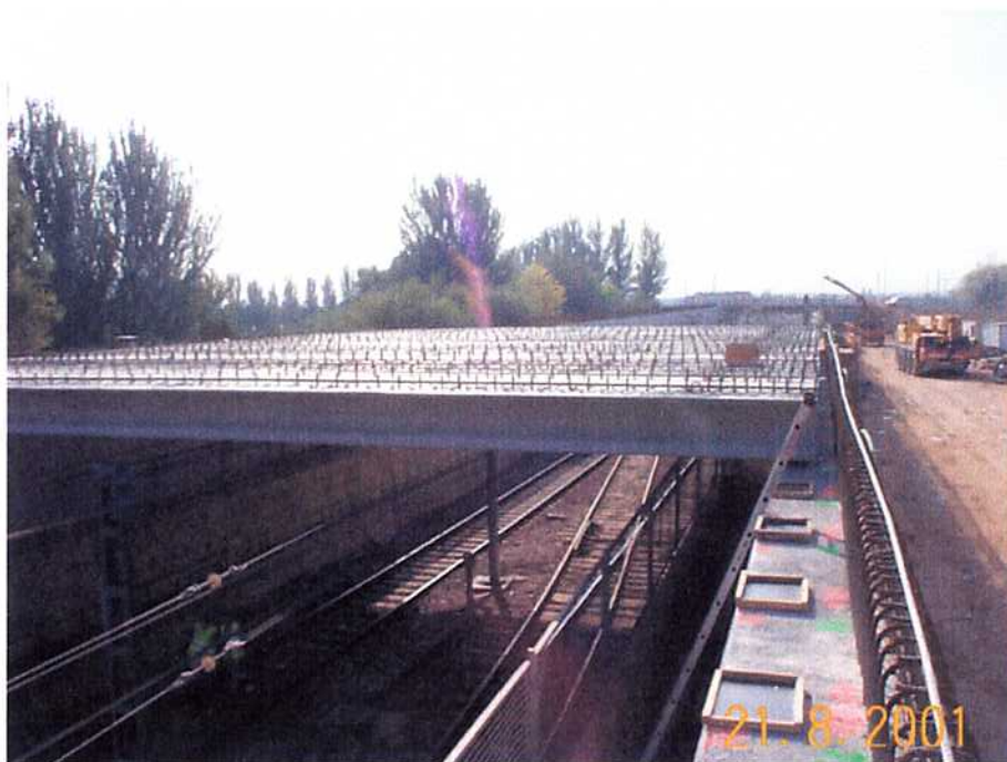
21/08/01 Colocación de las primeras vigas prefabricadas.
