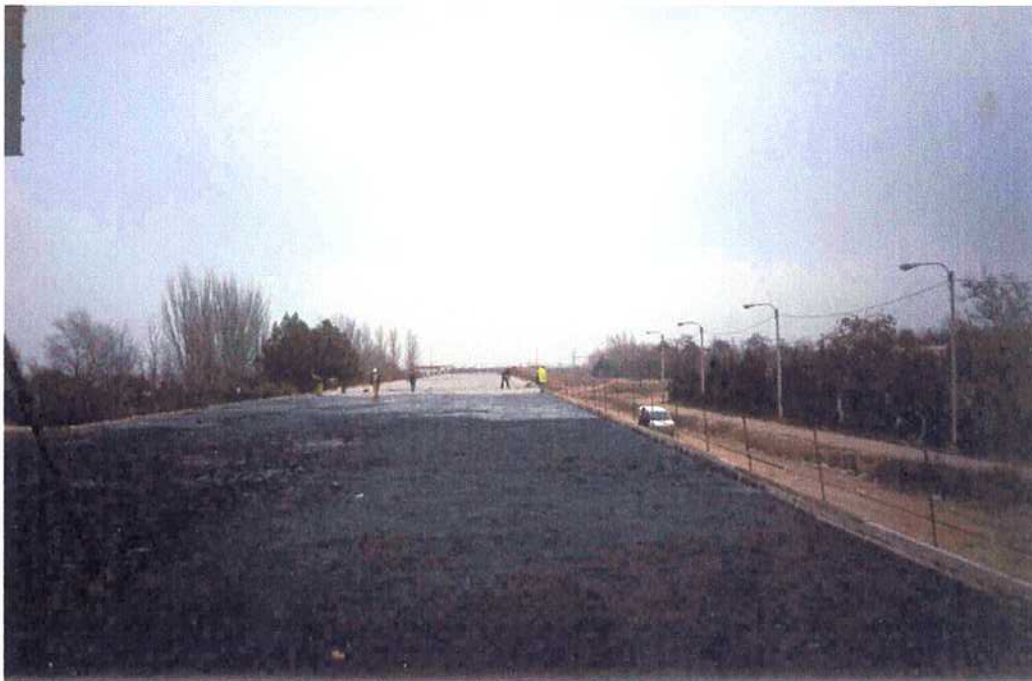
09/01/02 Avance de las labores de imprimación del falso túnel.
