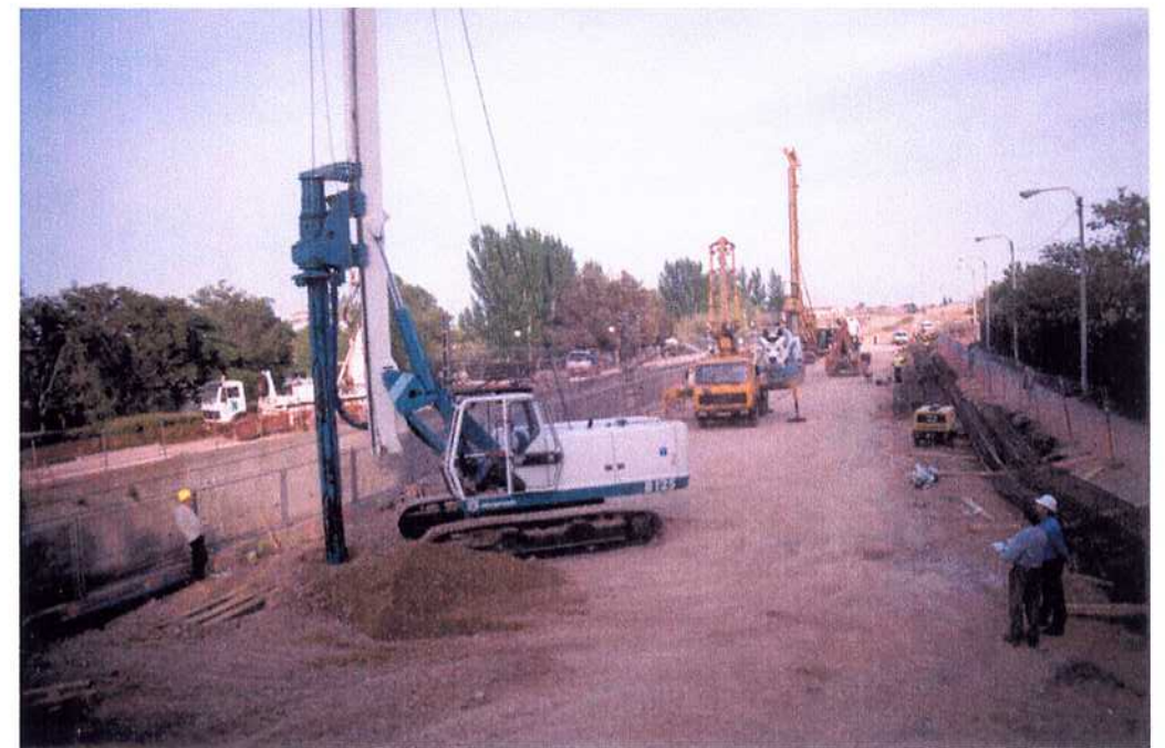
02/05/01 Perforación de pilotes en margen derecha e inicio en margen izquierda. Véanse, en primer plano, las tuberías para ensayo sónico dejadas en pilotes ya hormigonados.
