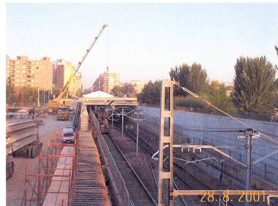
28/08/01 Colocación de vigas y modificación de catenaria (vistas desde Paso de Caballos).
