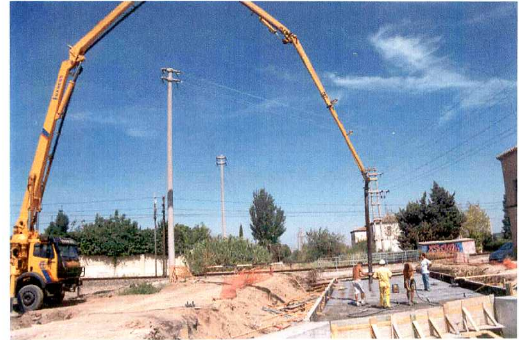
06/08/01 Detalle del hormigonado del tablero del paso inferior del escuradero mediante bomba.
