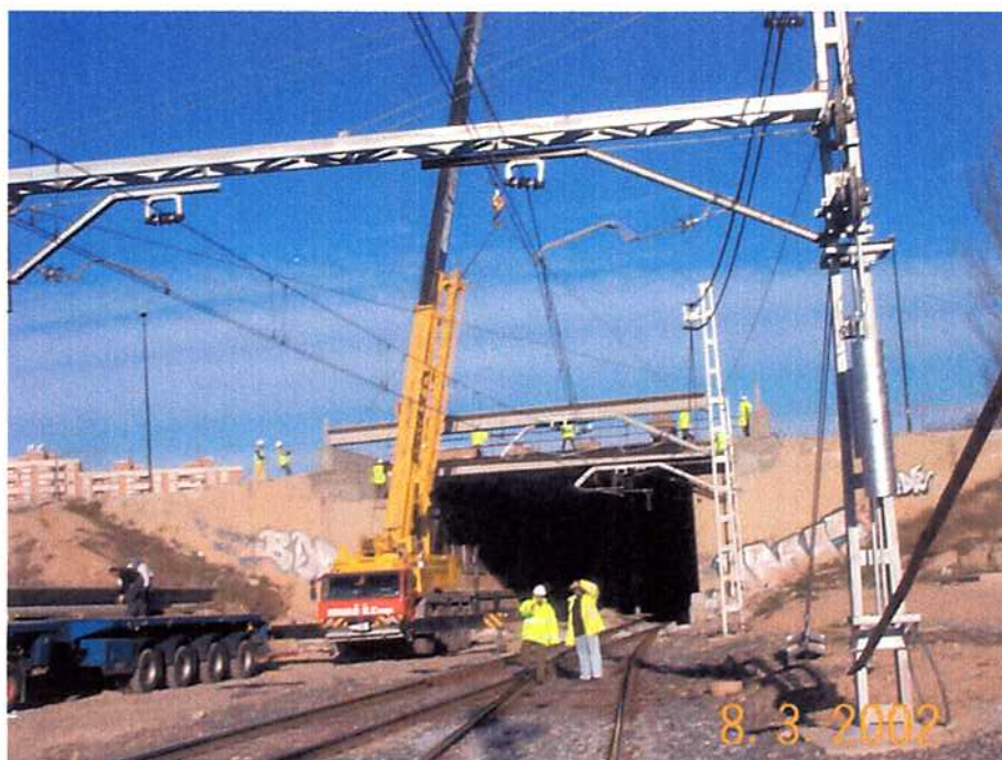
08/03/02 Paso de Cabaldos. Colocación de las nuevas vigas.
