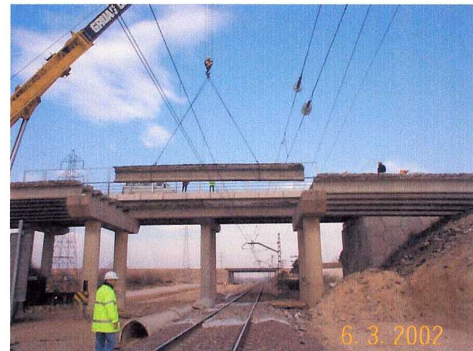
06/03/02 Retirada de las vigas del antiguo paso
