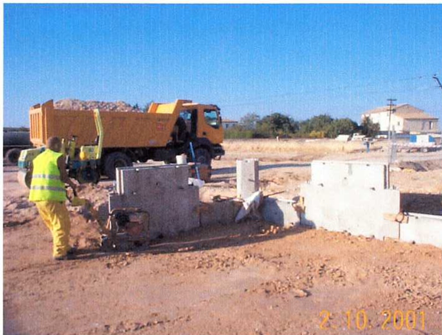
02/10/01 Compactación, con pistón de bandeja, en el contacto suelo seleccionado-escama de hormigón.
