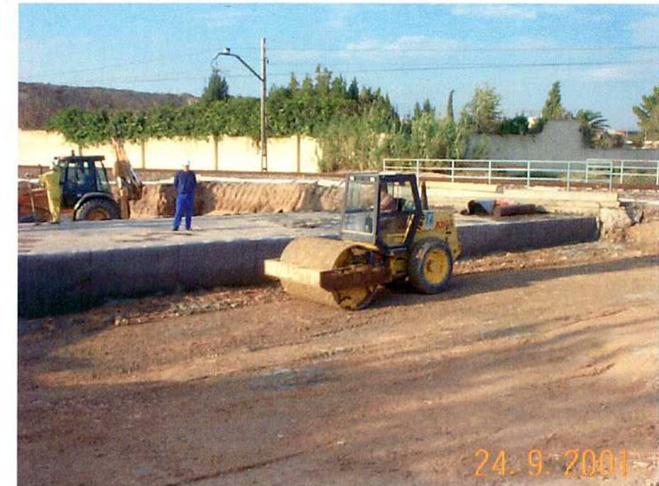
4/09/01 Compactación de la tongada de la cuña de transición.
