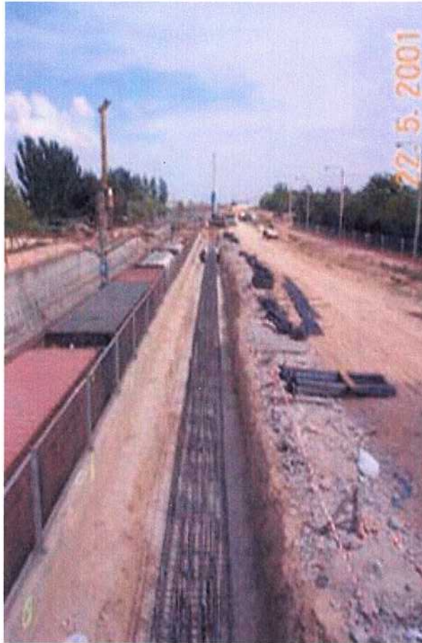
22/05/01 Ferrallado de la viga 1.
