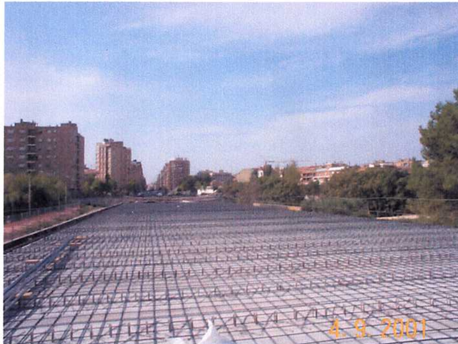
04/09/01 Armado de la losa de compresión nº 3.
