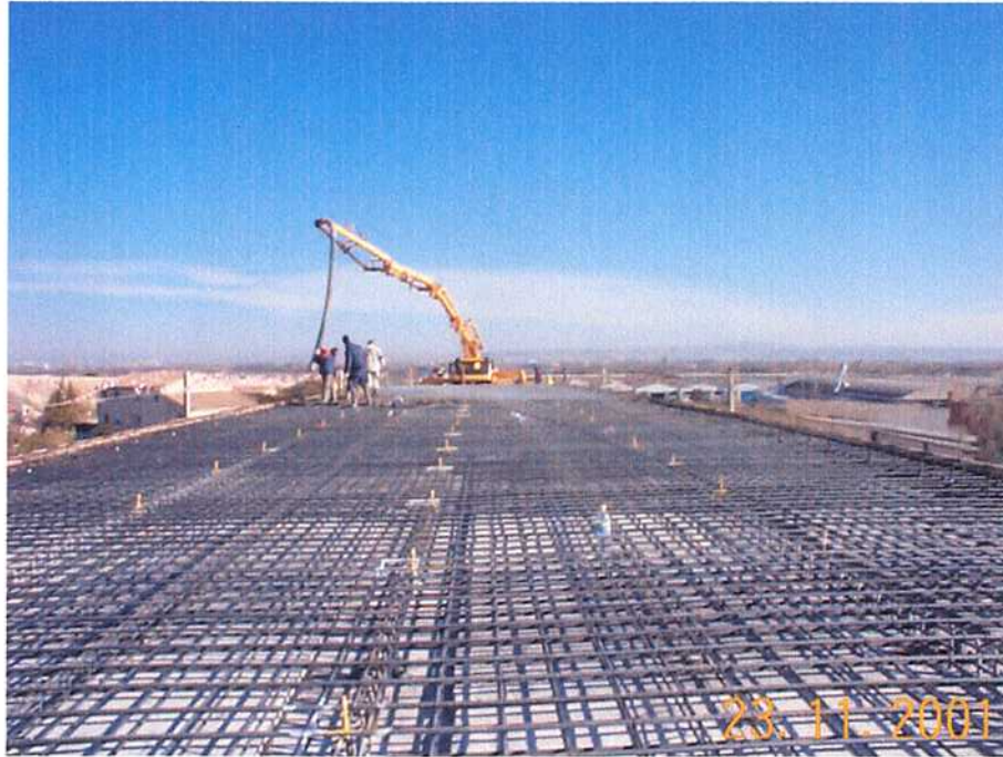
23/11/01 Hormigonado del tablero con bomba.
