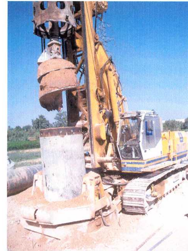
03/08/01 Detalle de perforación del pilote 1, en el lado más alejado de la vía..
