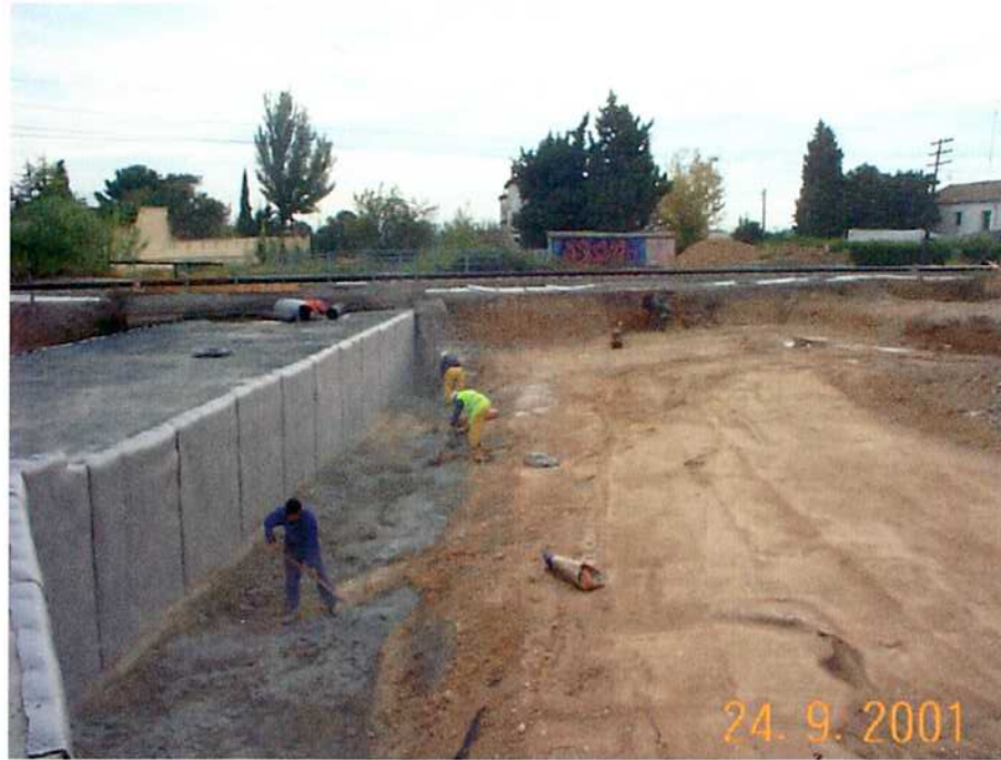
21/09/01 Proceso de puesta en obra de las cuñas de transición suelo-cemento. Extendido de cemento en solera.
