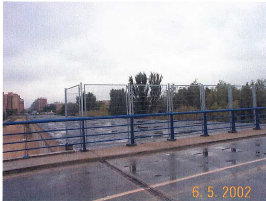
06/05/02 Final del falso túnel y entronque con el paso superior de Cabaldos.
