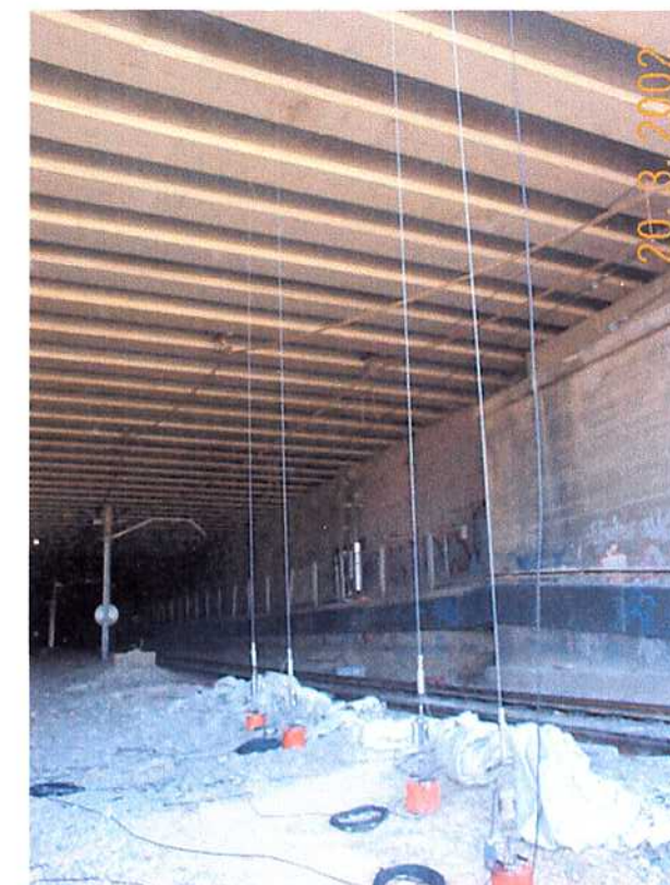
20/03/02 Paso superior de Cabaldos. Células de medición para una prueba de carga.
