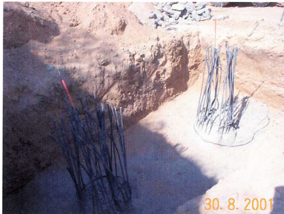
30/08/01 Pilotes ya descabezados.
