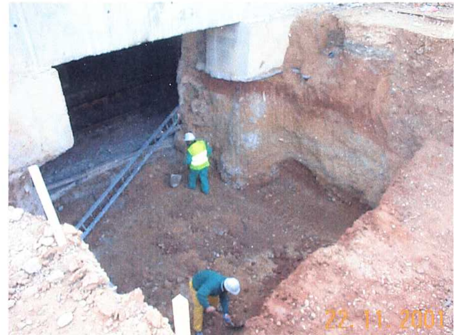
22/11/01 Refinado manual de la cimentación para la solera de la salida de emergencia.
