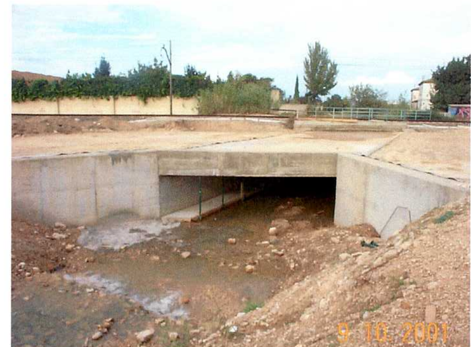
09/10/01 Vista de la acera recientemente construida en el paso inferior.
