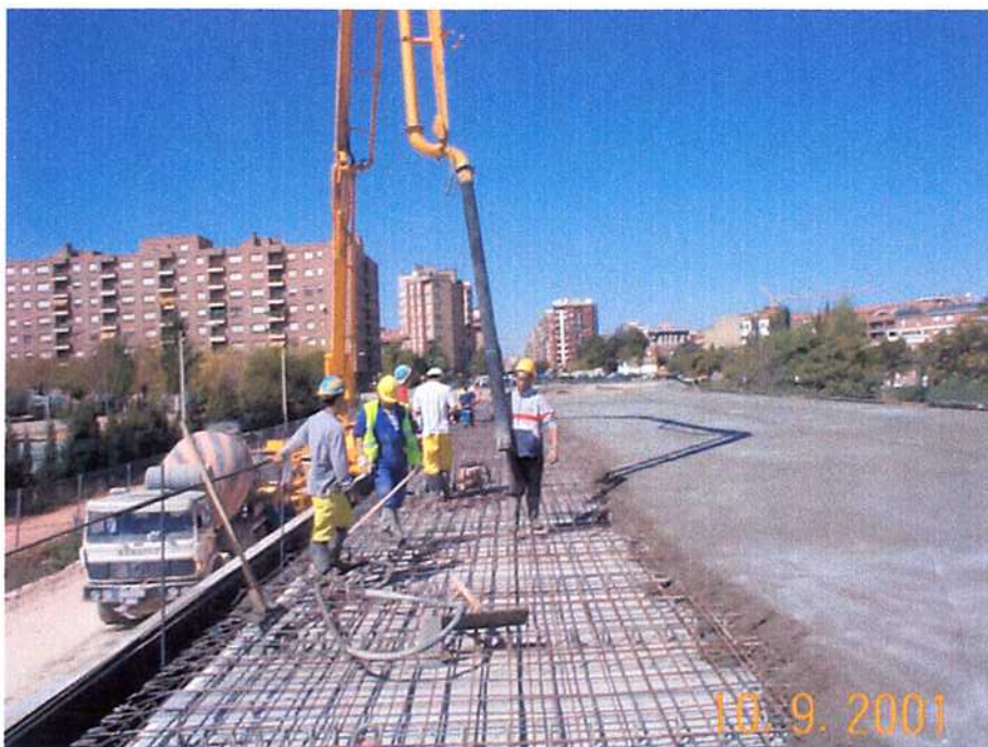
10/09/01 Detalles del hormigonado de la losa nº 3.
