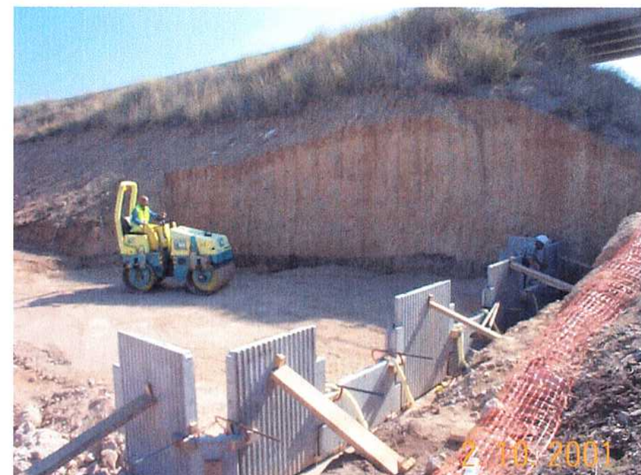
02/10/01 Compactación de tongada de tierra armada.
