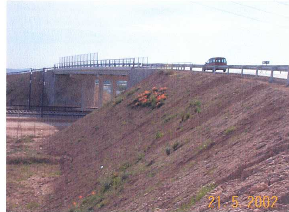
21/05/02 Detalle de paso superior de san Antonio ya finalizado y de los taludes hidrosembrados ya floreciendo
