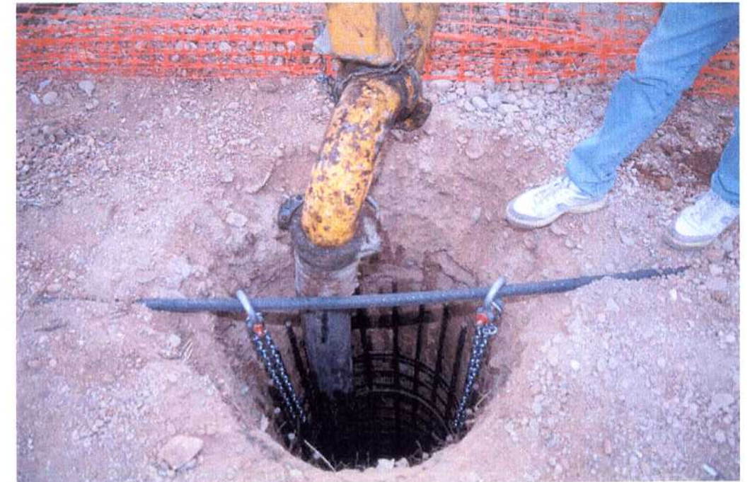
06/04/01 Detalle de armadura colocada en pilote y tubería para hormigonado mediante bomba.
