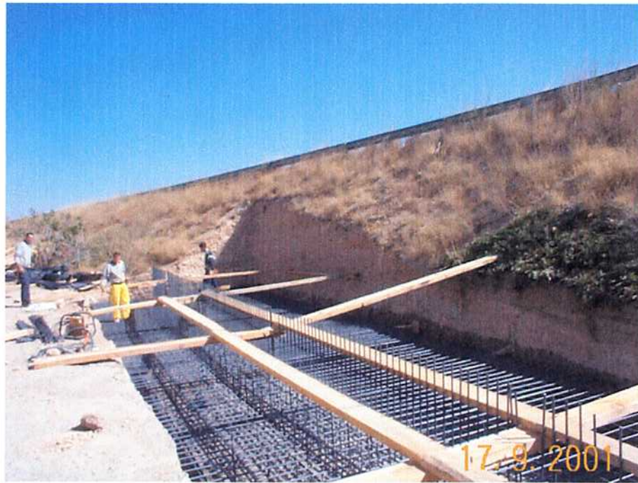
17/09/01 Armado de la zapata del muro de contención.
