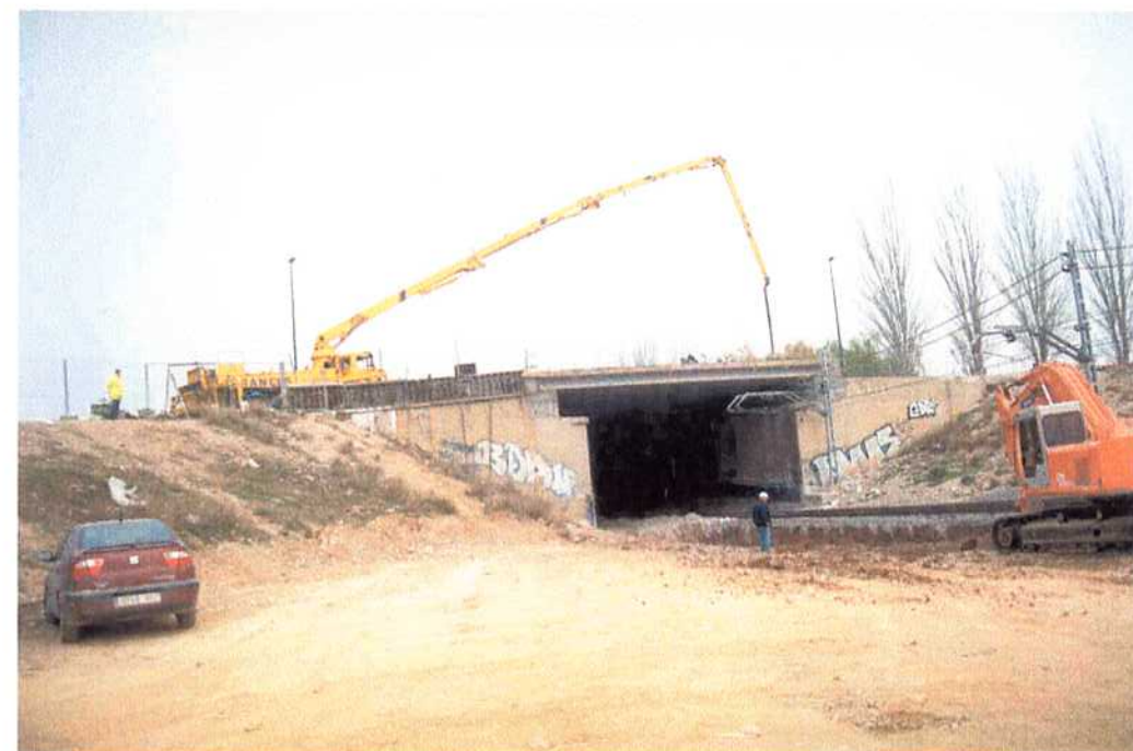
12/03/02 Hormigonado del tablero del paso superior de Cabaldos e inicio de la excavación de los saneos en pk 0+300
