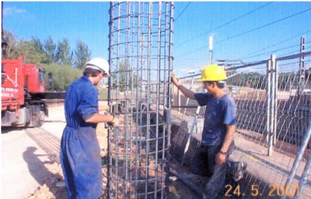
22/05/01 Ferrallado de la viga 1.
