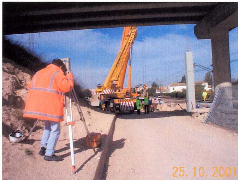
25/10/01 Comprobación topográfica de la verticalidad de los elementos prefabricados colocados.
