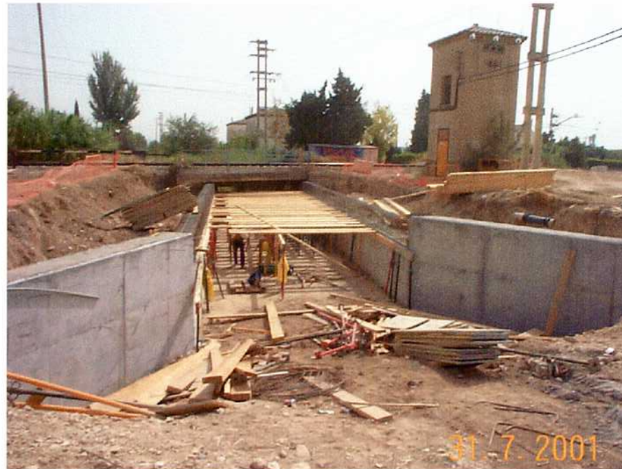
31/07/01 Montaje del forjado superior del paso.
