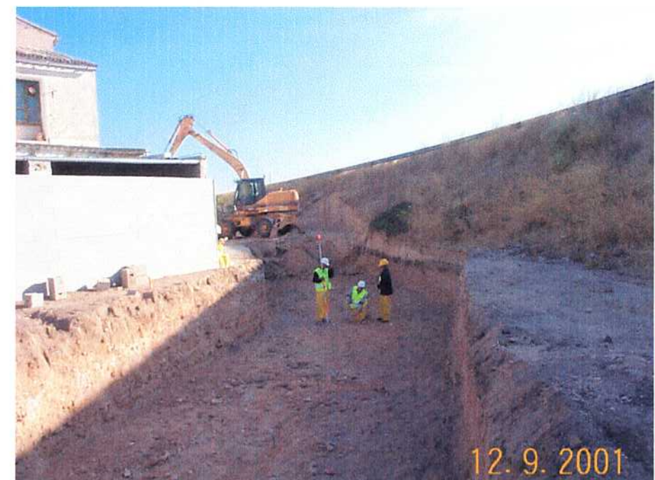
12/09/01 Excavación para muro de contención.
