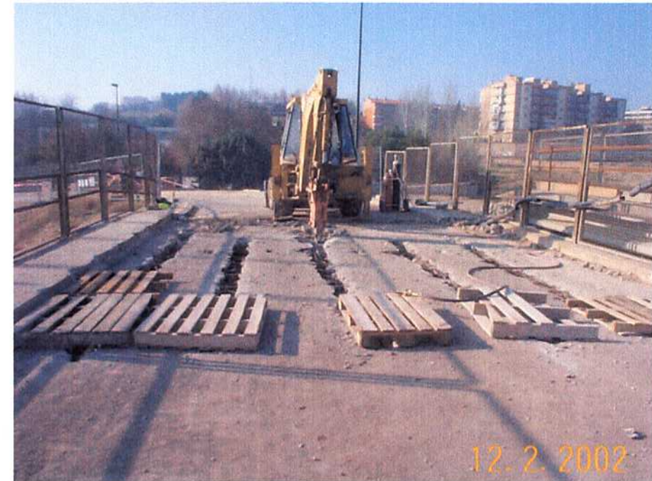
12/02/02 Paso superior de Cabaldos. Demolición del forjado superior dejando en los laterales las vigas para retirarlas en una segunda fase.
