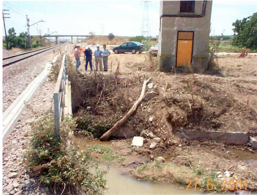
27/06/01 Pk 2+000. Escorredero de San Antonio. Detalle del cauce ya desbrozado. Véase también el edificio del transformador eléctrico a demoler.
