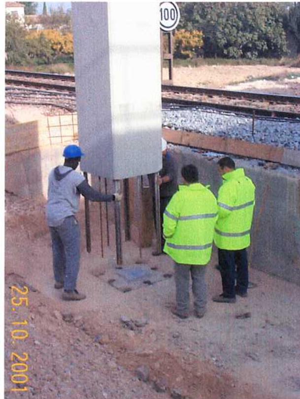
25/10/01 Colocación de la pila en las vainas.
