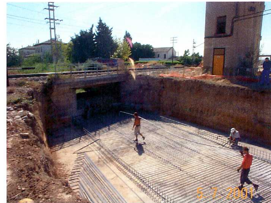
05/07/01 Ferrallado de la losa del escorredero.
