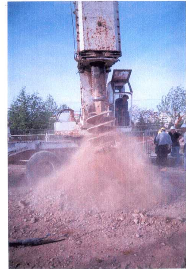
05/04/01 Detalle de la perforación y extracción de la grava arenosa existente en el sustrato del futuro falso túnel.
