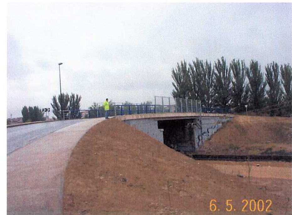
06/05/02 Paso superior de Cabaldos ya finalizado, incluso plantaciones e hidrosiembra en los taludes
