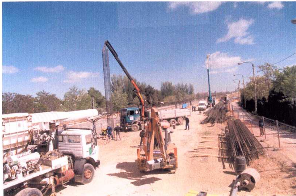
11/04/01 Colocación de la armadura en P17 V15 y hormigonado del mismo.
