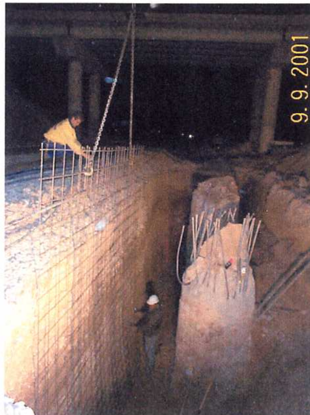
30/08/01 Pilotes ya descabezados.
