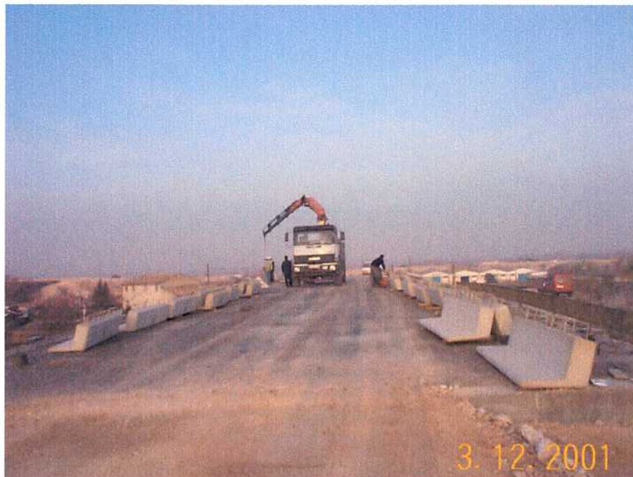
03/12/01 Montaje de las impostas en el tablero.
