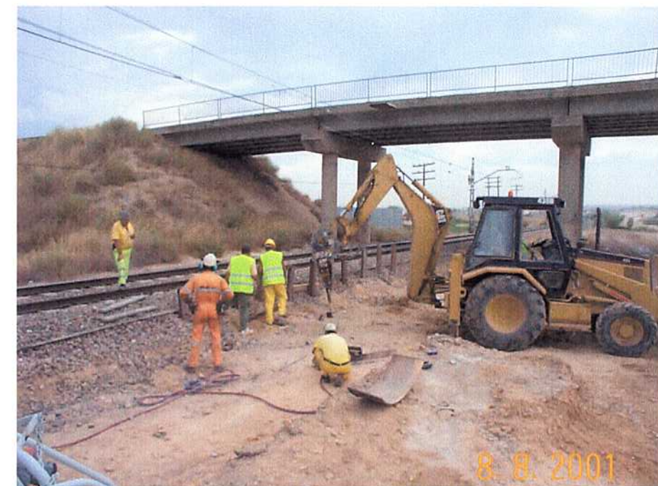
08/08/01 Colocación de la pantalla lateral en el hombro de balasto junto a los pilotes 3 y 4.
