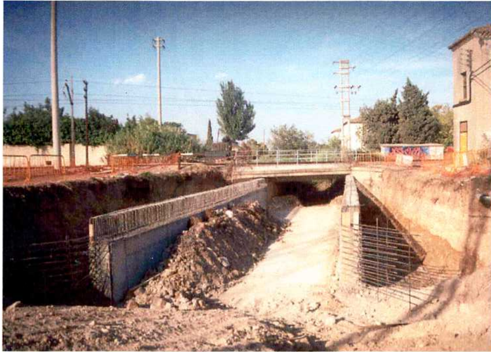
19/07/01 Muros ya hormigonados y detalle de las armaduras en las aletas de cierre.
