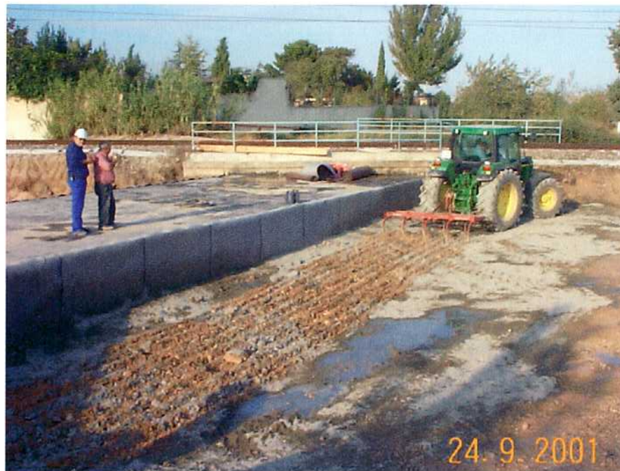
24/09/01 Mezcla del material granular con el cemento.
