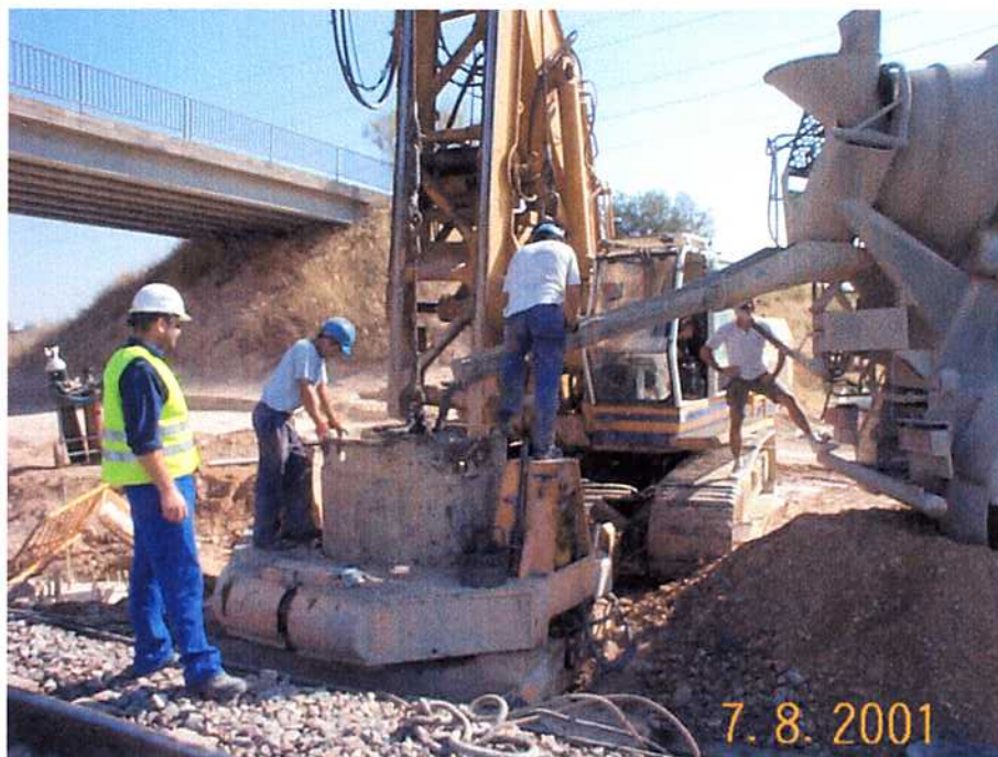
07/08/01 Pilote 4. Detalle de camisa de revestimiento y proceso de hormigonado.
