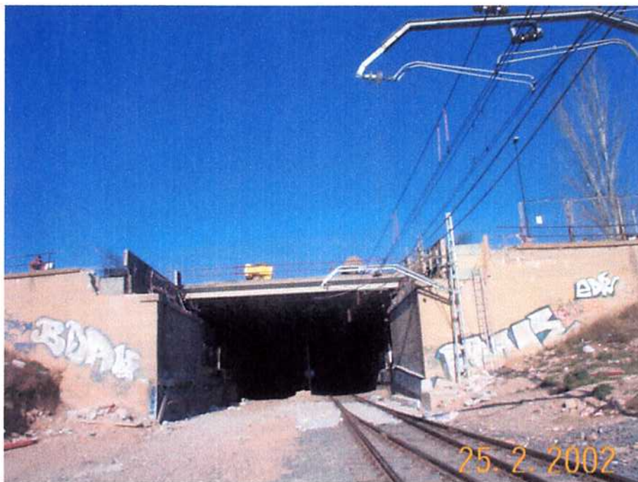
25/02/02 Paso superior de Cabaldos. Encofrado de ambos cargaderos.
