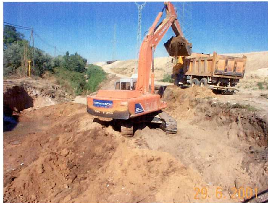
29/06/01 Excavación de la cimentación en el escorredero de San Antonio Pk 2+000.
