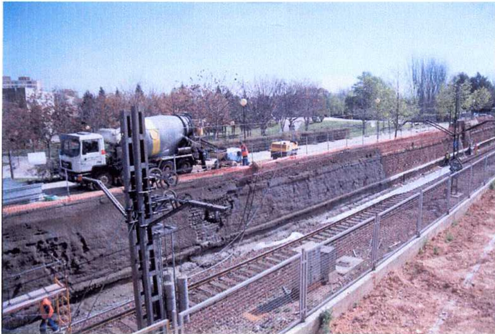
23/03/01 Perforación del mallazo en el muro de mampostería de la margen izquierda antes de su gunitado.
