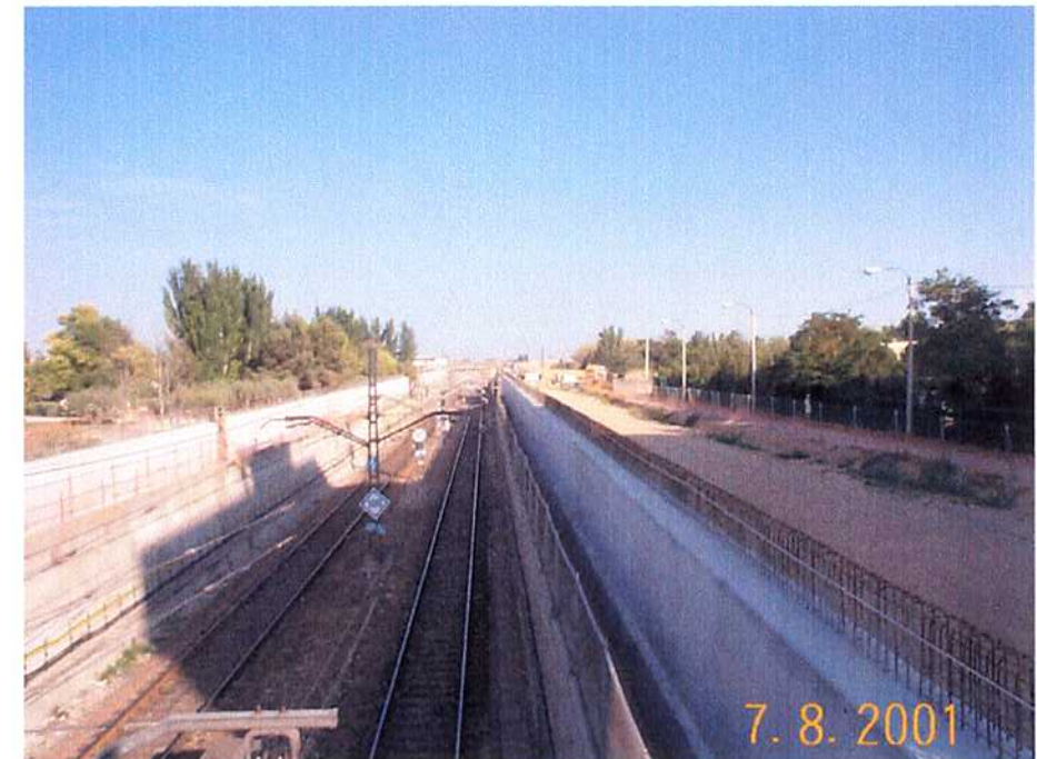
07/08/01 Vista de los muros laterales ya finalizados en los primeros 150 m.
