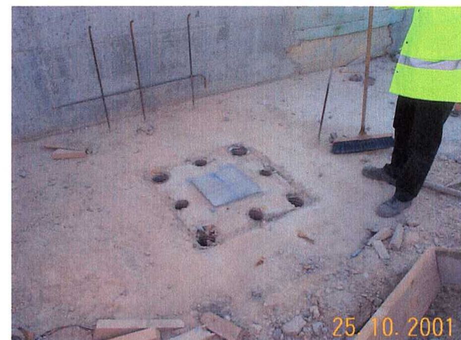
25/10/01 Vista de vainas dejadas en la zapata para la colocación de las pilas prefabricadas.
