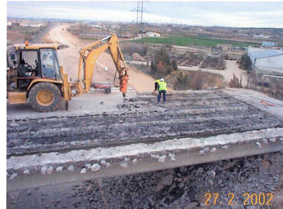
27/02/02 Demolición de las vigas del antiguo paso.
