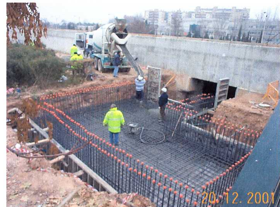
22/11/01 Refinado manual de la cimentación para la solera de la salida de emergencia.
