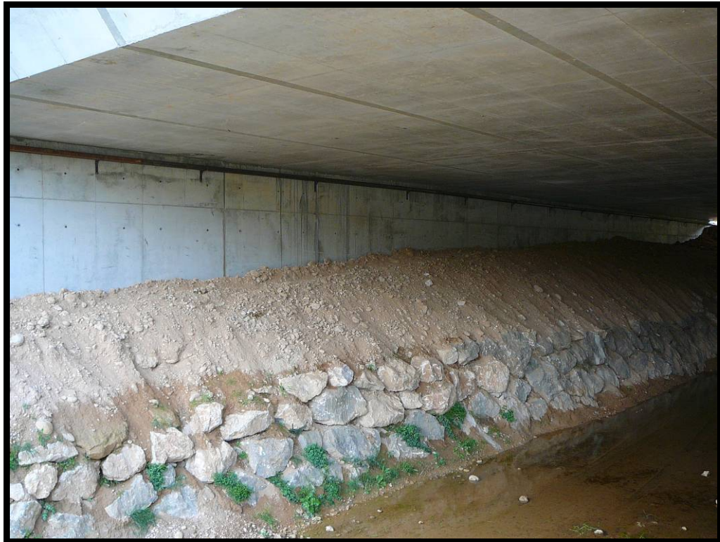
3. Estribo de entrada.
