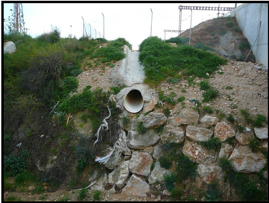
16. desagüe en margen derecha de aguas abajo.
