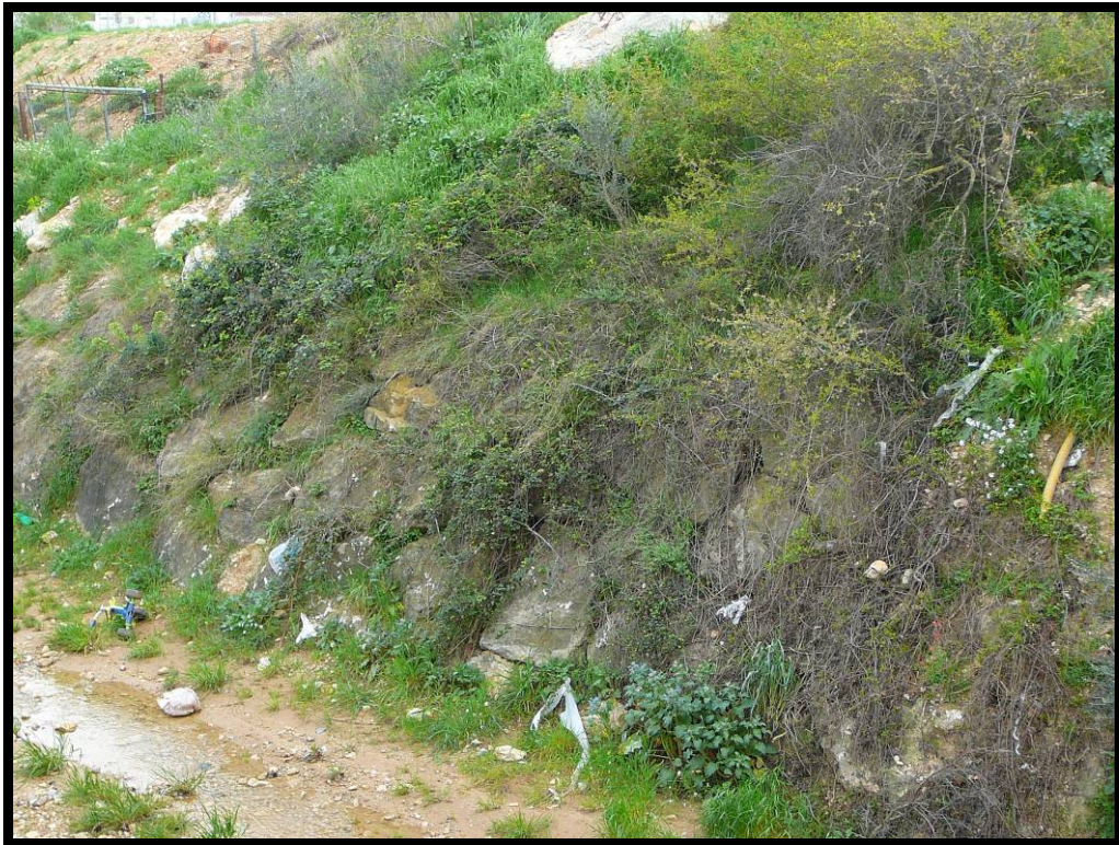
21. Escollera de protección en margen derecha.
