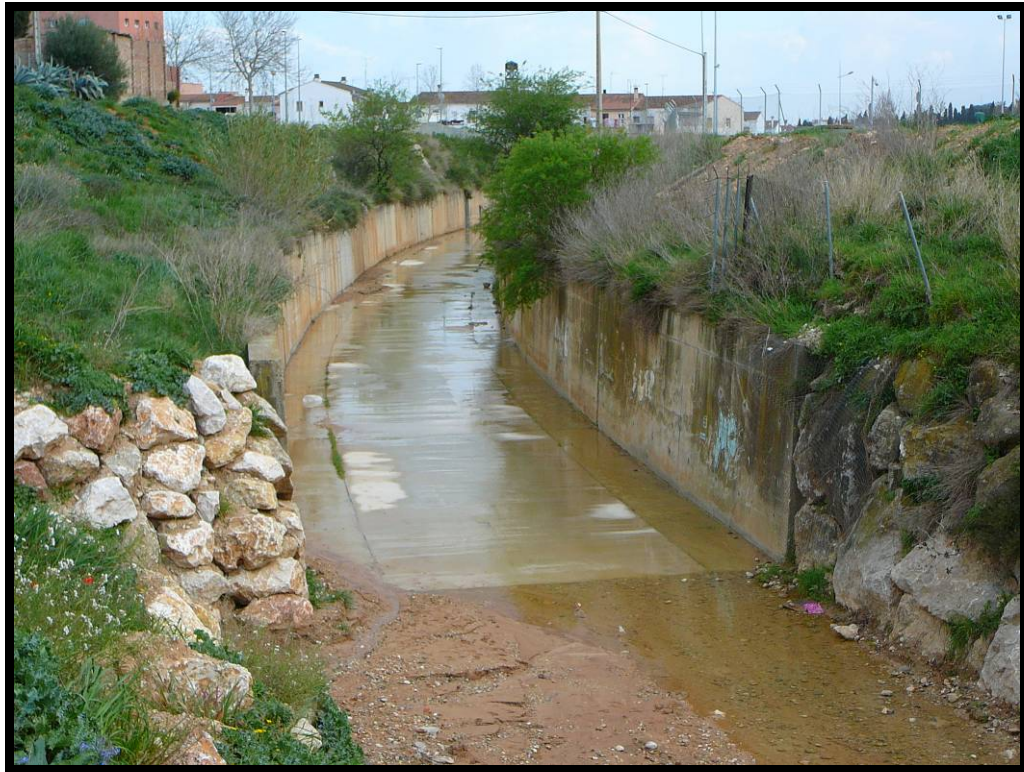
9. Canal, aguas abajo.
