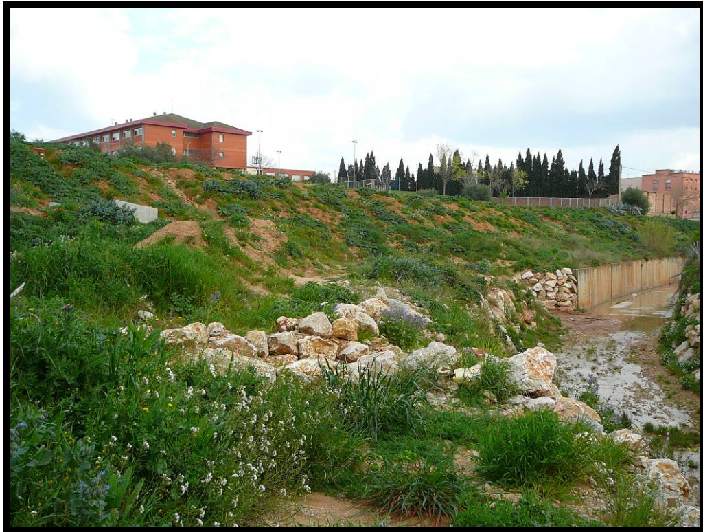
15. Margen izquierda del cauce aguas abajo.
