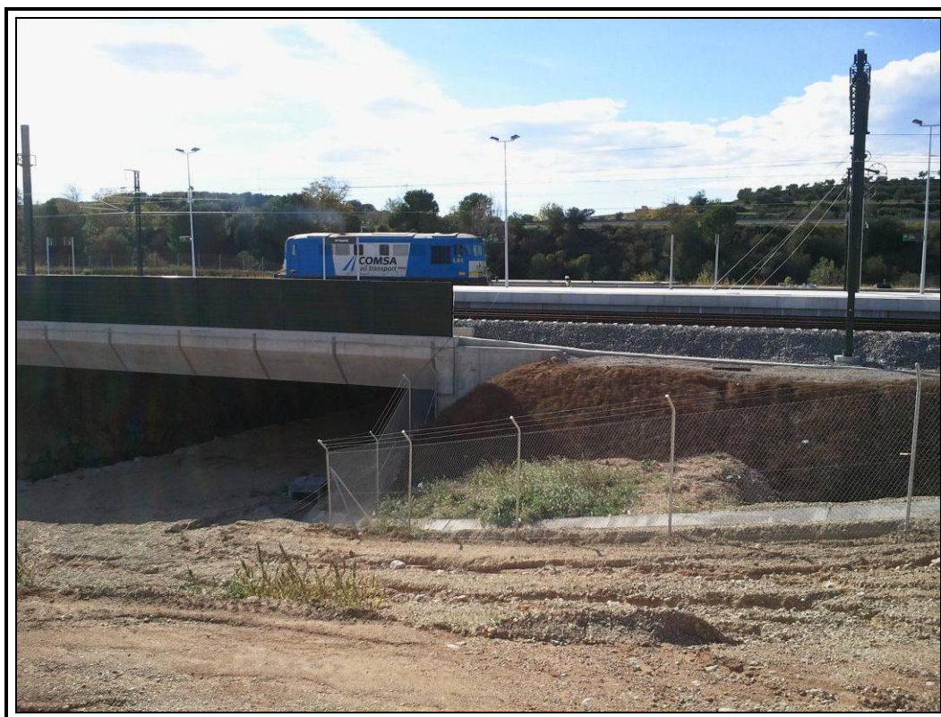
Nº 12.- Realización de prueba dinámica.
