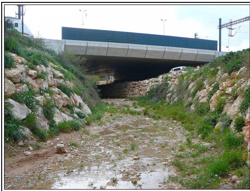
Nº 2.- Alzado izquierdo de la estructura.
