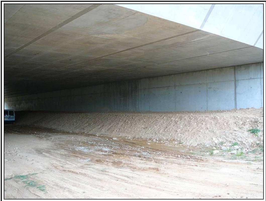
Nº 4.-Hastial derecho de la estructura.
