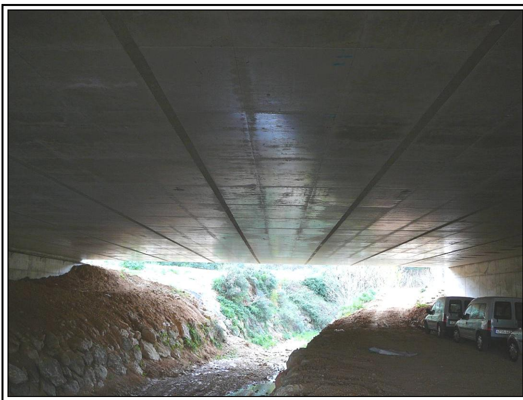
Nº 6.- Vista inferior de la losa postesada.
