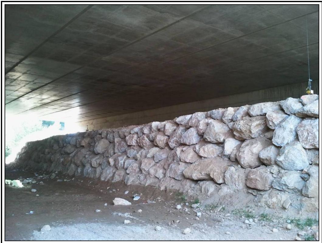
Nº 8.- LVDT's instalados en centro de vano.
