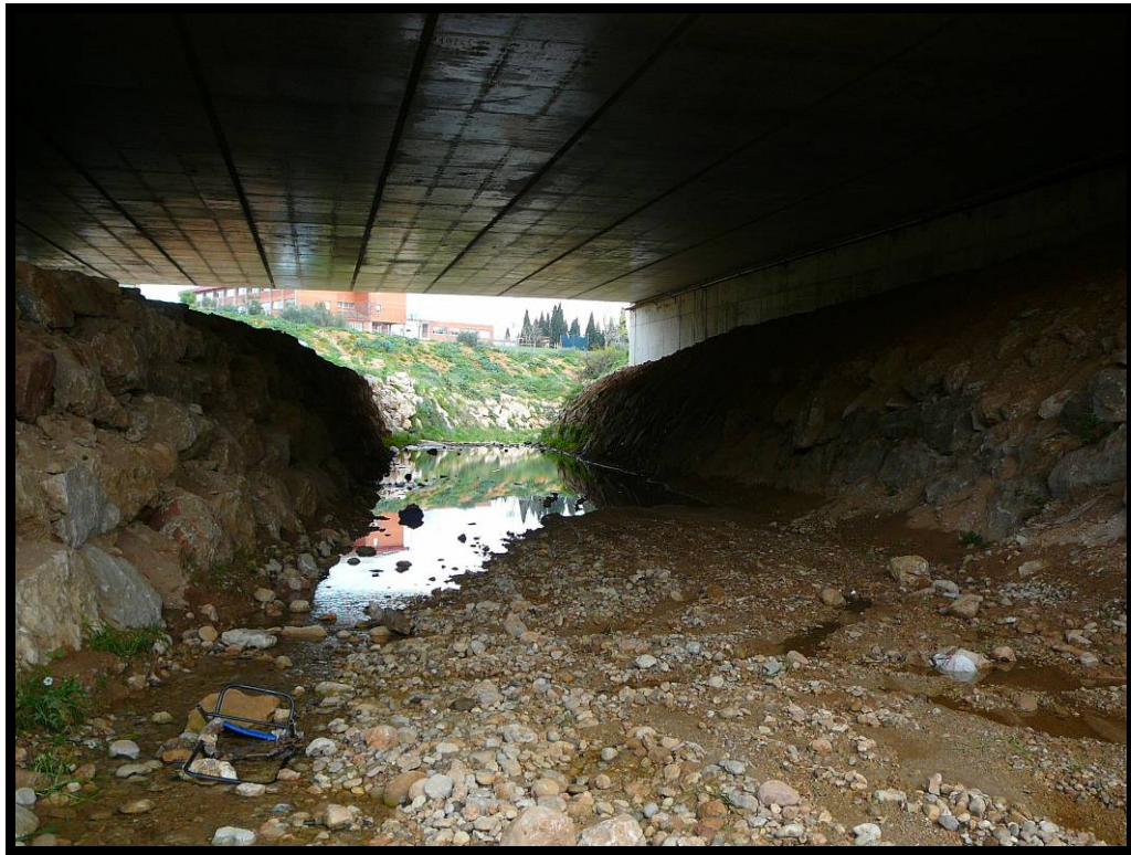
7. Cauce bajo la estructura.
