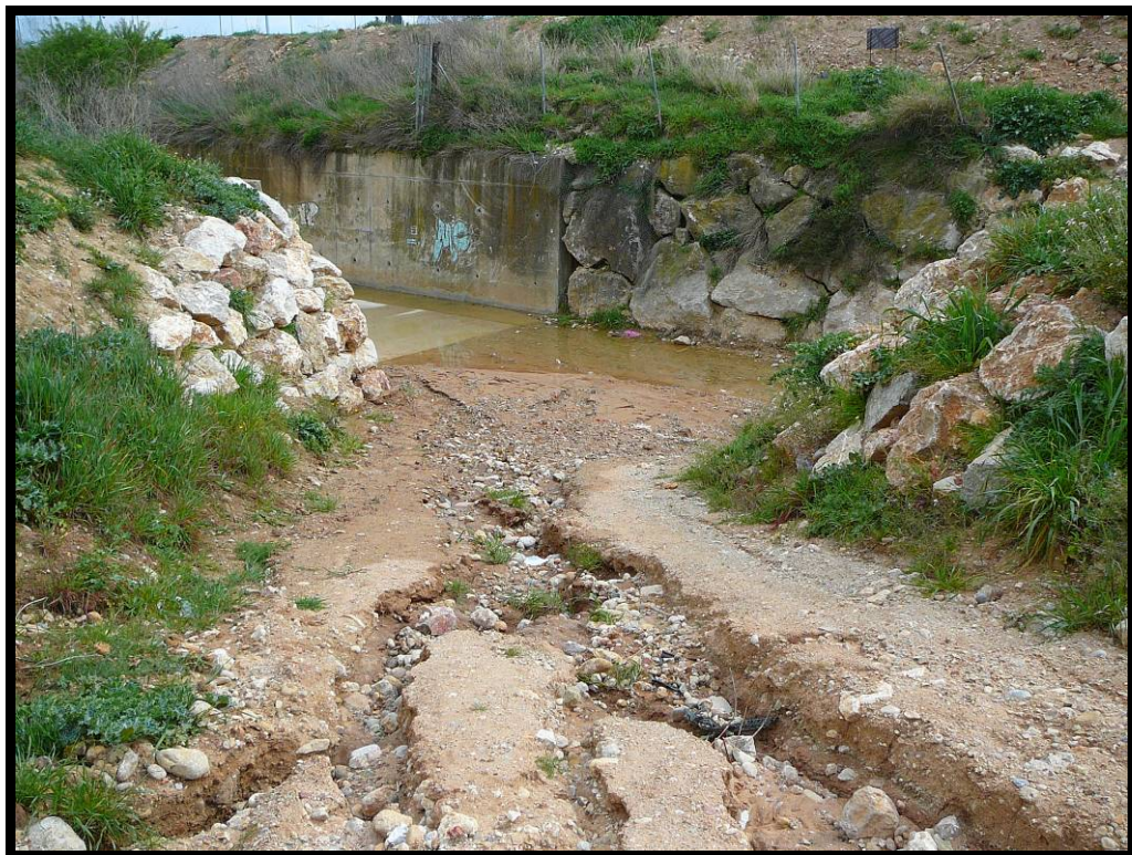
10. Acceso al canal.
