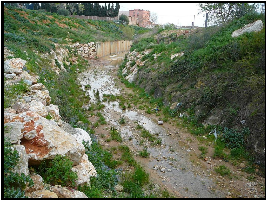
8. Cauce hacia aguas abajo.
