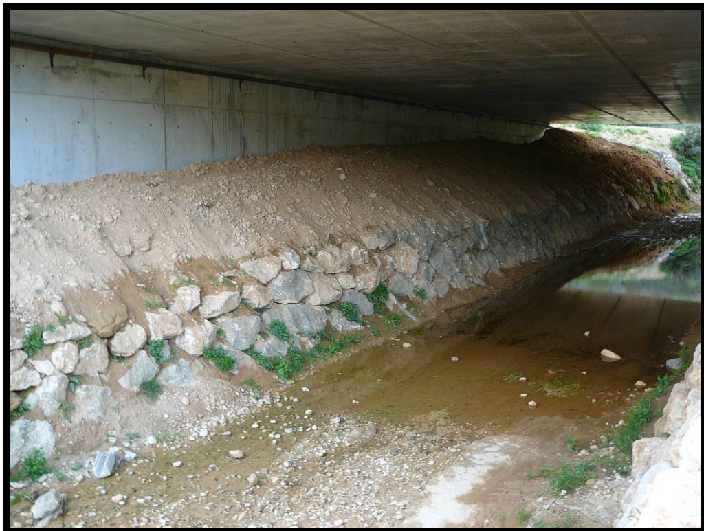
20. Escollera de protección en margen derecha.
