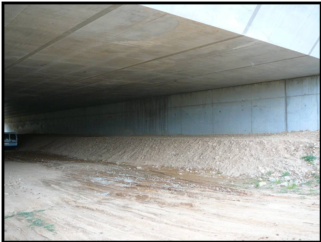
4. Estribo de salida.
