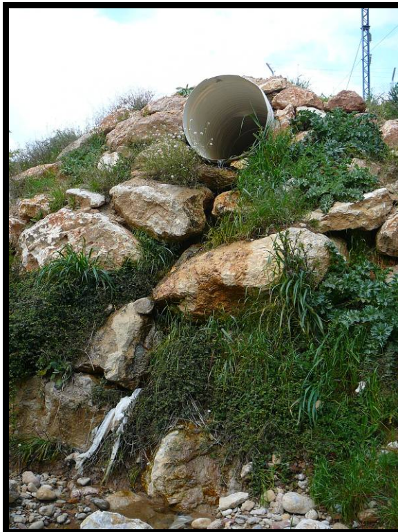
18. Desagüe en margen izquierda de aguas arriba.
