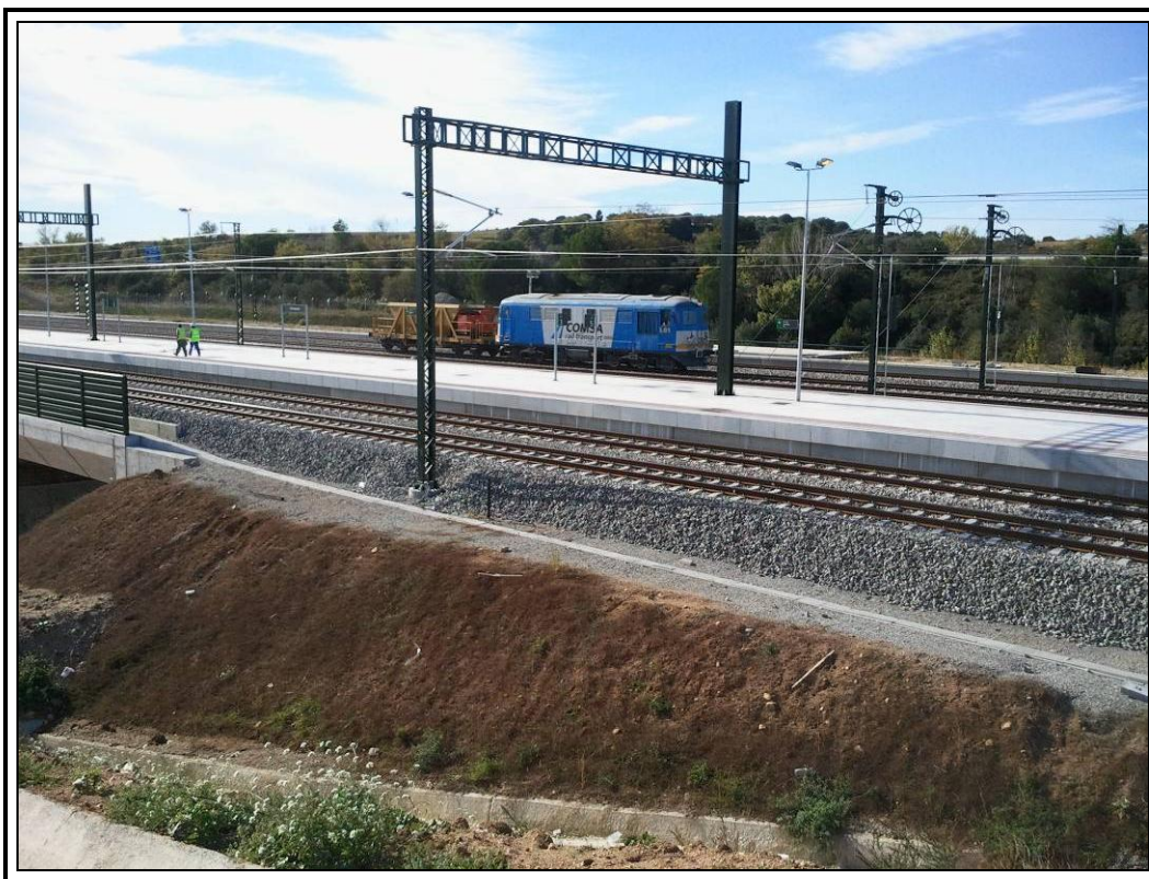
Nº 9.- Realización de prueba estática vía 1.
