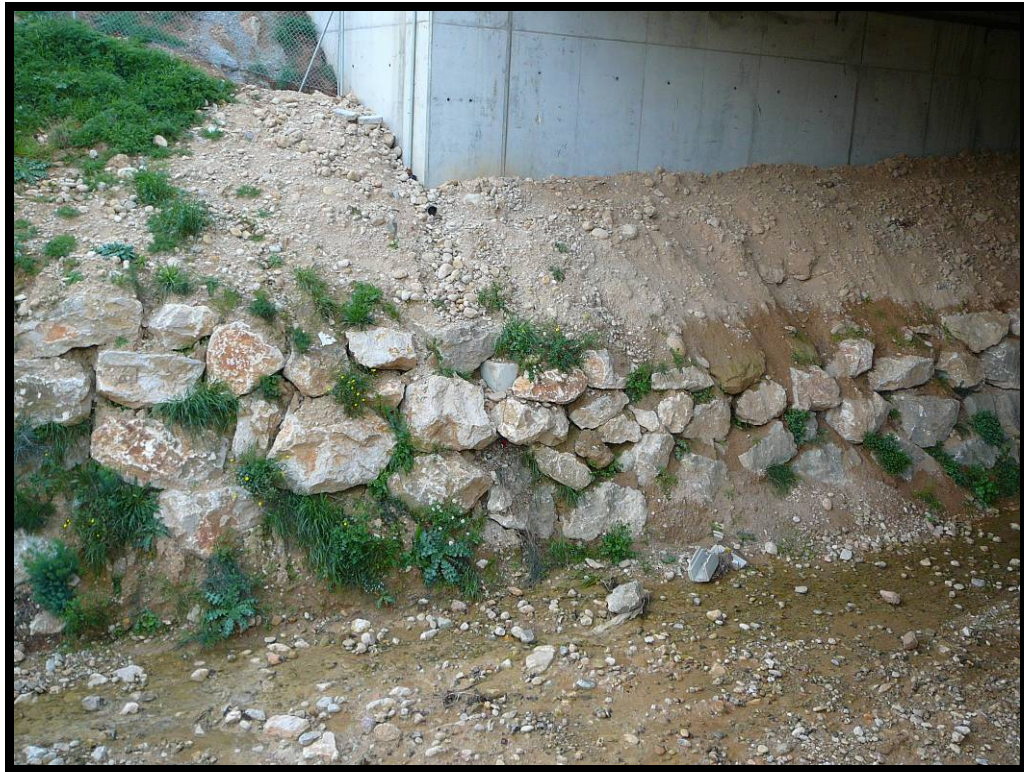
19. Escollera de protección en margen derecha.
