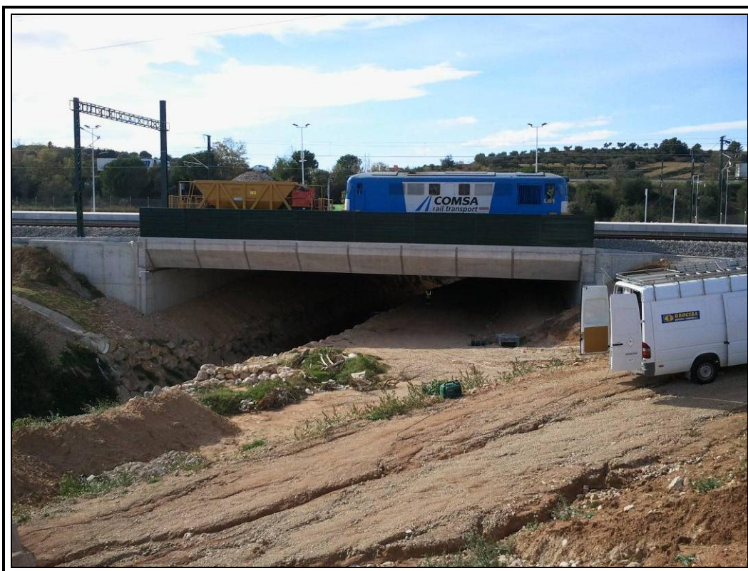
Nº 10.- Realización de prueba estática vía 7.
