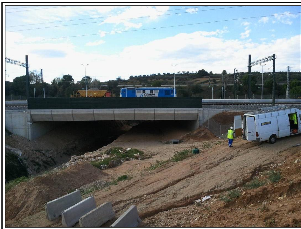
Nº 11.- Realización de prueba estática vía 3.
