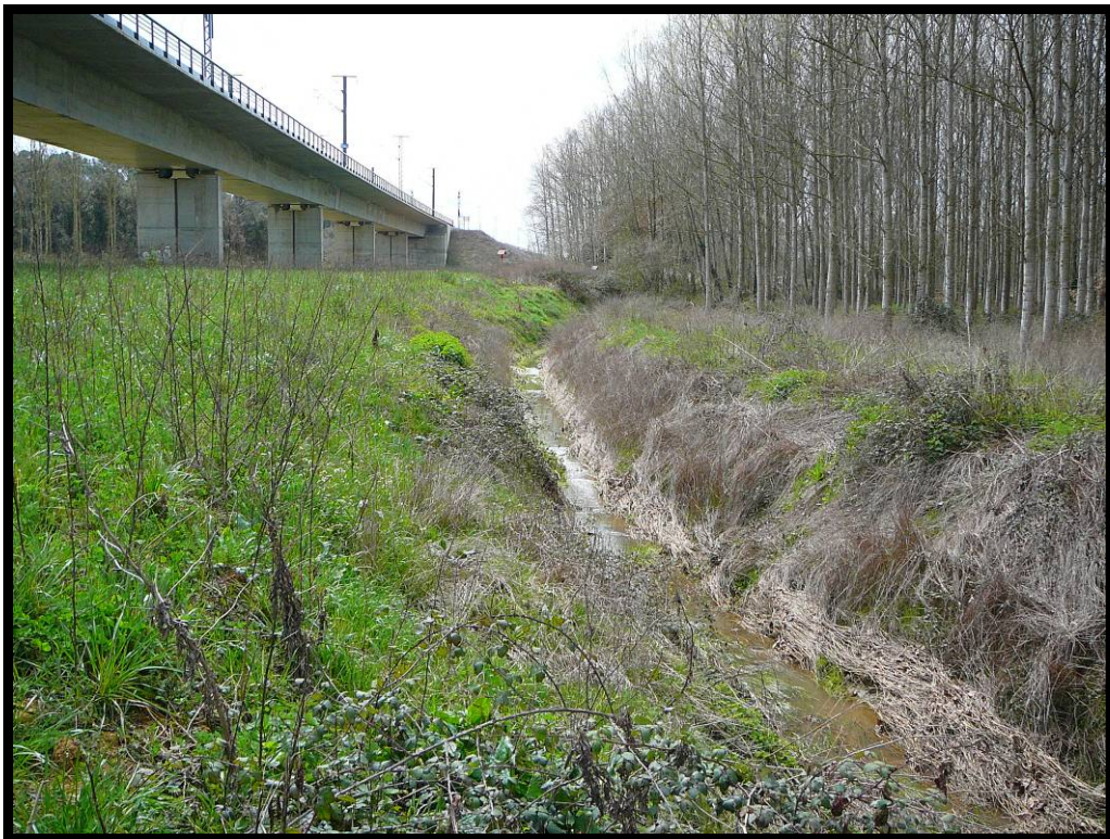
14. cauce hacia aguas arriba a la altura de la pila 6.
