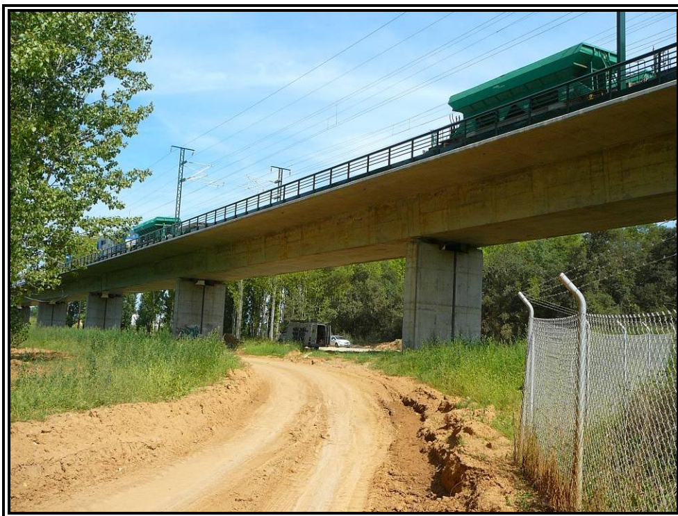
Nº 11.- Prueba estática Estado 1 (Vanos Nº 1 y Nº 3).
