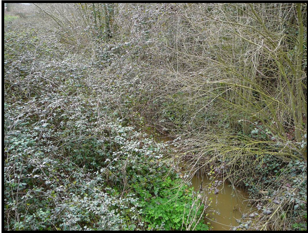
27. Vegetación arbustiva a la altura de la pila 6.
