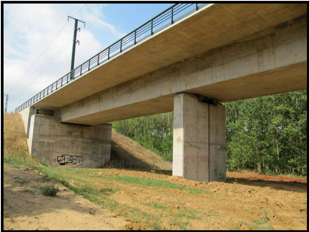
2. Alzado derecho, vista hacia el estribo 1.
