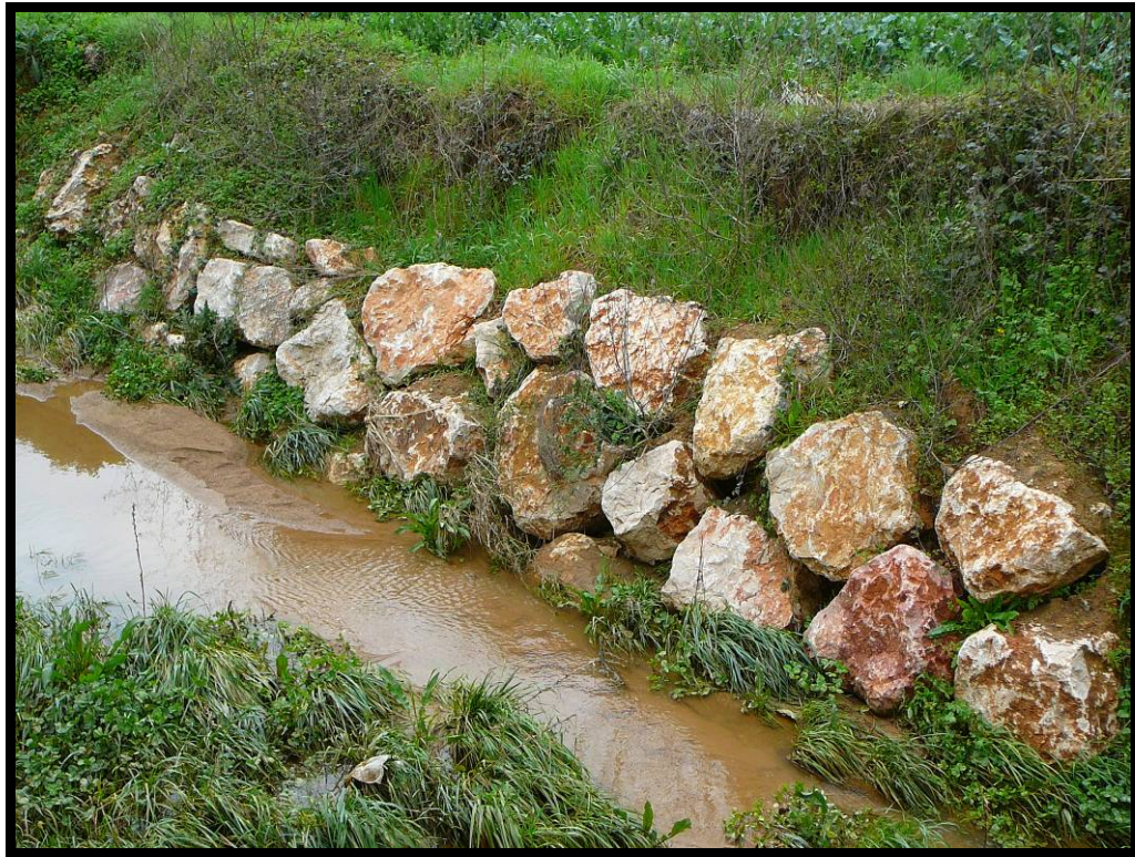
23. Escollera de protección a la altura de la pila 8.
