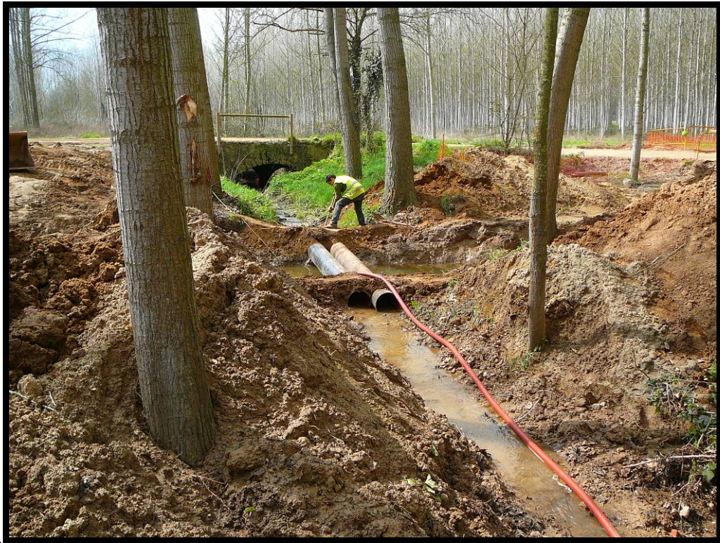
17. Cauce hacia aguas arriba, a la altura de la pila 2.
