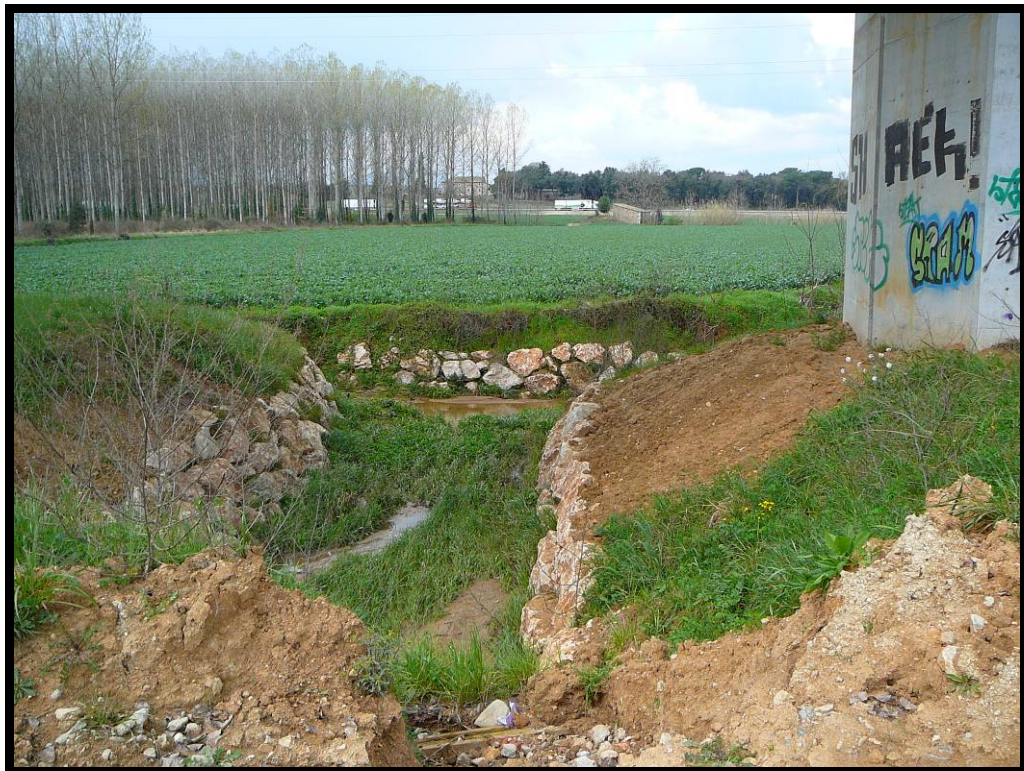
10. Cauce de desagüe, bajo vano 8.
