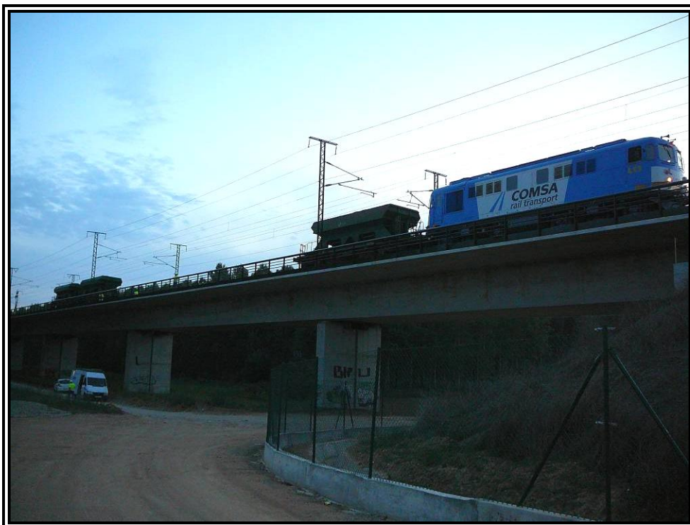
Nº 17.- Prueba estática Estado 7 (Vanos Nº 7 y Nº 9).
