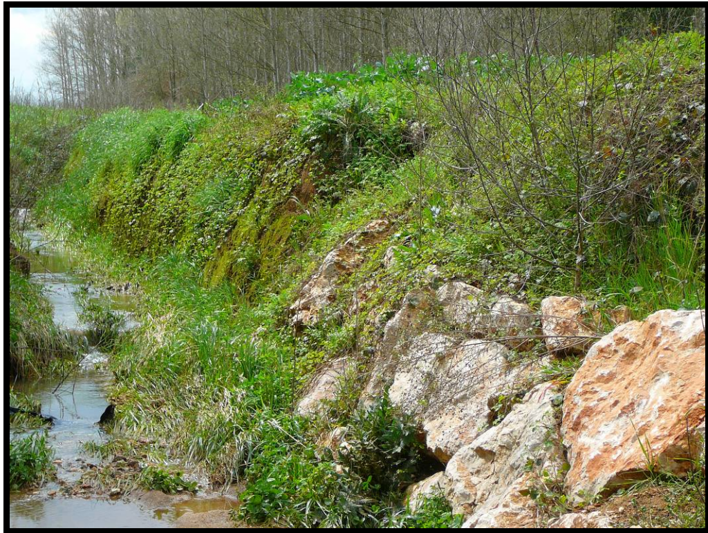
19. Margen izquierda hacia aguas arriba, a la altura de la pila 8.
