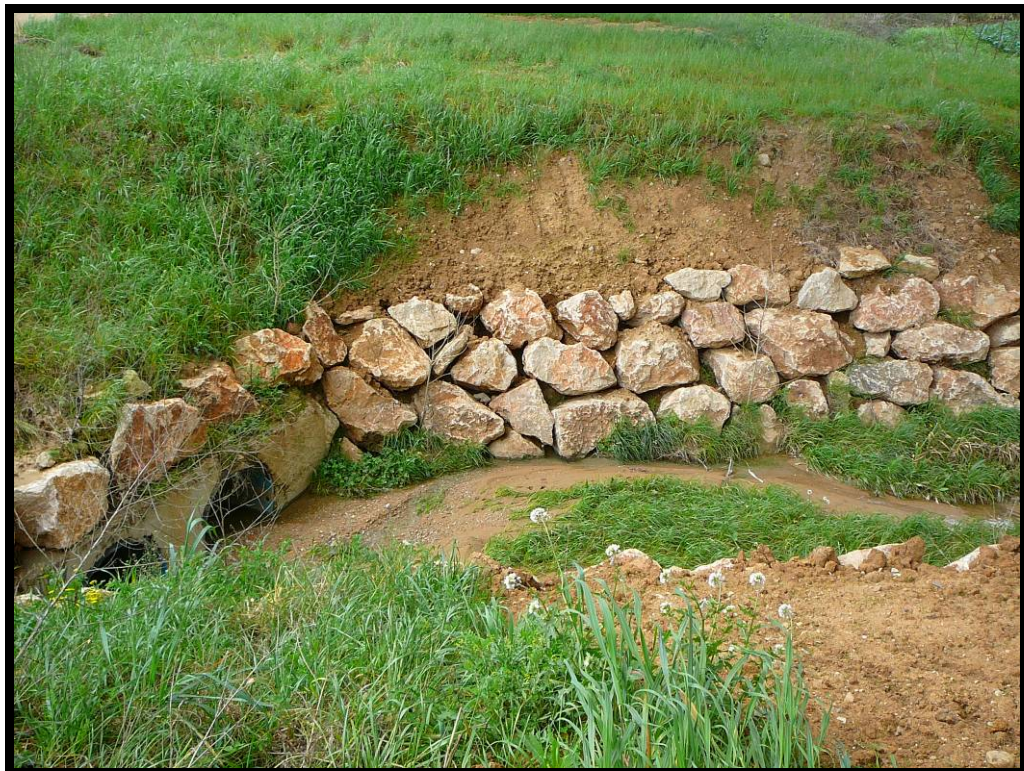
24. Escollera de protección a la altura de la pila 8.
