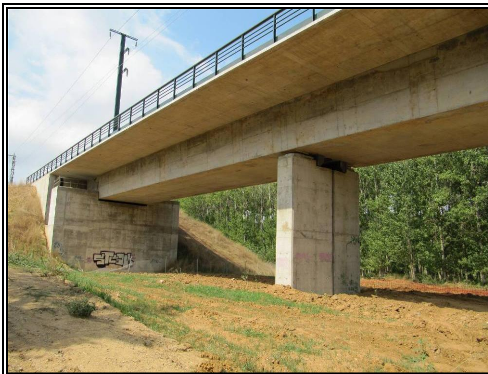
Nº 1.- Alzado derecho (vista hacia estribo 1).
