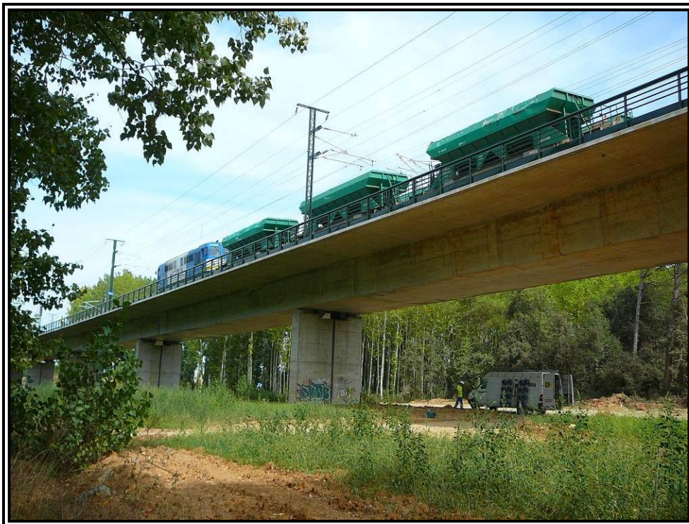
Nº 13.- Prueba estática Estado 3 (Vanos Nº 2 y Nº 3).
