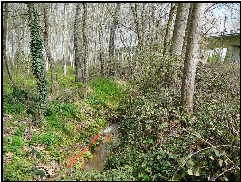
16. Cauce hacia aguas abajo, a la altura de la pila 3.
