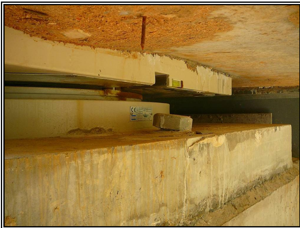
Nº 9.- Detalle de apoyo tipo POT.
