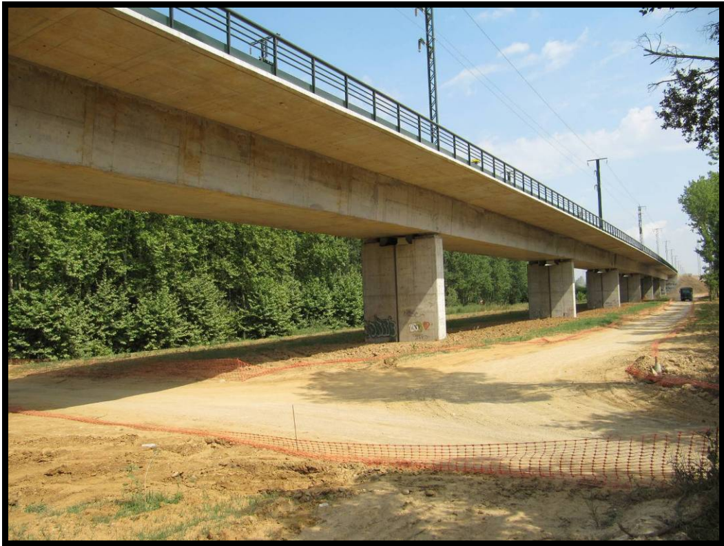
1. Alzado derecho, vista hacia el estribo 2.
