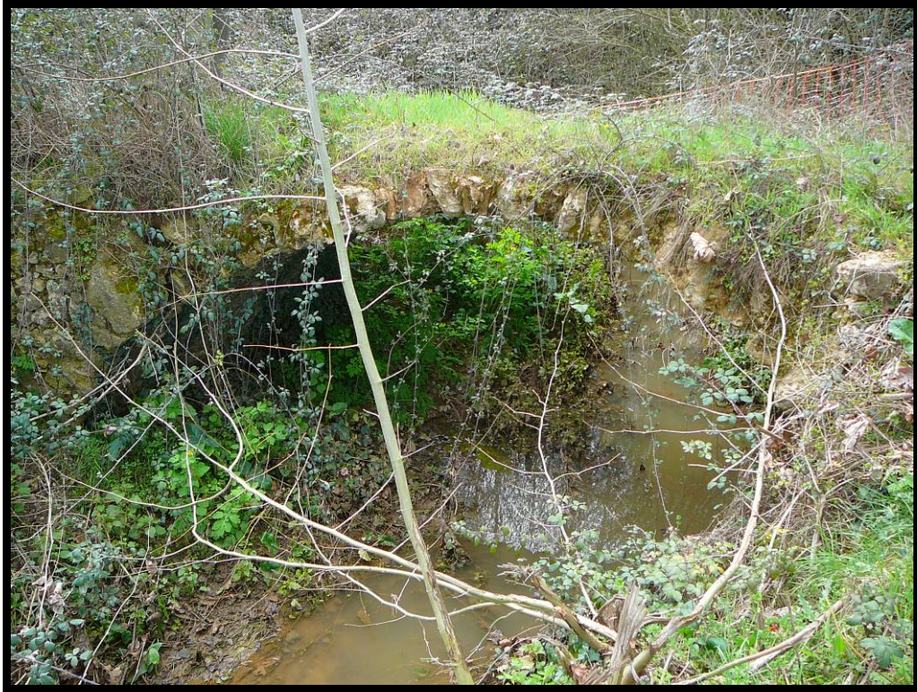
13. pequeña obra de paso a la altura de la pila 7.
