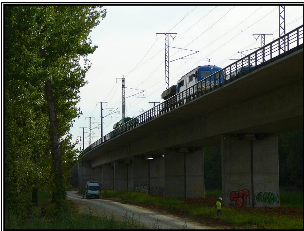
Nº 14.- Prueba estática Estado 4 (Vanos Nº 4 y Nº 6).
