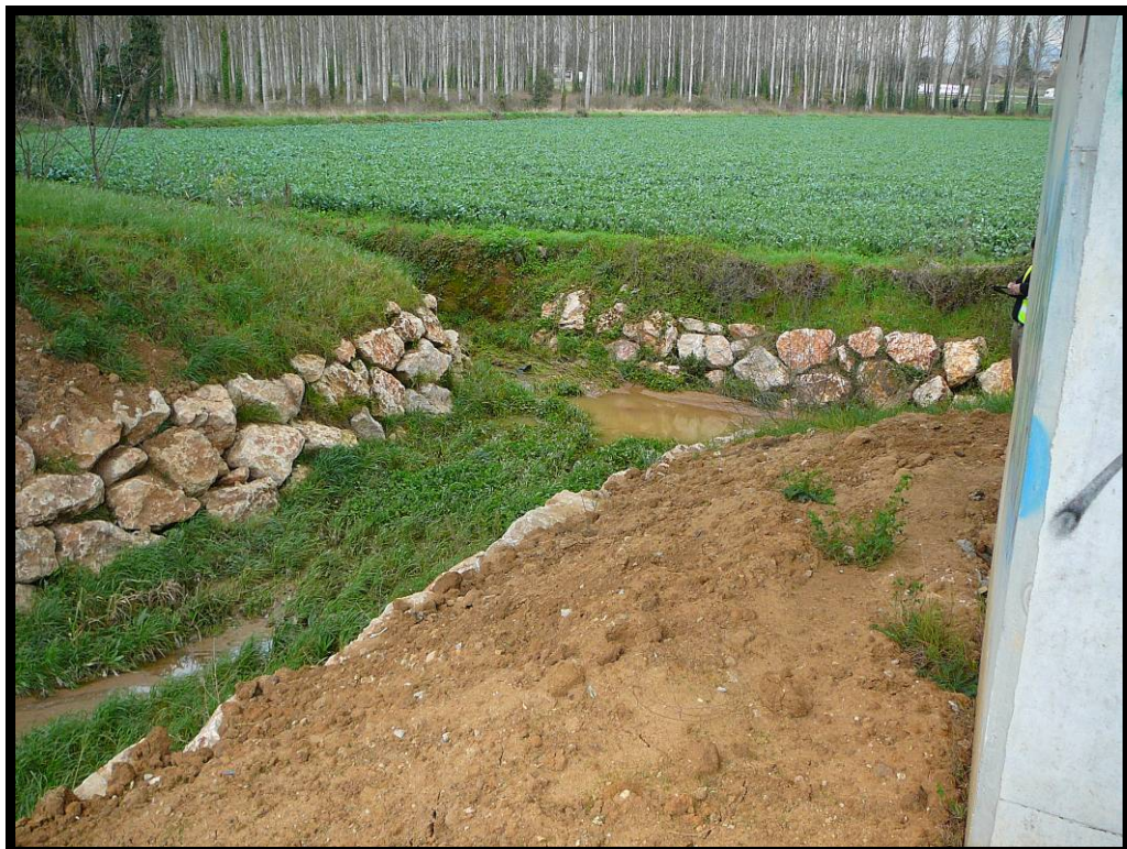
22. Escollera de protección a la altura de la pila 8.
