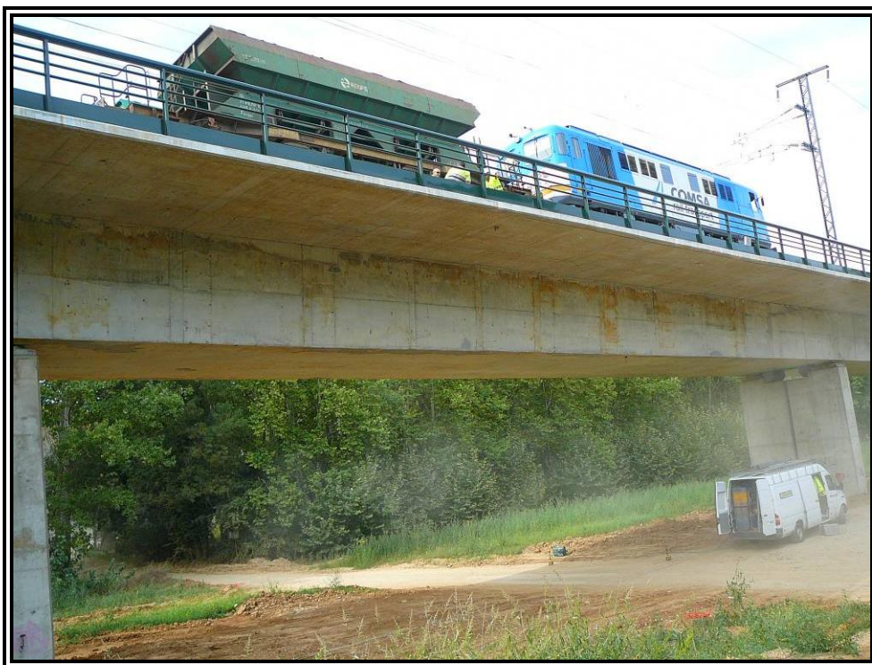
Nº 12.- Prueba estática Estado 2 (Vano Nº 2).
