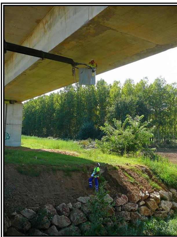
Nº 10.- Instrumentación en centro de vano.
