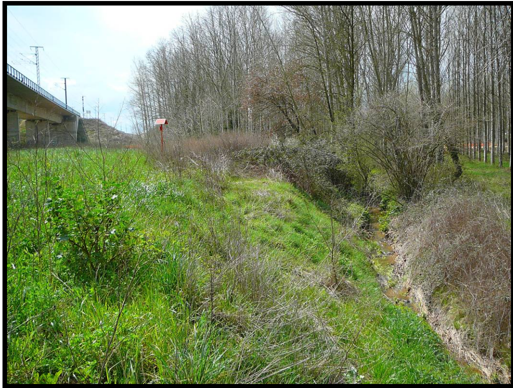
15. Cauce hacia aguas arriba, a la altura de la pila 4.
