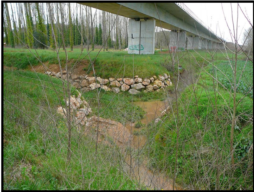
7. Cauce hacia aguas arriba, visto desde la zona del estribo 2.
