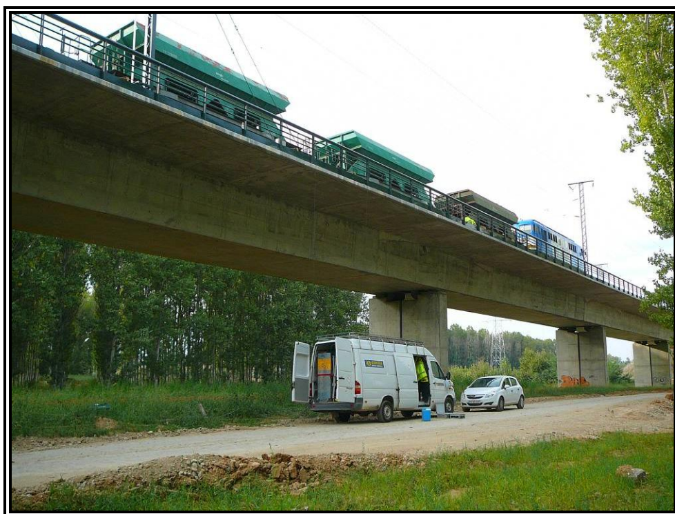
Nº 16.- Prueba estática Estado 6 (Vanos Nº 5 y Nº 6).
