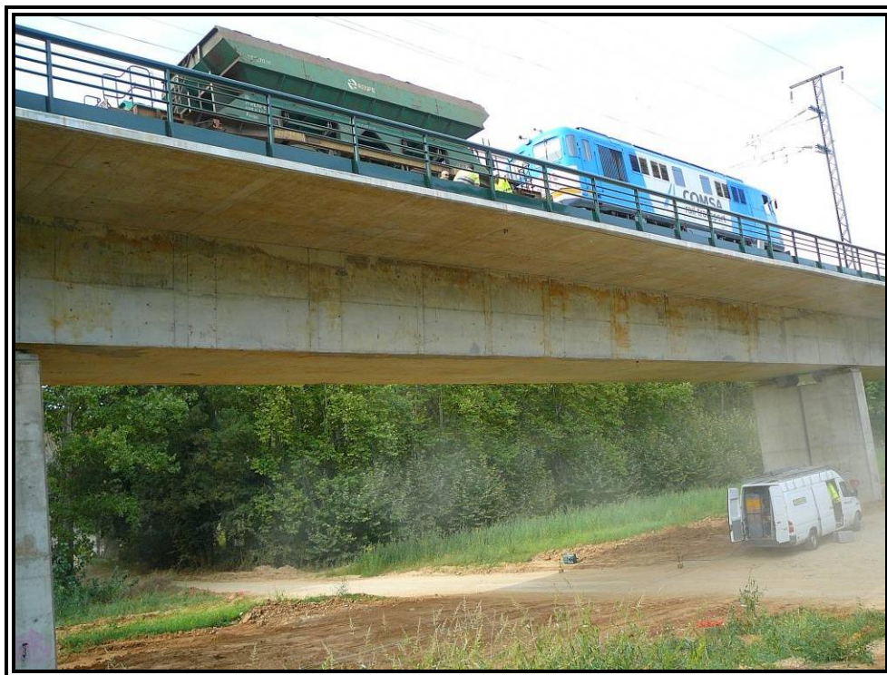
Nº 15.- Prueba estática Estado 5 (Vano Nº 5).
