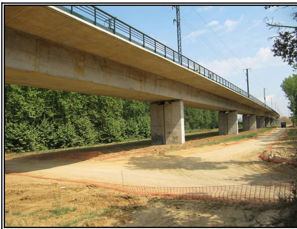
Nº 2.- Alzado derecho (vista hacia estribo 2).
