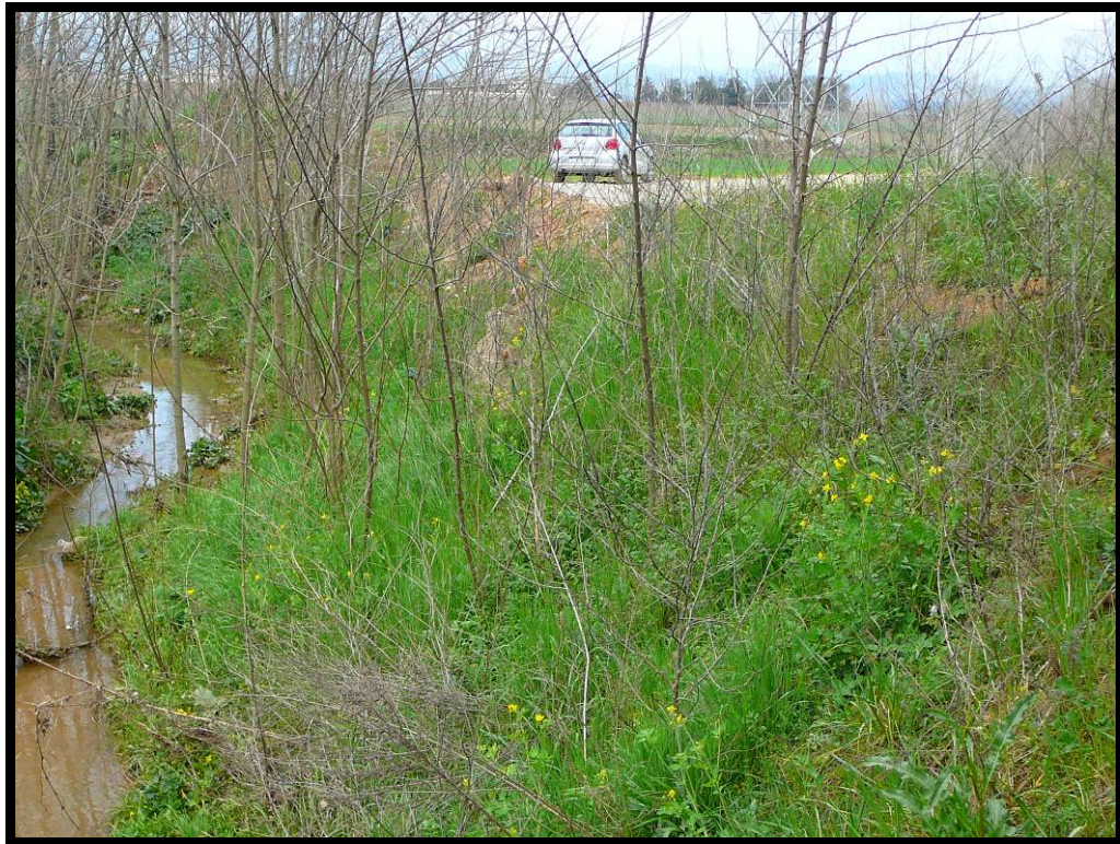
21. Margen derecha hacia aguas abajo, a la altura de la pila 8.
