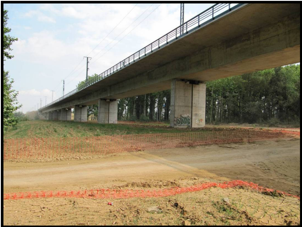
4. Alzado izquierdo, vista hacia el estribo 2.
