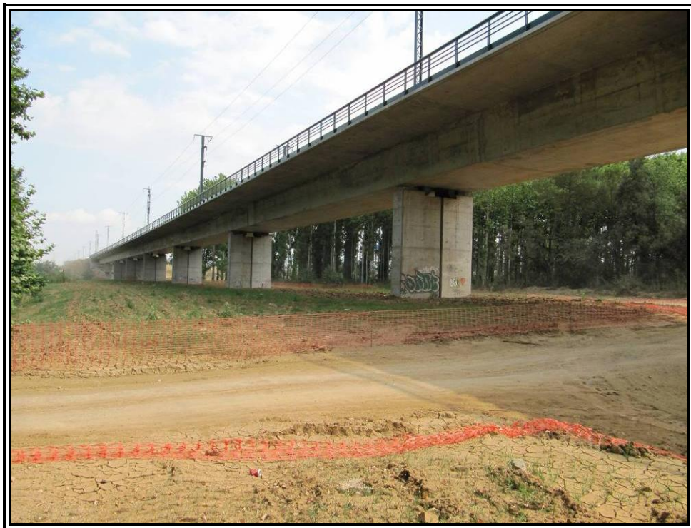
Nº 4.- Alzado izquierdo (vista hacia estribo 2).
