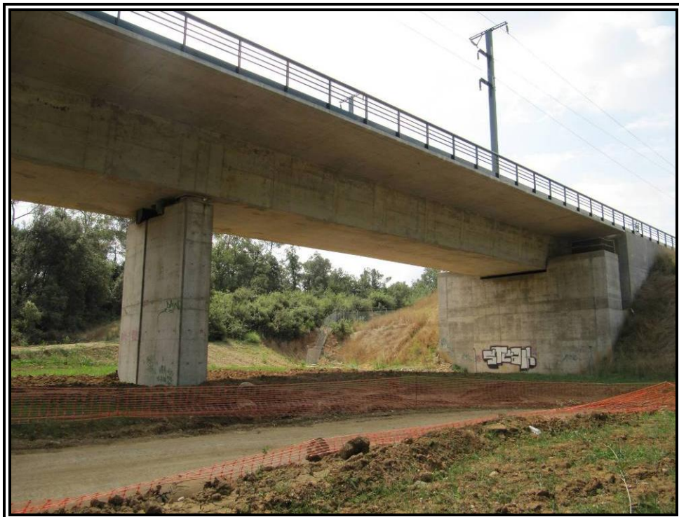
Nº 3.- Alzado izquierdo (vista hacia estribo 1).
