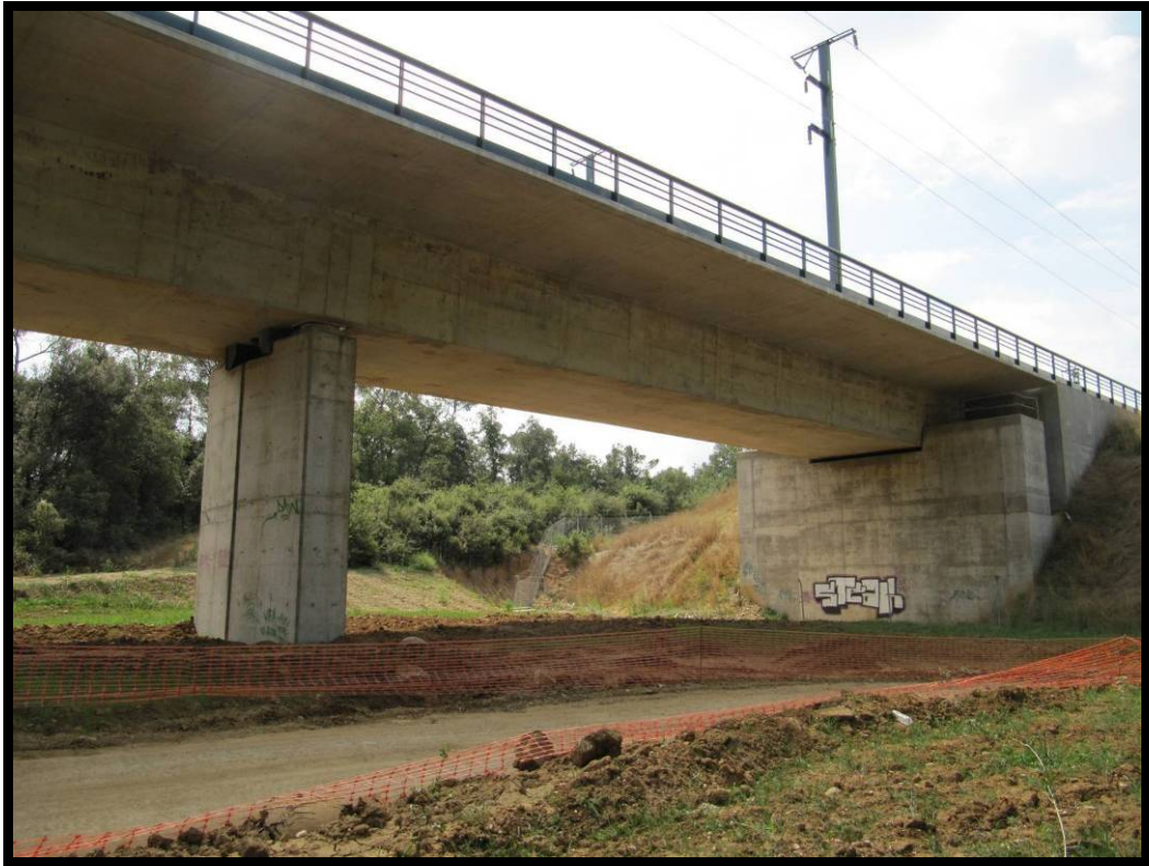
3. Alzado izquierdo, vista hacia el estribo 1.
