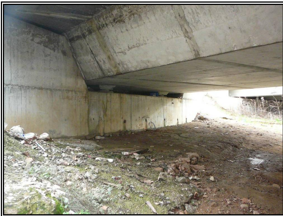
Nº 4.-Vista de estribo 2.
