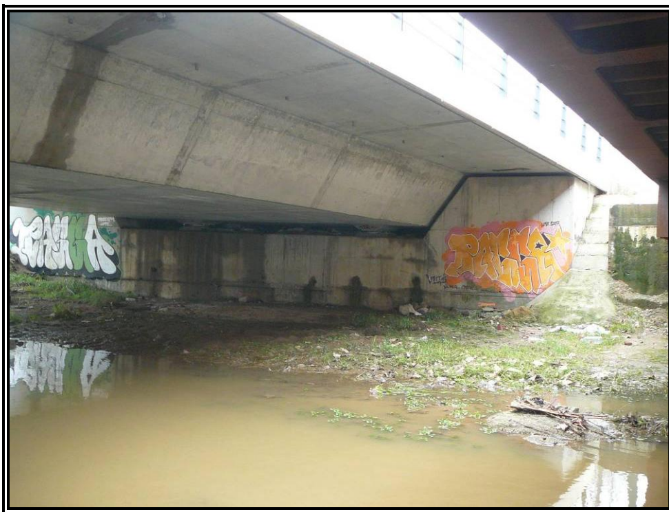
Nº 3.- Vista estribo 1.
