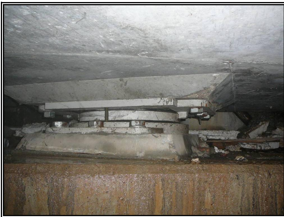
Nº 5.-Detalle de apoyo.
