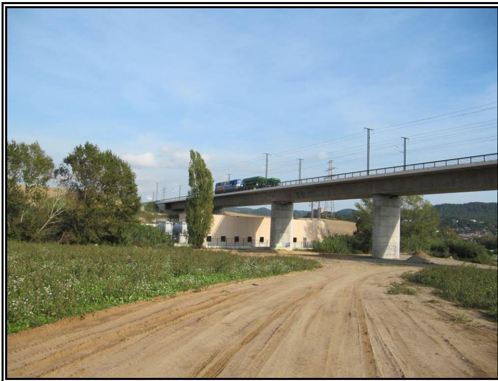
Nº 13.- Prueba estática Estado 5 (Vano Nº 5).
