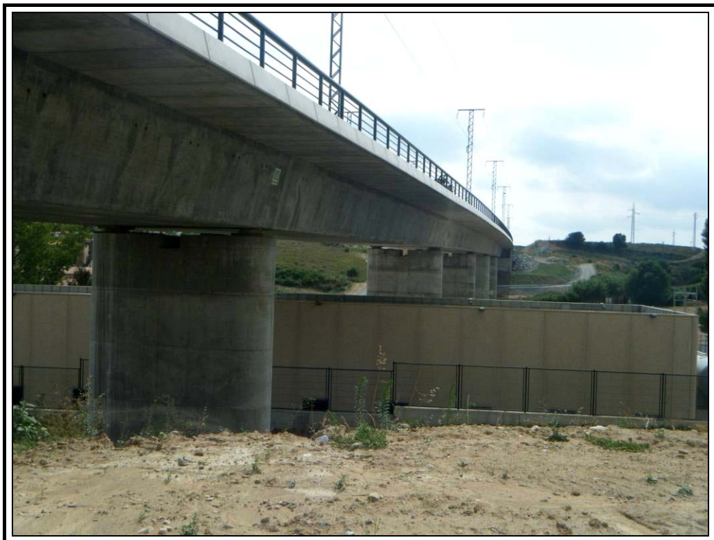
2. Alzado izquierdo, vista desde el estribo 2
