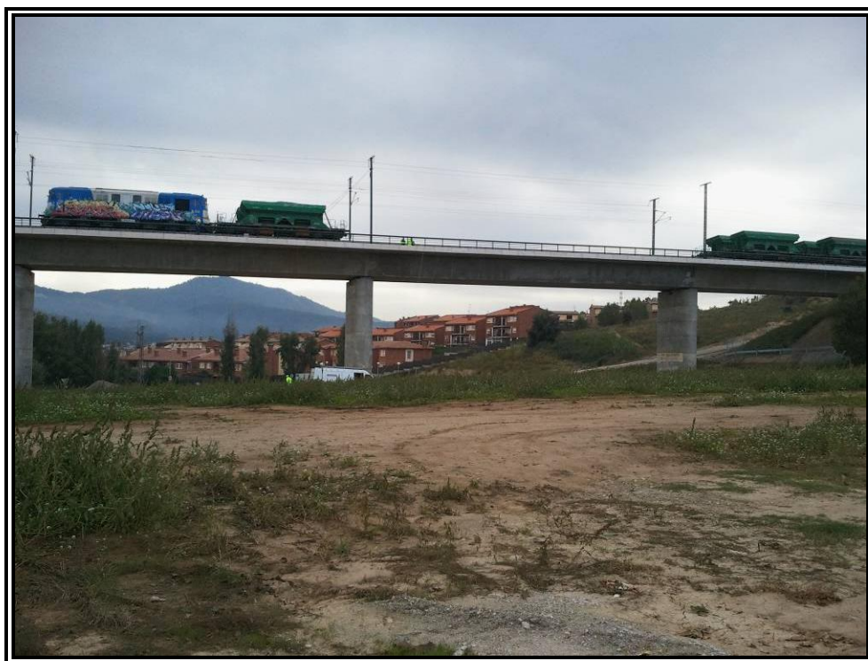
Nº 9.- Prueba estática Estado 1 (Vanos Nº 1 y Nº 3).
