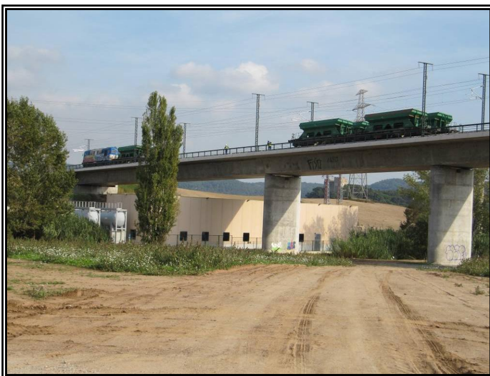
Nº 12.- Prueba estática Estado 4 (Vanos Nº 4 y Nº 6).
