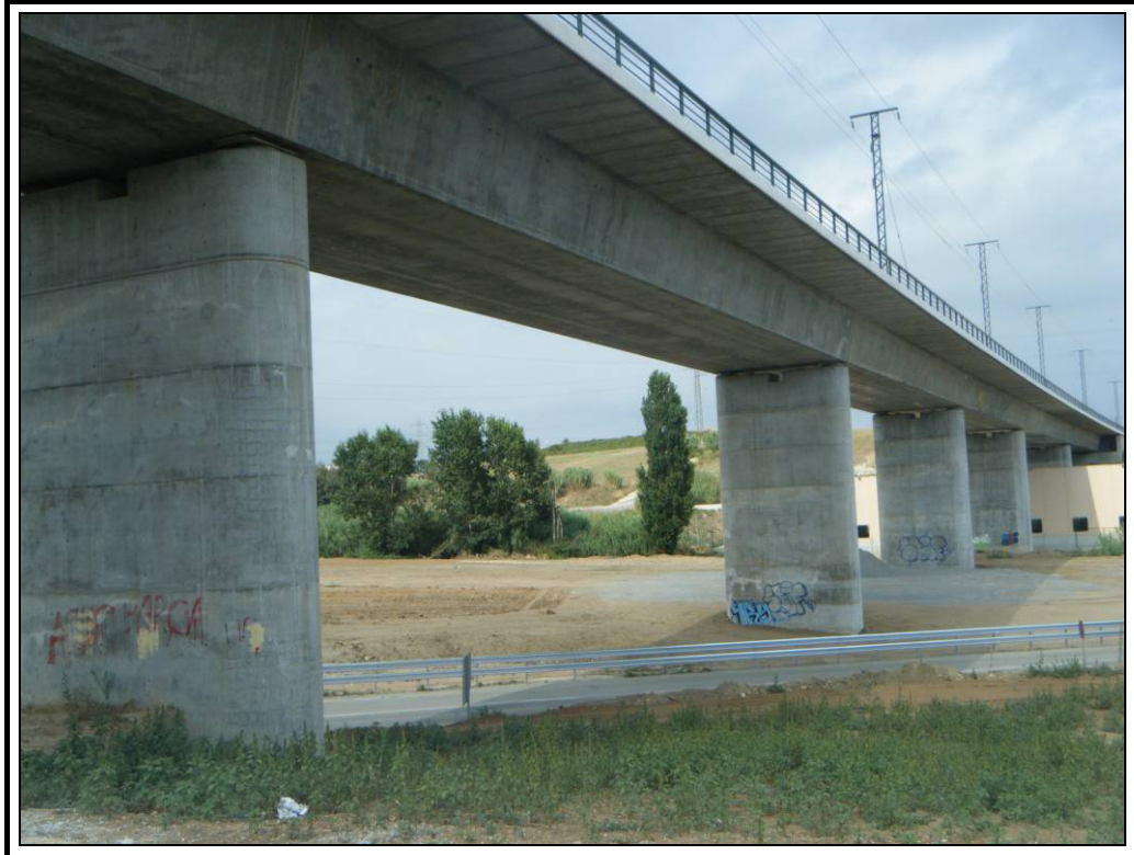
1. Alzado derecho, vista desde el estribo 1
