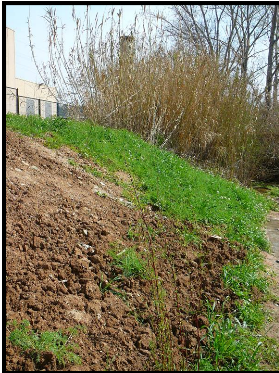
12. Margen izquierda del cauce aguas abajo.
