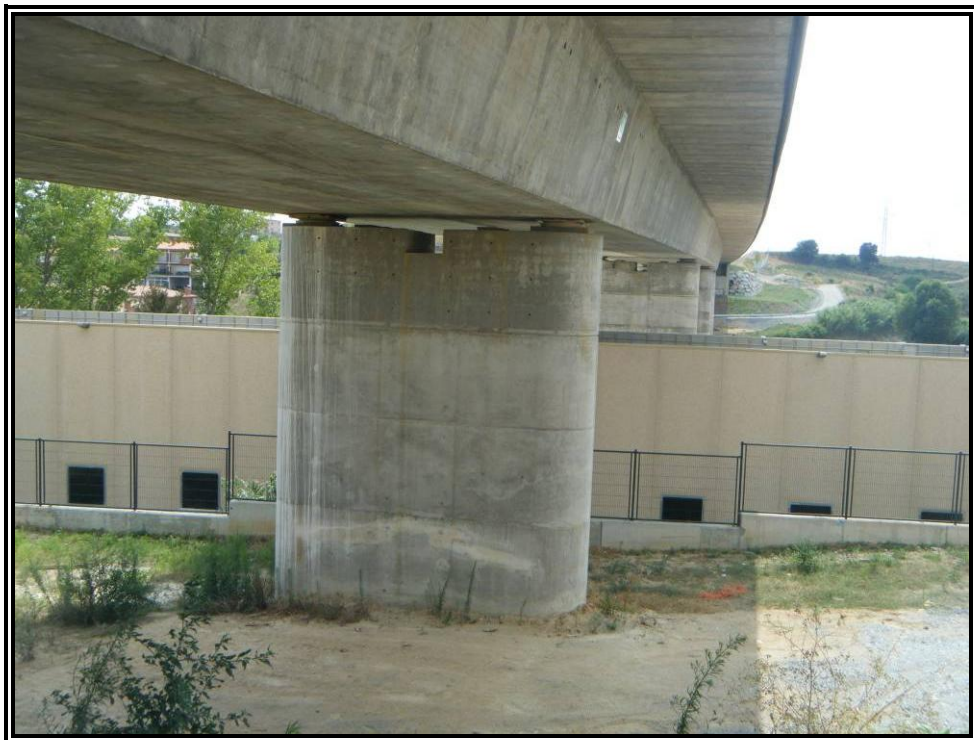
Nº 6.- Detalle de pila.
