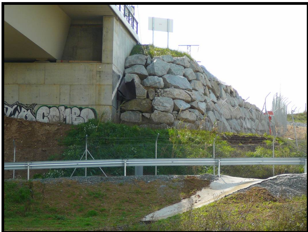
24. Protección en estribo1.
