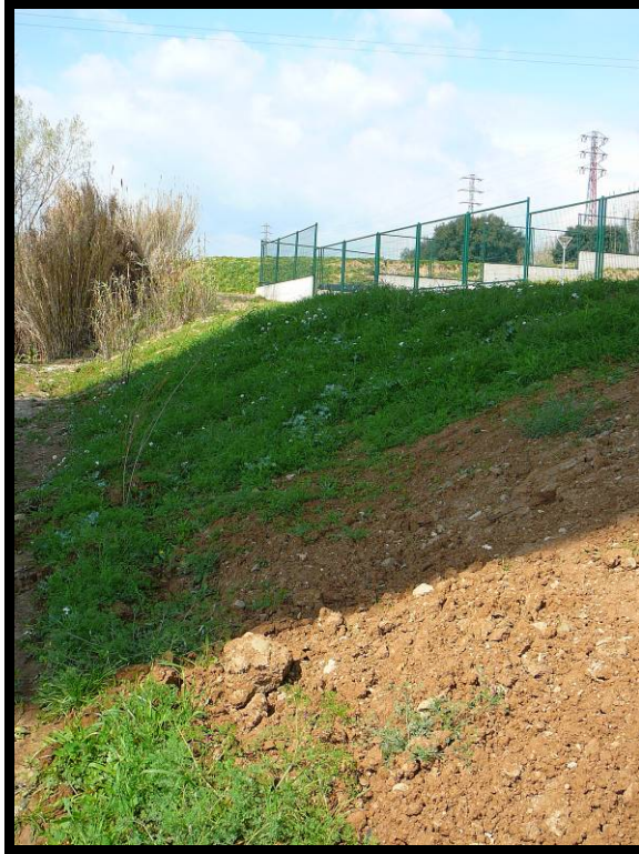
11. Margen izquierda del cauce aguas arriba.
