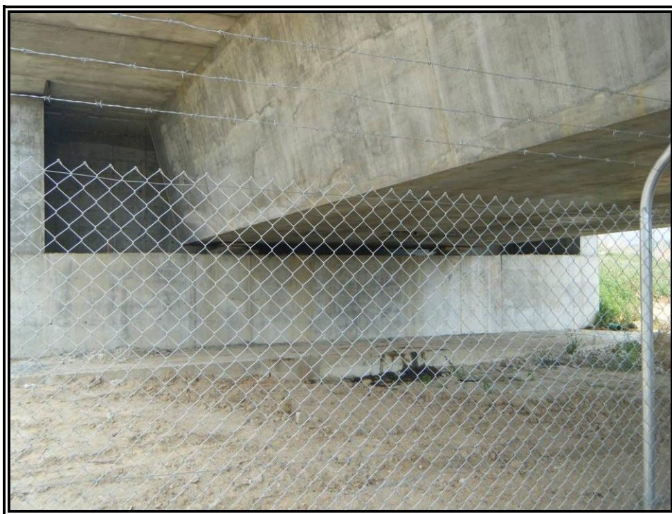
Nº 4.- Estribo de salida.
