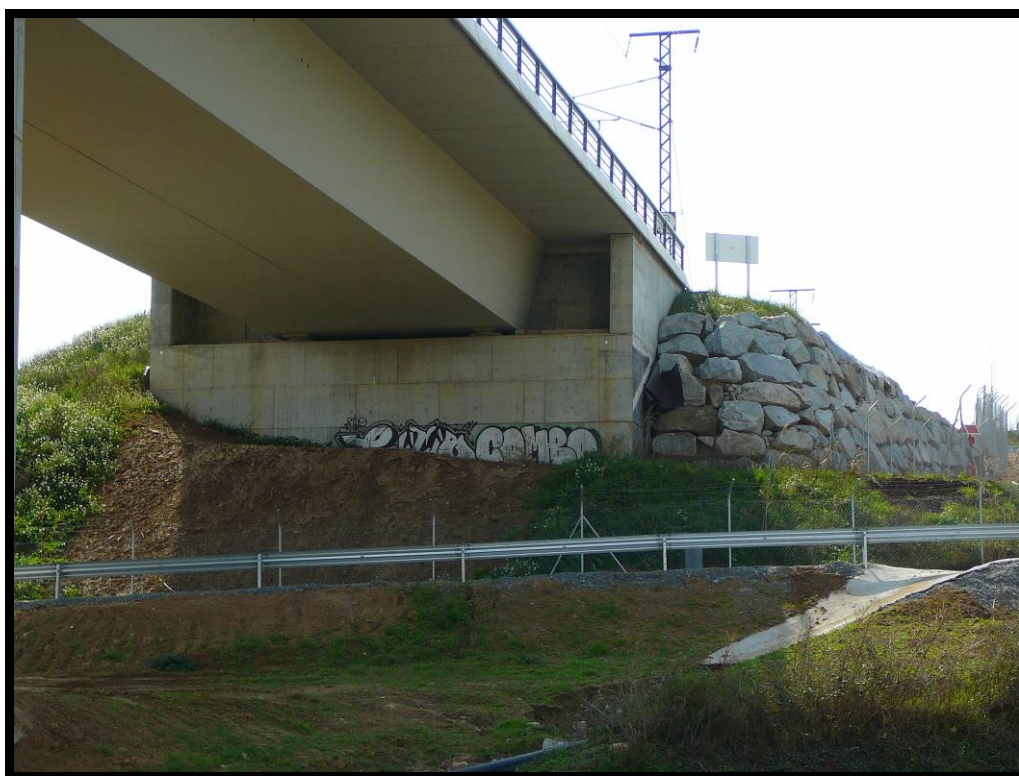
3. Estribo de entrada.
