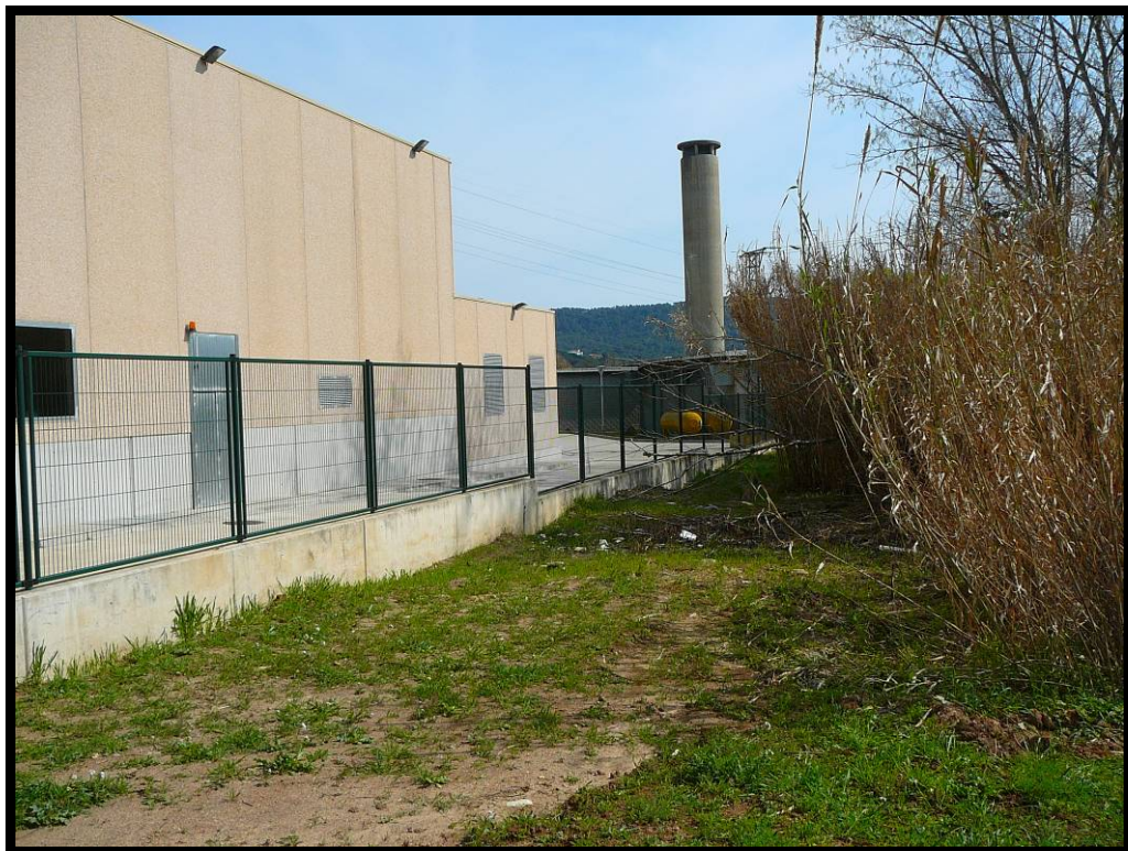
16. Llanura de inundación izquierda, aguas abajo.
