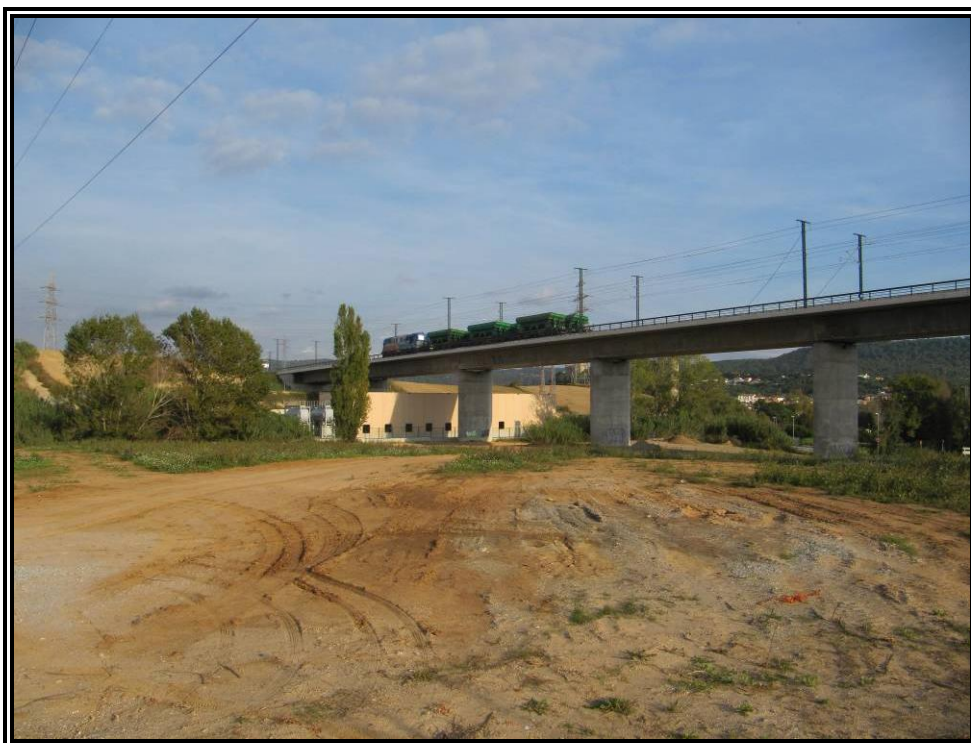
Nº 14.- Prueba estática Estado 6 (Vanos Nº 4 y Nº 5).
