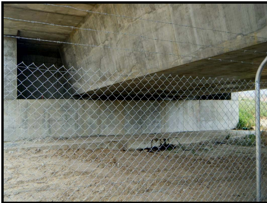
4. Estribo de salida.
