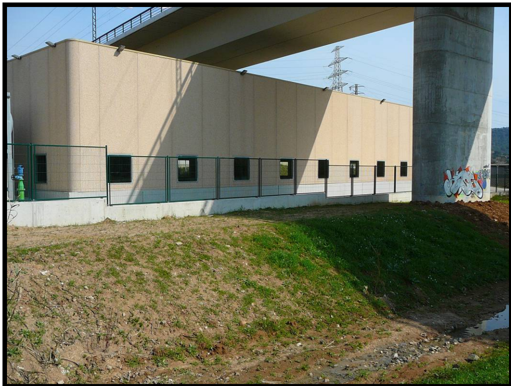
20. Estación de bombeo bajo vano 5 (junto a cauce).
