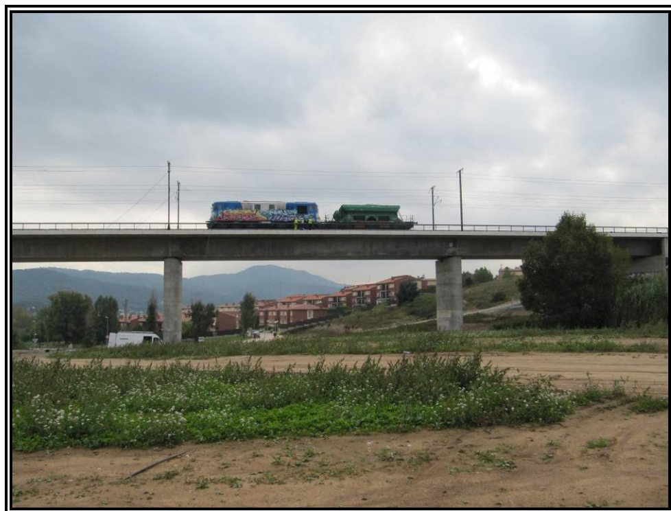
Nº 10.- Prueba estática Estado 2 (Vano Nº 2).
