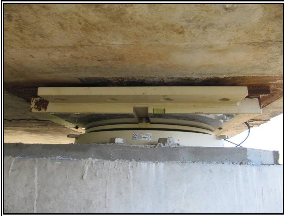
Nº 7.- Detalle de apoyo tipo POT.
