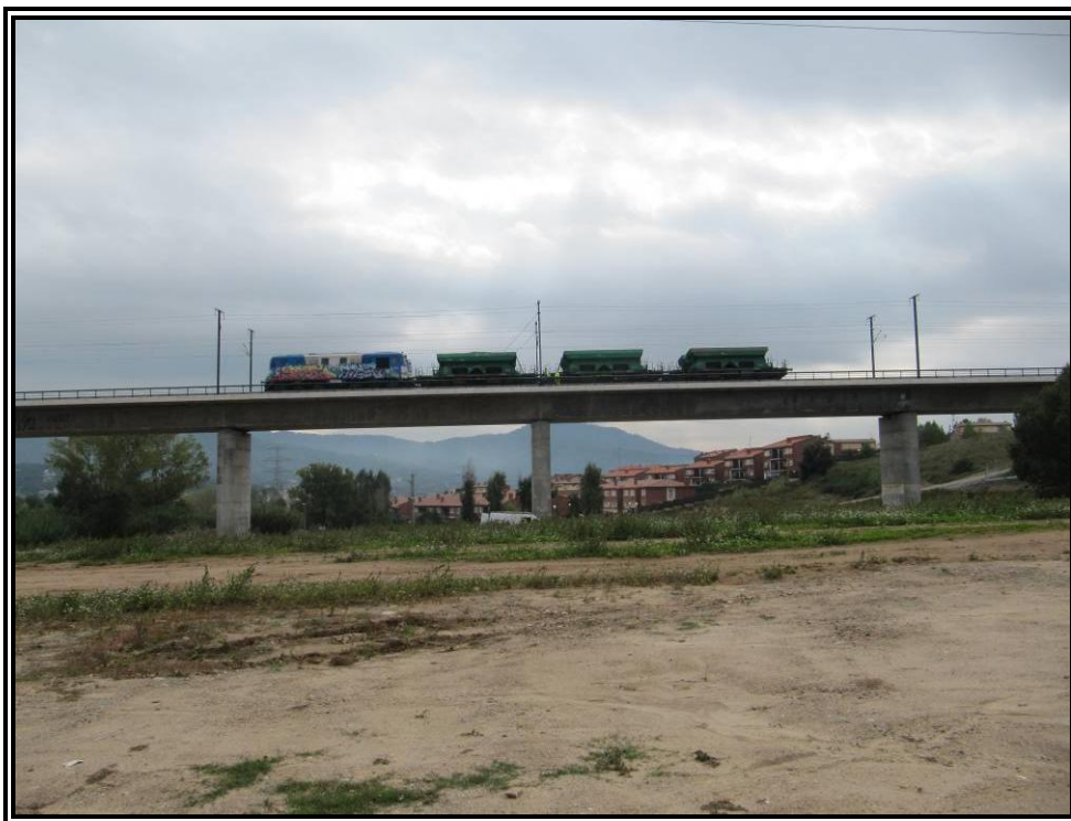
Nº 11.- Prueba estática Estado 3 (Vanos Nº 2 y Nº 3).
