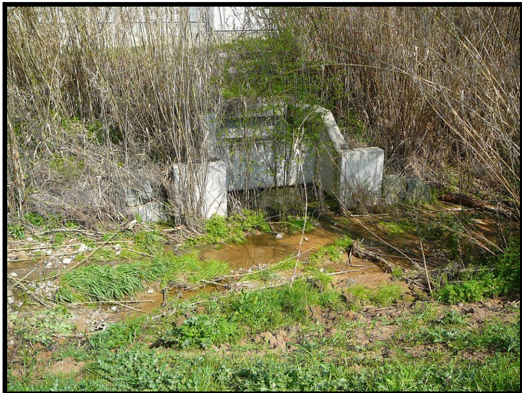
22. Desagüe aguas abajo de la estación de bombeo.
