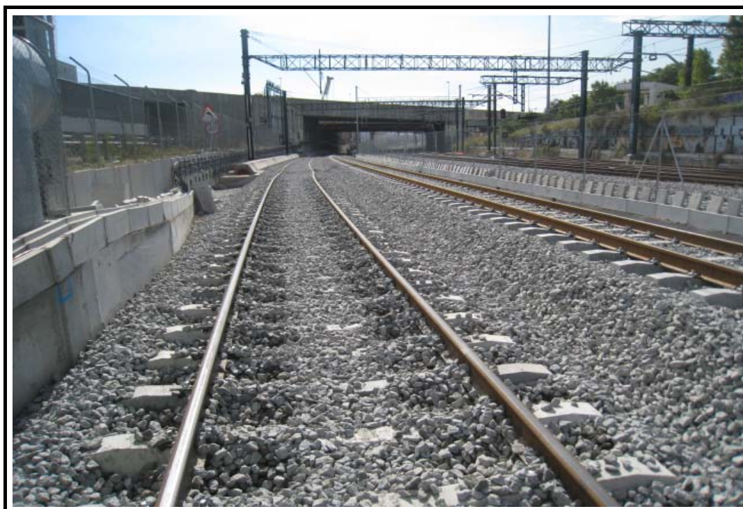
Foto 2: Vista superior de la superestructura
