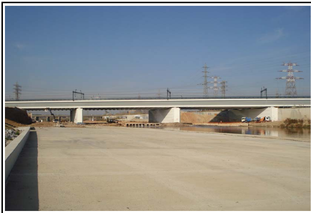
Foto 1: Vista general de la estructura
