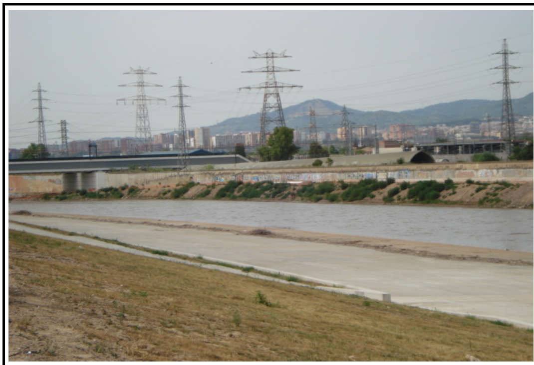
Foto 7: Vista general de margen izquierda aguas abajo
