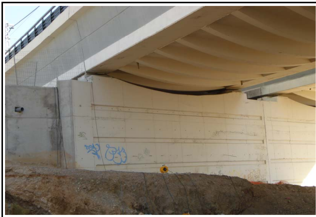
Foto 3: Vista lateral de estribo
