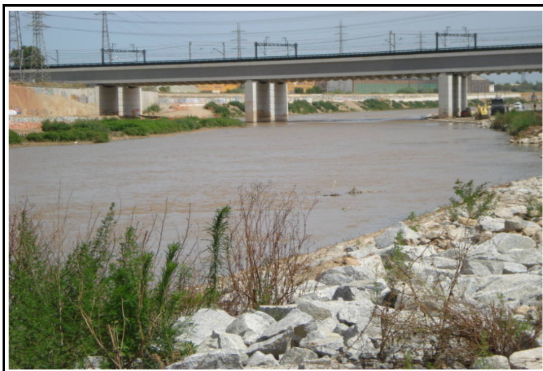
Foto 2: Vista general del cauce aguas arriba
