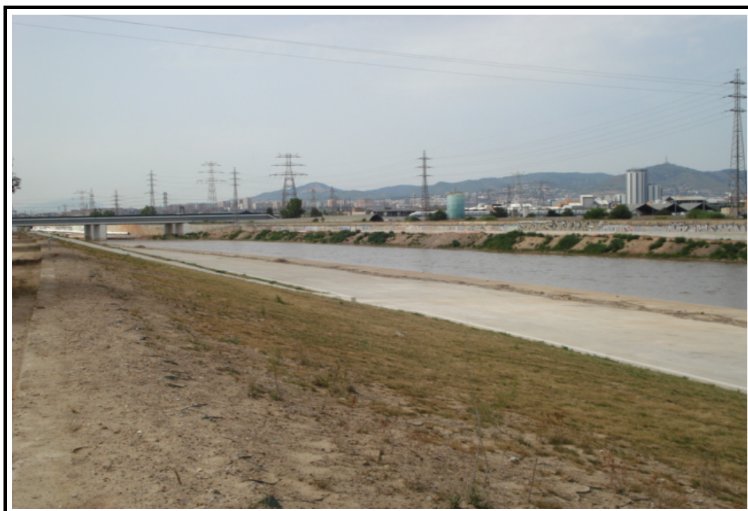
Foto 6: Vista general de margen derecha aguas abajo
