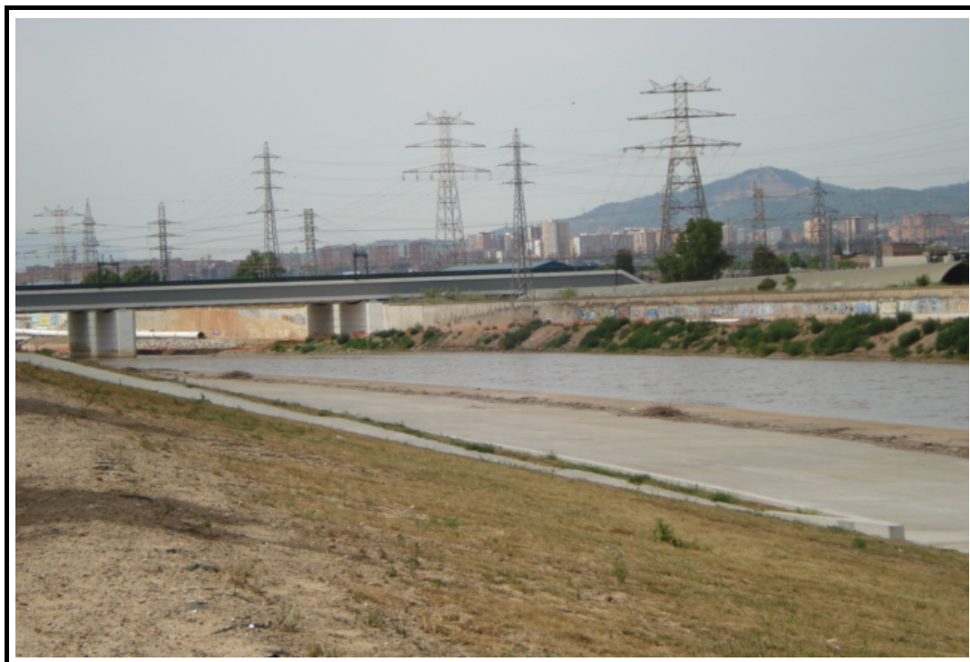
Foto 3: Vista general del cauce aguas abajo
