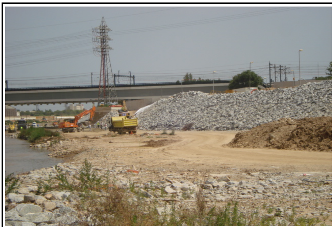
Foto 4: Vista general de margen derecha aguas arriba
