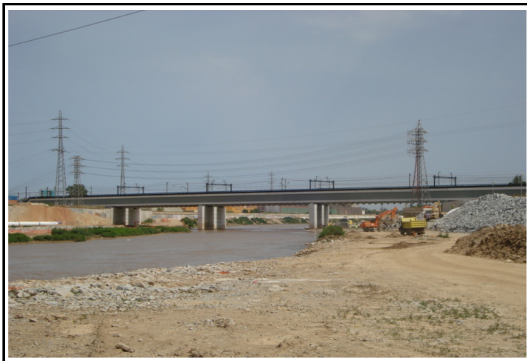
Foto 1: Vista general de la estructura
