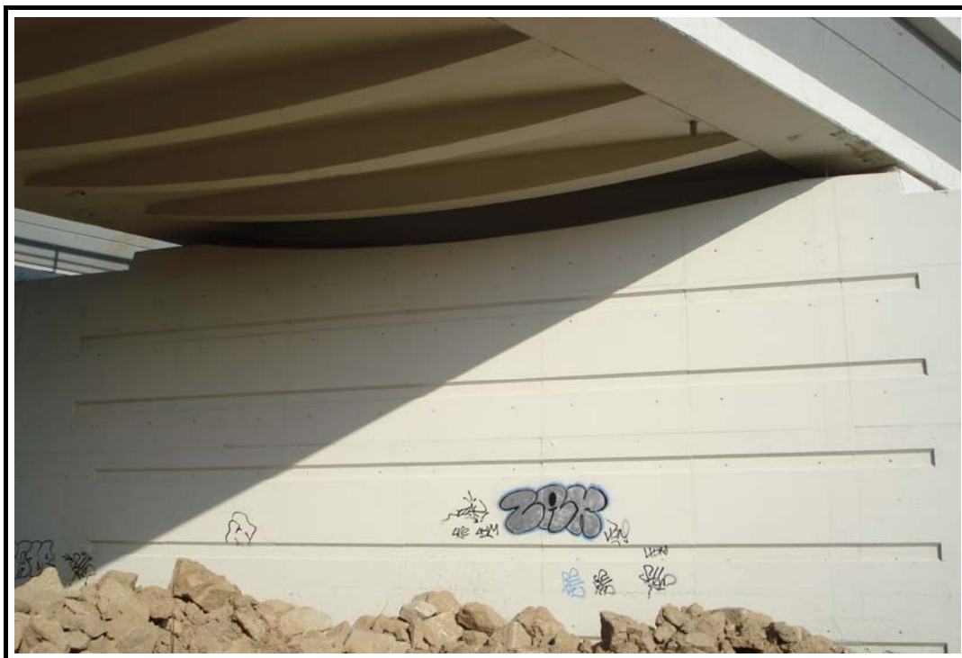
Foto 2: Vista General de las pilas
