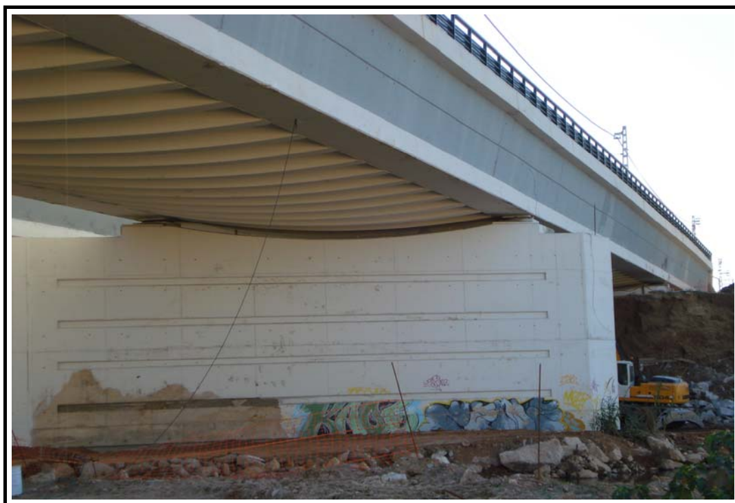
Foto 4: Vista de pilar
