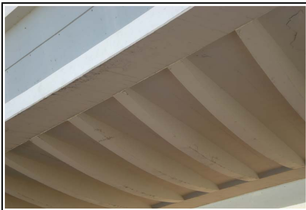
Foto 2: Vista inferior del tablero
