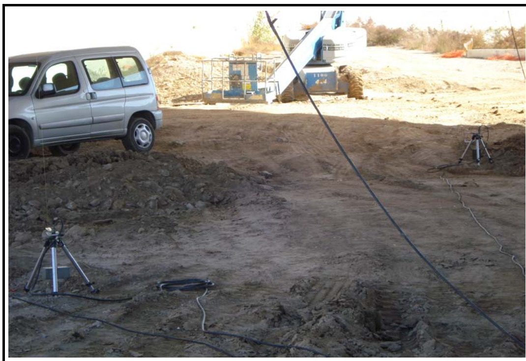
Foto 5: Línea de ménsulas para la medida de flecha en centro de vano
