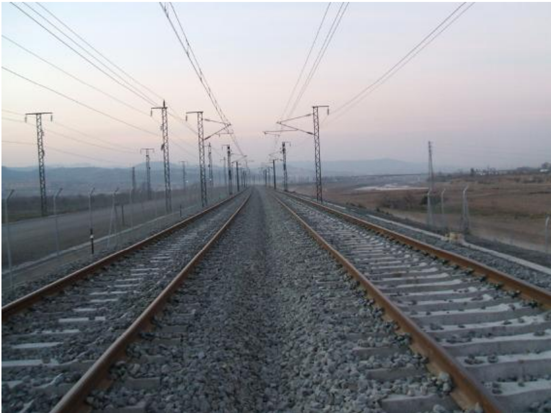
FOTOGRAFIA N°2: Vista superior desde la entrada en dirección Barcelona.
