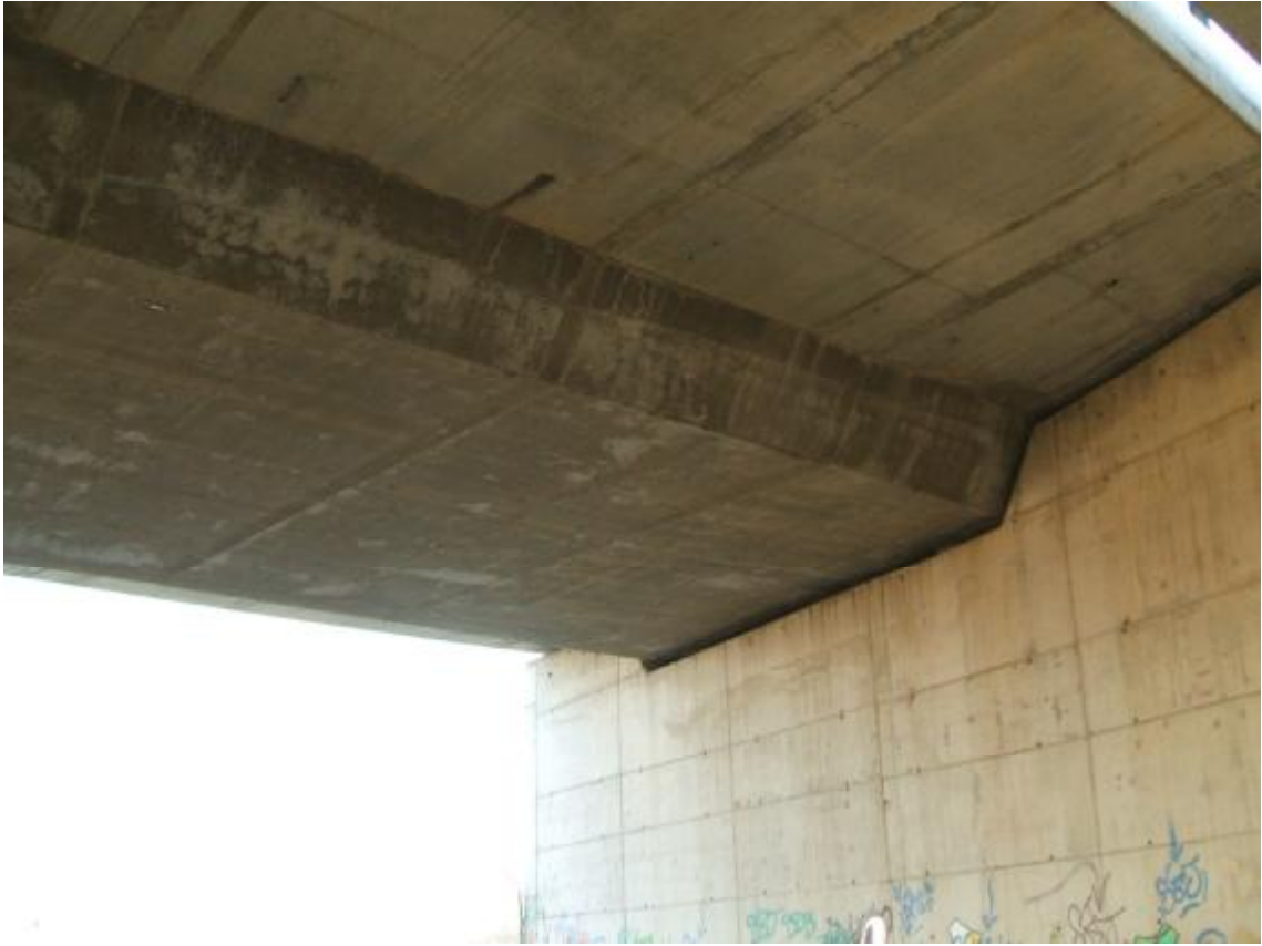
FOTOGRAFIA N°7: Estribo de salida con dirección Barcelona.
