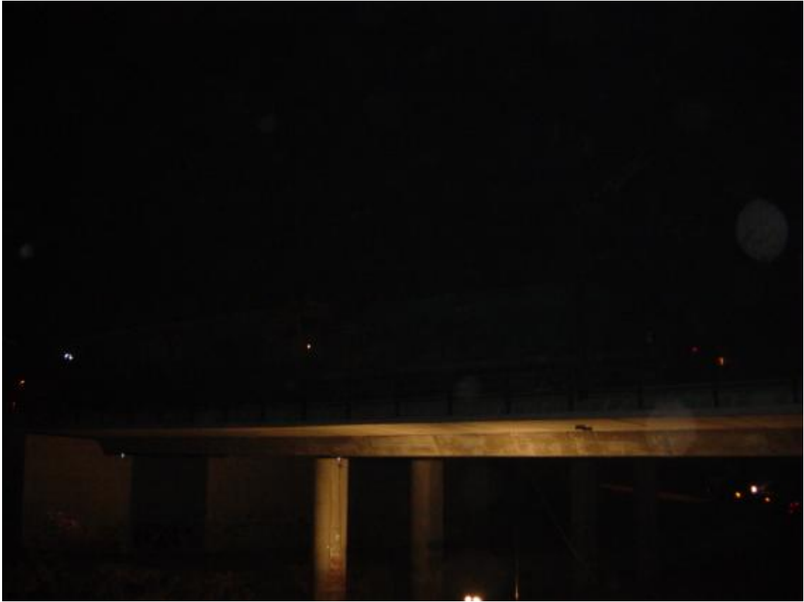
FOTOGRAFIA N°1: Detalle de la prueba estática con vanos continuos.
