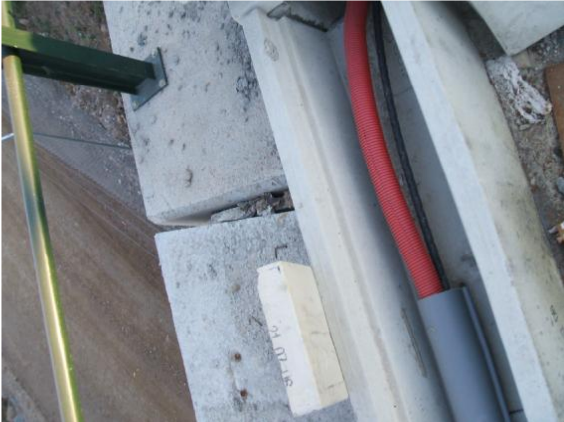
FOTOGRAFIA N°15: Detalle de las juntas de dilatación a la entrada del viaducto.
