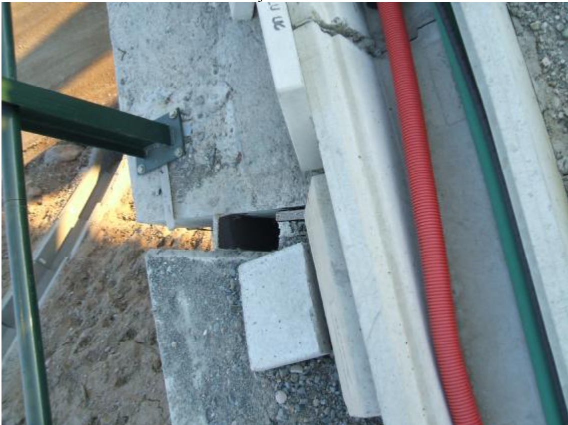
FOTOGRAFIA N°16: Detalle de la junta de dilatación a la salida del viaducto.
