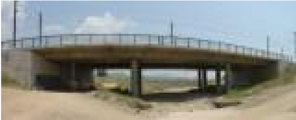
FOTOGRAFÍA Nº 12: TORRELLES DESDE AGUAS ARRIBA.
