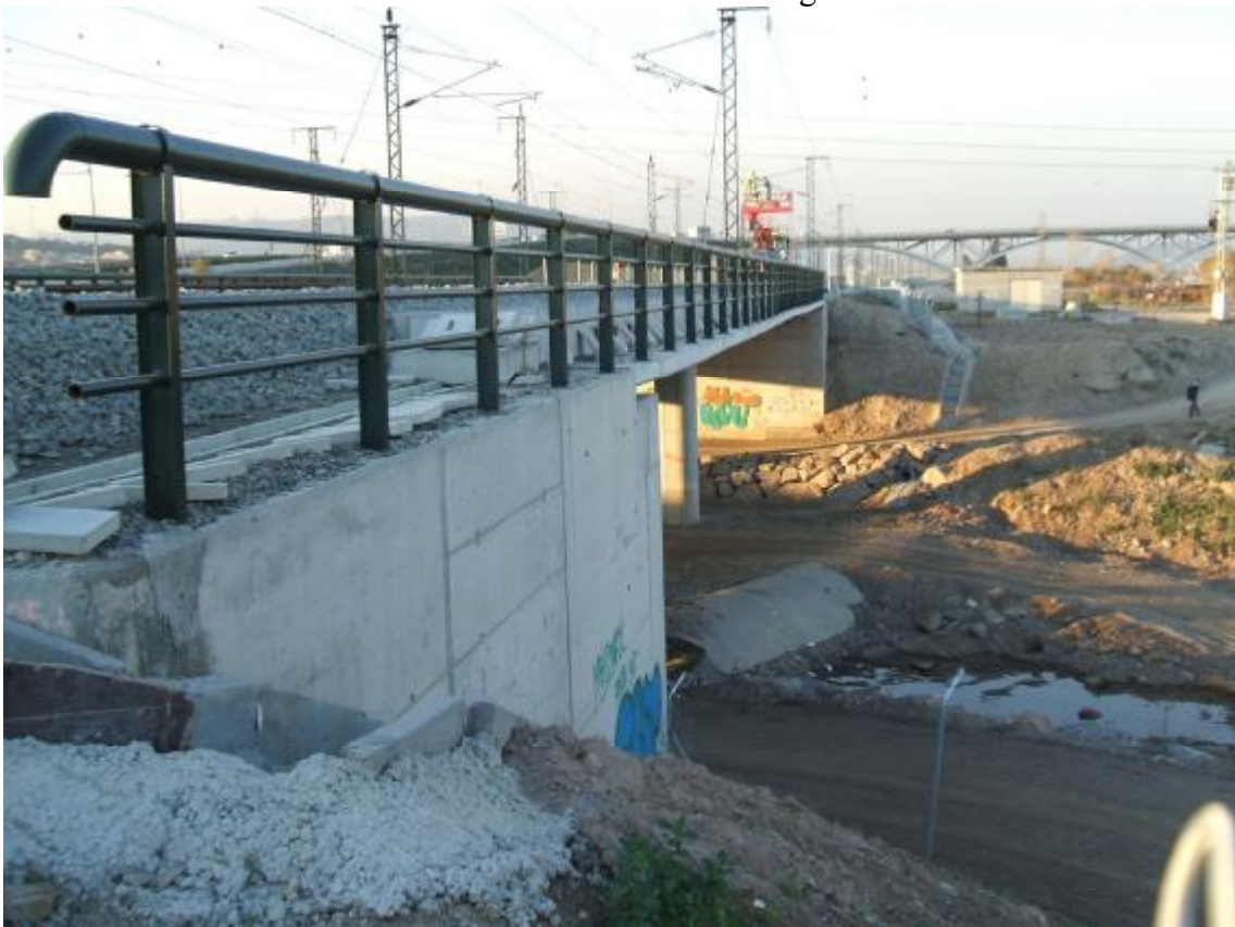
FOTOGRAFIA N°14: Detalle de la evacuación del drenaje de agua.
