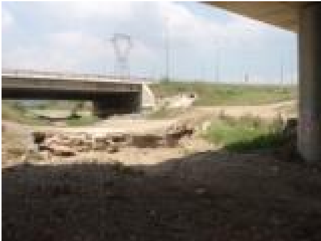
FOTOGRAFÍA Nº 11: TORRELLES DESDE AGUAS ABAJO.
