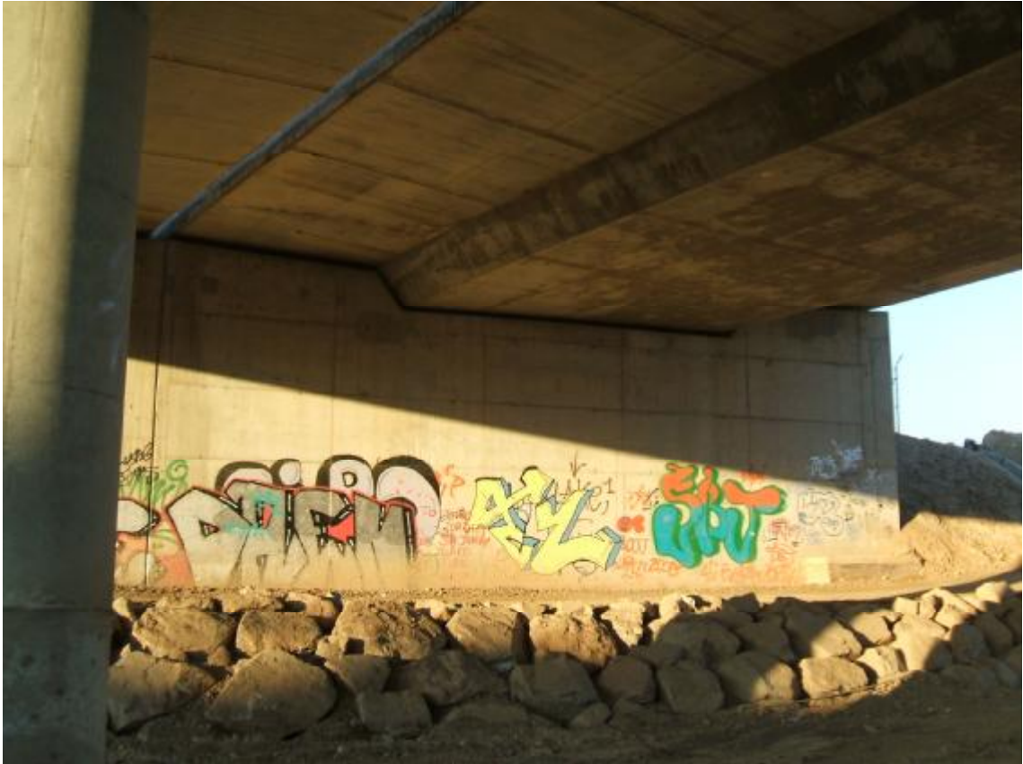
FOTOGRAFIA N°5: Estribo de entrada con dirección Barcelona.
