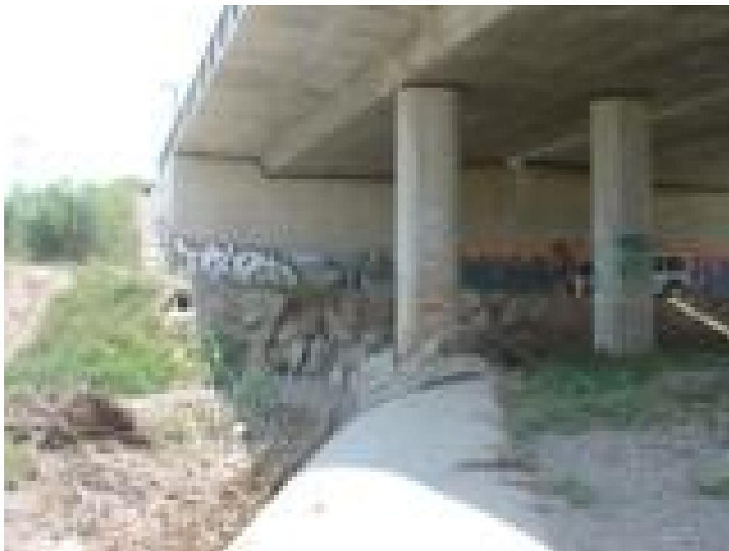
FOTOGRAFÍA N° 2: DRENAJE ESTRIBO DERECHO (E2) A AGUAS ABAJO
