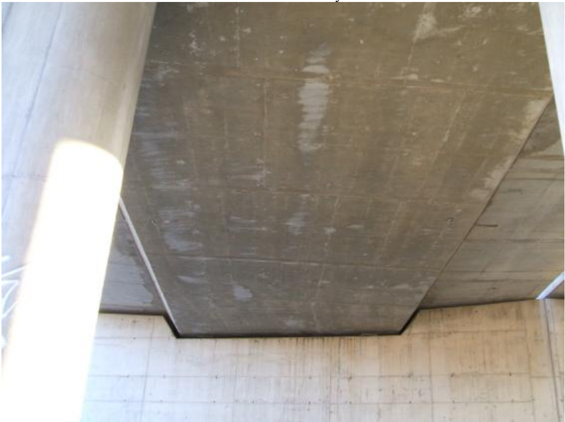
FOTOGRAFIA N°10: Apoyo de la losa sobre el estribo.
