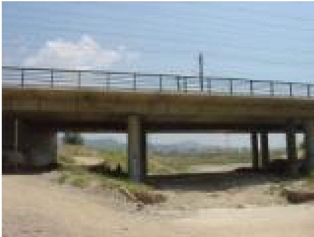
FOTOGRAFÍA Nº 1: CAUCE DESDE AGUAS ARRIBA
