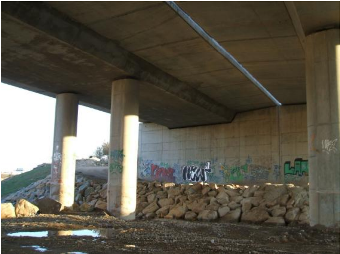
FOTOGRAFIA N°6: Estribo de entrada con dirección Barcelona.
