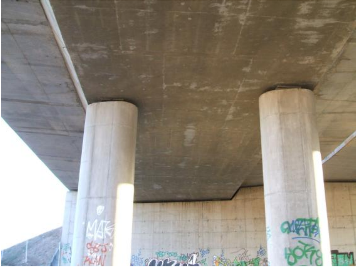
FOTOGRAFIA N°11: Vista del otro apoyo entre losa y estribo.
