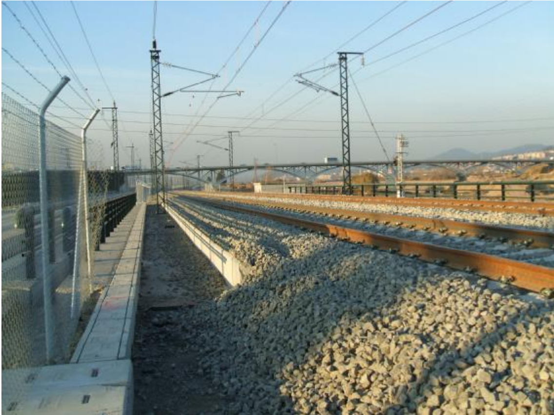
FOTOGRAFIA N°13: Detalle del muro guardabalasto.
