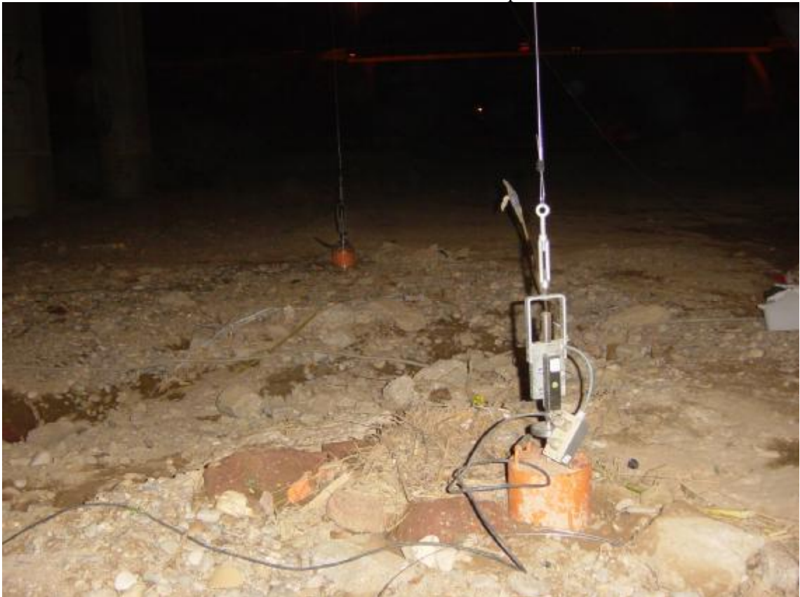
FOTOGRAFIA N°4: Vista de la instrumentación utilizada en centro de vano.
