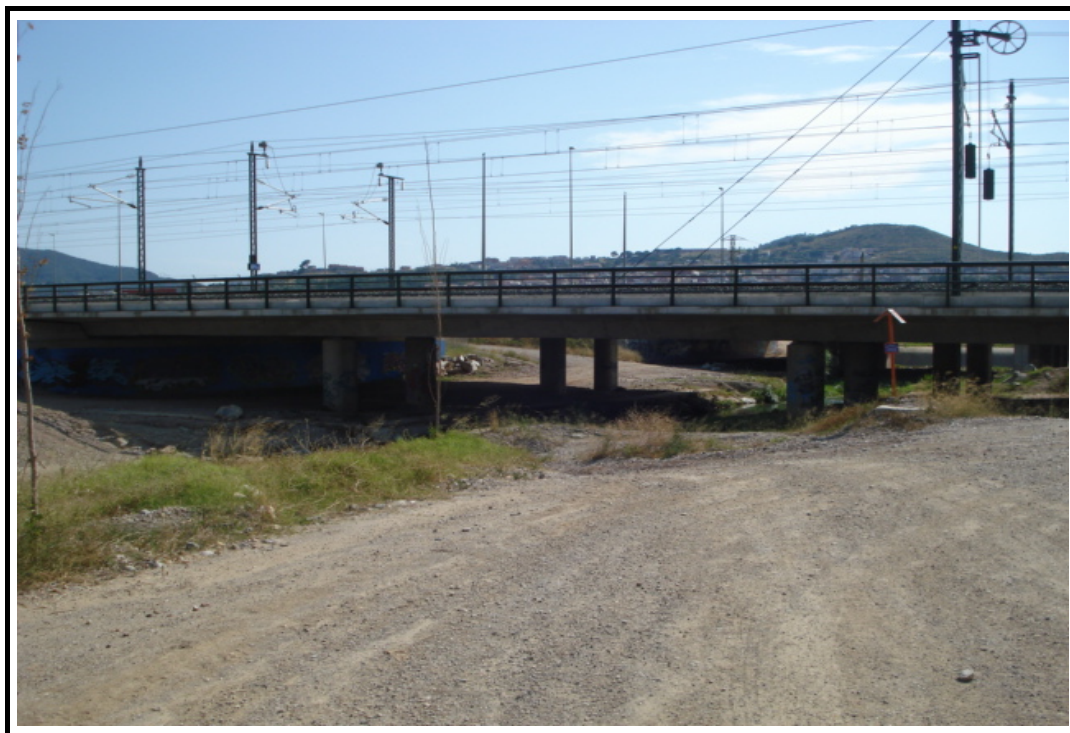
Foto 1: Vista general de la estructura_1
