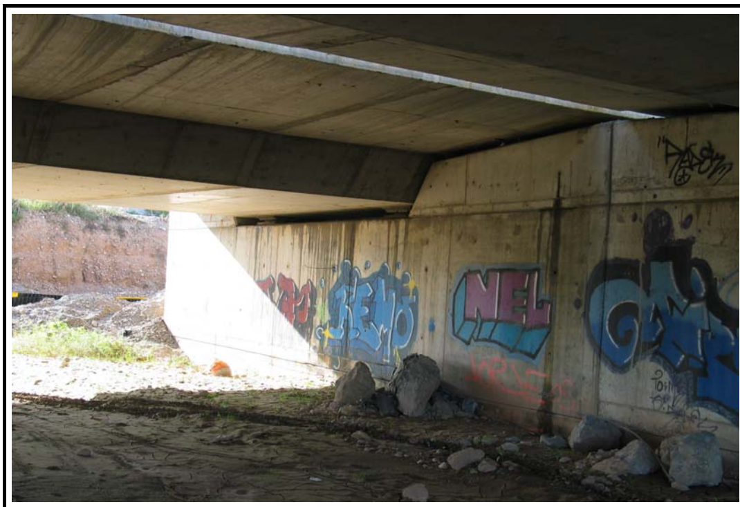
Foto 3: Vista del estribo de entrada de la estructura.
