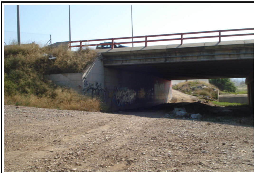
Foto 11: Vista general de margen derecha aguas arriba
