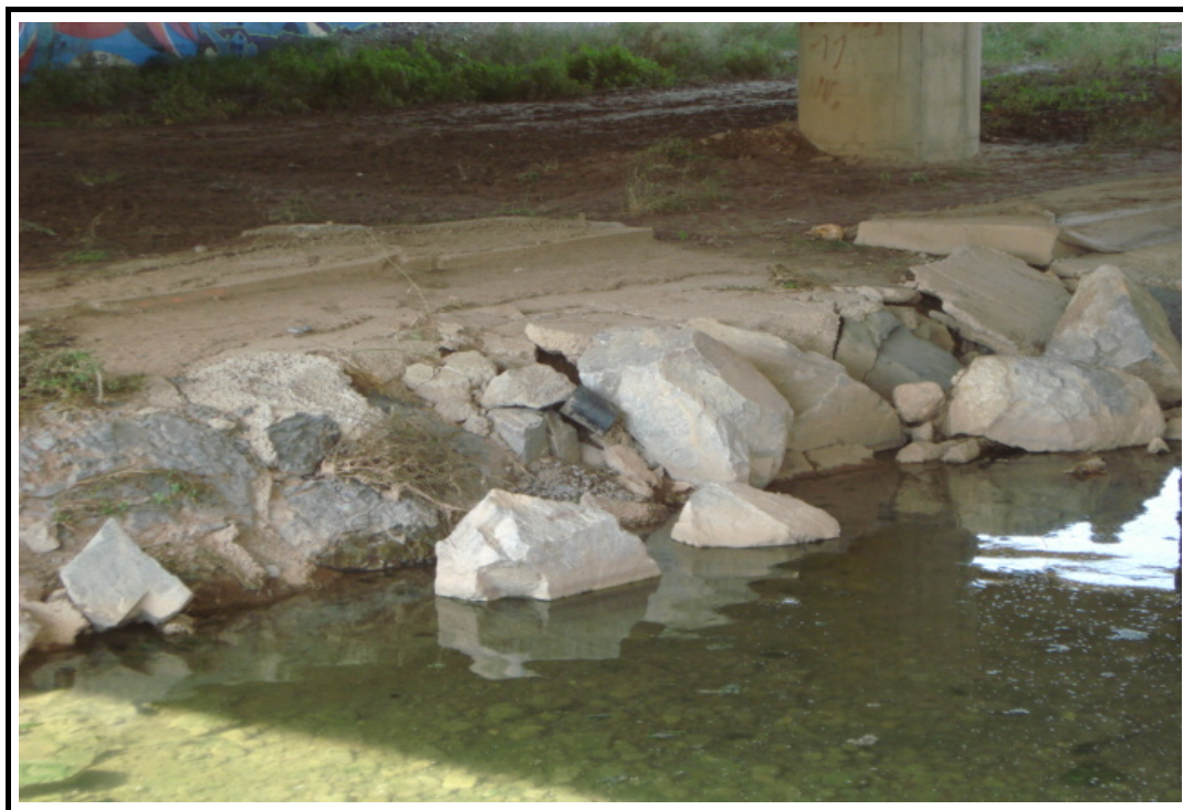
Foto 15: Escollera en margen izquierda bajo la estructura
