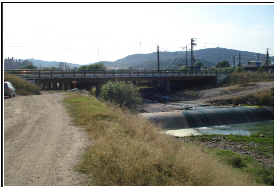
Foto 2: Vista general de la estructura_2
