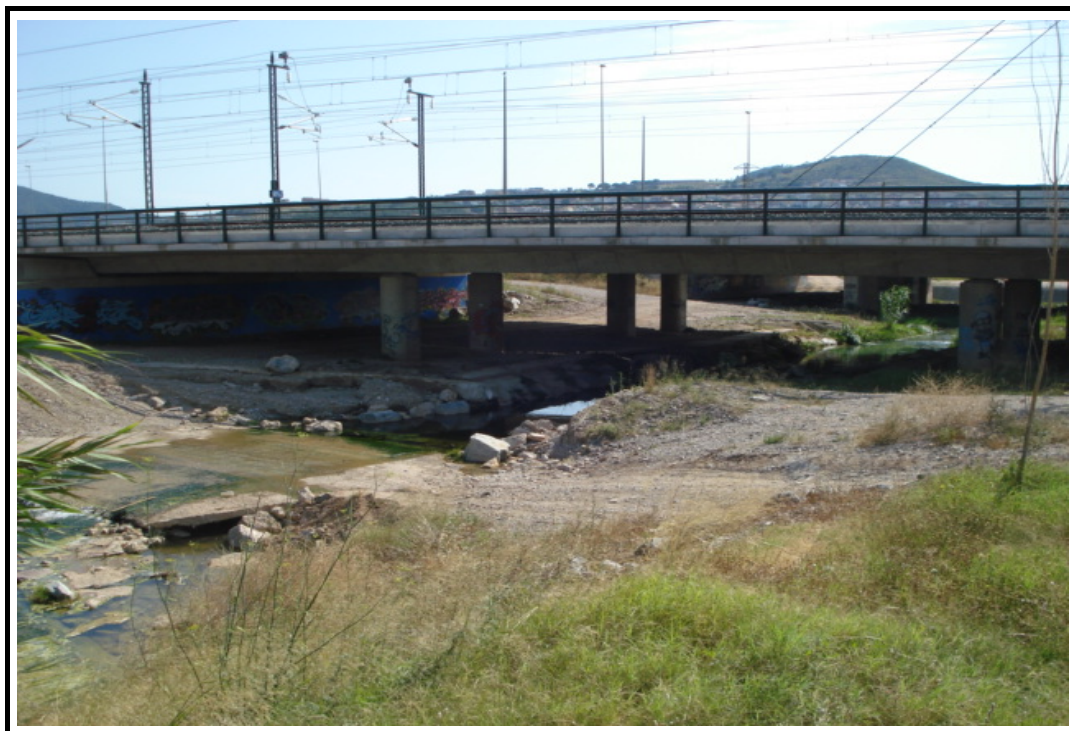
Foto 3: Vista general de la estructura_3
