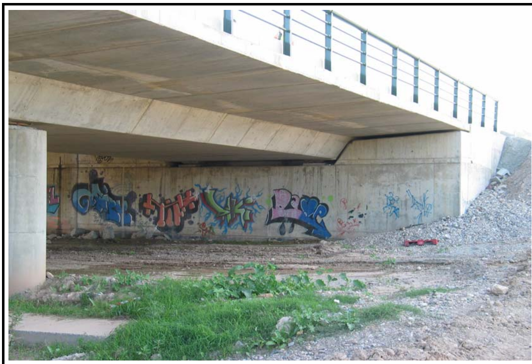
Foto 3: Estribo de entrada
