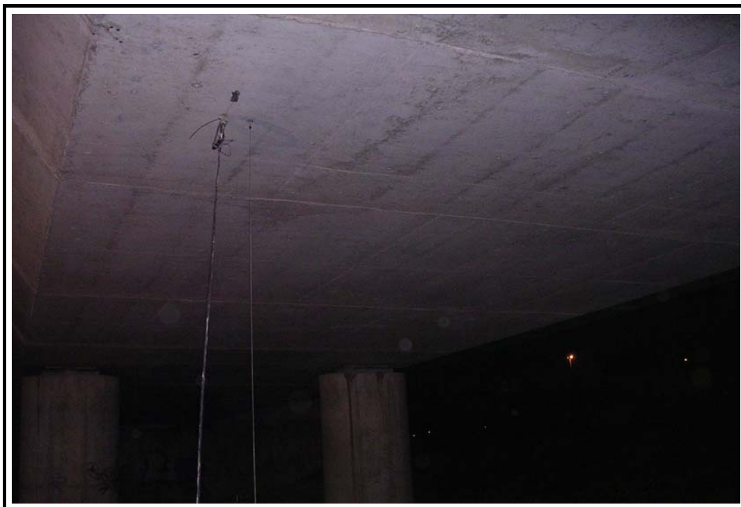
Foto 7: Bandas extensométricas para la medida de deformaciones unitarias en centro de vano.
