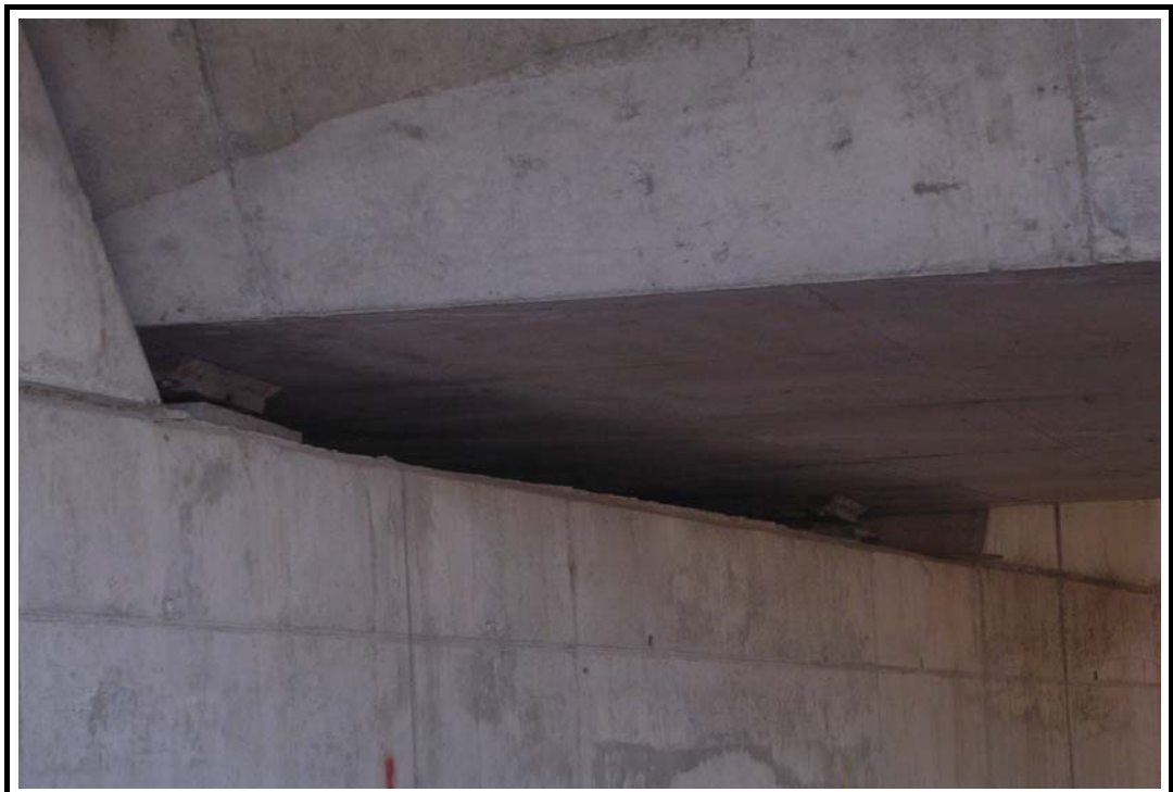
Foto 10: Detalle de apoyos
