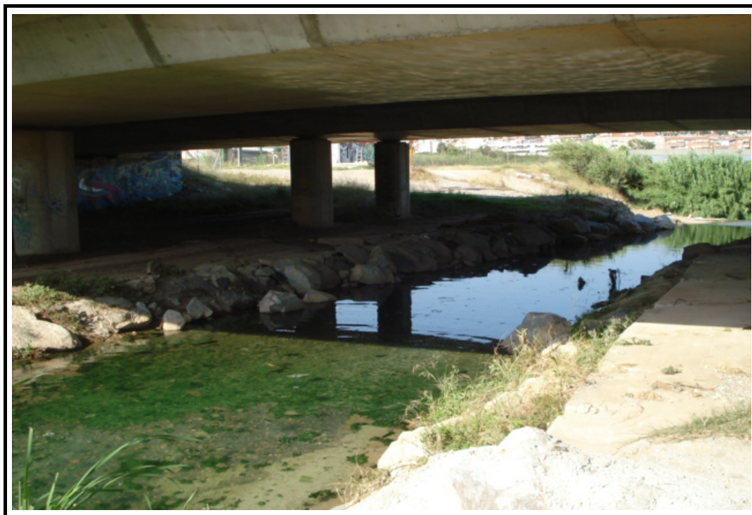
Foto 5: Vista general del cauce bajo la estructura_2
