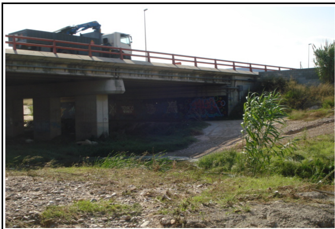
Foto 12: Vista general de margen izquierdo aguas arriba
