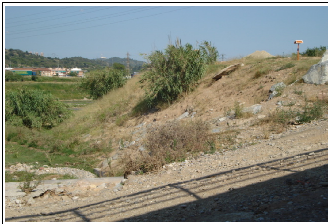
Foto 13: Vista general de margen derecha aguas abajo
