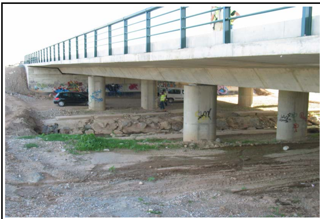
Foto 1: Vista general de la estructura.
