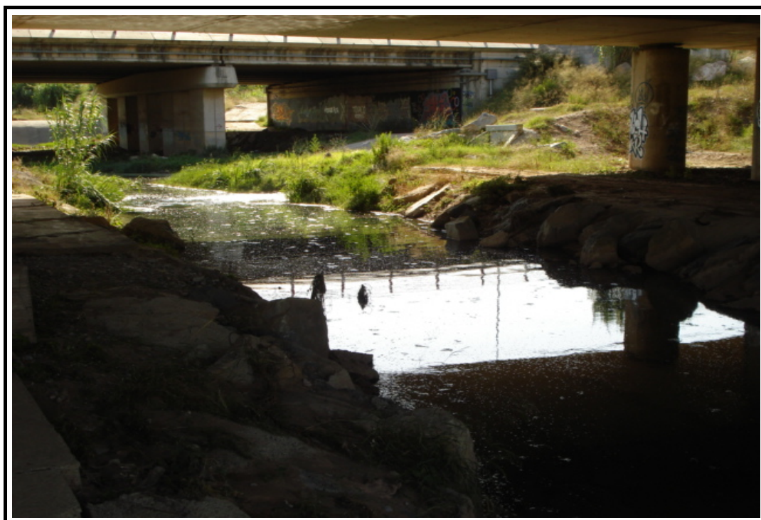
Foto 4: Vista general del cauce bajo la estructura_1
