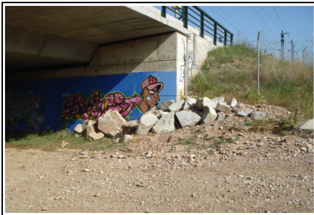
Foto 17: Escollera en estribo de salida
