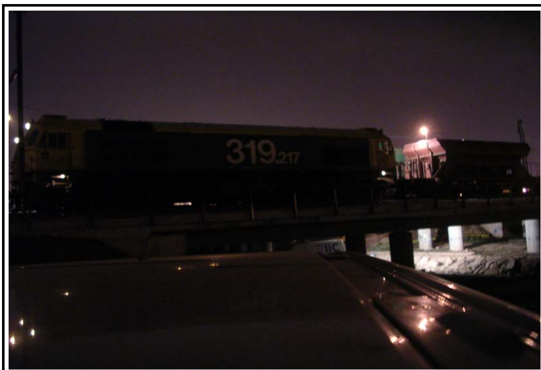
Foto 12: Ensayo estático. Vista lateral de la sobrecarga.
