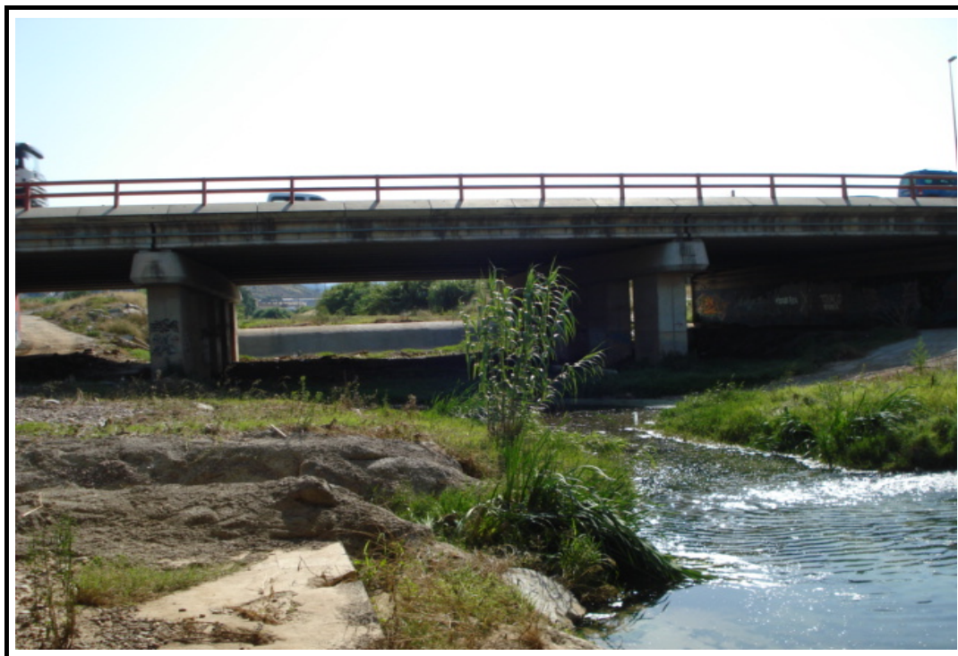
Foto 7: Vista general del cauce aguas arriba
