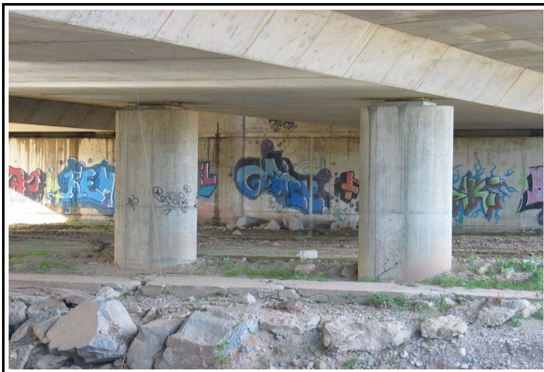
Foto 4: Vista de las pilas de la estructura.
