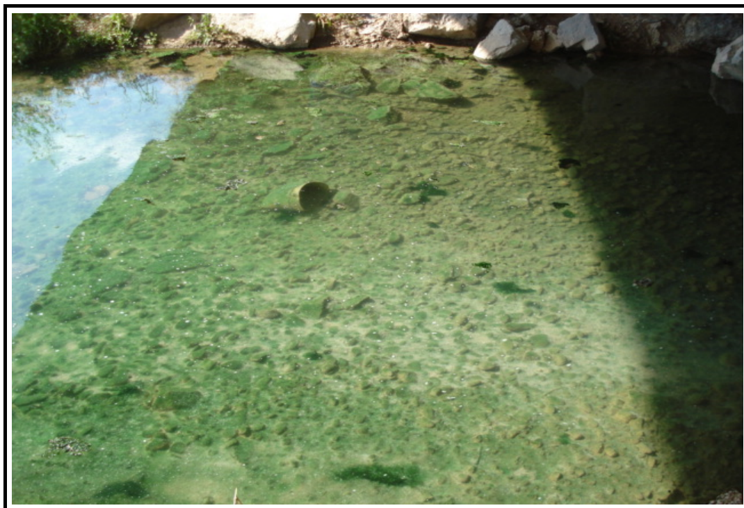
Foto 6: Vista del cauce bajo la estructura
