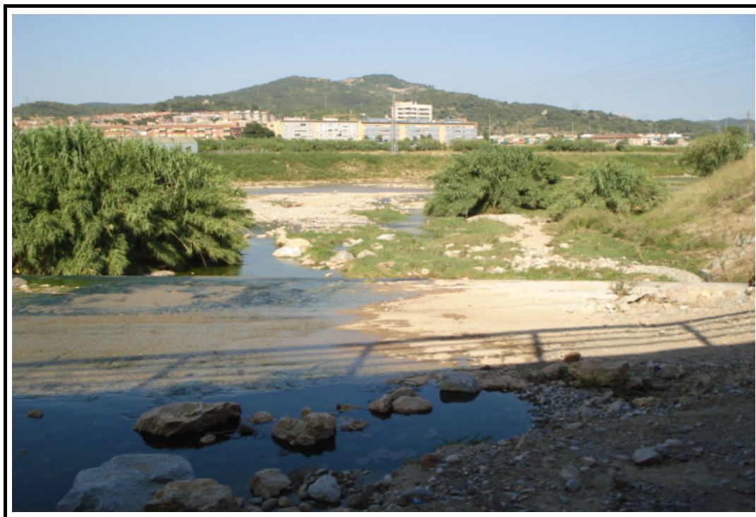
Foto 9: Vista general del cauce aguas abajo_2
