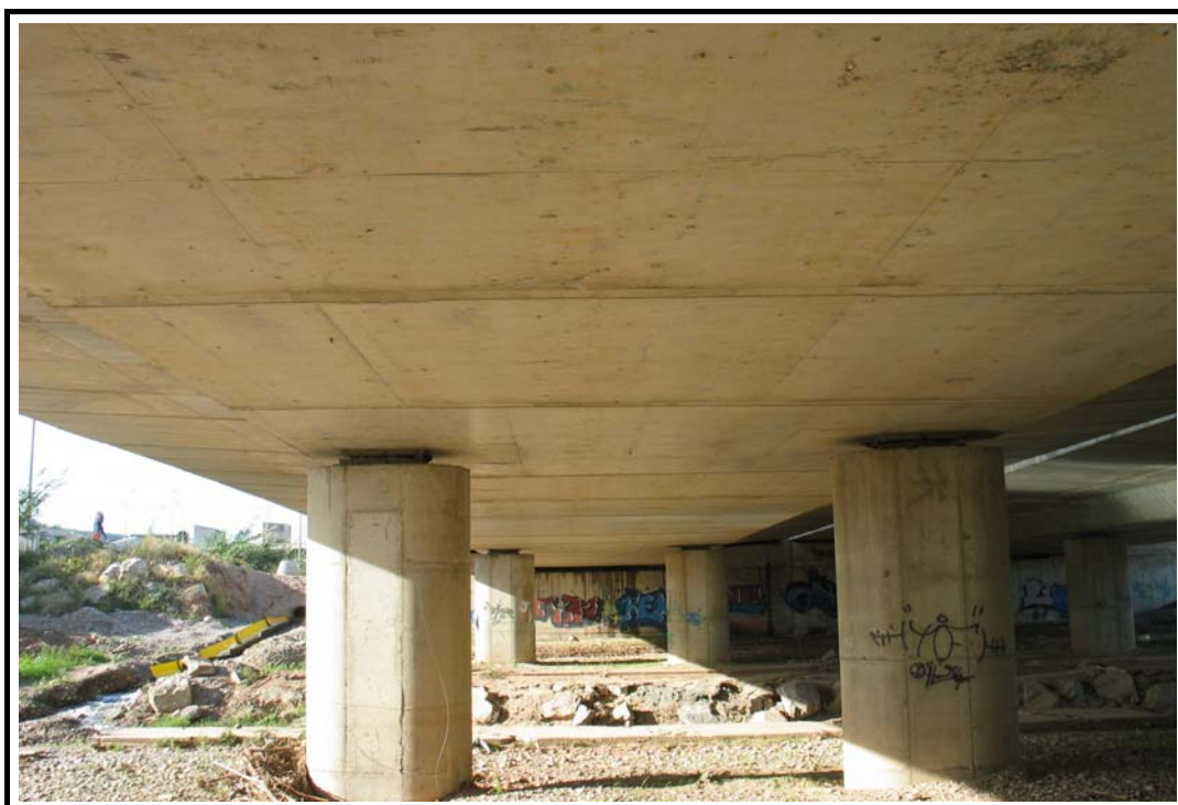
Foto 2: Vista inferior del tablero de la estructura.
