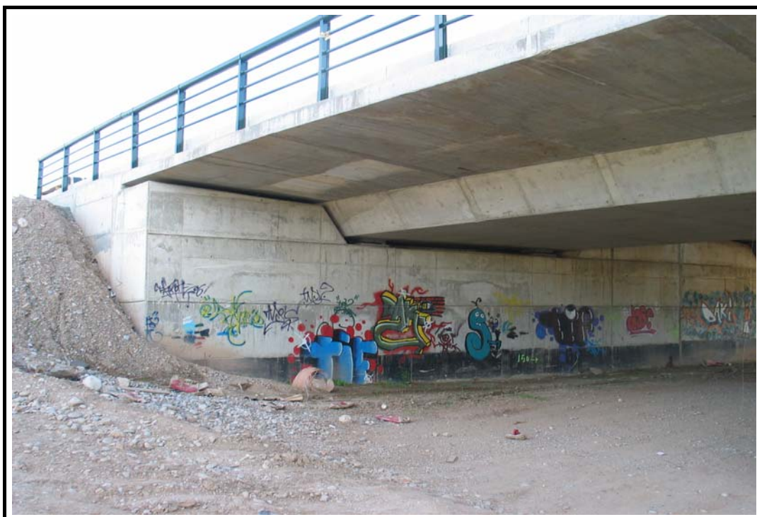
Foto 4: Estribo de salida
