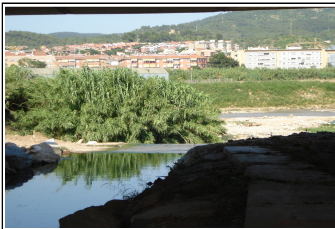
Foto 8: Vista general del cauce aguas abajo_1
