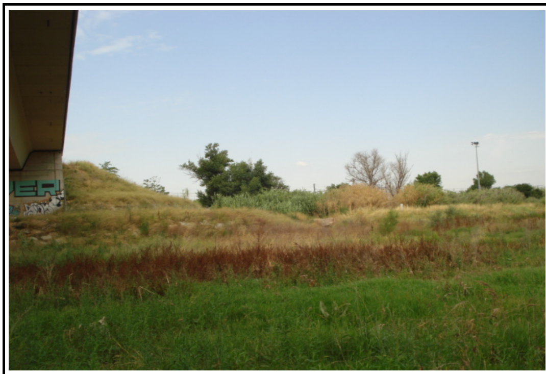
Foto 9: Vista general de margen derecha aguas arriba
