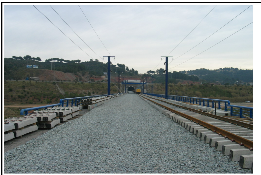
Foto 3: Vista superior desde entrada
