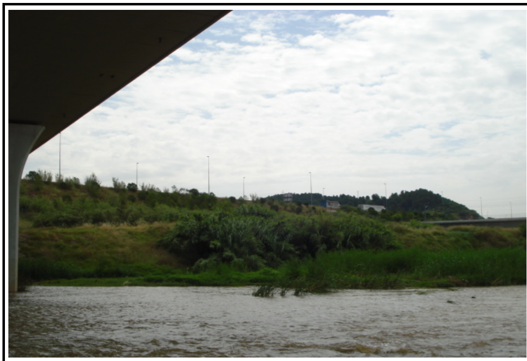
Foto 13: Vista general de margen derecha aguas abajo
