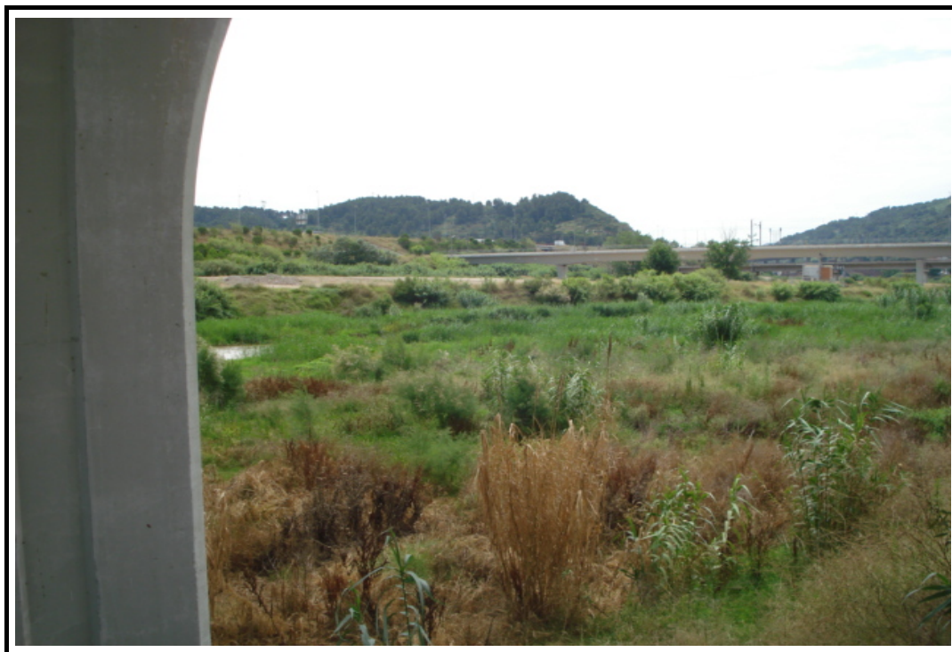
Foto 7: Vista general del cauce aguas abajo_1
