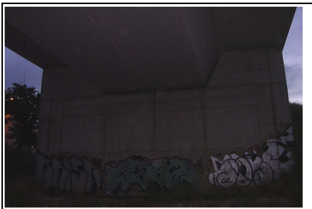
Foto 4: Estribo de entrada
