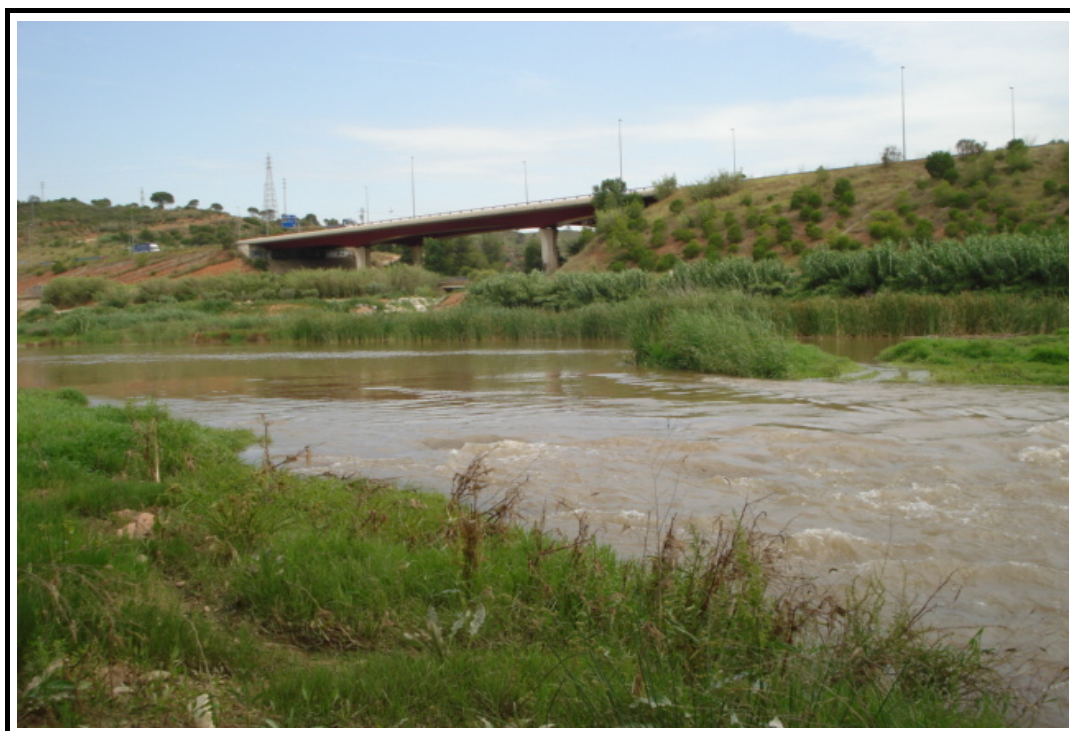
Foto 6: Vista general del cauce aguas arriba_3
