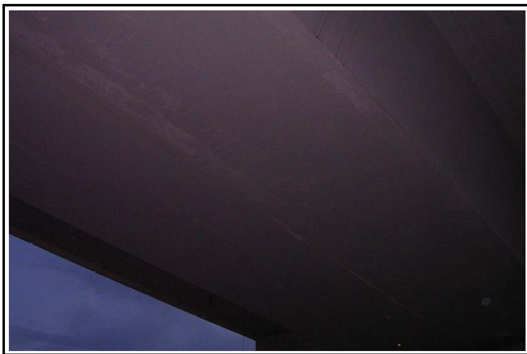
Foto 5: Vista Inferior Tablero
