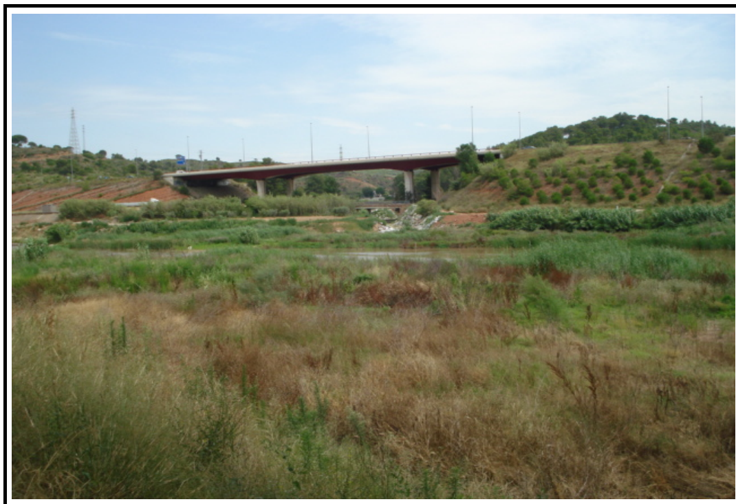
Foto 5: Vista general del cauce aguas arriba_2
