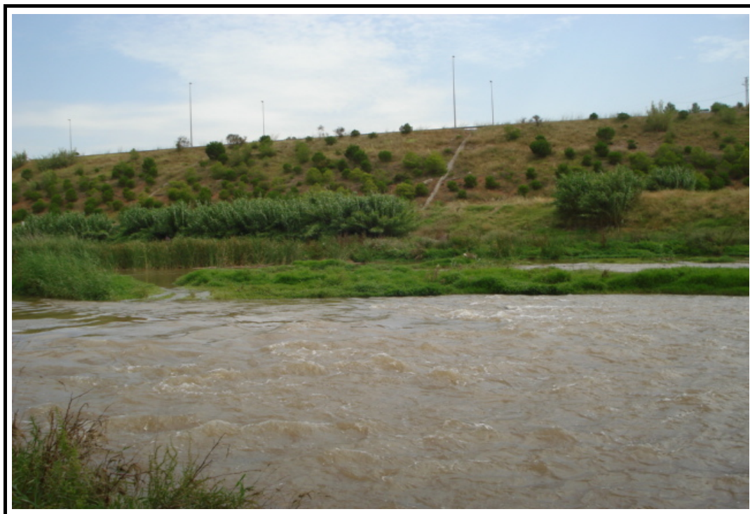
Foto 15: Barras en cauce aguas arriba
