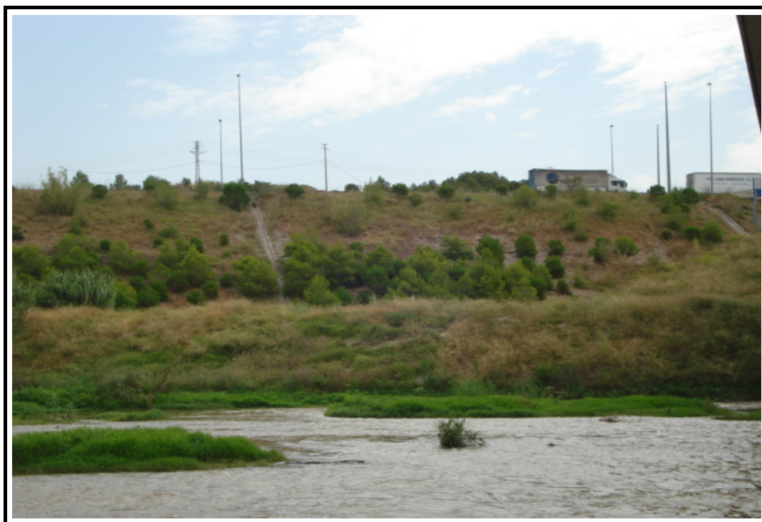
Foto 10: Vista general de margen izquierda aguas arriba
