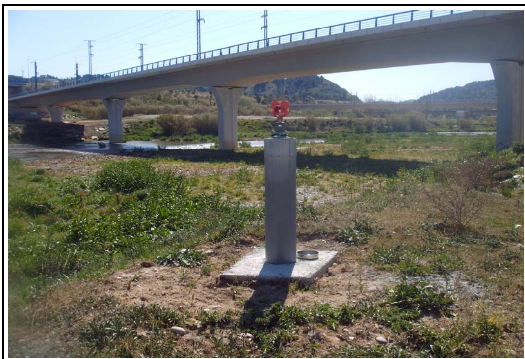
Foto 2: Pilar de observación 2
