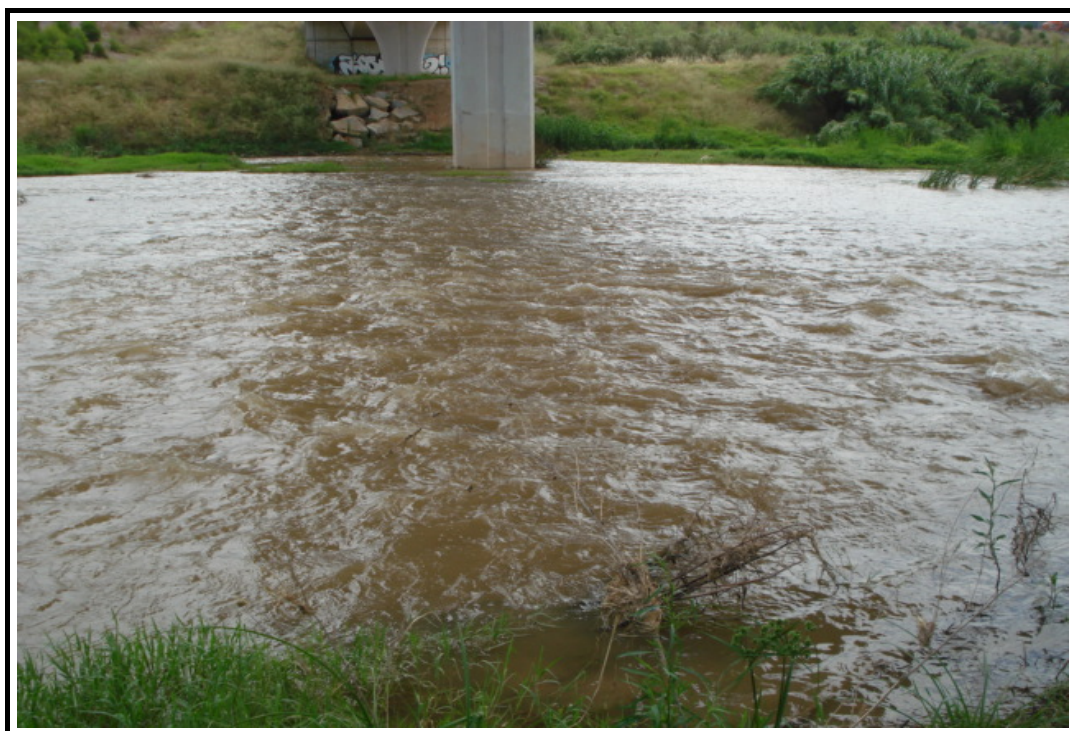
Foto 4: Vista general del cauce bajo la estructura_2
