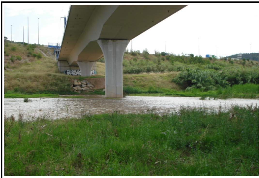
Foto 3: Vista general del cauce bajo la estructura_1
