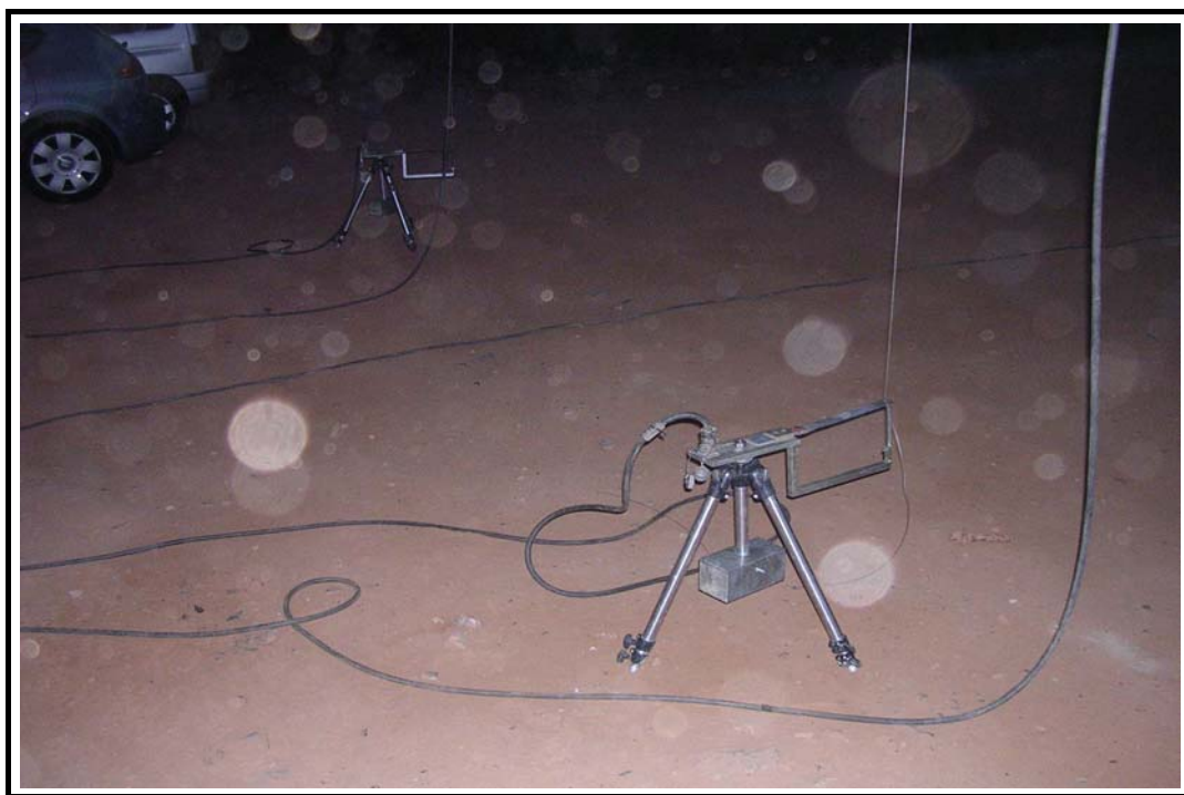
Foto 7: Línea de ménsulas para medida de flechas en centro de vano
