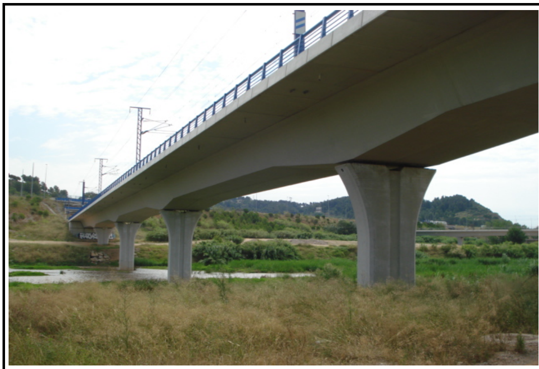
Foto 1: Vista general de la estructura
