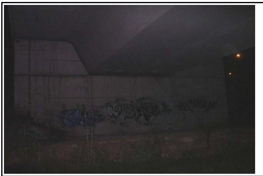
Foto 5: Estribo de salida
