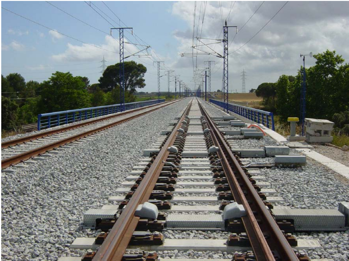
FOTOGRAFIA N°3: Vista superior desde entrada.
