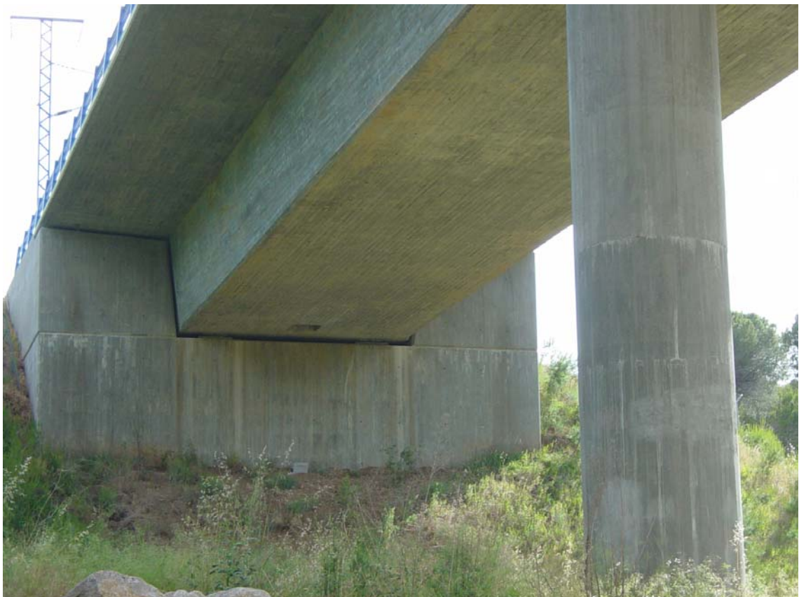
FOTOGRAFIA N°6: Estribo de salida.
