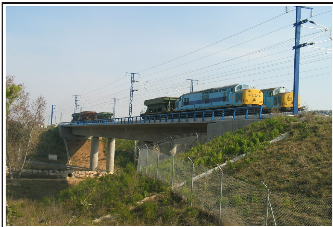
Foto 9: Vista frontal en prueba estática. Vanos 1 y 3
