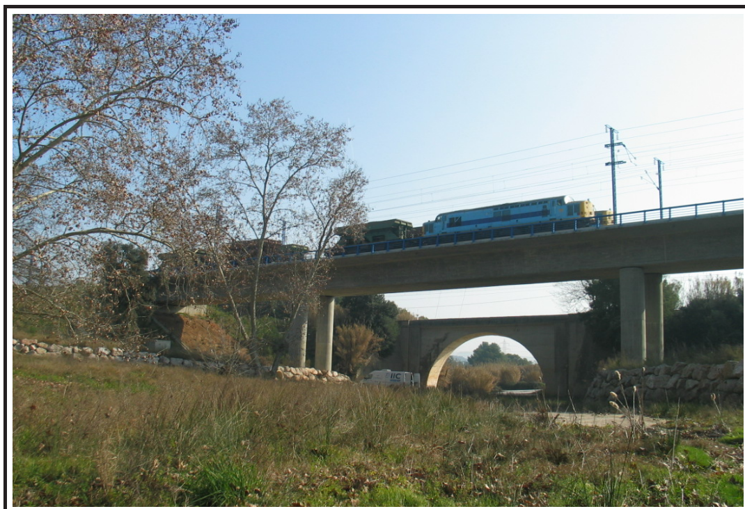
Foto 1: Vista general de la estructura
