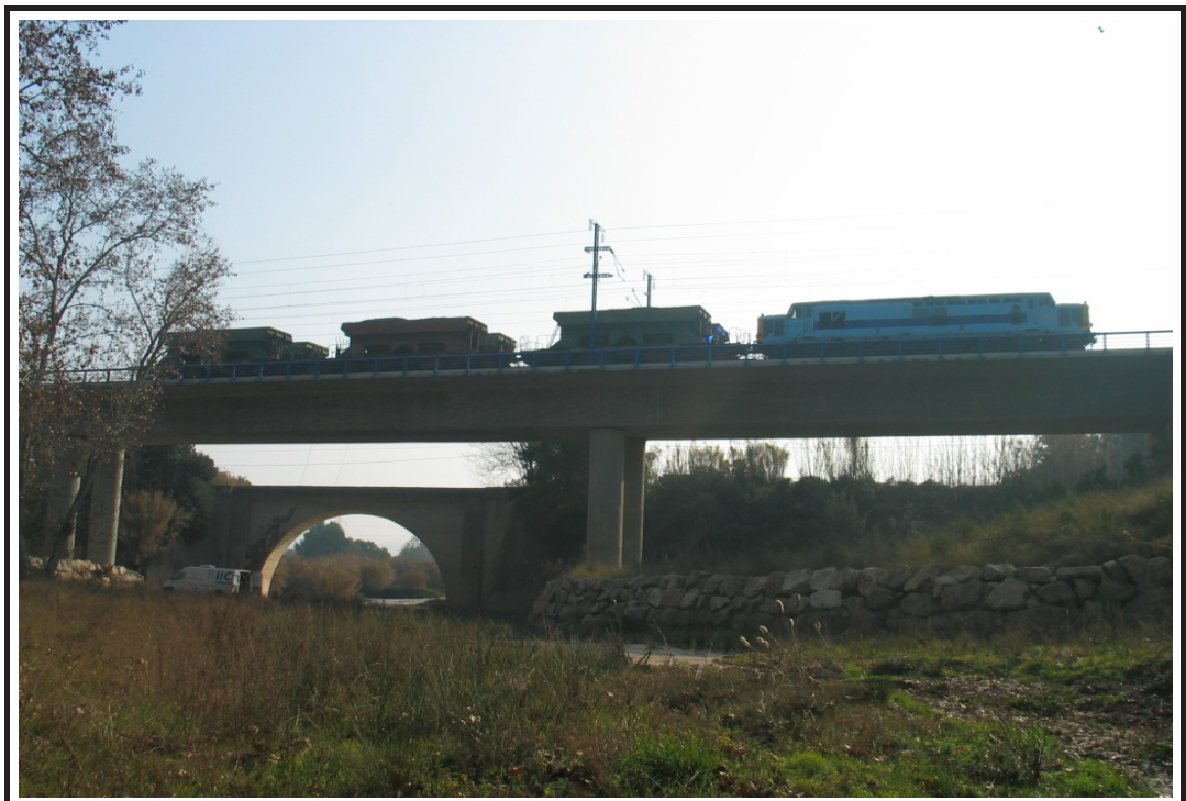
Foto 8: Vista lateral en prueba estática
