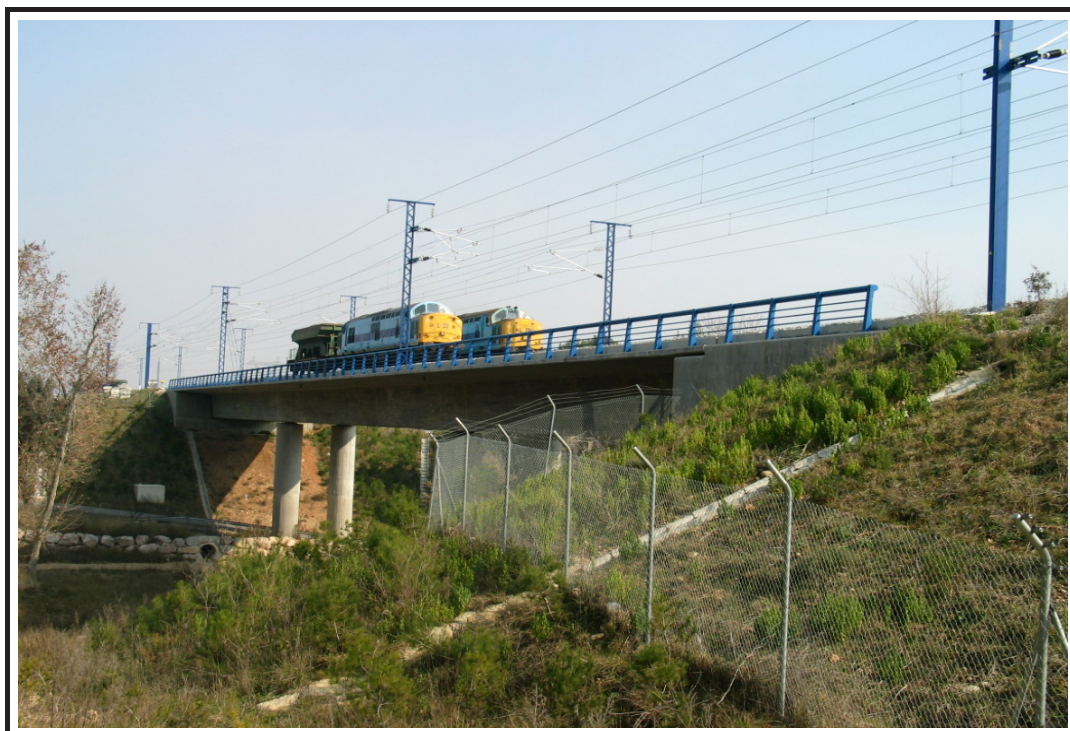
Foto 10: Vista frontal en prueba estática. Vano 2
