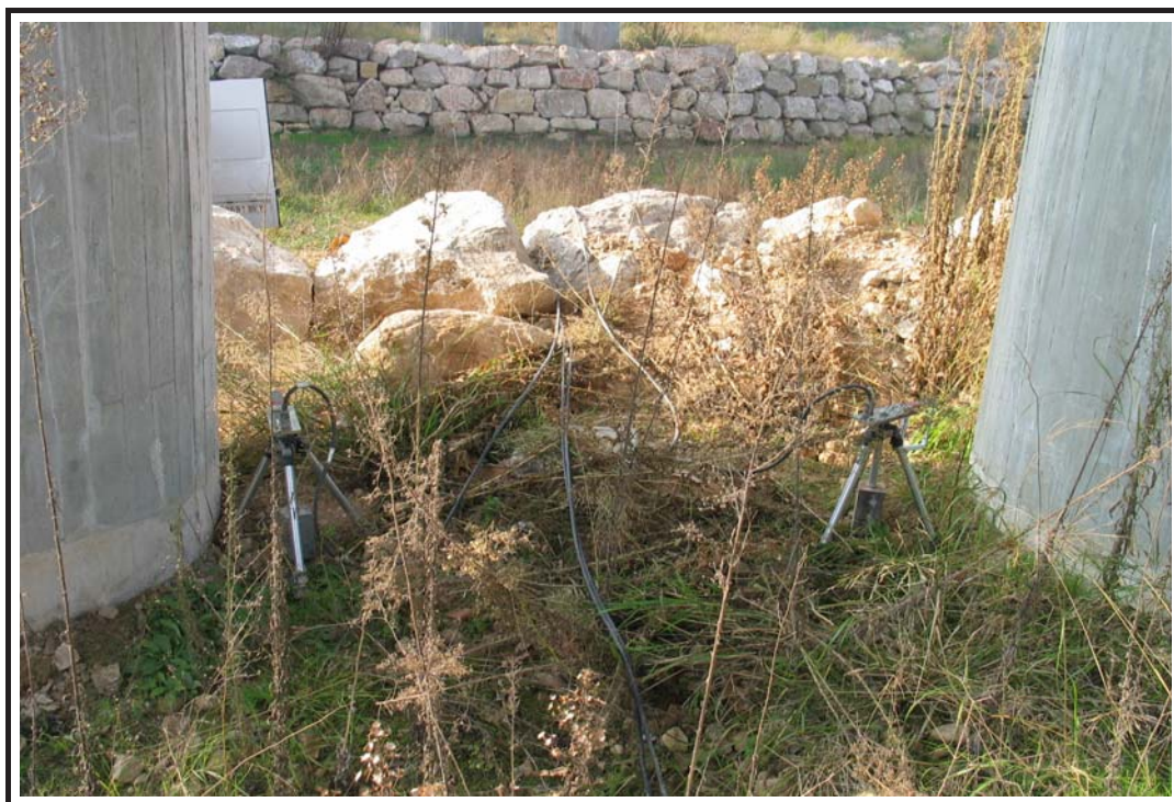
Foto 6: Ménsulas para la medida de flechas en apoyos
