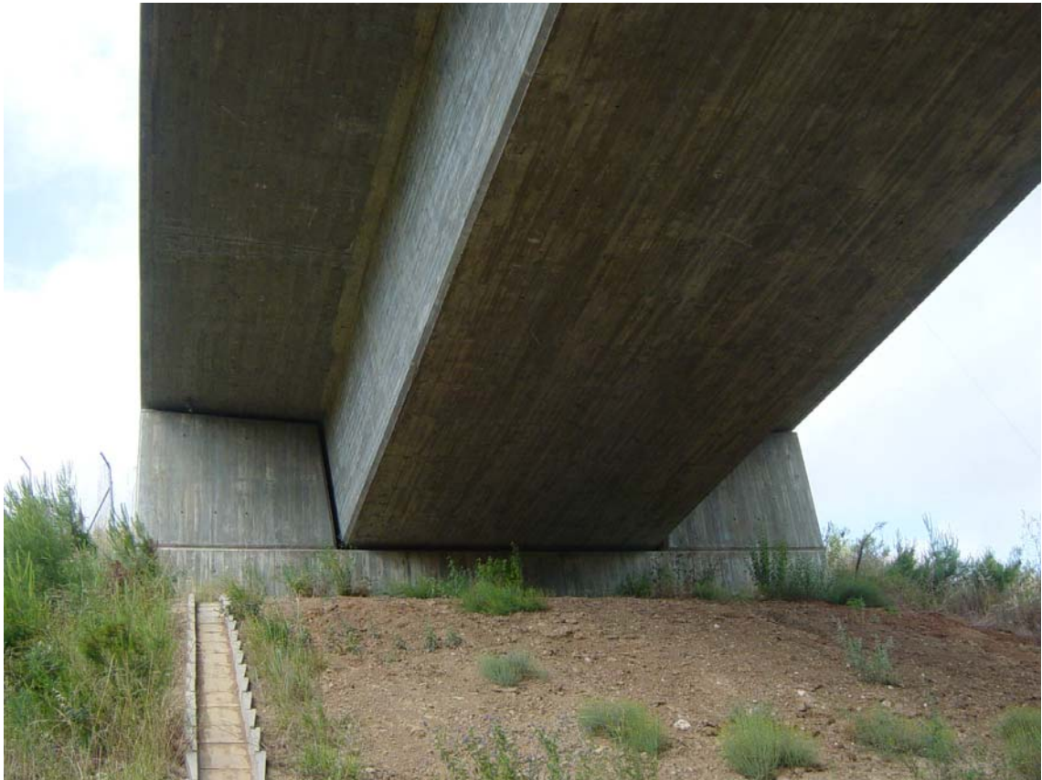
FOTOGRAFIA N°5: Estribo de entrada.
