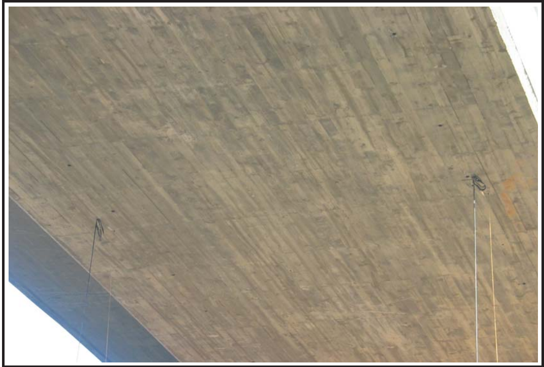
Foto 7: Bandas extensométricas para la medida de deformaciones en centro de vano
