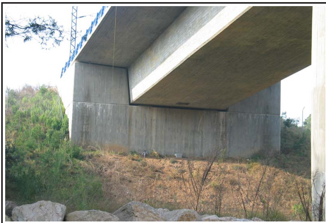
Foto 3: Vista general del estribo
