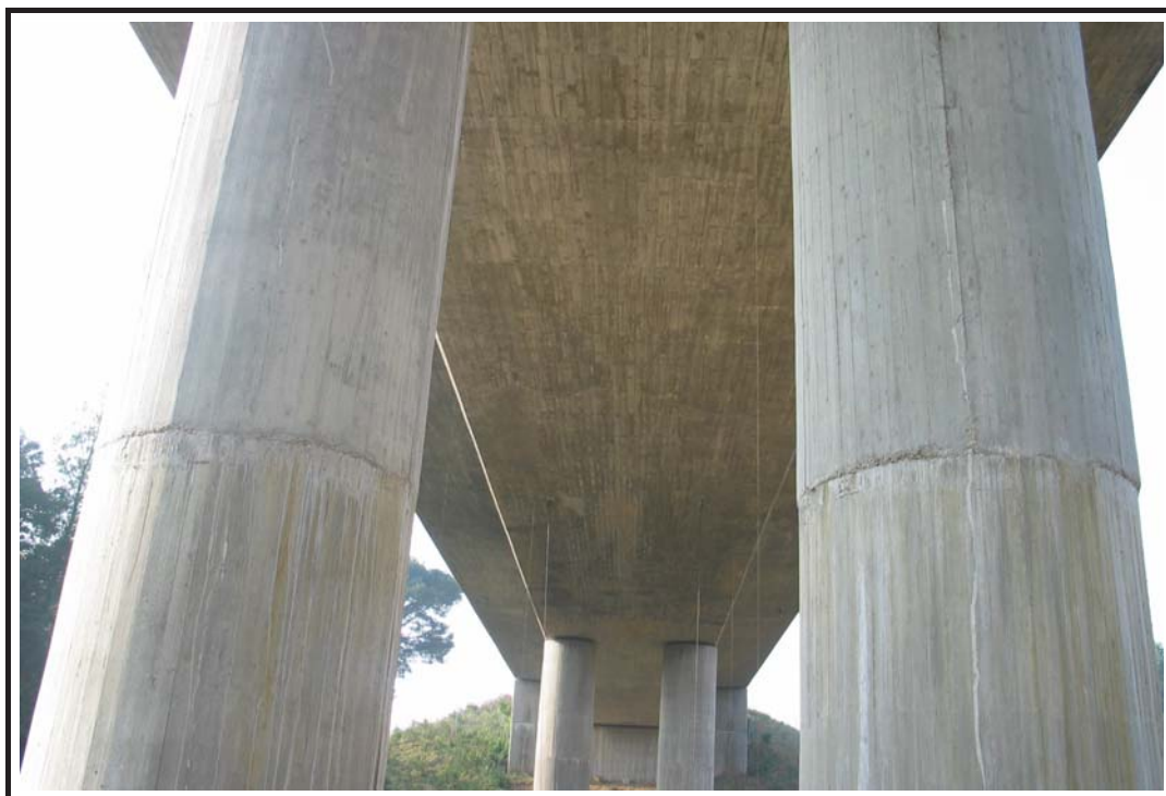
Foto 2: Vista inferior del tablero
