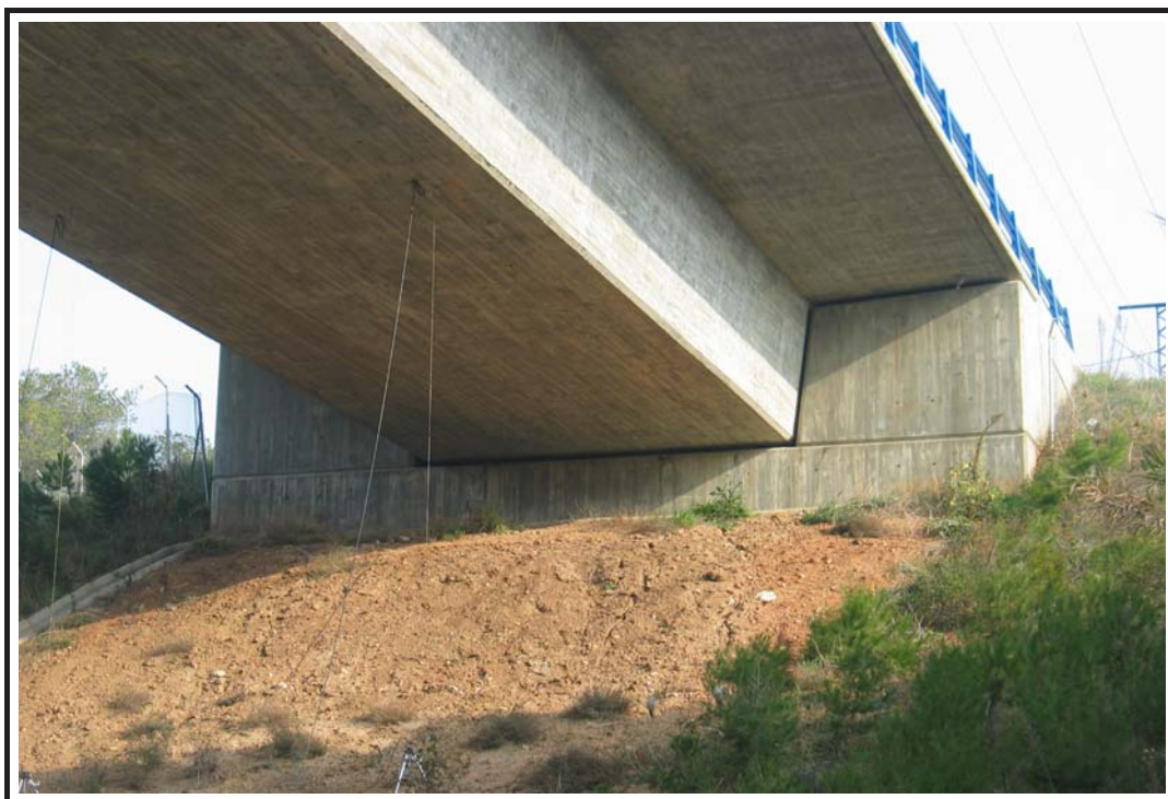
Foto 4: Vista general del estribo
