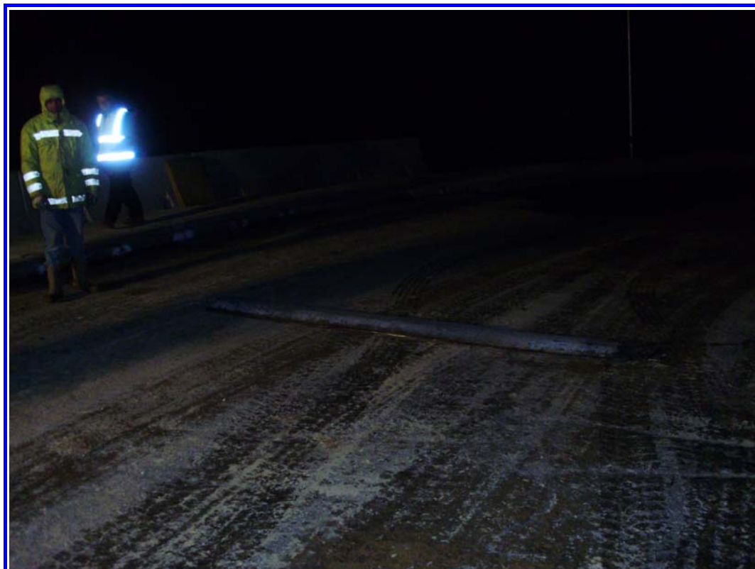
FOTOGRAFÍA N° 12: Detalle tablón normalizado RILEM.
