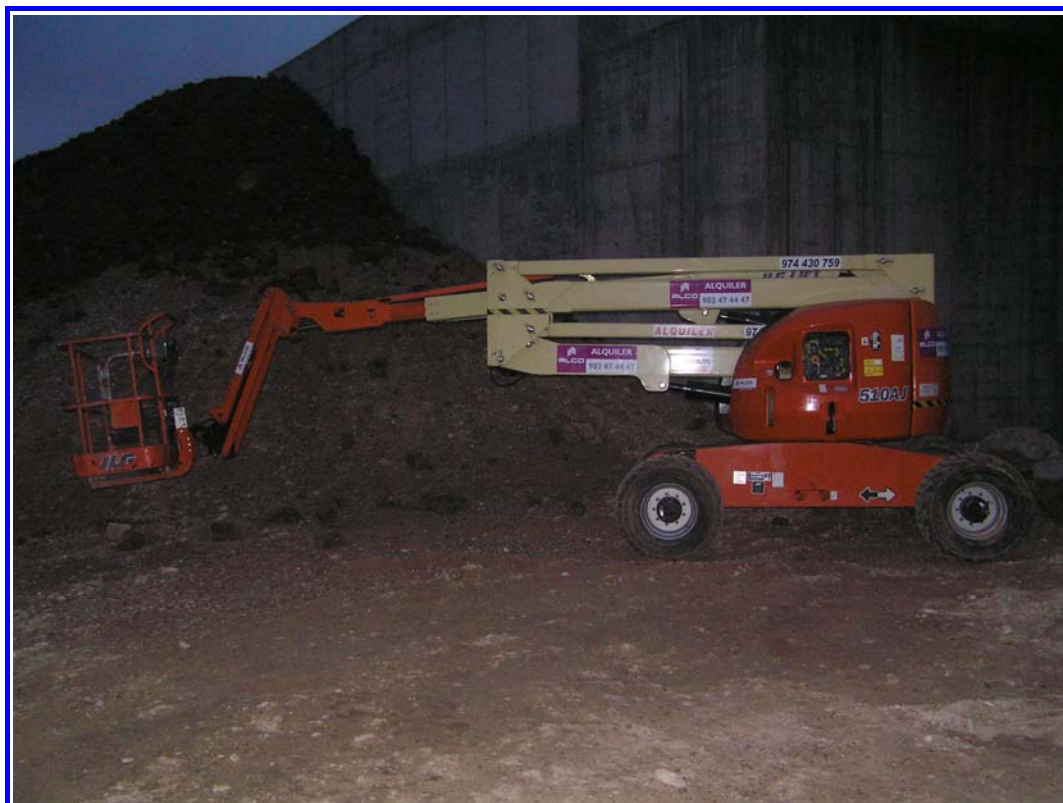
FOTOGRAFÍA N° 4: Equipos auxiliares utilizados durante la instrumentación.
