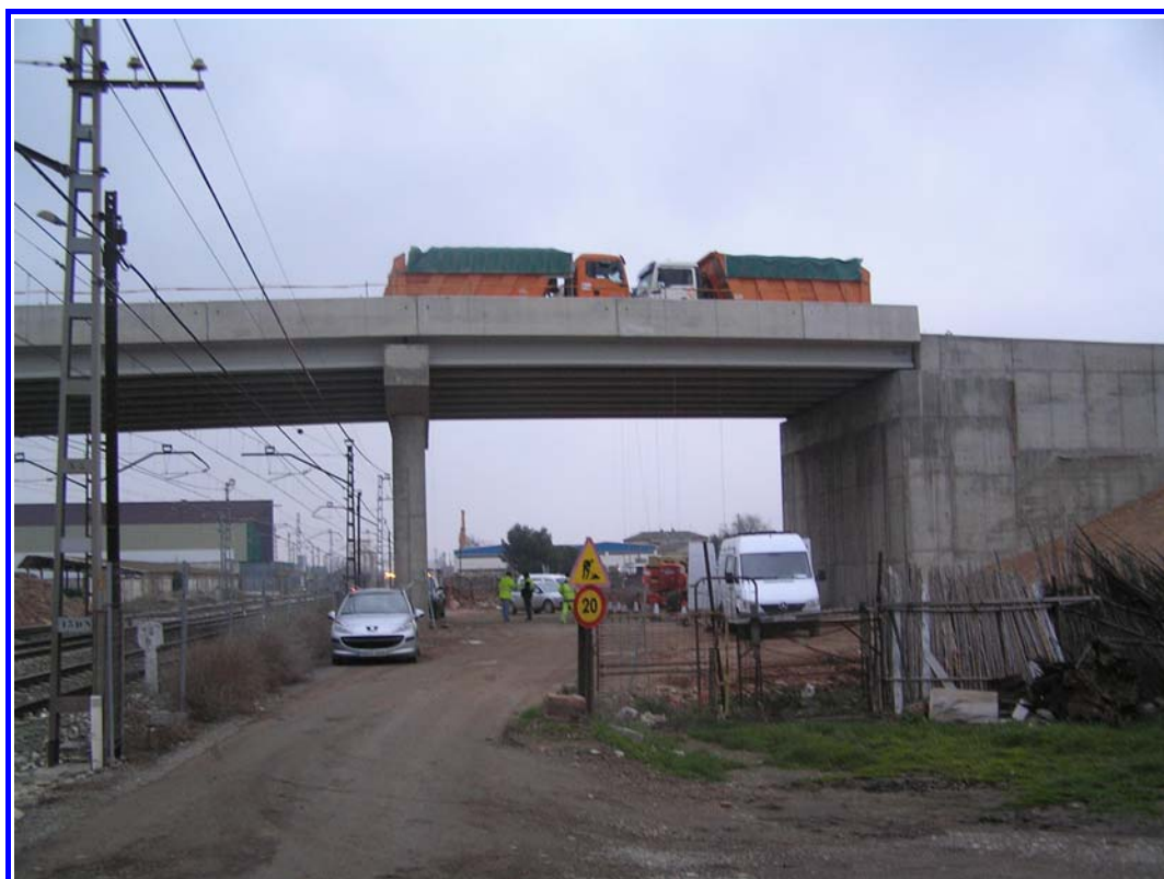
FOTOGRAFÍA N° 10: Prueba estática.
