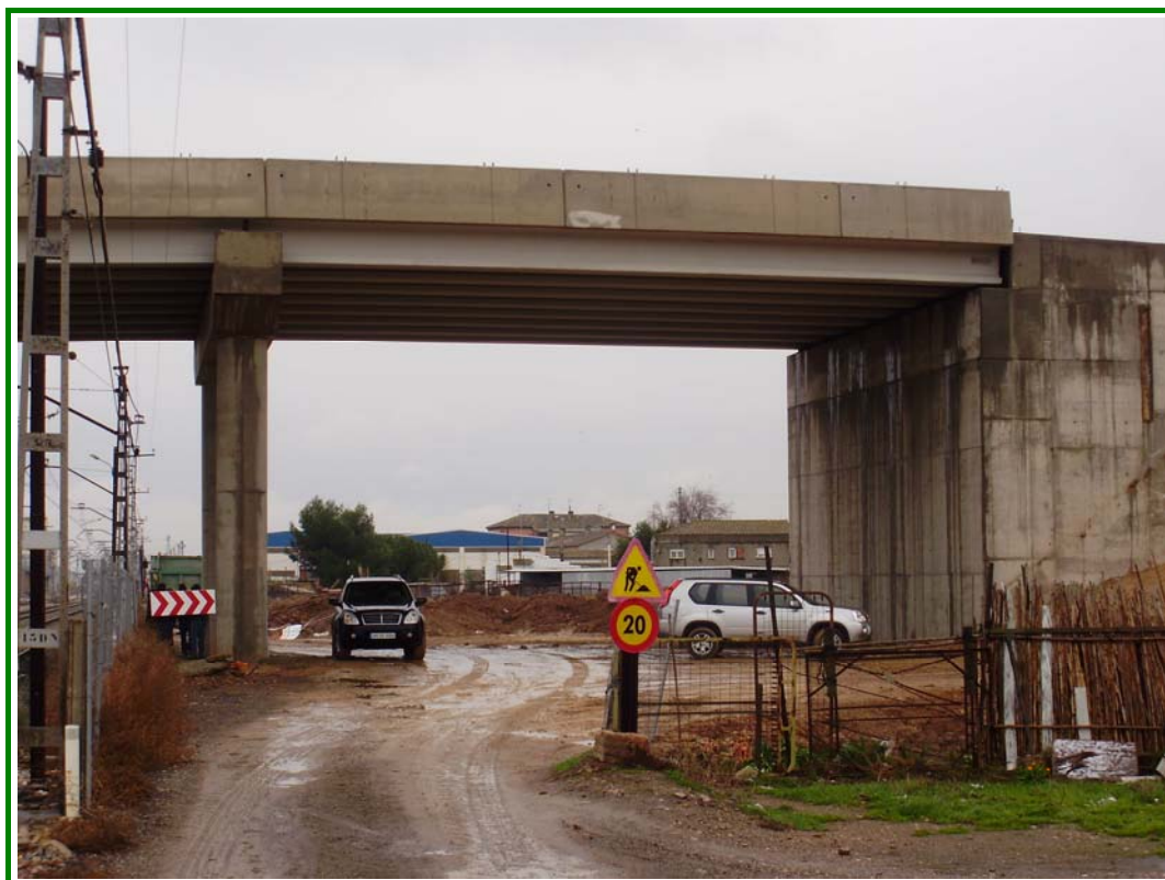
FOTOGRAFÍA Nº 3: Alzado izquierdo del vano 1.
