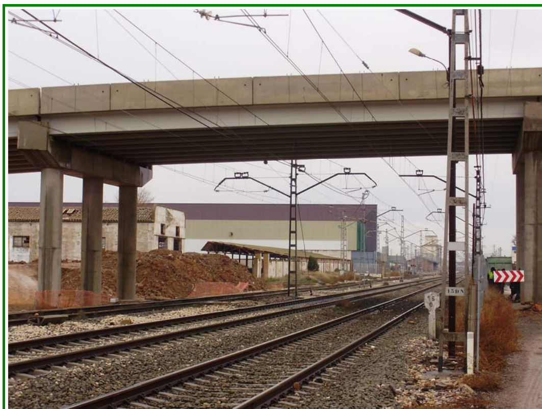
FOTOGRAFÍA Nº 4: Alzado izquierdo del vano 2.
