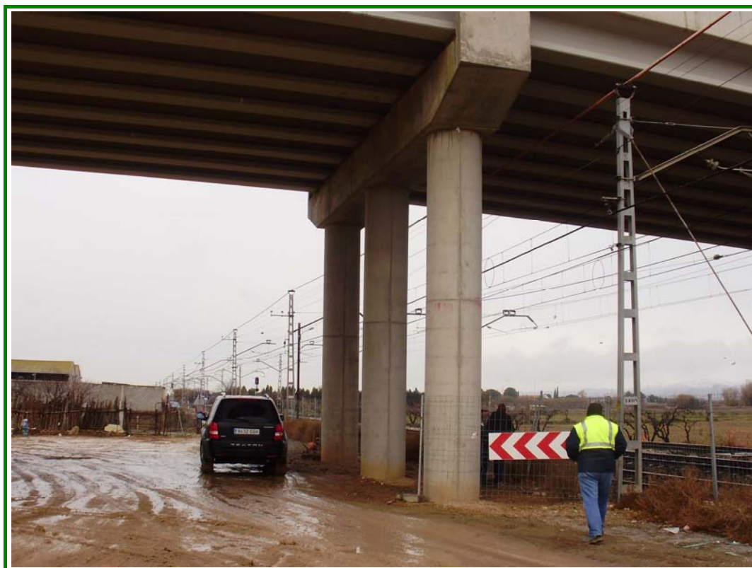
FOTOGRAFÍA N° 11: Detalle de pila 1.
