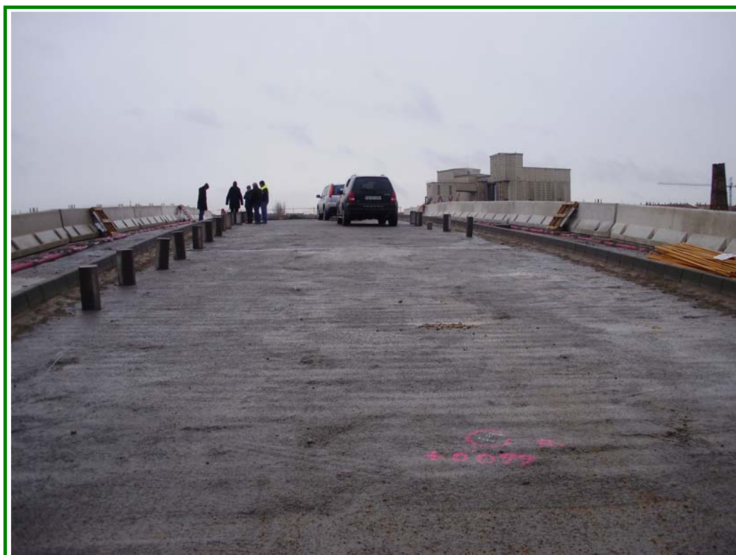
FOTOGRAFÍA N° 8: Vista superior desde estribo de salida.
