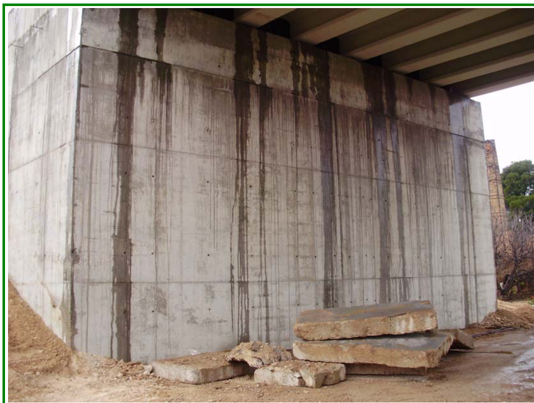
FOTOGRAFÍA N° 9: Detalle de estribo de entrada.
