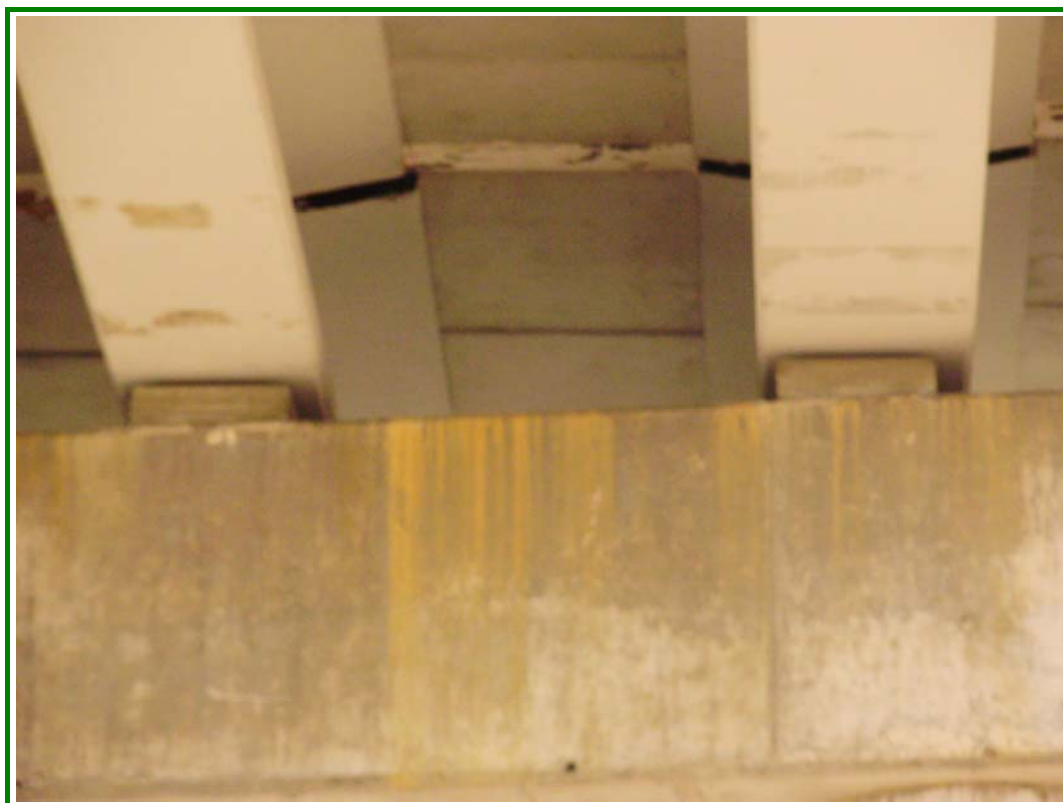
FOTOGRAFÍA N° 13: Detalle de apoyos.
