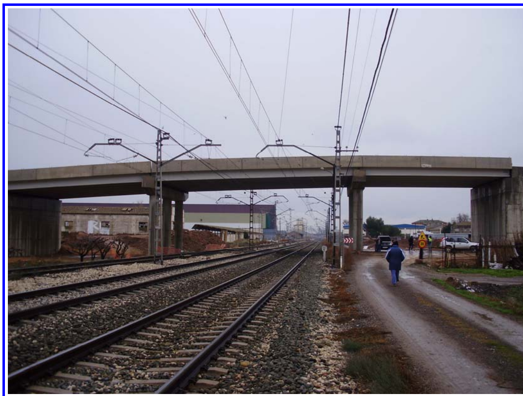
FOTOGRAFÍA Nº 1: Vista general de la estructura.
