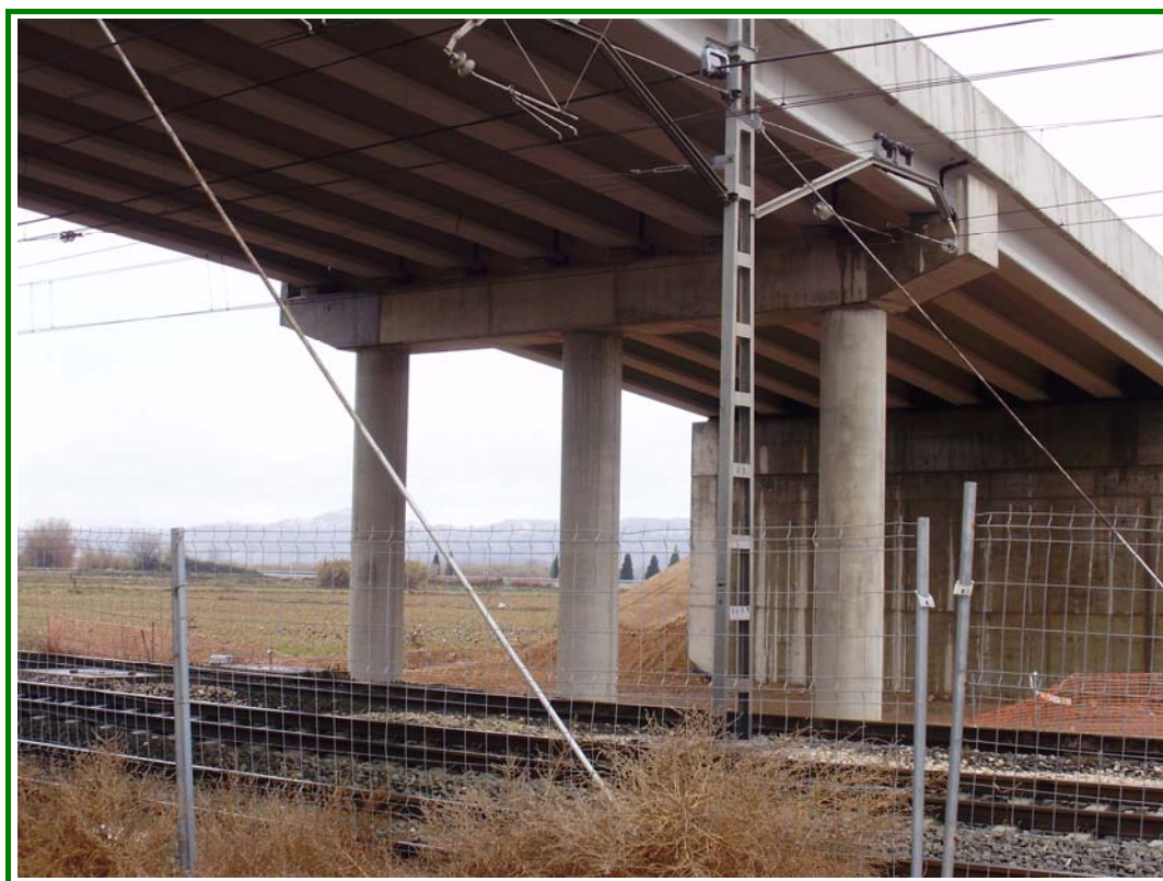
FOTOGRAFÍA N° 12: Detalle de pila 2.
