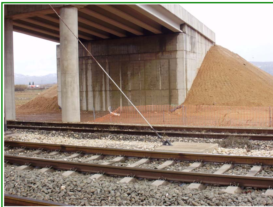
FOTOGRAFÍA N° 10: Detalle de estribo de salida.
