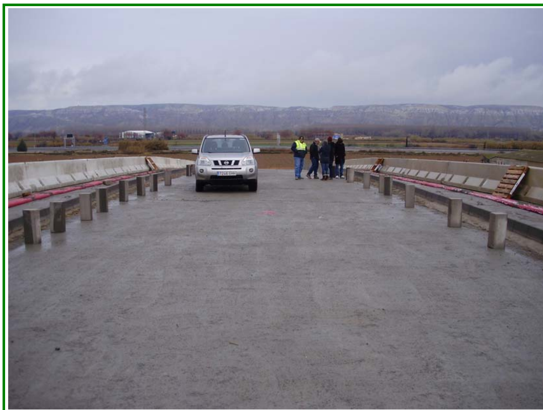
FOTOGRAFÍA N° 7: Vista superior desde estribo de entrada.
