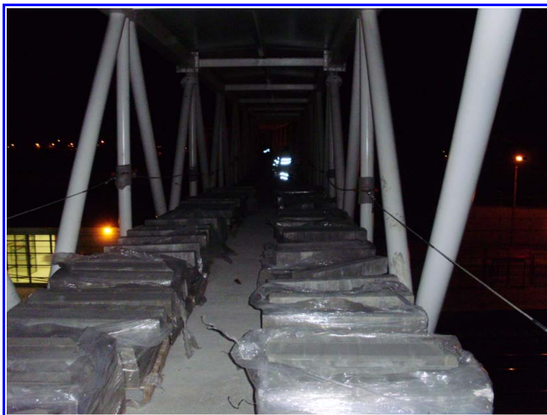
FOTOGRAFÍA Nº 6: Carga de la celosía C.
