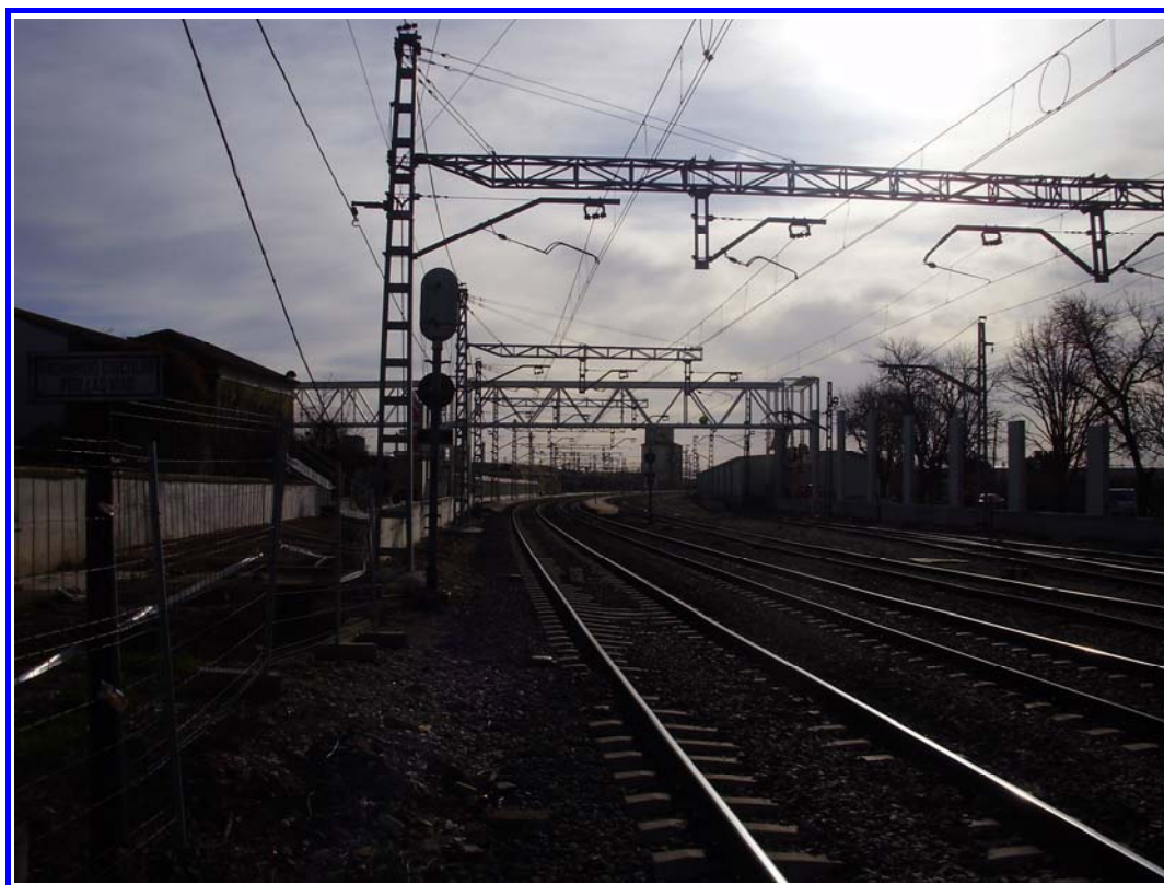
FOTOGRAFÍA Nº 1: Vista general de la estructura (celosía A).
