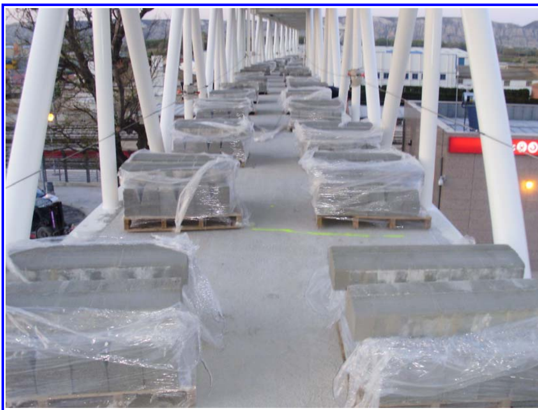
FOTOGRAFÍA Nº 4: Carga de la celosía A.
