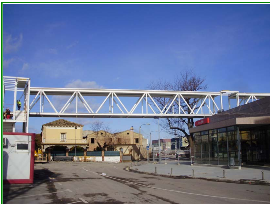
FOTOGRAFÍA Nº 2: Vista de la celosía B.
