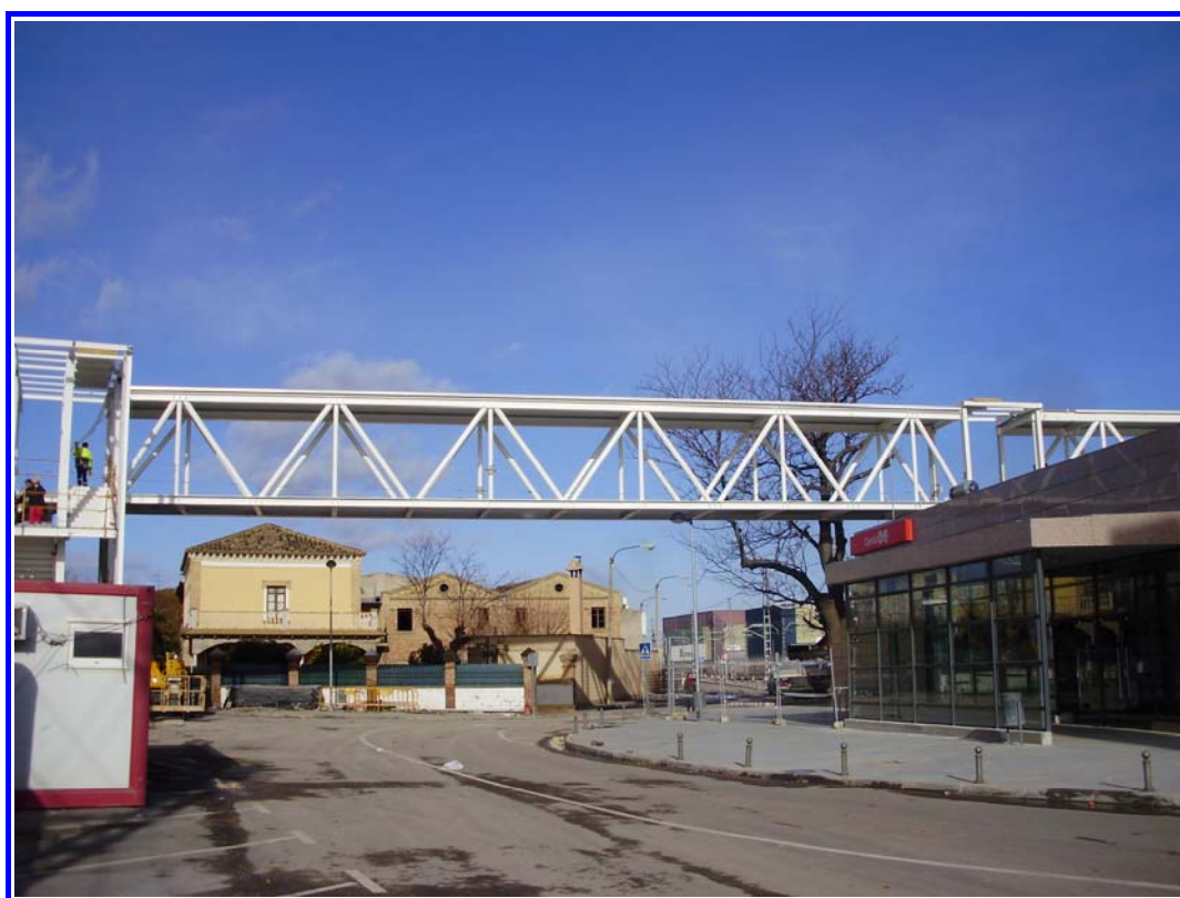
FOTOGRAFÍA Nº 2: Vista general de la estructura (celosía B).
