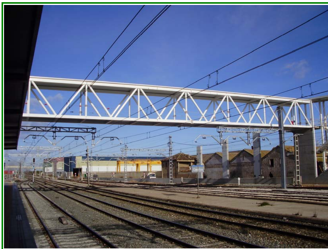
FOTOGRAFÍA Nº 3: Vista de la celosía C.
