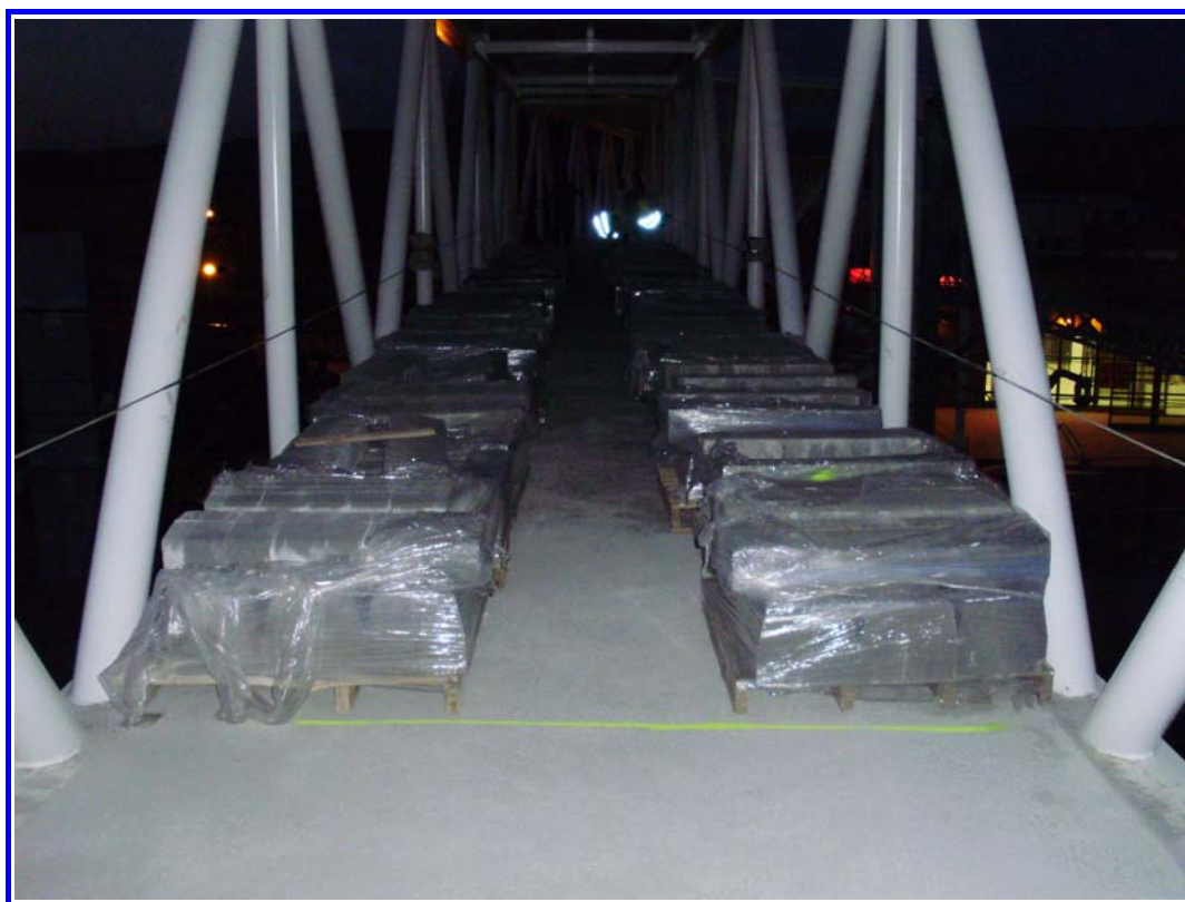
FOTOGRAFÍA Nº 5: Carga de la celosía B.
