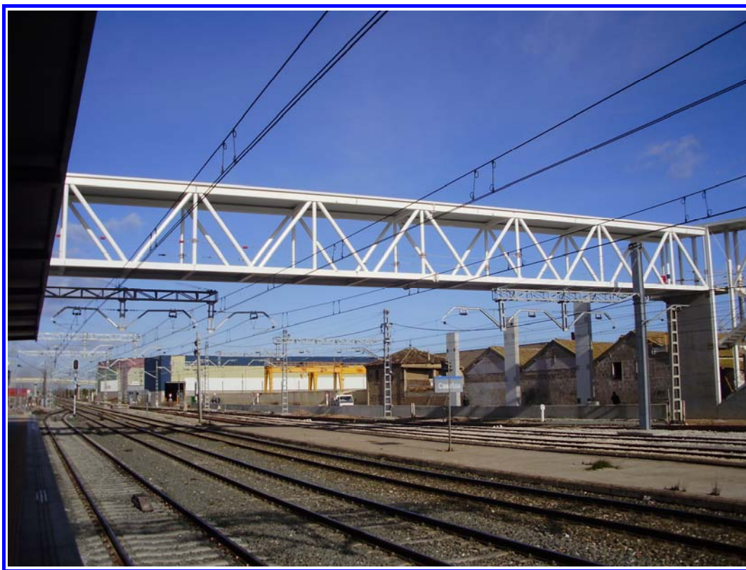
FOTOGRAFÍA Nº 3: Vista general de la estructura (celosía C).
