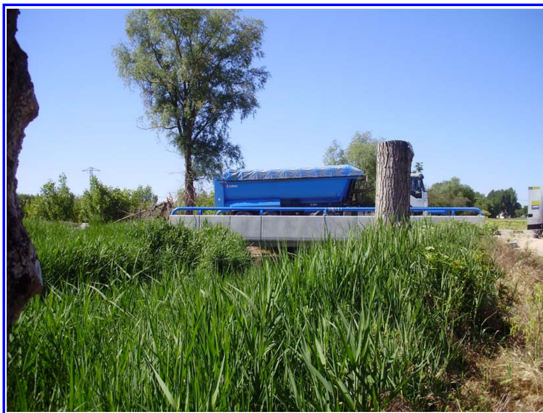
FOTOGRAFÍA Nº 1: Vista general de la estructura.
