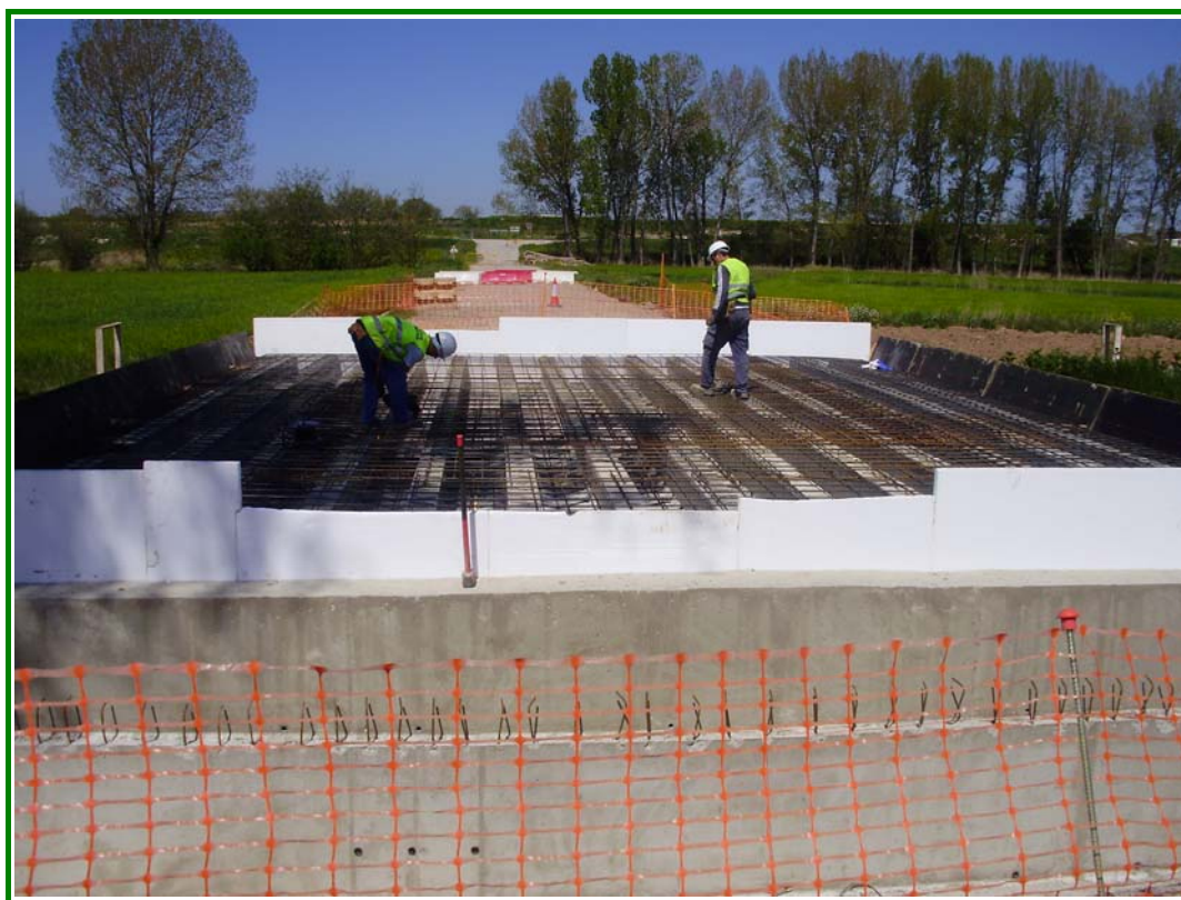
FOTOGRAFÍA N° 1: Vista general del Puente sobre el Rio Jiloca.
