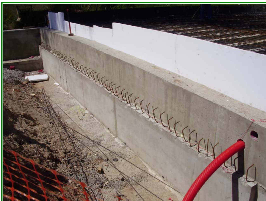
FOTOGRAFÍA N° 4: Detalle de estribo.
