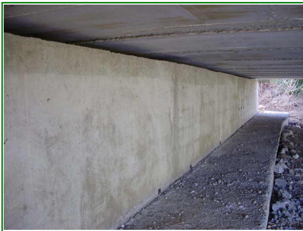
FOTOGRAFÍA N° 5: Vista de apoyo de las vigas.
