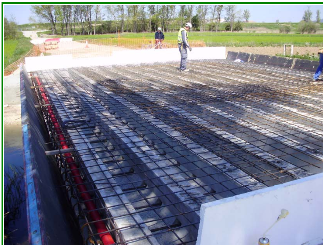
FOTOGRAFÍA N° 2: Vista superior de las vigas.
