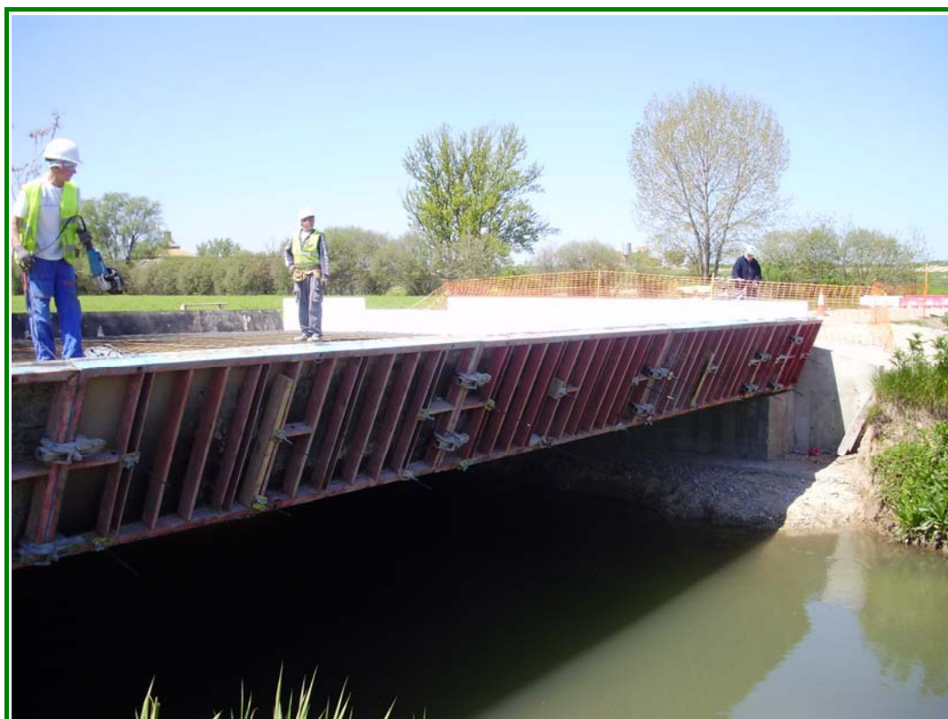
FOTOGRAFÍA N° 6: Vista lateral del puente.
