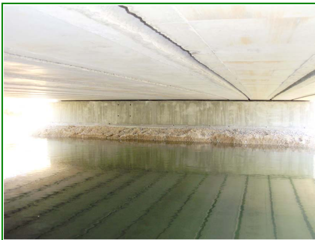
FOTOGRAFÍA N° 3: Vista inferior de las vigas.
