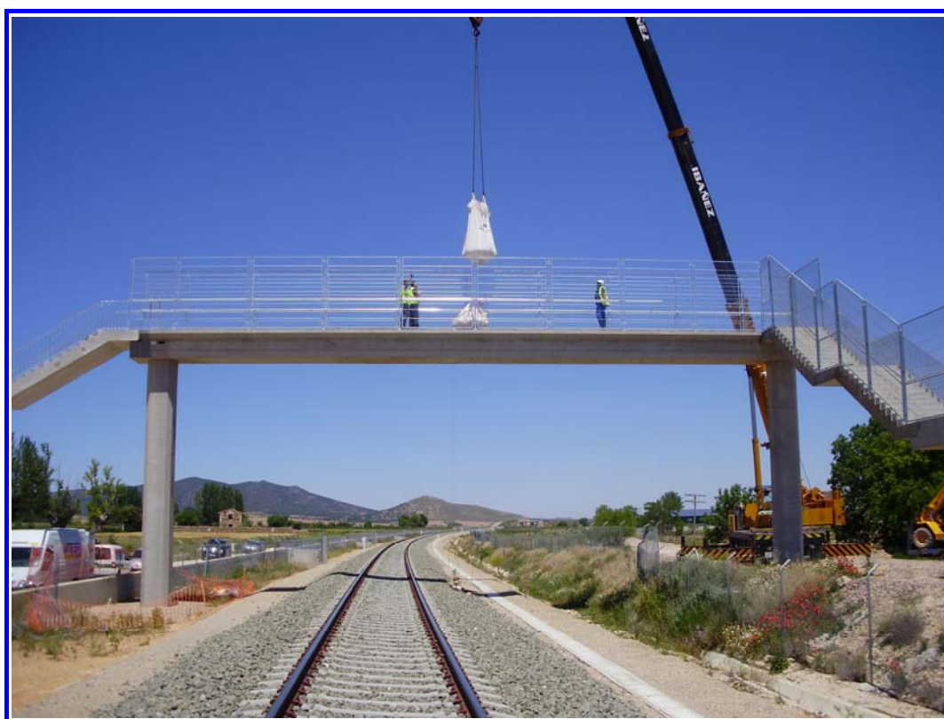
FOTOGRAFÍA Nº 2: Vista general de la pasarela durante la carga.
