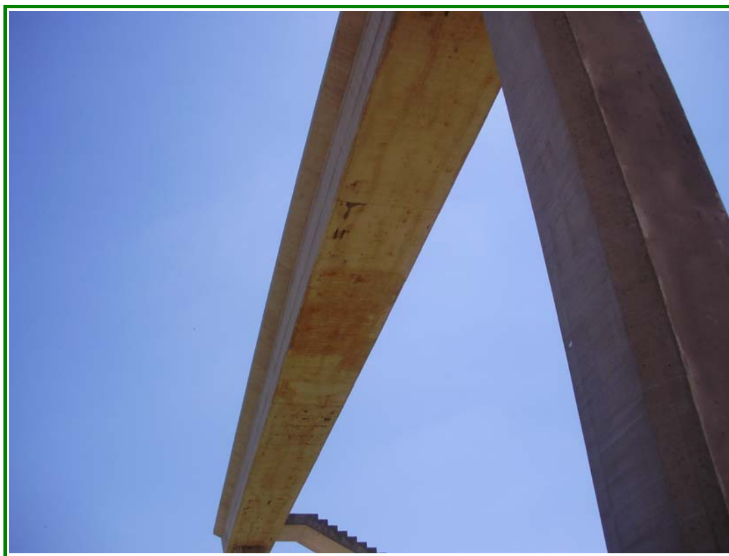
FOTOGRAFÍA N° 5: Vista inferior de la viga.
