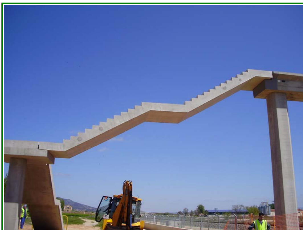
FOTOGRAFÍA N° 8: Escalera de acceso a la plataforma lado izquierdo.
