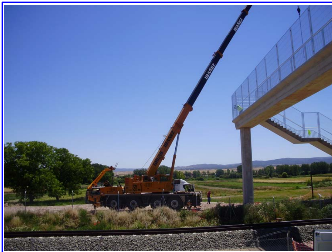
FOTOGRAFÍA Nº 11: Medios auxiliares para la carga de la pasarela.
