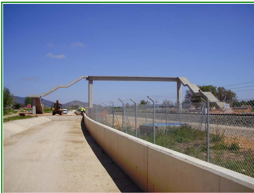
FOTOGRAFÍA Nº 2: Vista general de la pasarela desde el lado Teruel.
