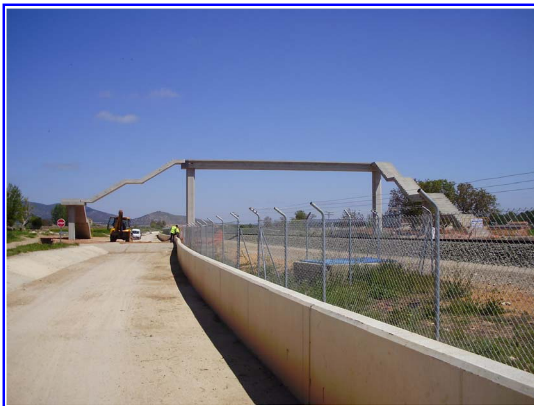
FOTOGRAFÍA Nº 1: Vista general de la pasarela.
