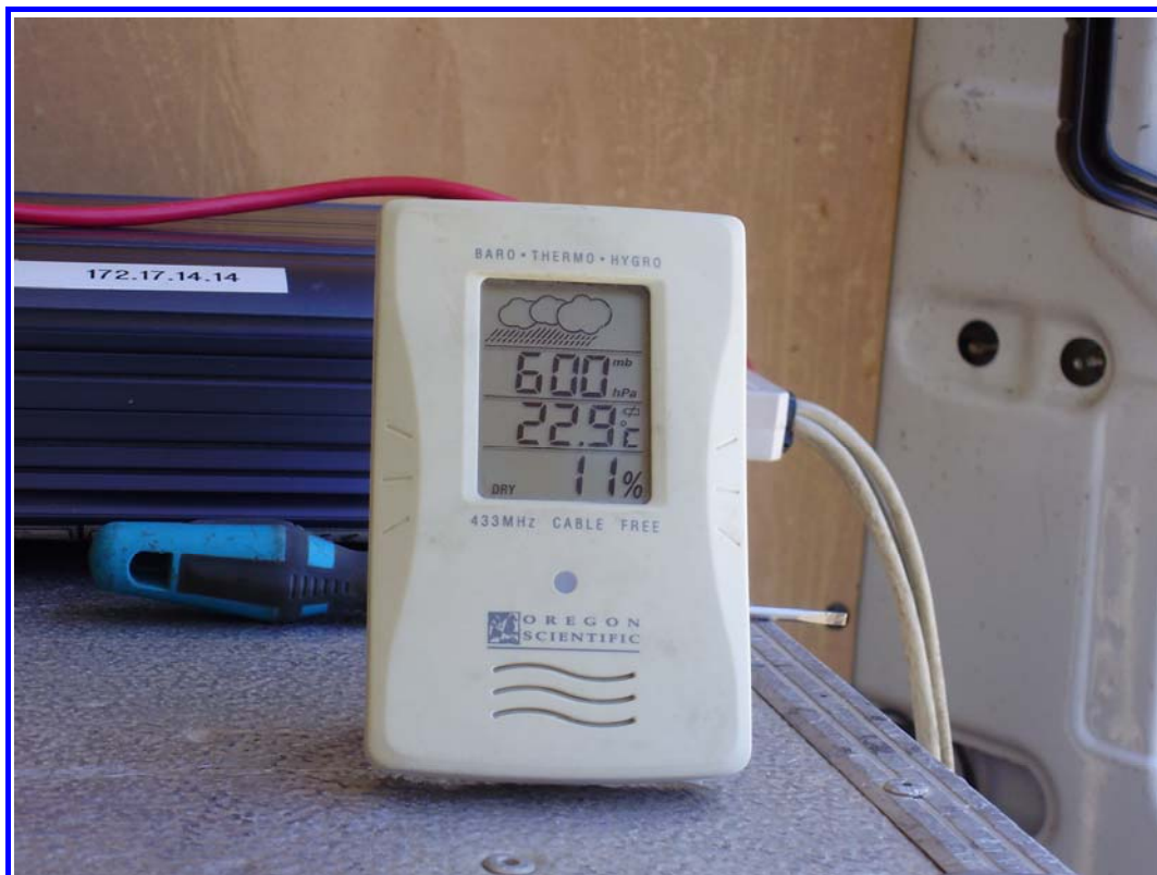
FOTOGRAFÍA Nº 8: Registro de temperatura y humedad durante la prueba.
