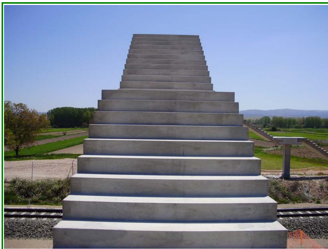
FOTOGRAFÍA Nº 9: Escalera de acceso a la plataforma. Detalle.
