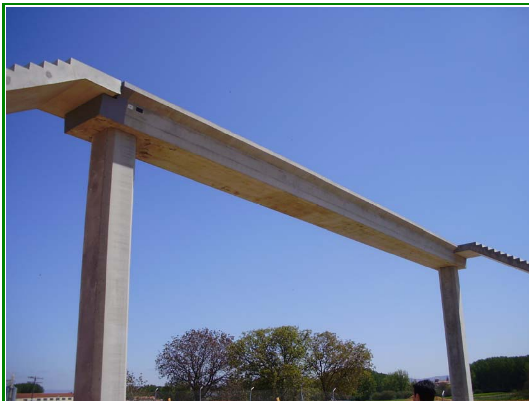
FOTOGRAFÍA N° 4: Vista del la viga que conforma la pasarela.
