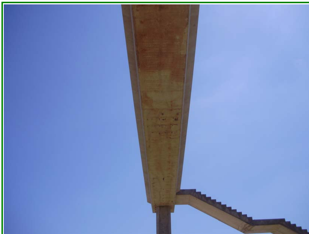
FOTOGRAFÍA N° 6: Vista inferior de la viga. Detalle.
