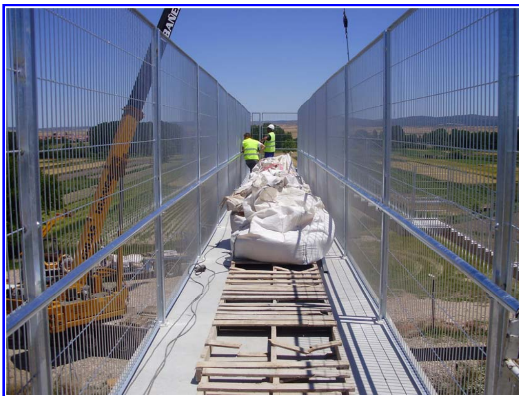
FOTOGRAFÍA N° 3: Pasarela carga parcialmente (I).
