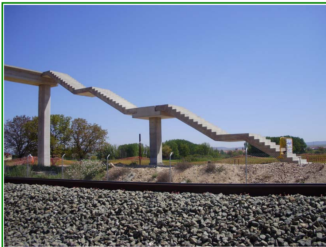
FOTOGRAFÍA N° 7: Escalera de acceso a la plataforma lado derecho.
