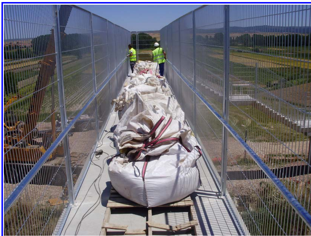
FOTOGRAFÍA N° 4: Pasarela carga parcialmente (II).
