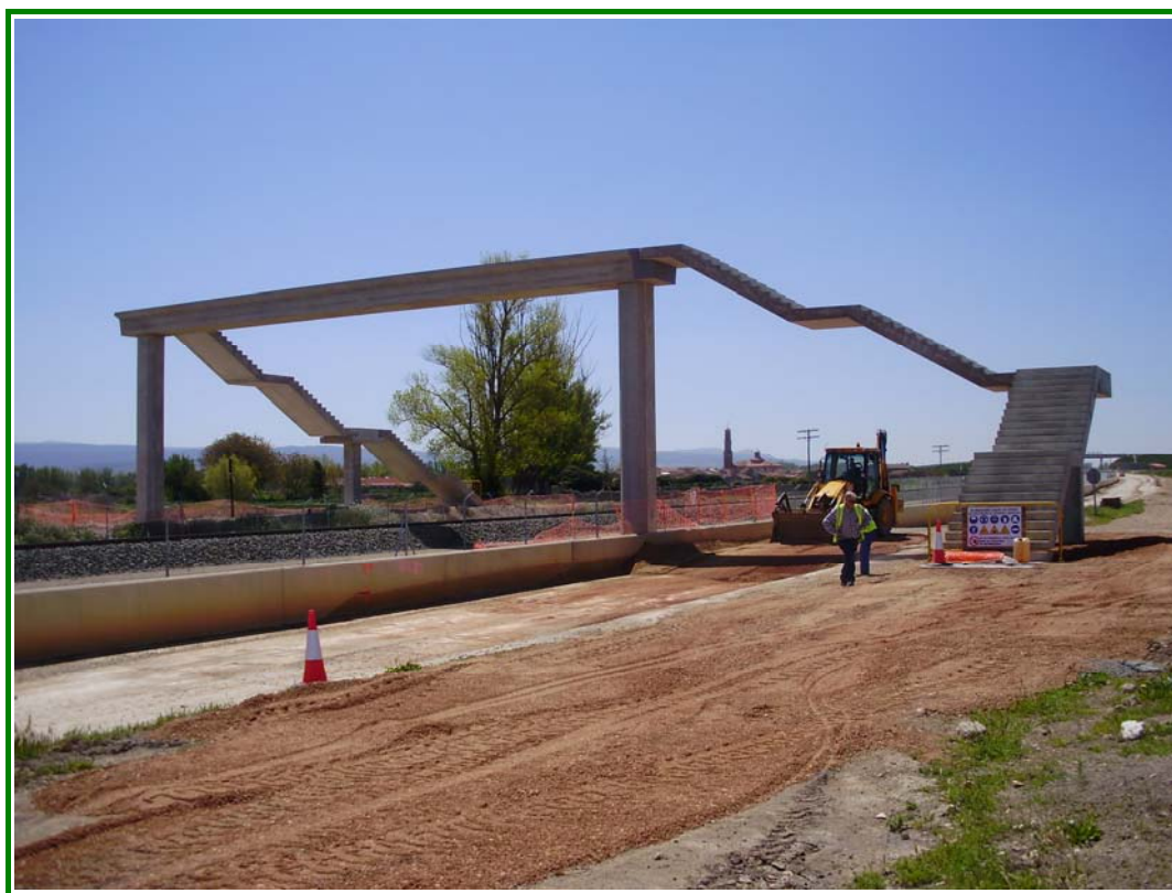
FOTOGRAFÍA Nº 1: Vista general de la pasarela desde el lado Zaragoza.
