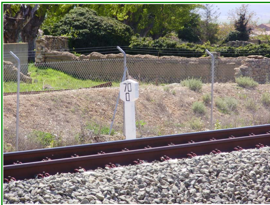
FOTOGRAFÍA N° 11: Punto kilométrico de la estructura.
