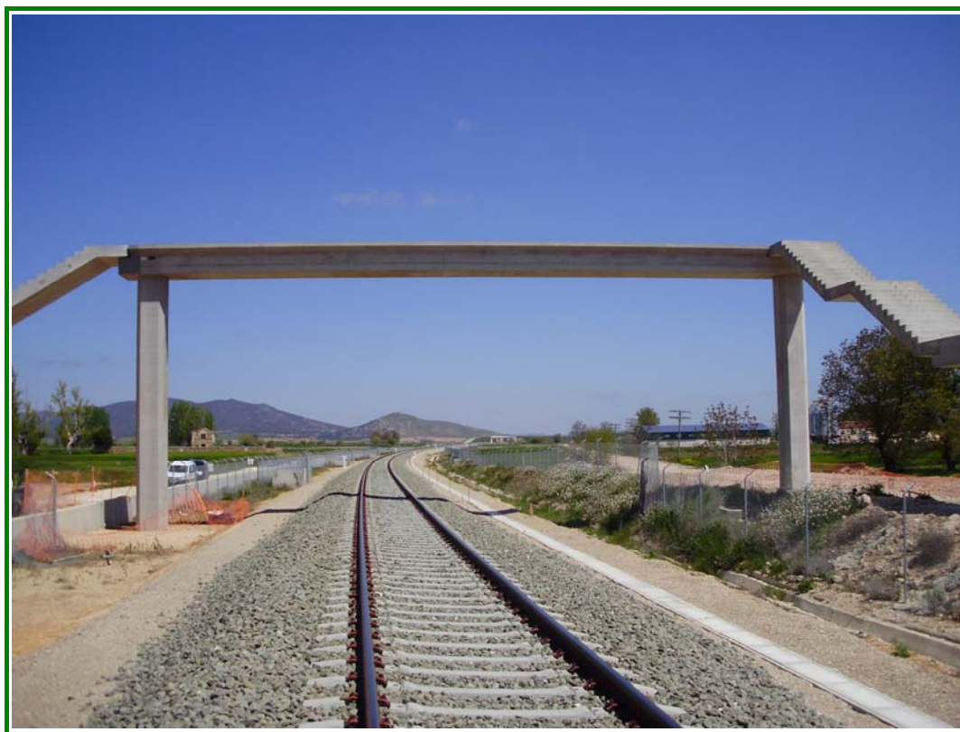
FOTOGRAFÍA N° 3: Vista de la pasarela. Detalle.
