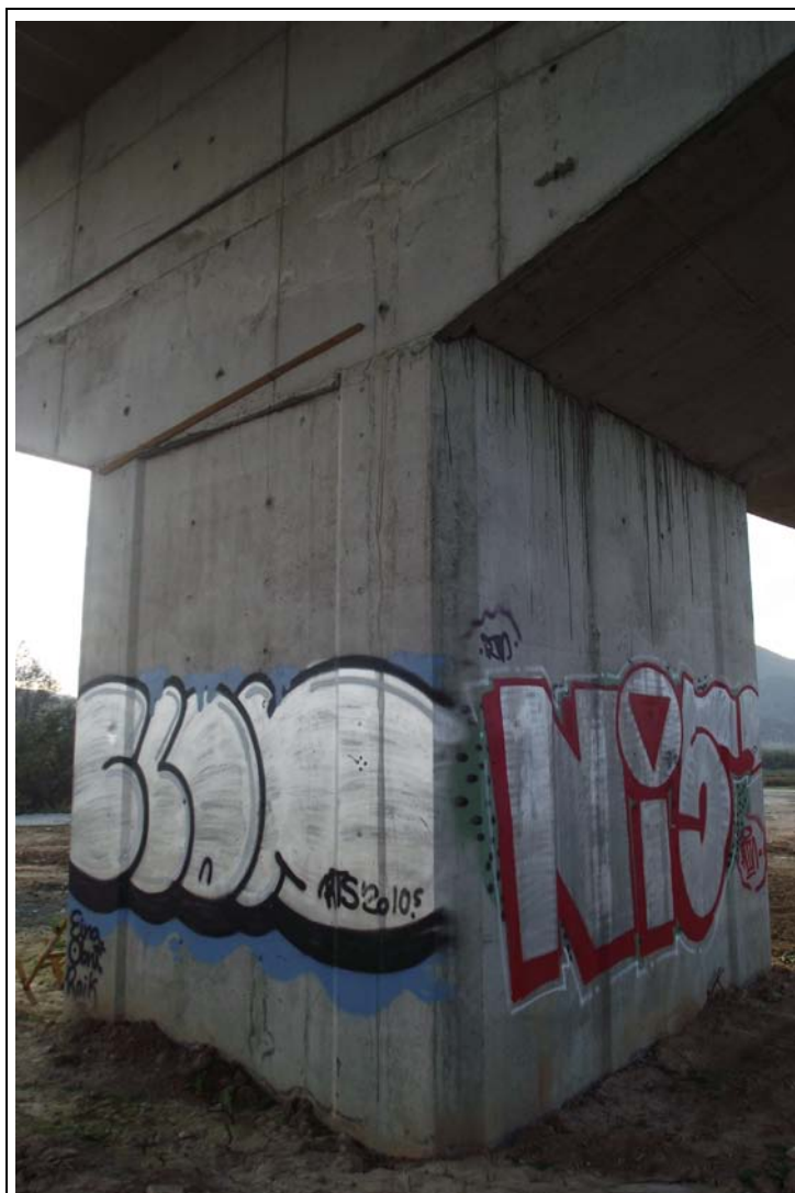
FOTOGRAFÍA Nº 8: Pila-estribo de salida desde lado derecho.
