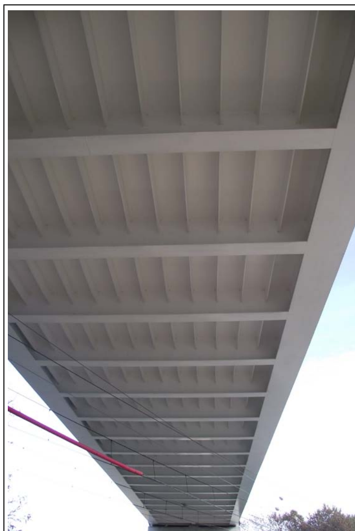
FOTOGRAFÍA Nº 11: Fibra inferior del tablero desde el lado izquierdo de la pila-estribo de salida.
