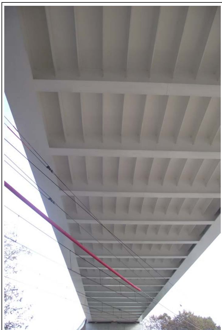
FOTOGRAFÍA Nº 10: Fibra inferior del tablero desde el lado derecho de la pila-estribo de salida.
