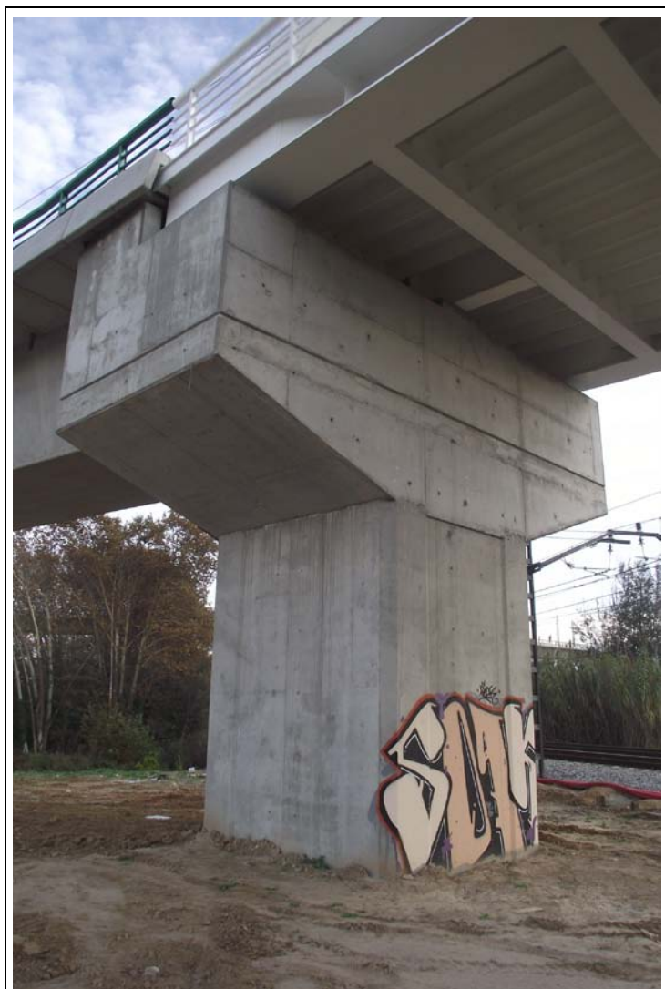
FOTOGRAFÍA Nº 7: Pila-estribo de entrada desde lado derecho.
