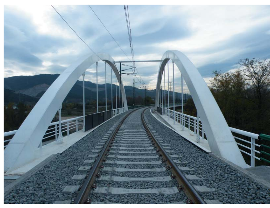
FOTOGRAFÍA N° 3: Plataforma vista desde la entrada.
