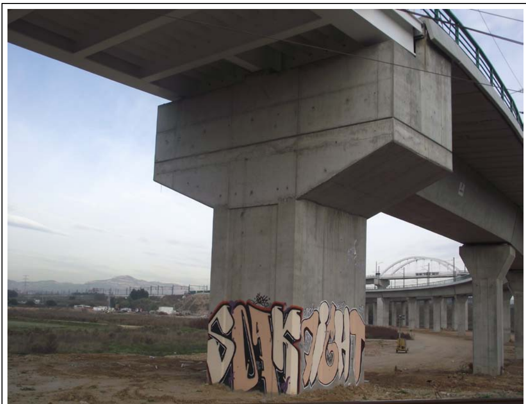
FOTOGRAFÍA N° 6: Pila-estribo de entrada desde lado izquierdo.
