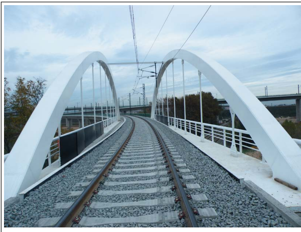
FOTOGRAFÍA N° 4: Plataforma vista desde la salida.
