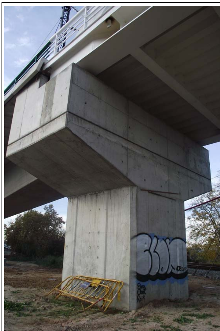
FOTOGRAFÍA Nº 9: Pila-estribo de salida desde lado izquierdo.
