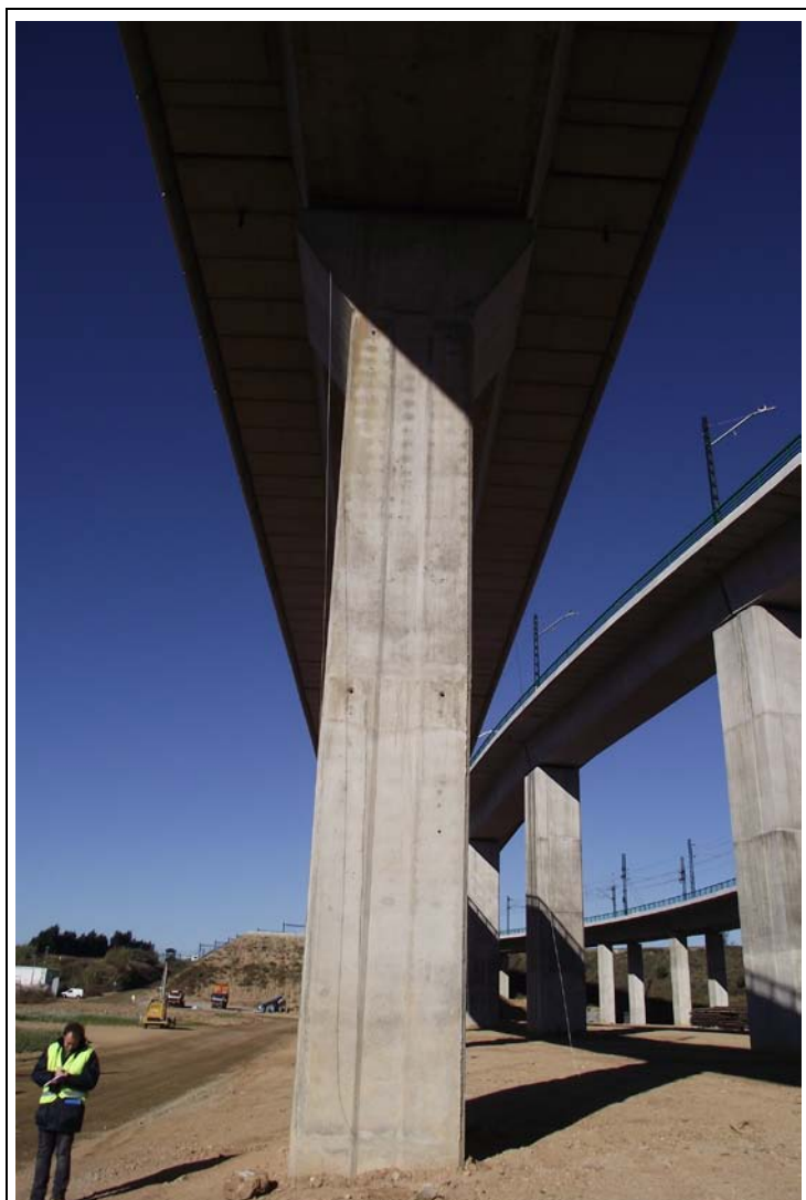
FOTOGRAFÍA Nº 31: Pila 8 en Tramo IX.
