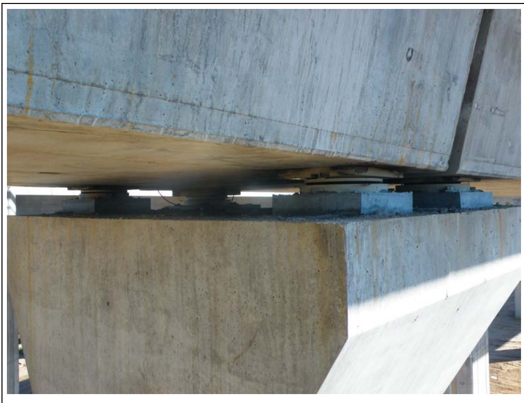
FOTOGRAFÍA N° 68: Apoyos en pila 4.
