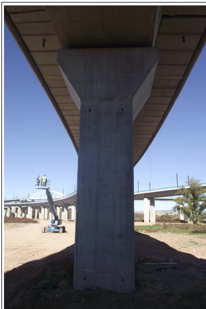
FOTOGRAFÍA Nº 61: Pila 18 en Tramo XIX.
