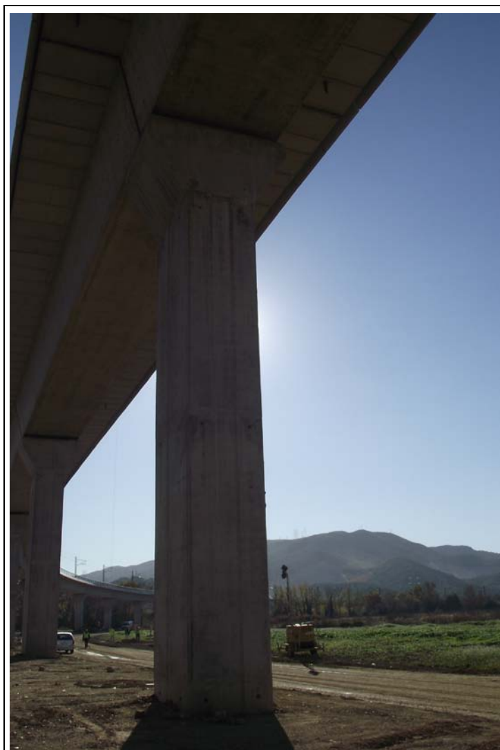
FOTOGRAFÍA Nº 27: Pila 7 en Tramo VII.
