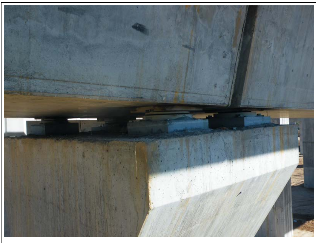
FOTOGRAFÍA N° 69: Apoyos en pila 5.
