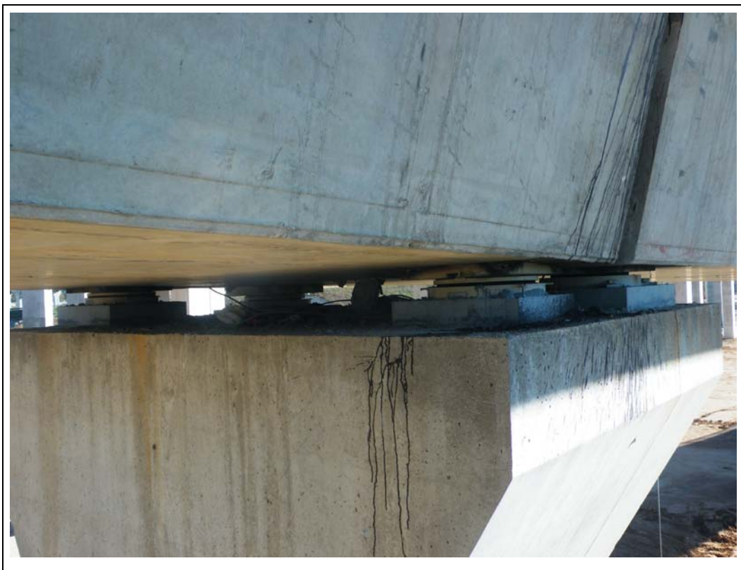
FOTOGRAFÍA N° 74: Apoyos en pila 10.
