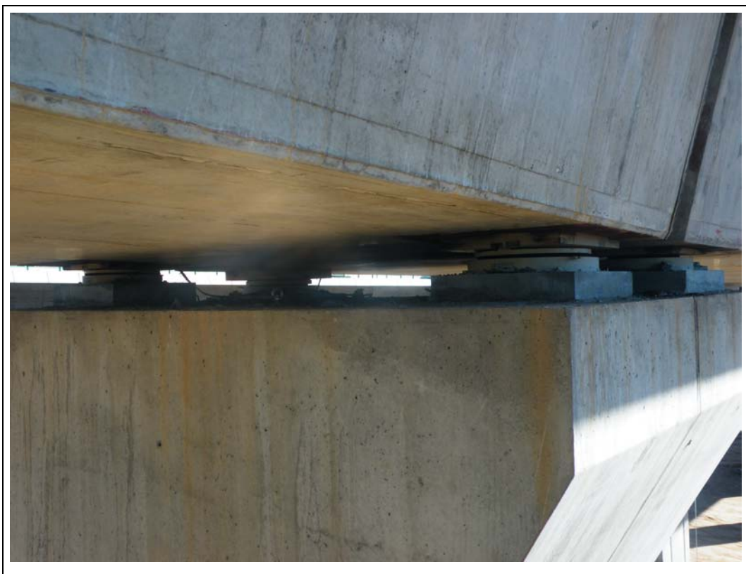
FOTOGRAFÍA N° 67: Apoyos en pila 3.
