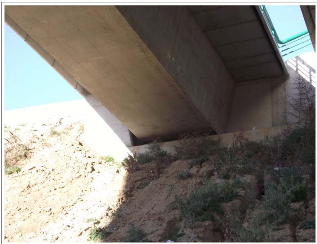
FOTOGRAFÍA N° 6: Estribo de entrada desde lado derecho.
