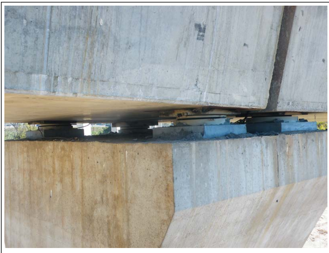
FOTOGRAFÍA N° 78: Apoyos en pila 14.
