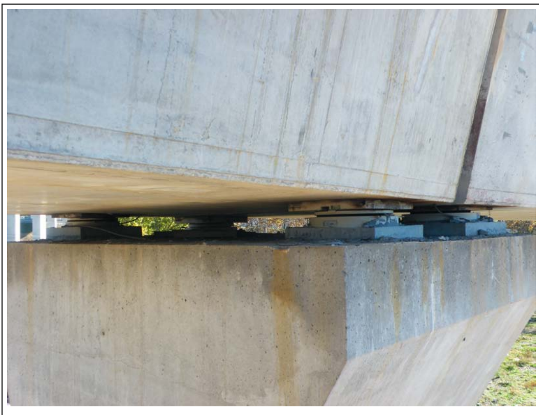
FOTOGRAFÍA N° 79: Apoyos en pila 15.
