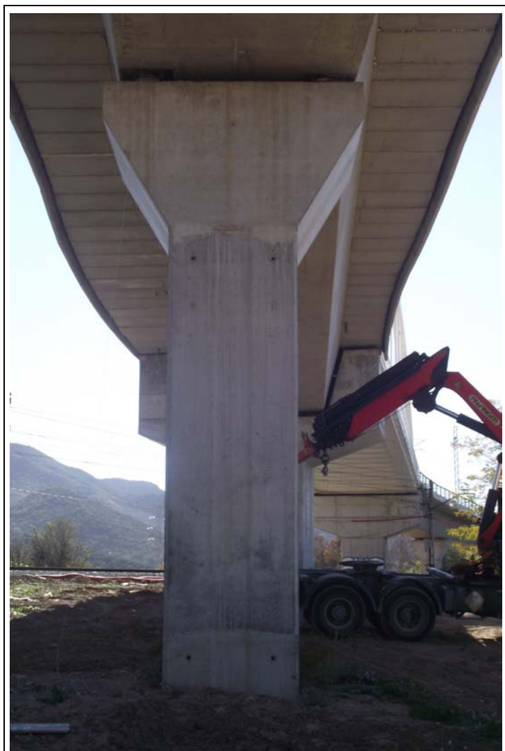
FOTOGRAFÍA Nº 60: Pila 18 en Tramo XVIII.
