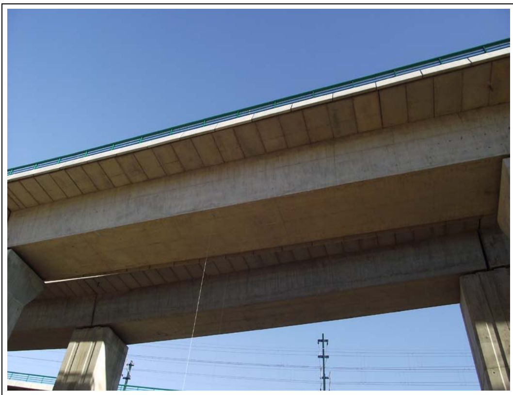
FOTOGRAFÍA N° 11: Fibra inferior del Tramo II.
