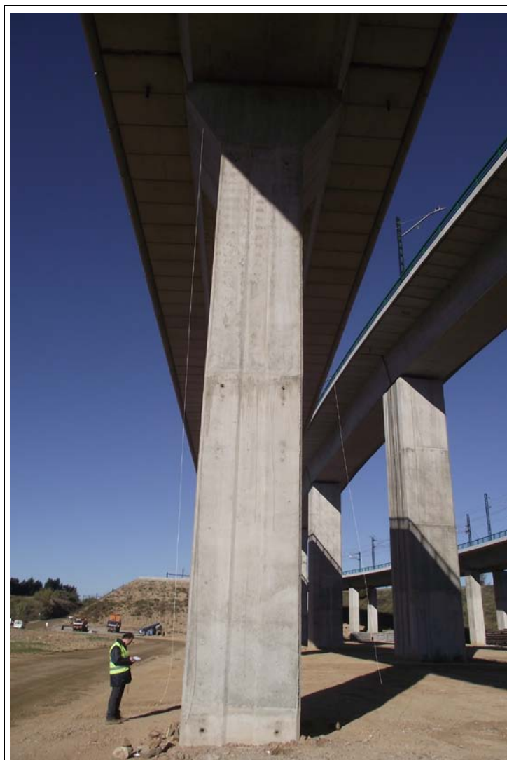
FOTOGRAFÍA Nº 28: Pila 7 en Tramo VIII.
