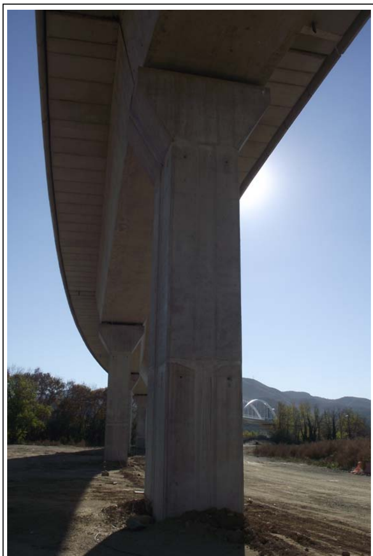
FOTOGRAFÍA Nº 42: Pila 12 en Tramo XII.
