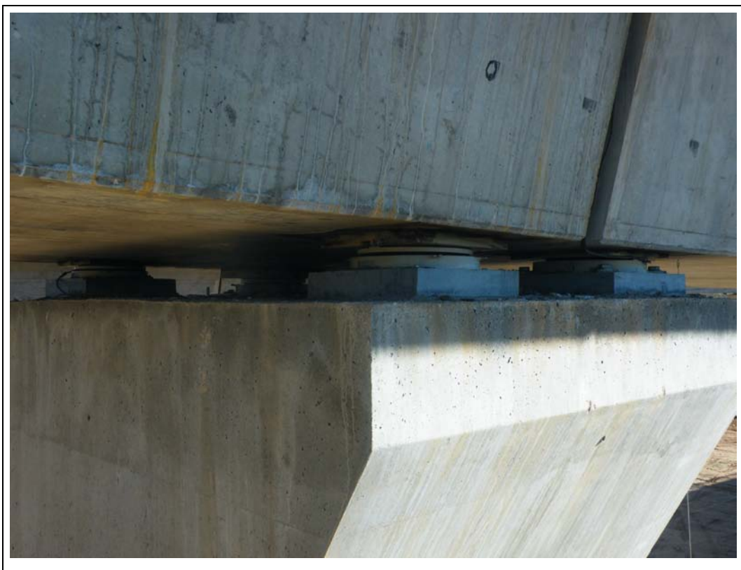
FOTOGRAFÍA N° 71: Apoyos en pila 7.
