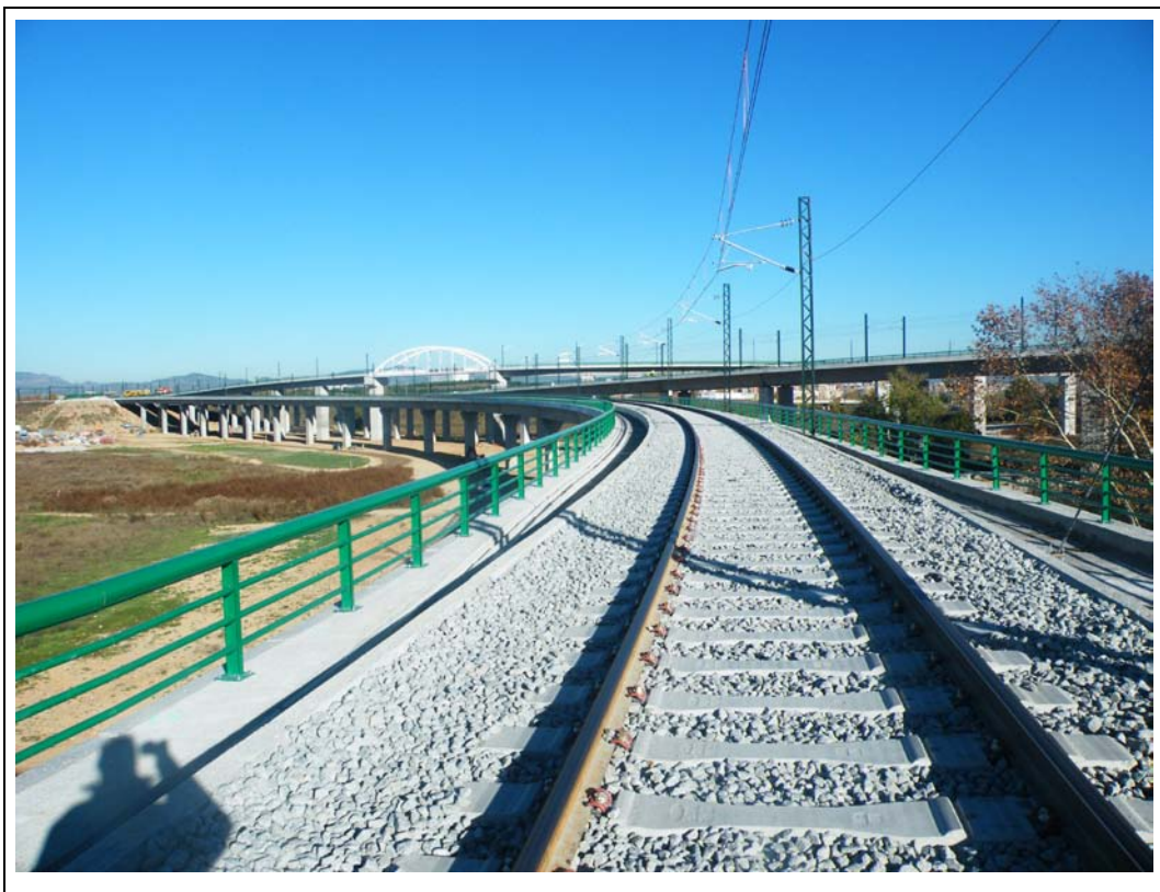
FOTOGRAFÍA N° 4: Plataforma vista desde lado de salida.
