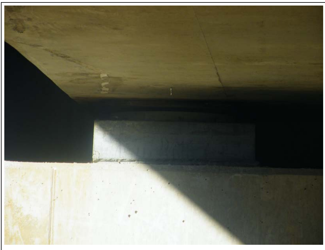
FOTOGRAFÍA N° 63: Apoyo derecho sobre el estribo de entrada.
