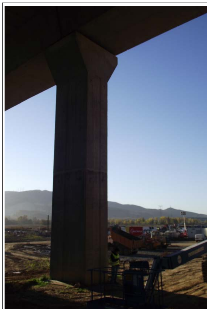
FOTOGRAFÍA Nº 9: Pila 1 en Tramo I.
