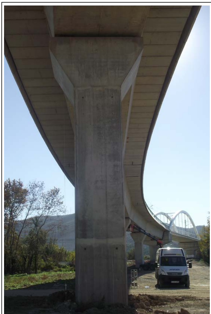
FOTOGRAFÍA N° 51: Pila 15 en Tramo XV.
