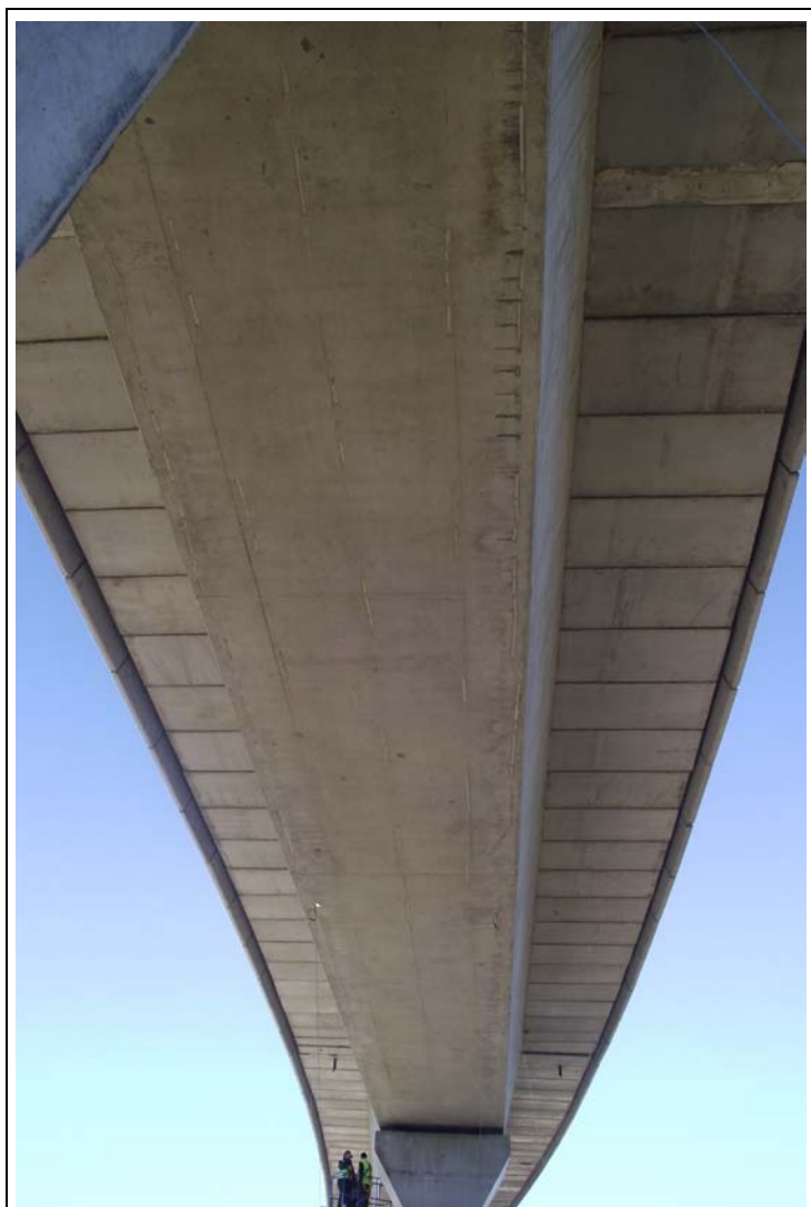
FOTOGRAFÍA Nº 59: Fibra inferior del Tramo XVIII.
