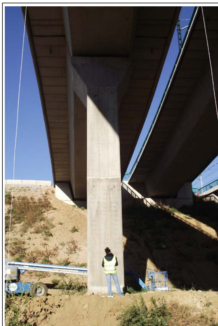
FOTOGRAFÍA Nº 10: Pila 1 en Tramo II.
