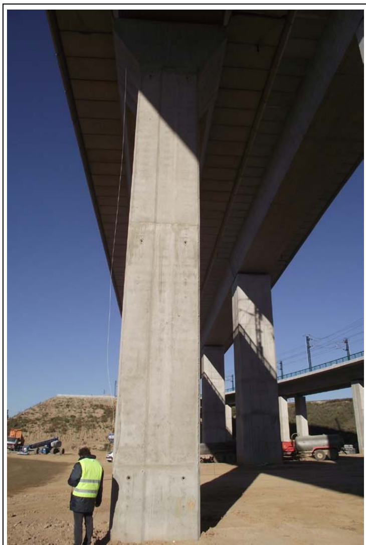
FOTOGRAFÍA Nº 22: Pila 5 en Tramo VI.
