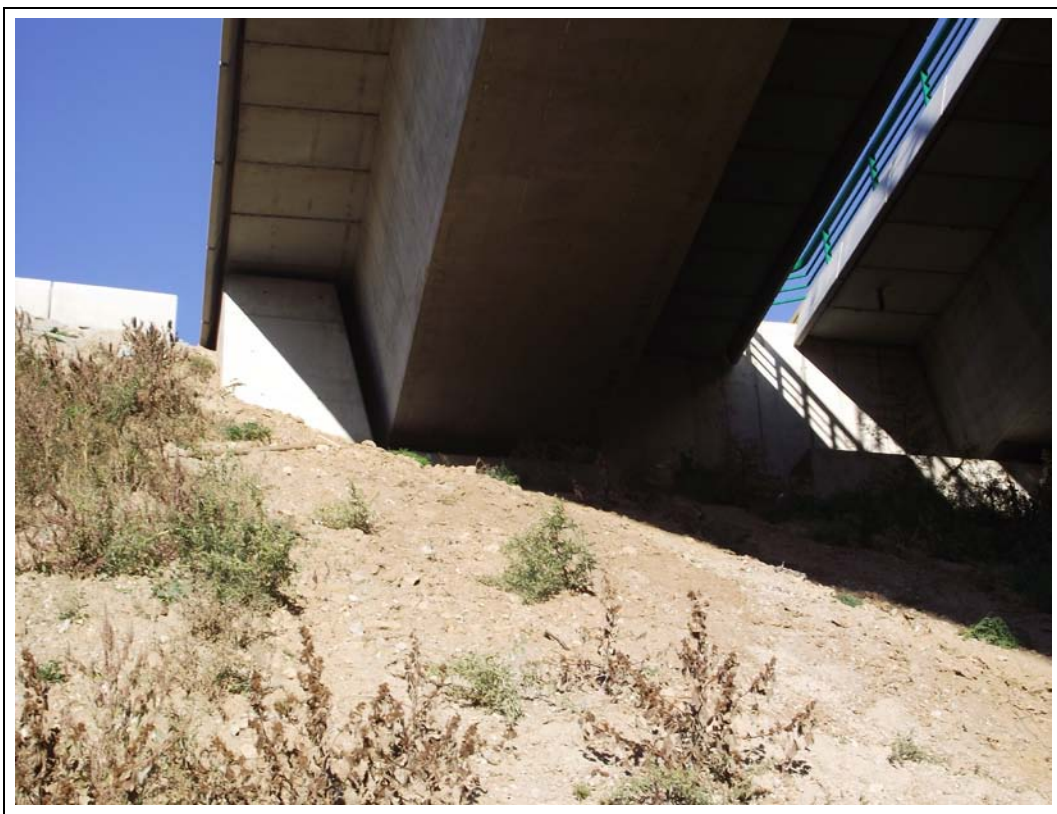
FOTOGRAFÍA N° 5: Estribo de entrada desde lado derecho.
