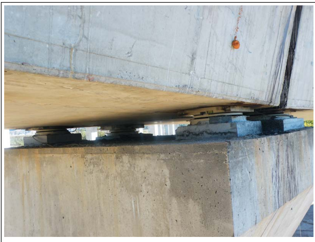
FOTOGRAFÍA N° 77: Apoyos en pila 13.
