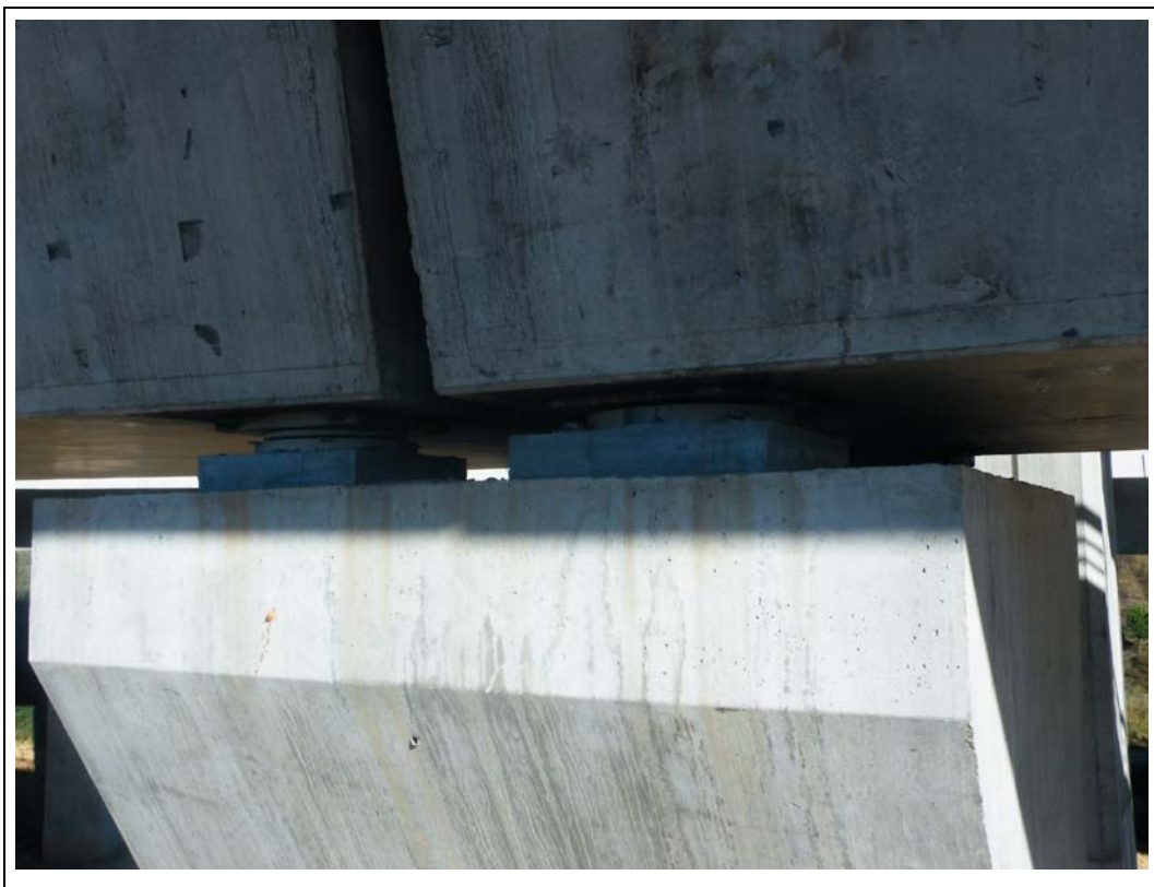
FOTOGRAFÍA N° 66: Apoyos en pila 2.
