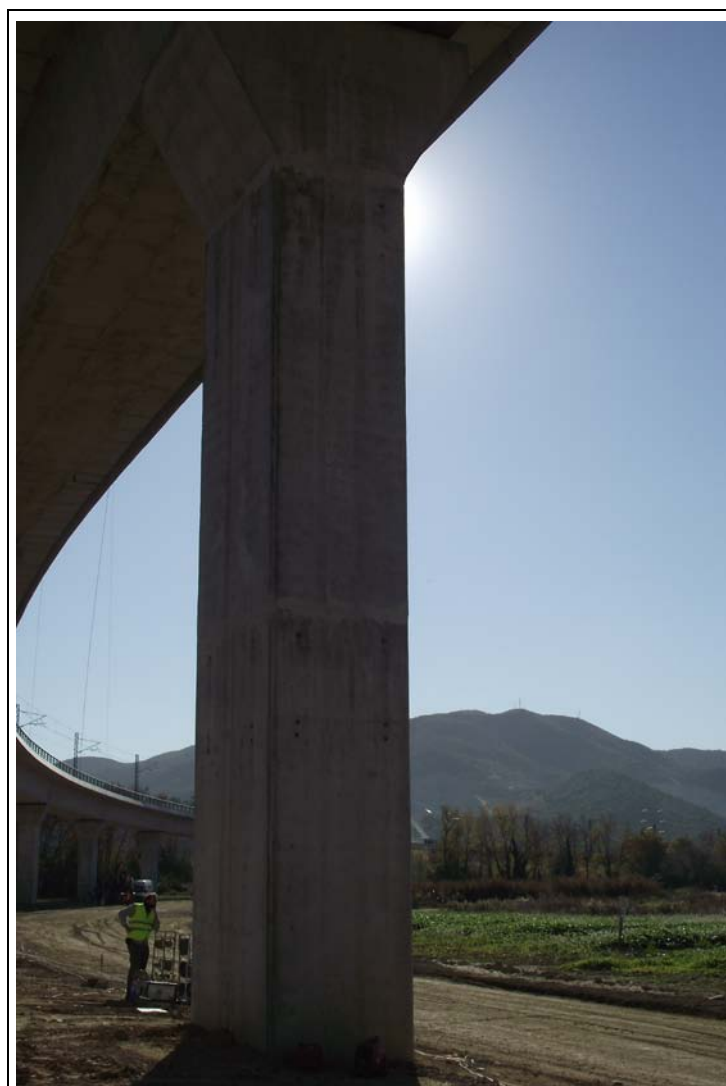
FOTOGRAFÍA Nº 33: Pila 9 en Tramo IX.
