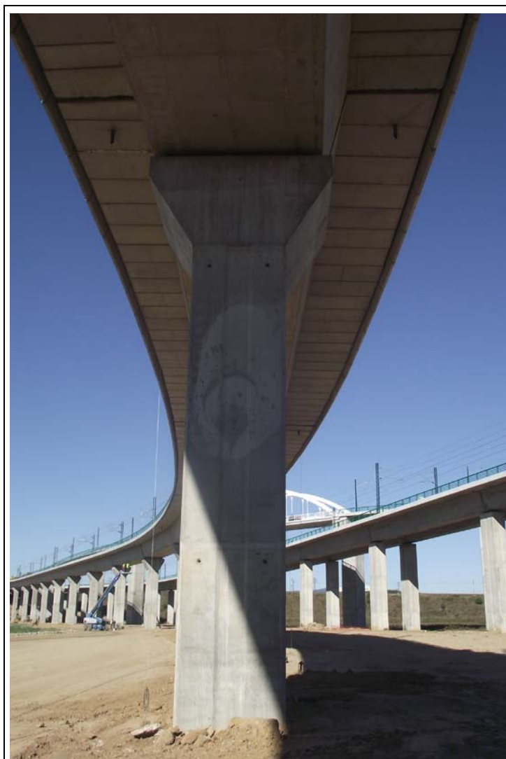
FOTOGRAFÍA N° 49: Pila 14 en Tramo XV.
