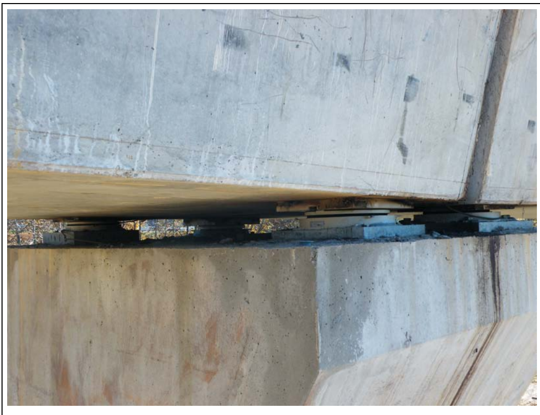
FOTOGRAFÍA N° 80: Apoyos en pila 16.
