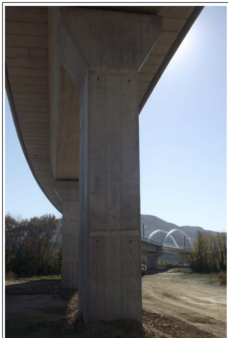
FOTOGRAFÍA Nº 45: Pila 13 en Tramo XIII.
