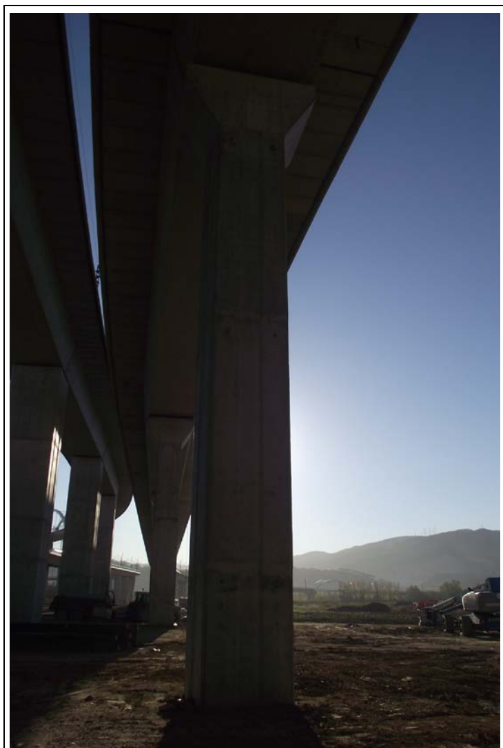
FOTOGRAFÍA Nº 13: Pila 2 en Tramo II.
