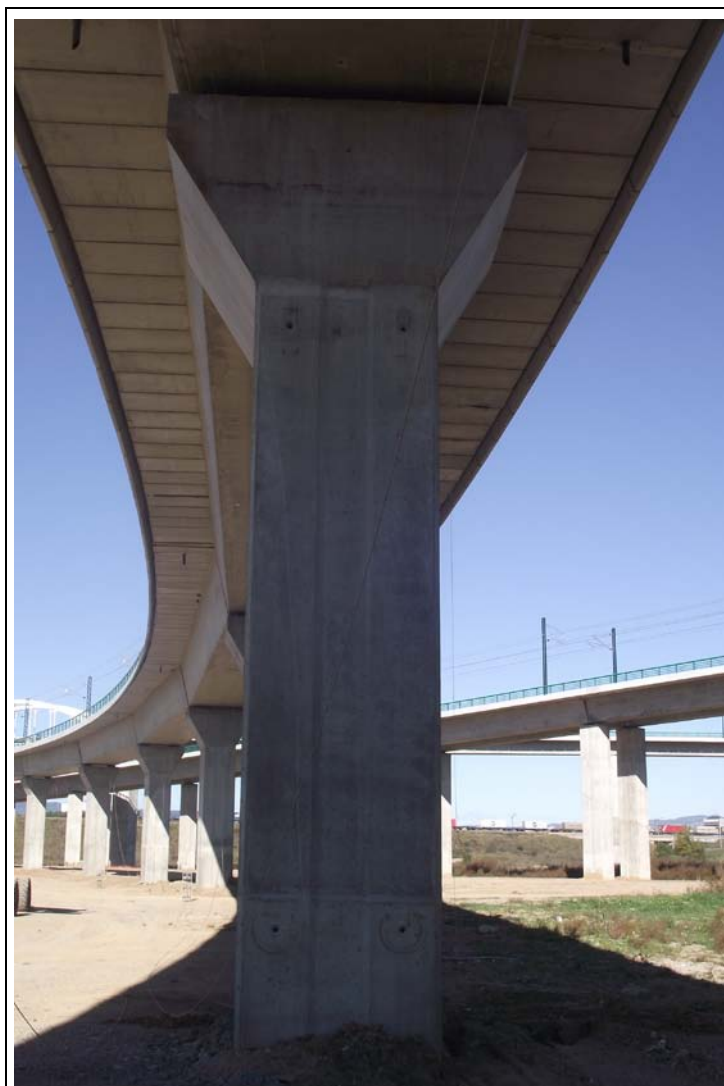
FOTOGRAFÍA N° 58: Pila 17 en Tramo XVIII.
