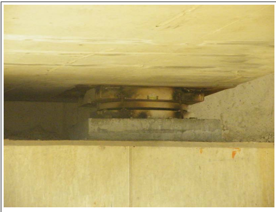
FOTOGRAFÍA N° 64: Apoyo izquierdo sobre el estribo de entrada.
