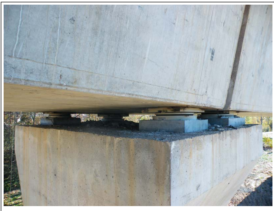
FOTOGRAFÍA N° 81: Apoyos en pila 17.
