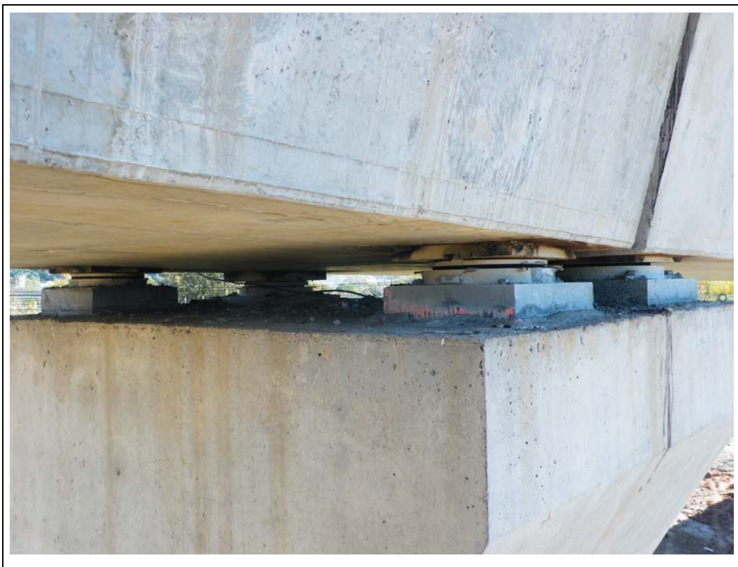
FOTOGRAFÍA N° 82: Apoyos en pila 18.
