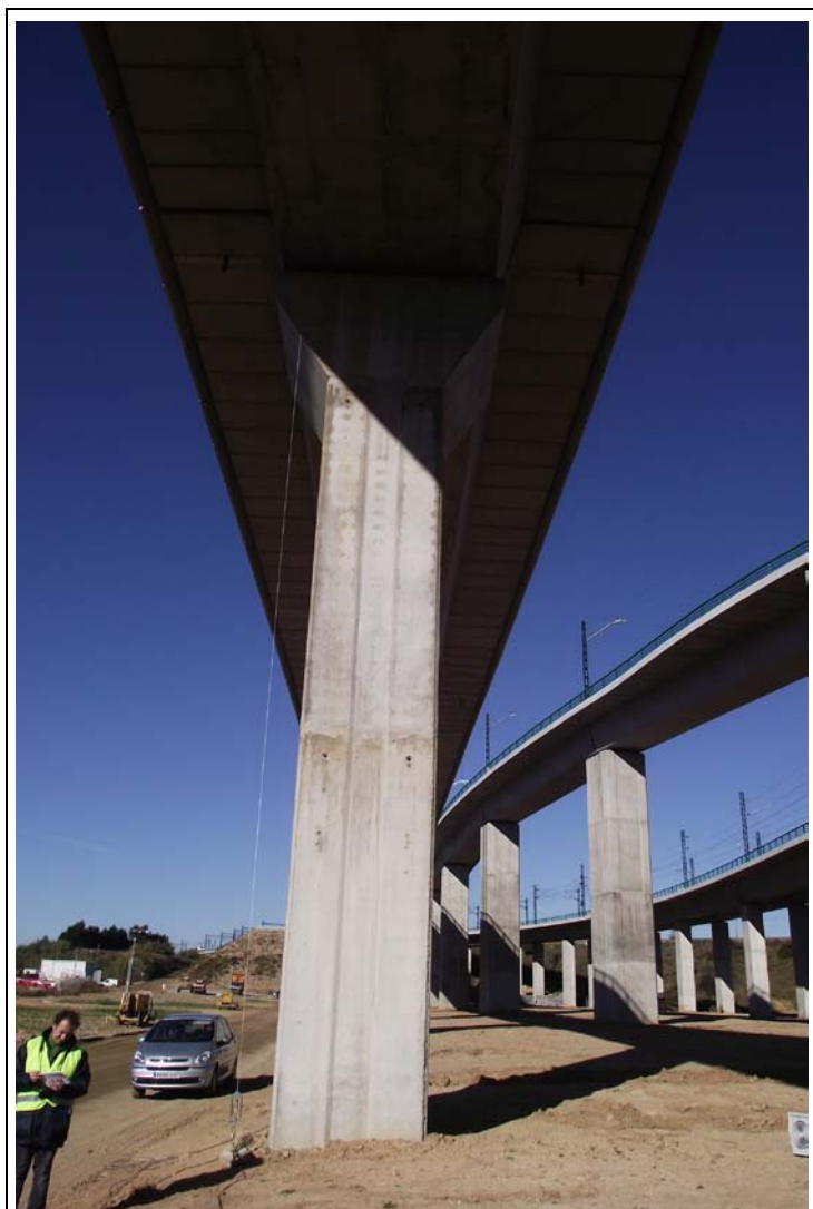
FOTOGRAFÍA Nº 34: Pila 9 en Tramo X.
