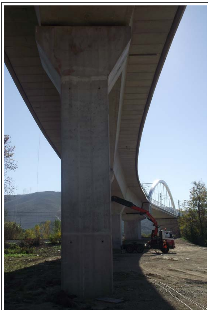
FOTOGRAFÍA N° 54: Pila 16 en Tramo XVI.
