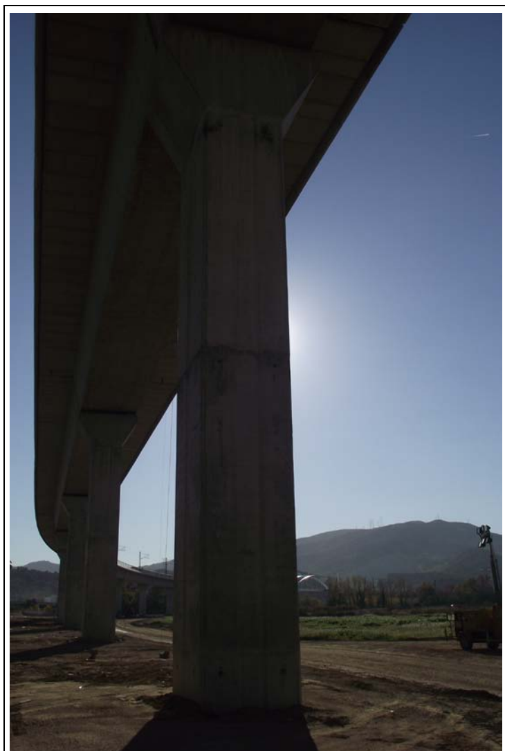
FOTOGRAFÍA Nº 24: Pila 6 en Tramo VI.
