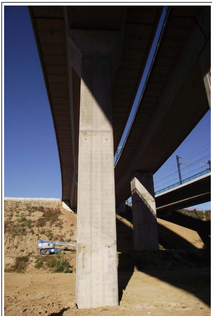
FOTOGRAFÍA Nº 14: Pila 2 en Tramo III.
