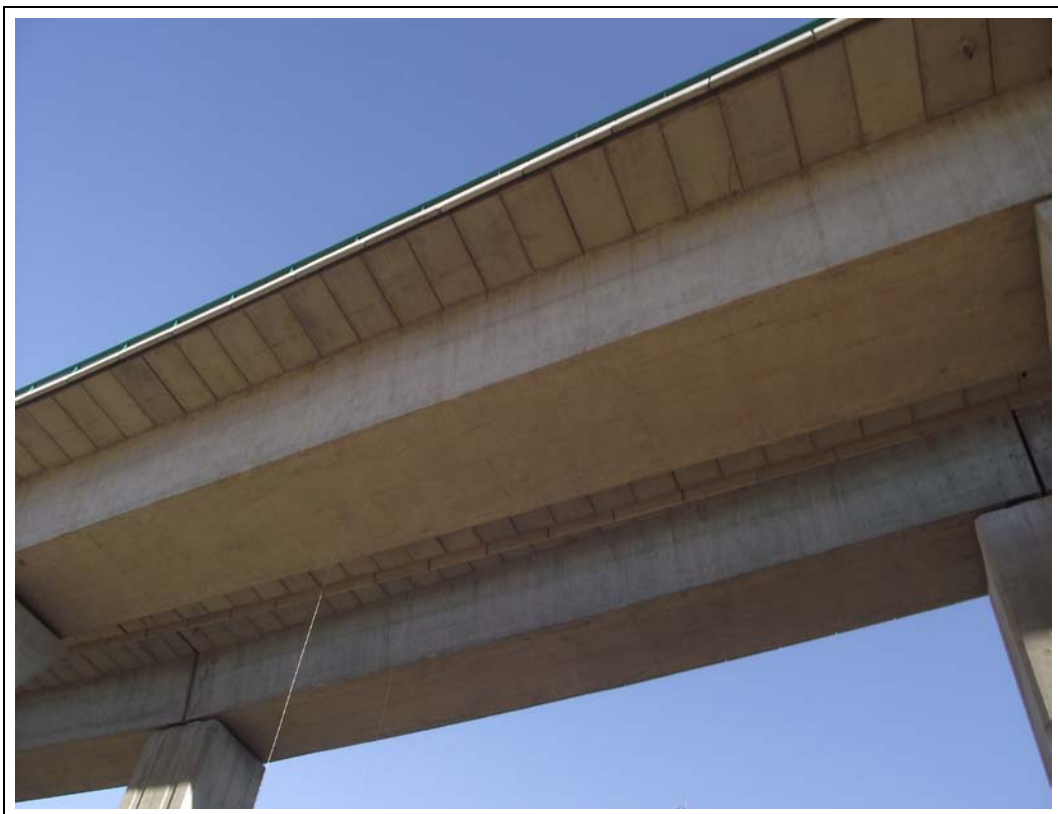
FOTOGRAFÍA N° 12: Fibra inferior del Tramo III.
