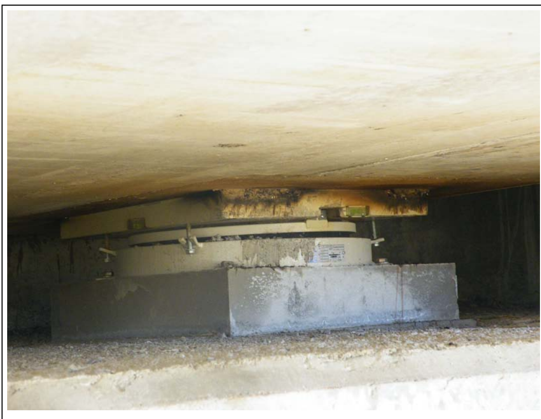
FOTOGRAFÍA N° 83: Apoyo derecho sobre el estribo de salida.
