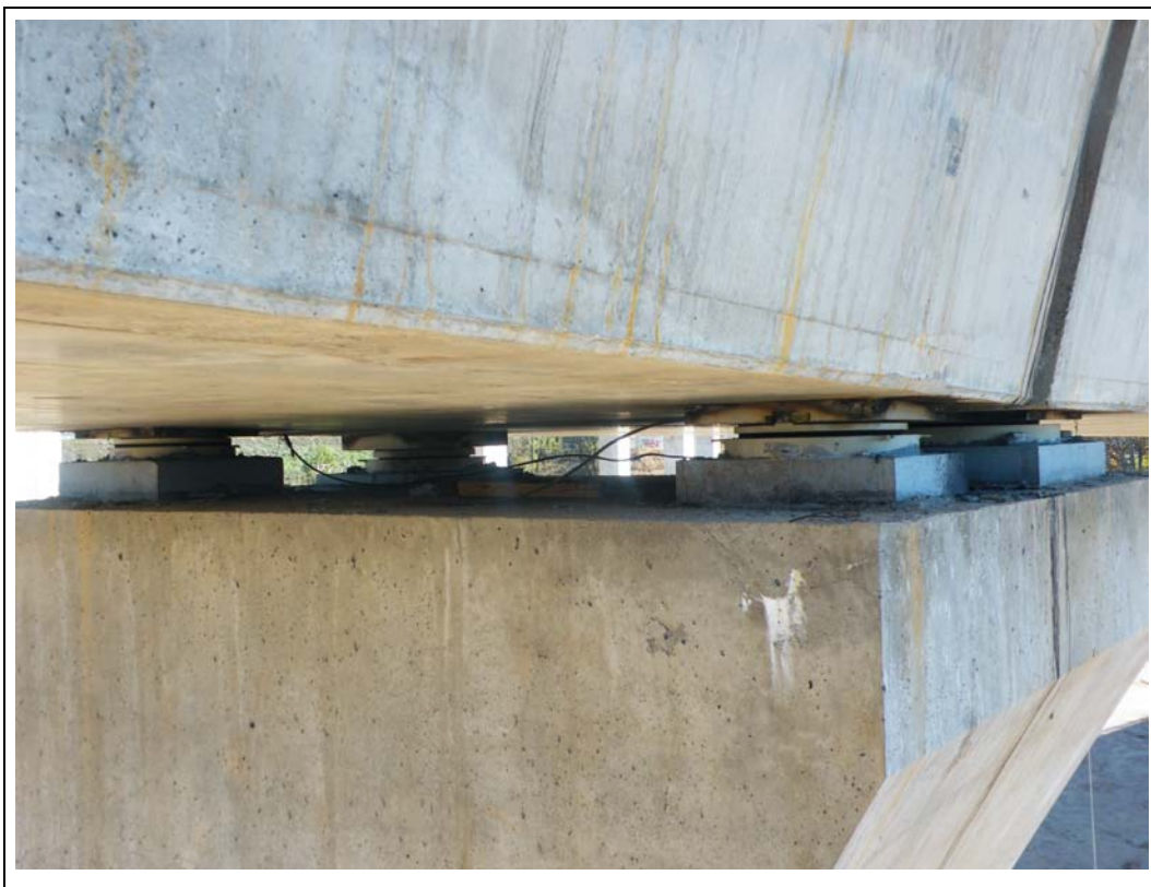
FOTOGRAFÍA N° 76: Apoyos en pila 12.
