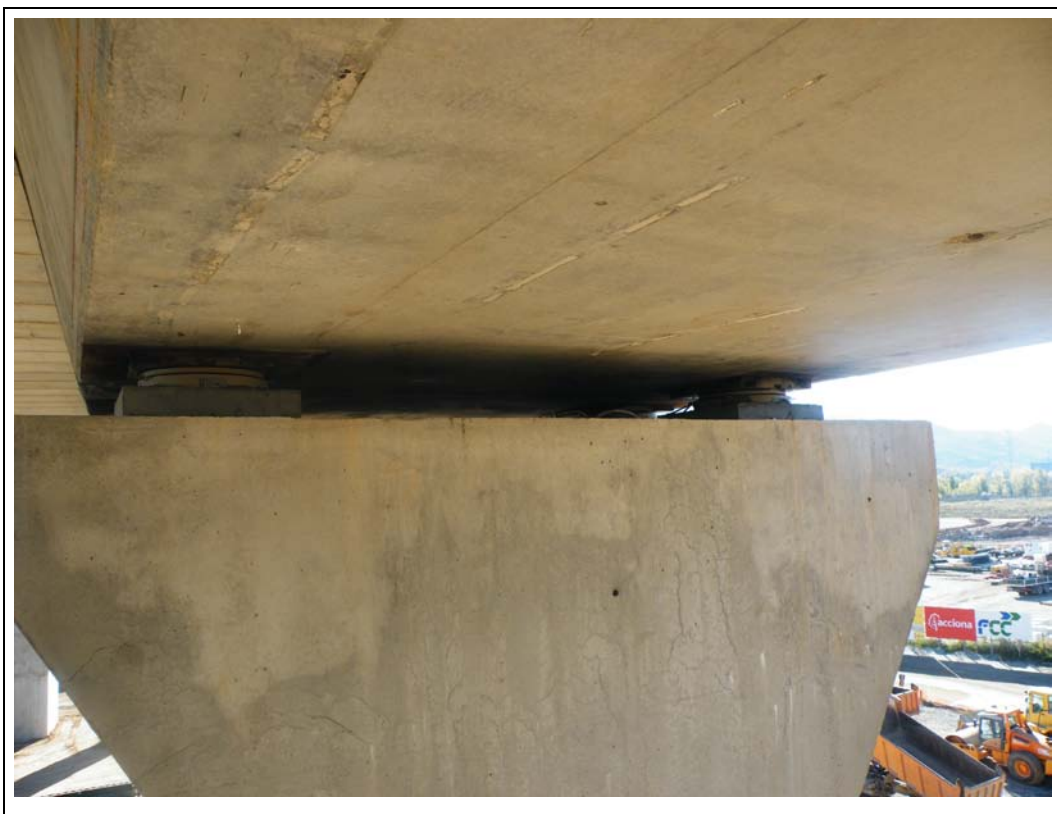
FOTOGRAFÍA N° 65: Apoyos en pila 1.
