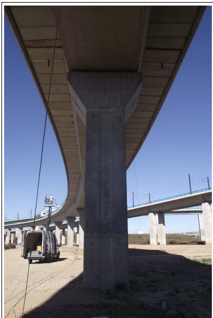
FOTOGRAFÍA Nº 55: Pila 16 en Tramo XVII.
