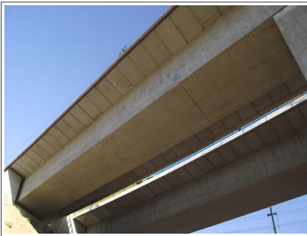
FOTOGRAFÍA N° 8: Fibra inferior del Tramo I.
