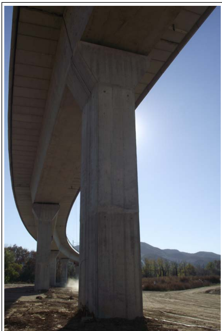
FOTOGRAFÍA Nº 39: Pila 11 en Tramo XI.
