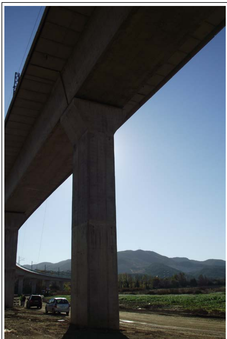
FOTOGRAFÍA Nº 30: Pila 8 en Tramo VIII.
