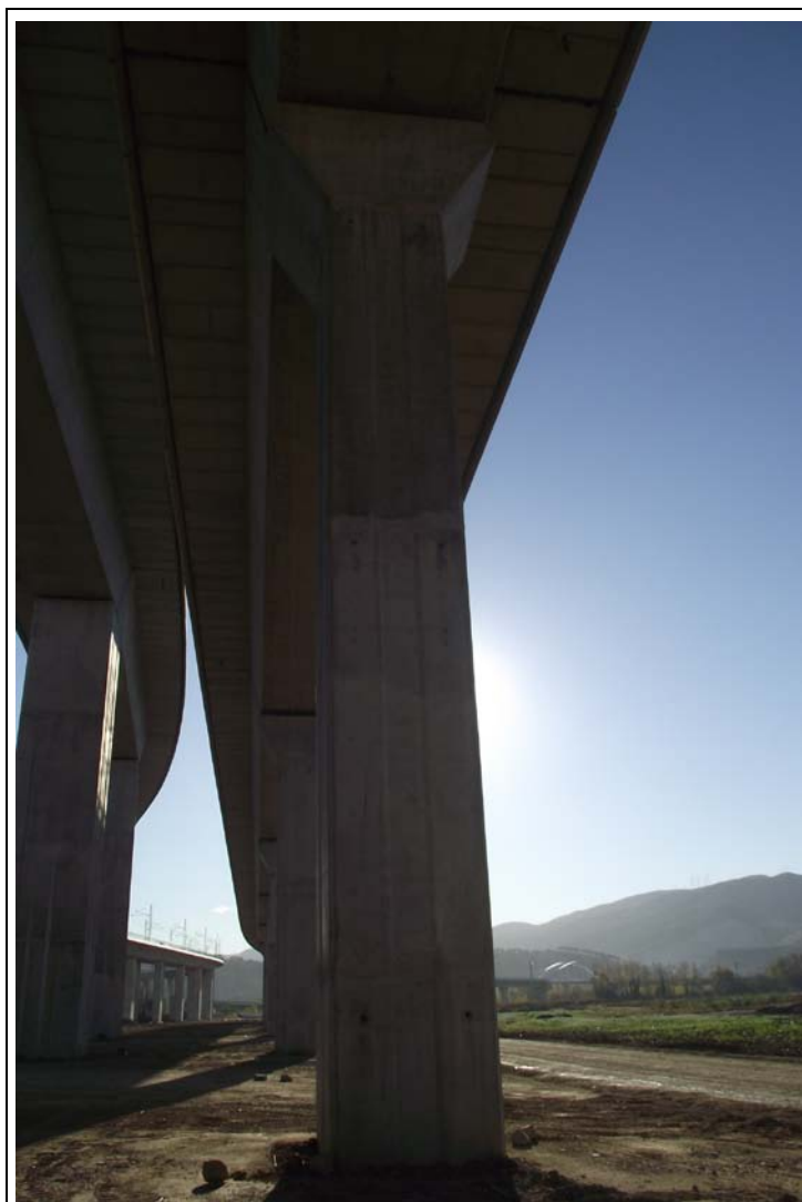
FOTOGRAFÍA Nº 18: Pila 4 en Tramo IV.
