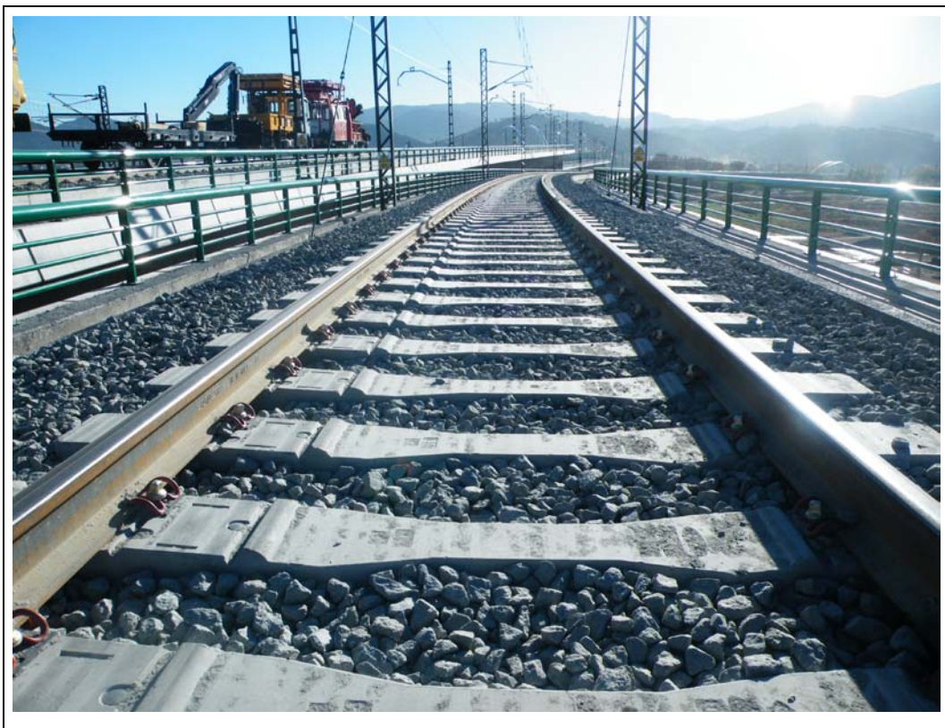
FOTOGRAFÍA Nº 93: Material de vía.
