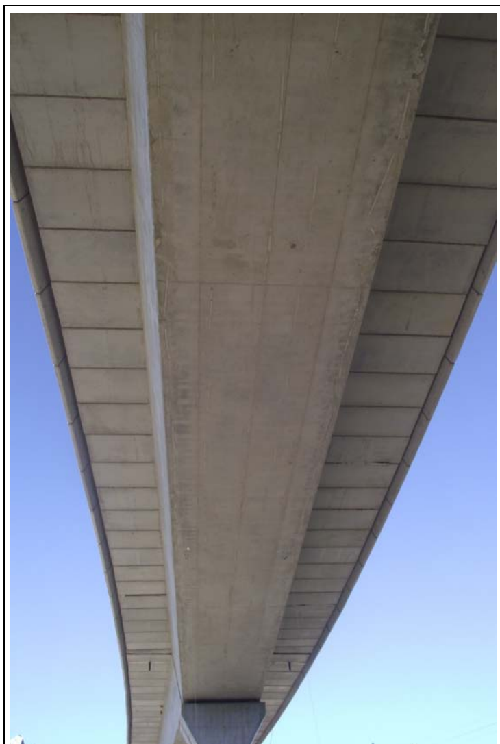
FOTOGRAFÍA Nº 56: Fibra inferior del Tramo XVII.
