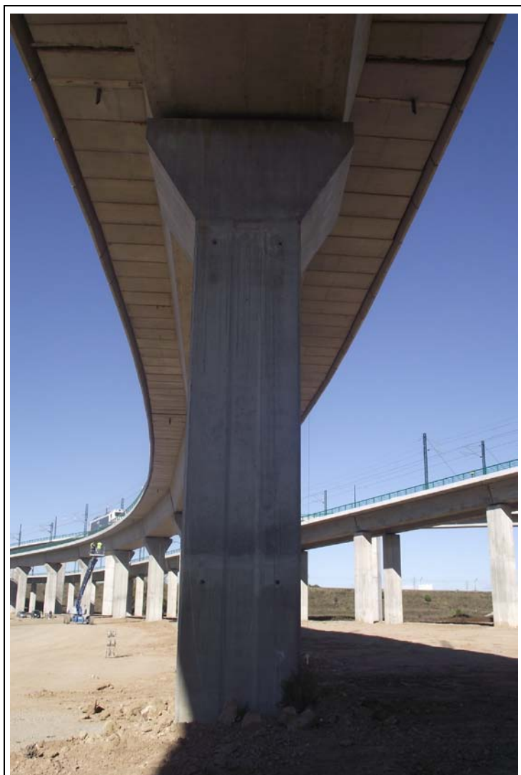
FOTOGRAFÍA Nº 52: Pila 15 en Tramo XVI.
