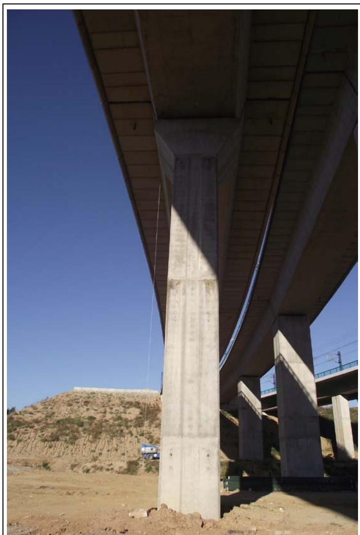
FOTOGRAFÍA Nº 16: Pila 3 en Tramo IV.
