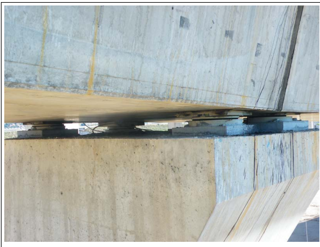
FOTOGRAFÍA N° 75: Apoyos en pila 11.
