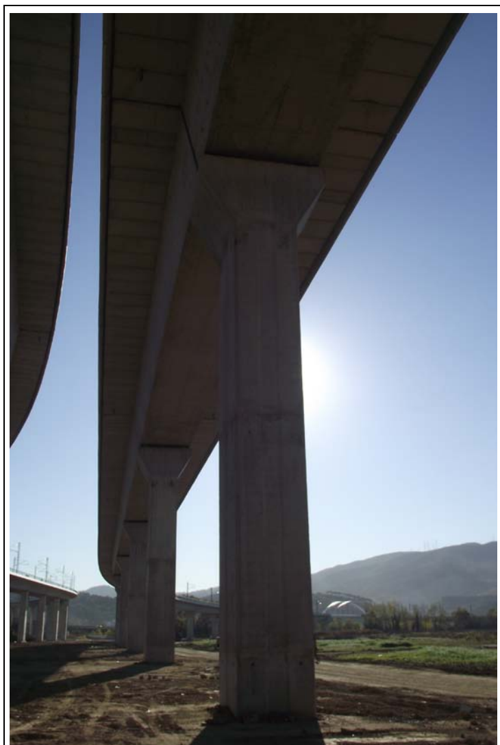
FOTOGRAFÍA Nº 21: Pila 5 en Tramo V.
