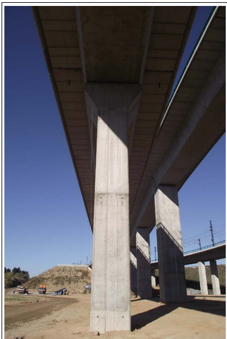
FOTOGRAFÍA Nº 25: Pila 6 en Tramo VII.
