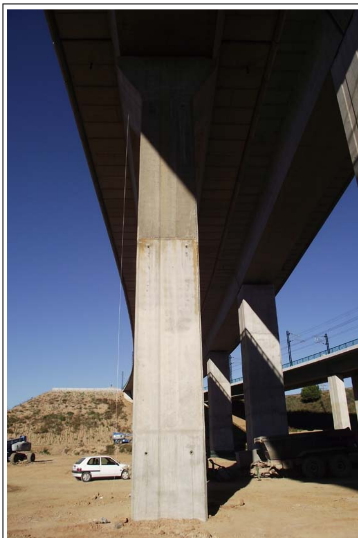
FOTOGRAFÍA Nº 19: Pila 4 en Tramo V.
