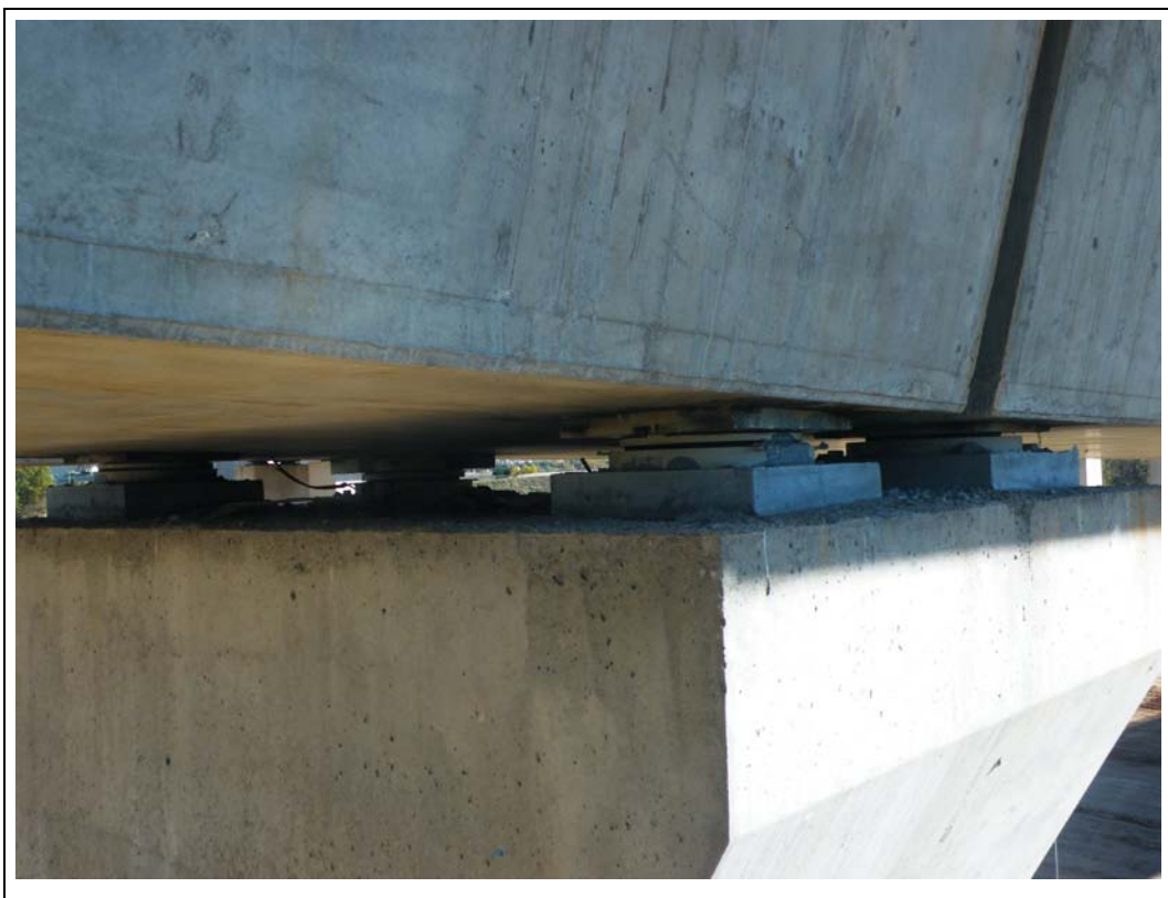
FOTOGRAFÍA N° 73: Apoyos en pila 9.
