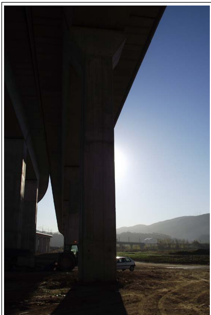
FOTOGRAFÍA Nº 15: Pila 3 en Tramo III.
