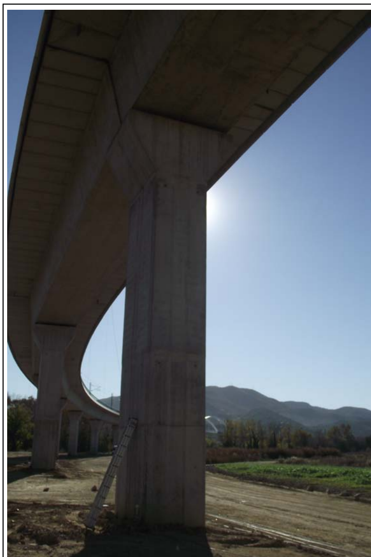
FOTOGRAFÍA N° 36: Pila 10 en Tramo X.
