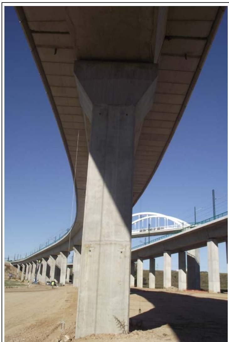
FOTOGRAFÍA Nº 46: Pila 13 en Tramo XIV.
