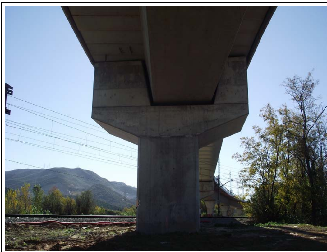
FOTOGRAFÍA N° 7: Pila-estribo de salida.
