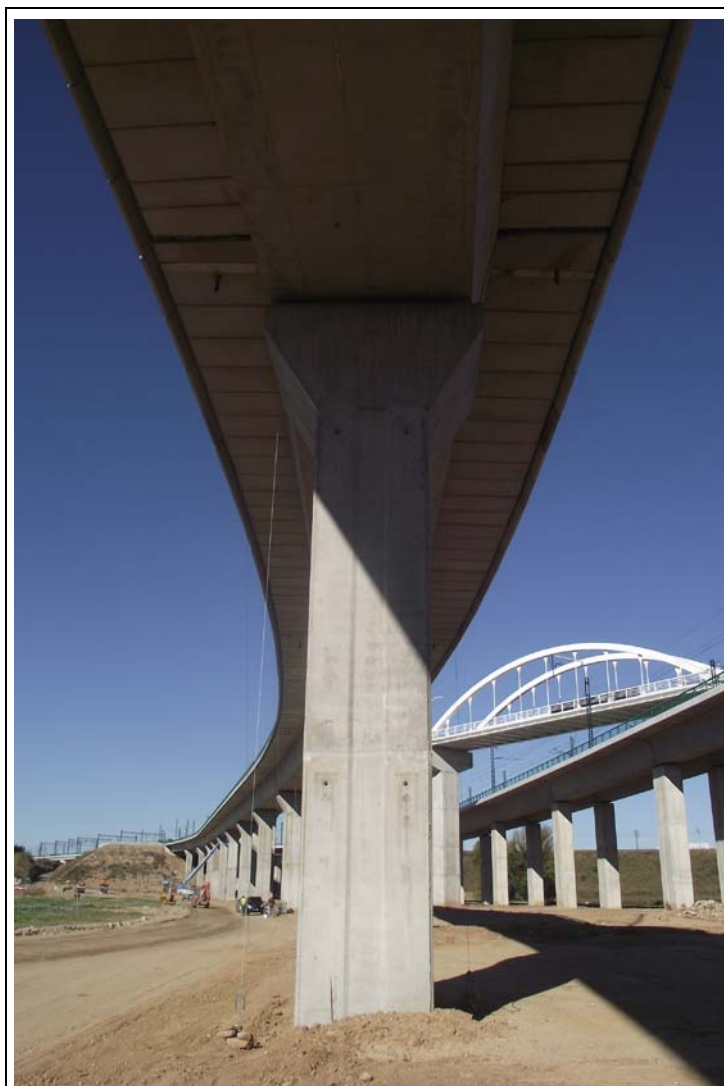
FOTOGRAFÍA Nº 43: Pila 12 en Tramo XIII.
