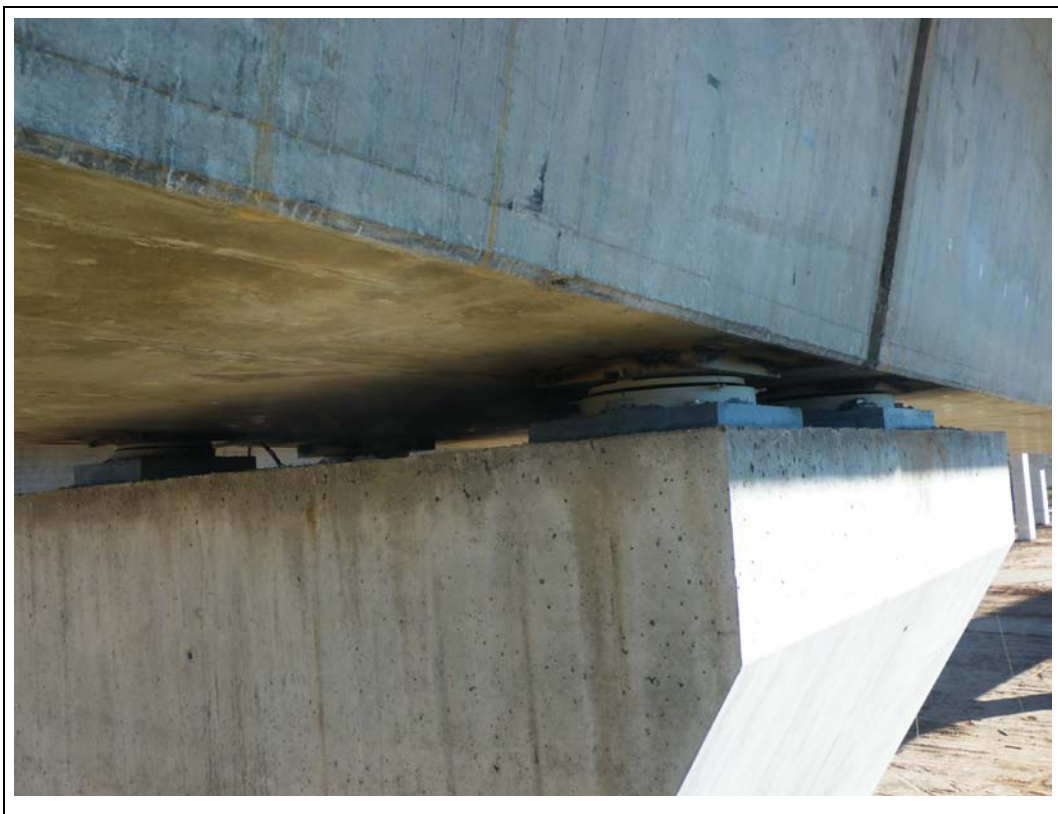
FOTOGRAFÍA N° 72: Apoyos en pila 8.
