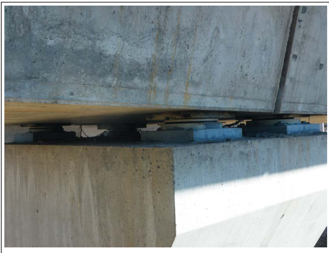
FOTOGRAFÍA N° 70: Apoyos en pila 6.
