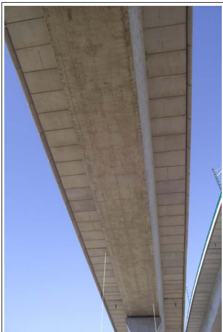
FOTOGRAFÍA Nº 26: Fibra inferior del Tramo VII.
