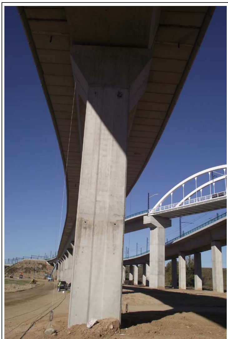
FOTOGRAFÍA Nº 40: Pila 11 en Tramo XII.
