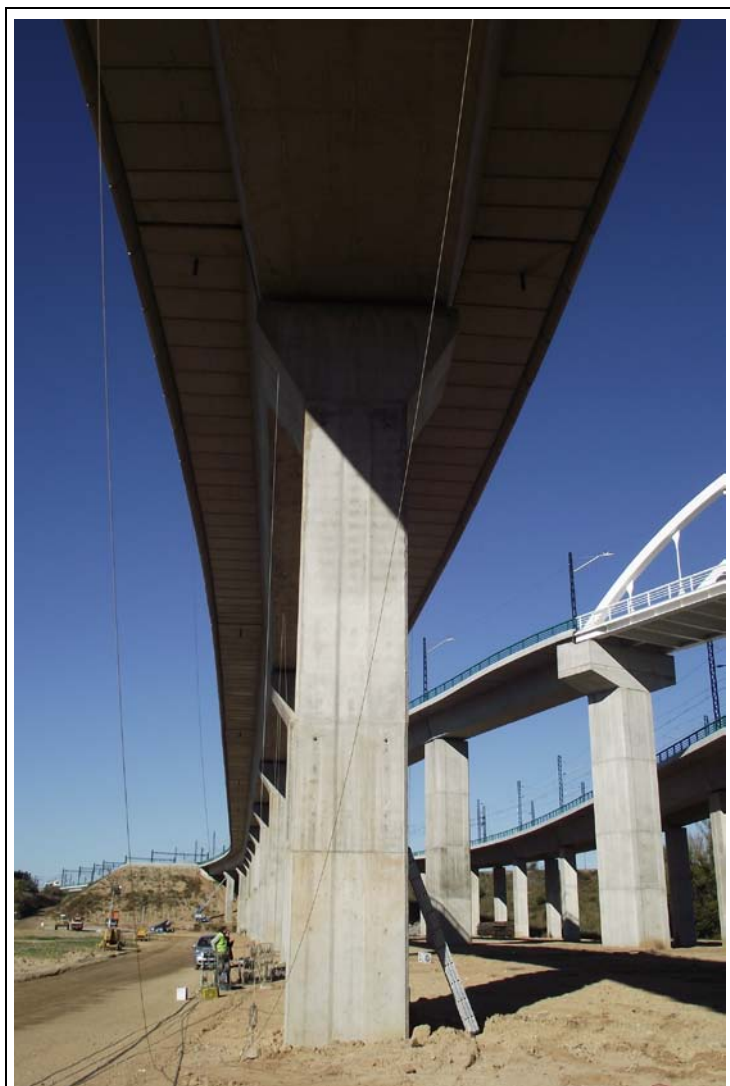
FOTOGRAFÍA Nº 37: Pila 10 en Tramo XI.
