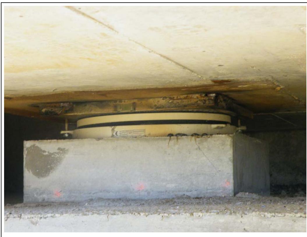
FOTOGRAFÍA N° 84: Apoyo izquierdo sobre el estribo de salida.
