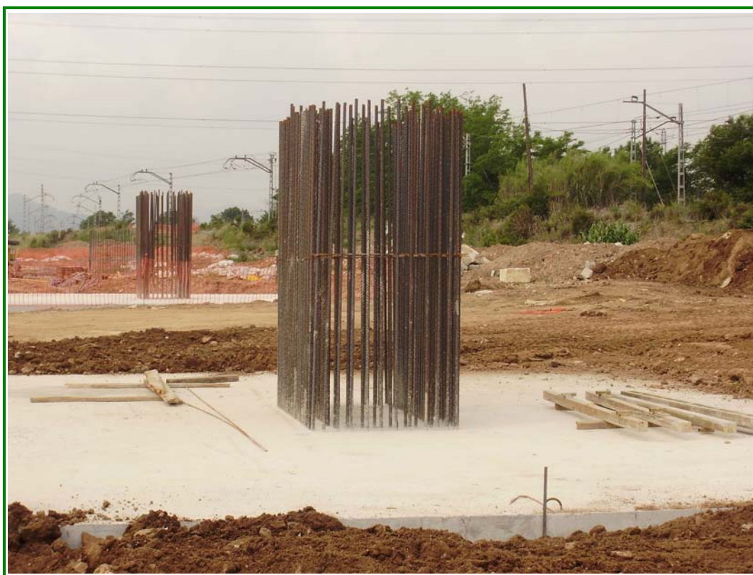
FOTOGRAFÍA N° 2: Vista detalle de armadura de unión pila – encepado.
