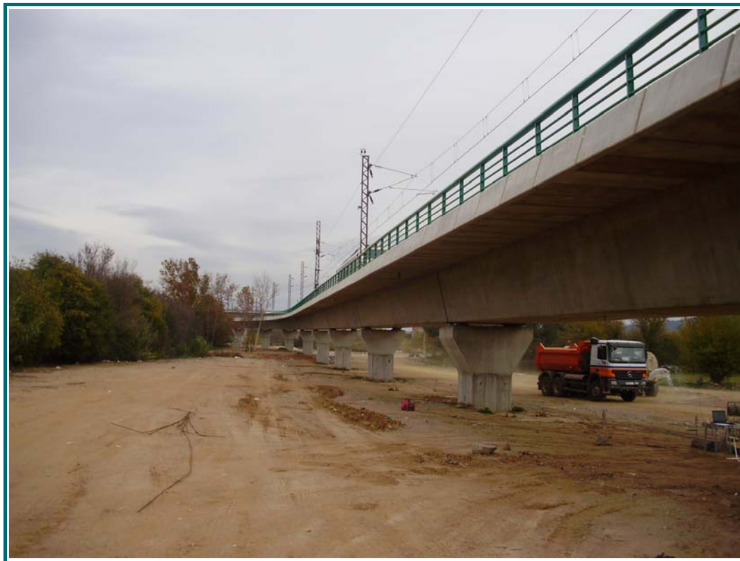
FOTOGRAFÍA Nº 1: Vista general de la estructura.
