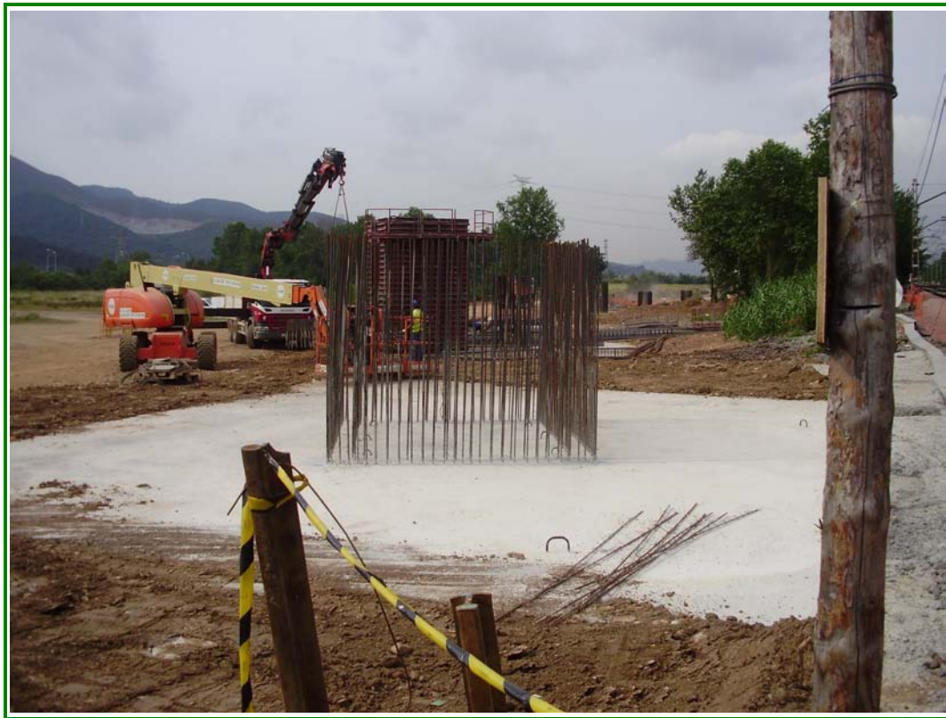
FOTOGRAFÍA N° 3: Vista detalle de armadura de unión estribo 01 – encepado.
