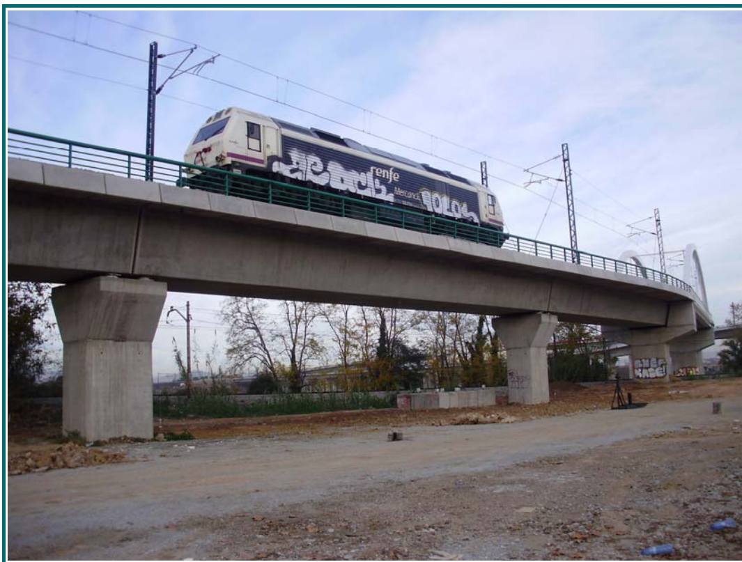
FOTOGRAFÍA Nº 10: Prueba estática de uno de los vanos
