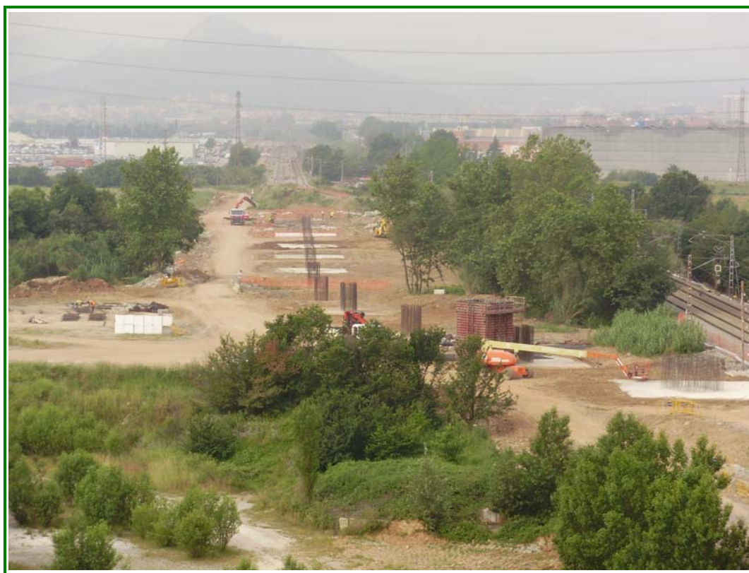
FOTOGRAFÍA N° 1: Vista general de la estructura desde estribo 1.
