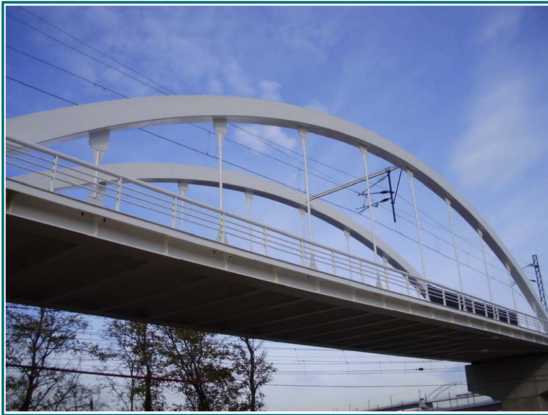
FOTOGRAFÍA N° 1: Vista general de la estructura.
