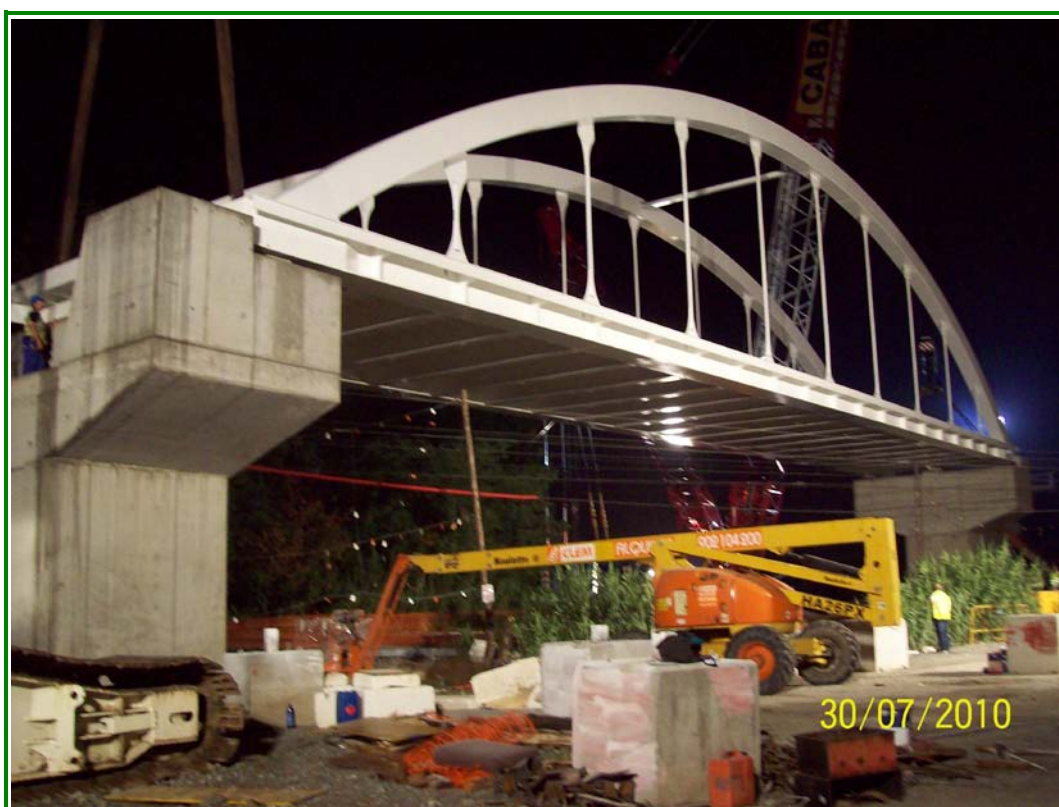
FOTOGRAFÍA N° 2: Vista general de la estructura 2.
