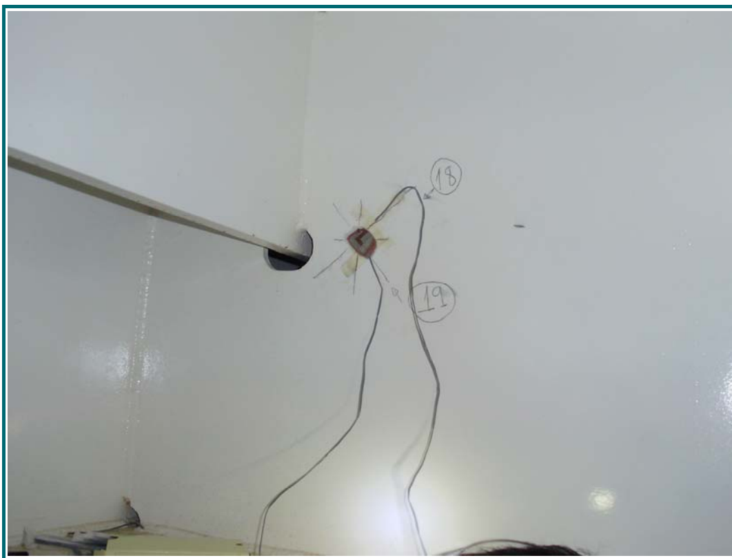
FOTOGRAFÍA N° 7: Detalle de galga extensométrica de cortante.
