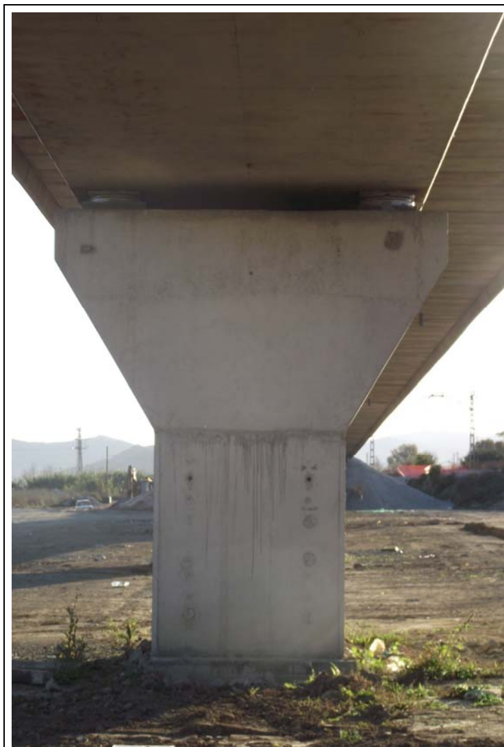
FOTOGRAFÍA Nº 28: Pila 7 vista desde el tramo VII.
