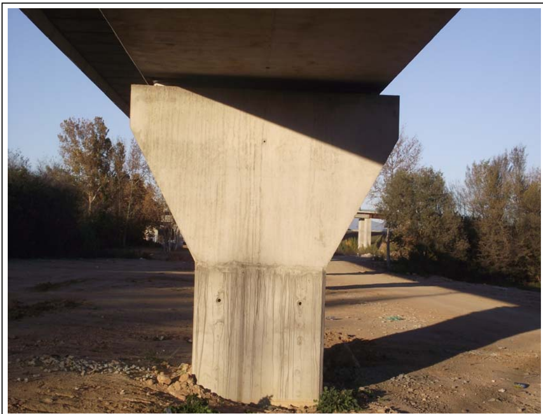
FOTOGRAFÍA N° 32: Pila 8 vista desde tramo IX.
