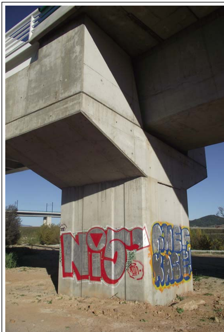
FOTOGRAFÍA Nº 6: Estribo de entrada visto desde el lado izquierdo.
