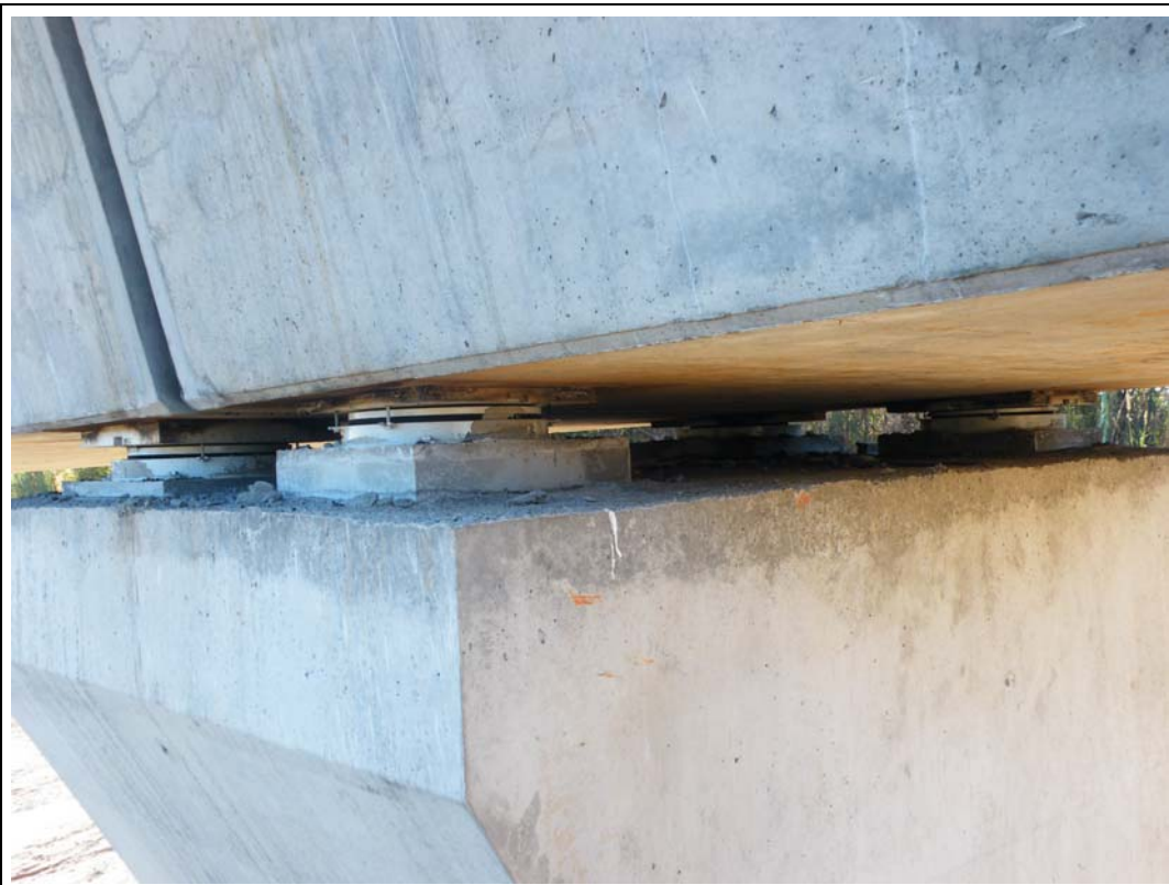
FOTOGRAFÍA N° 49: Apoyo en pila 6 visto desde tramo VI.
