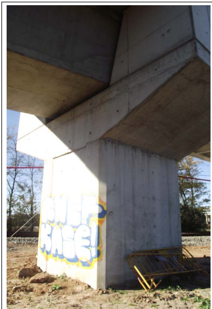
FOTOGRAFÍA Nº 5: Estribo de entrada visto desde el lado derecho.
