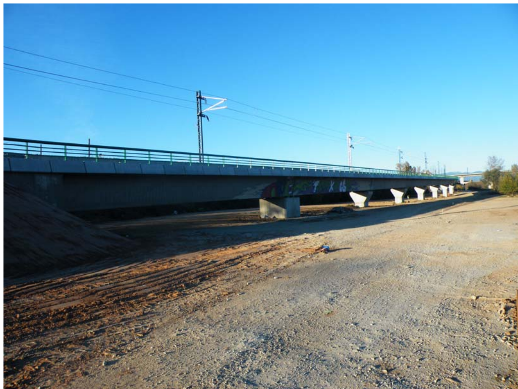
FOTOGRAFÍA Nº 2: Alzado izquierdo visto desde estribo de salida.
