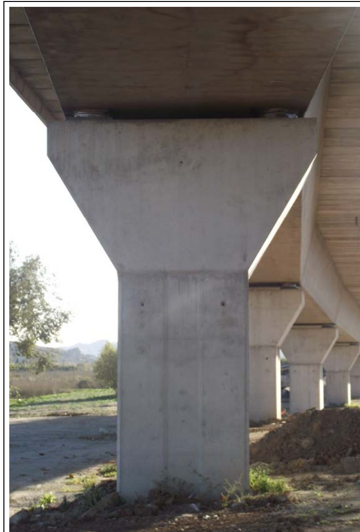
FOTOGRAFÍA Nº 16: Pila 3 vista desde el tramo III.
