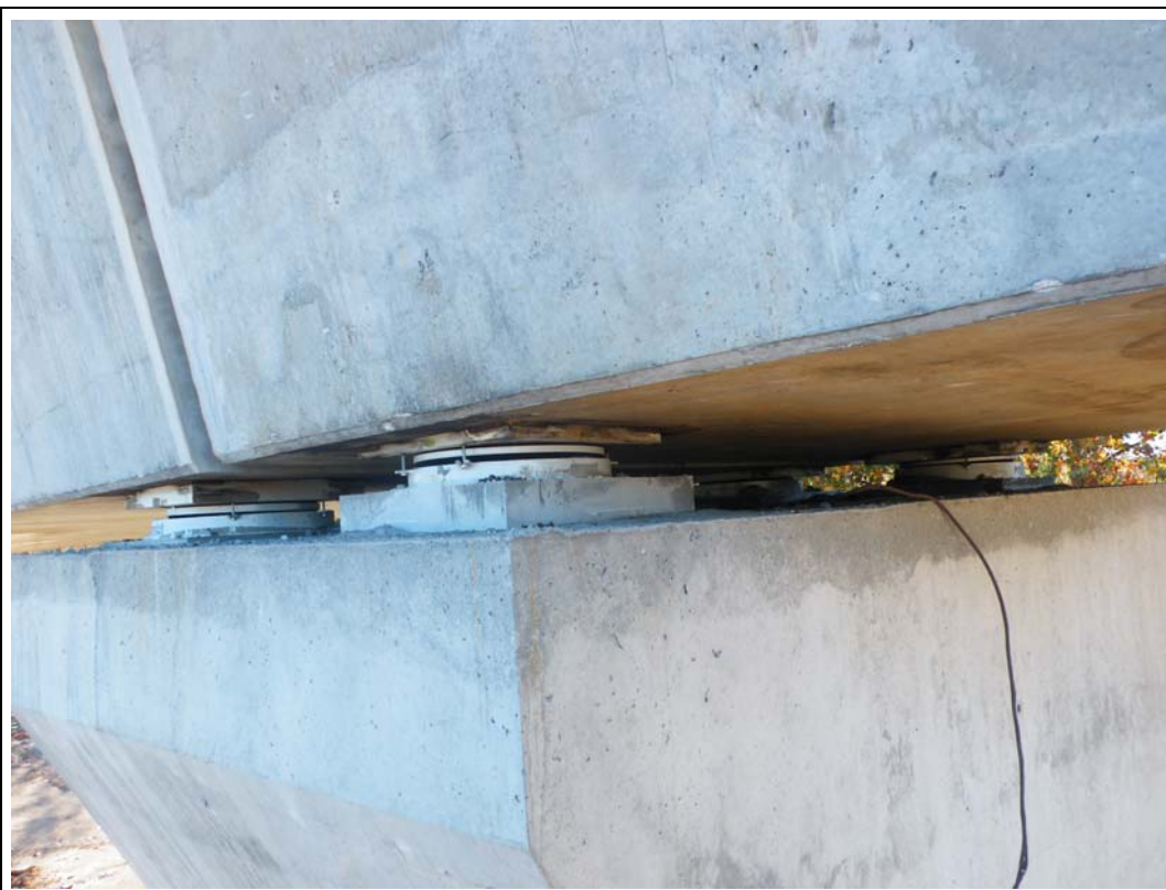
FOTOGRAFÍA N° 45: Apoyo en pila 2 visto desde tramo II.
