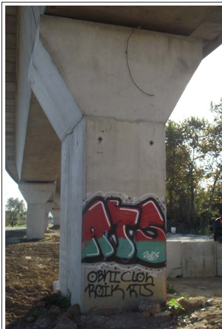
FOTOGRAFÍA Nº 10: Pila 1 vista desde el tramo I.
