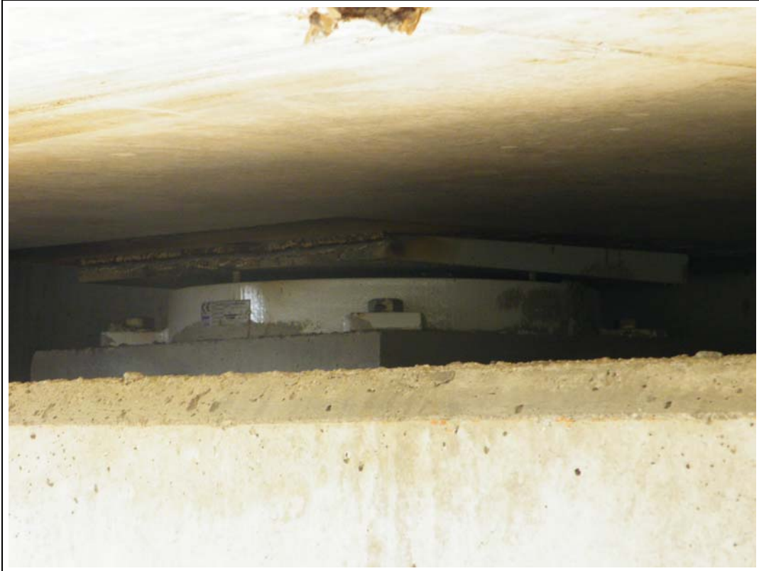
FOTOGRAFÍA N° 40: Apoyo en el estribo de entrada visto desde el lado derecho.
