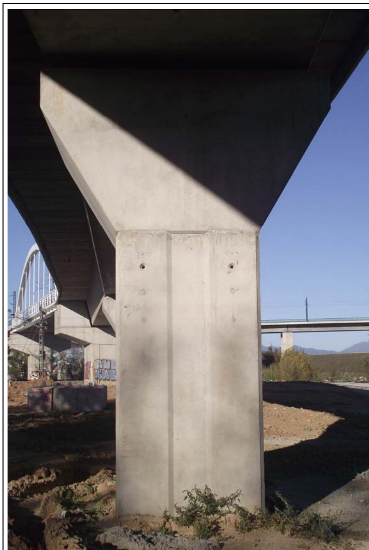
FOTOGRAFÍA Nº 14: Pila 2 vista desde el tramo III.
