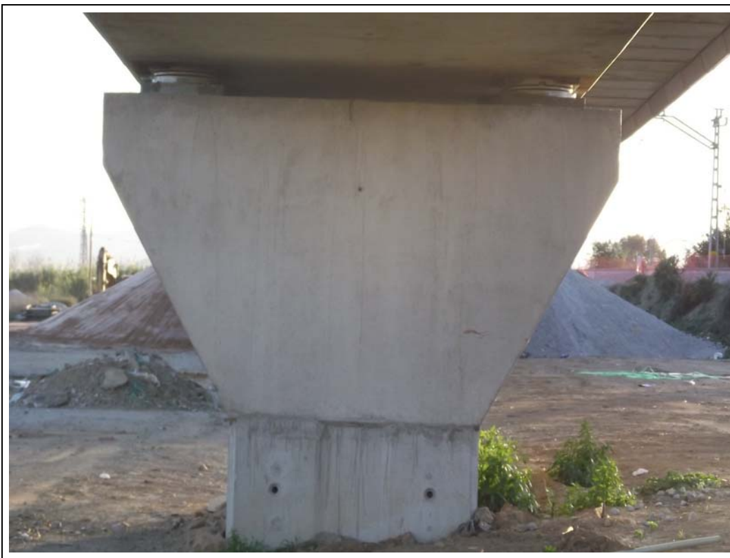
FOTOGRAFÍA N° 34: Pila 9 vista desde tramo IX.
