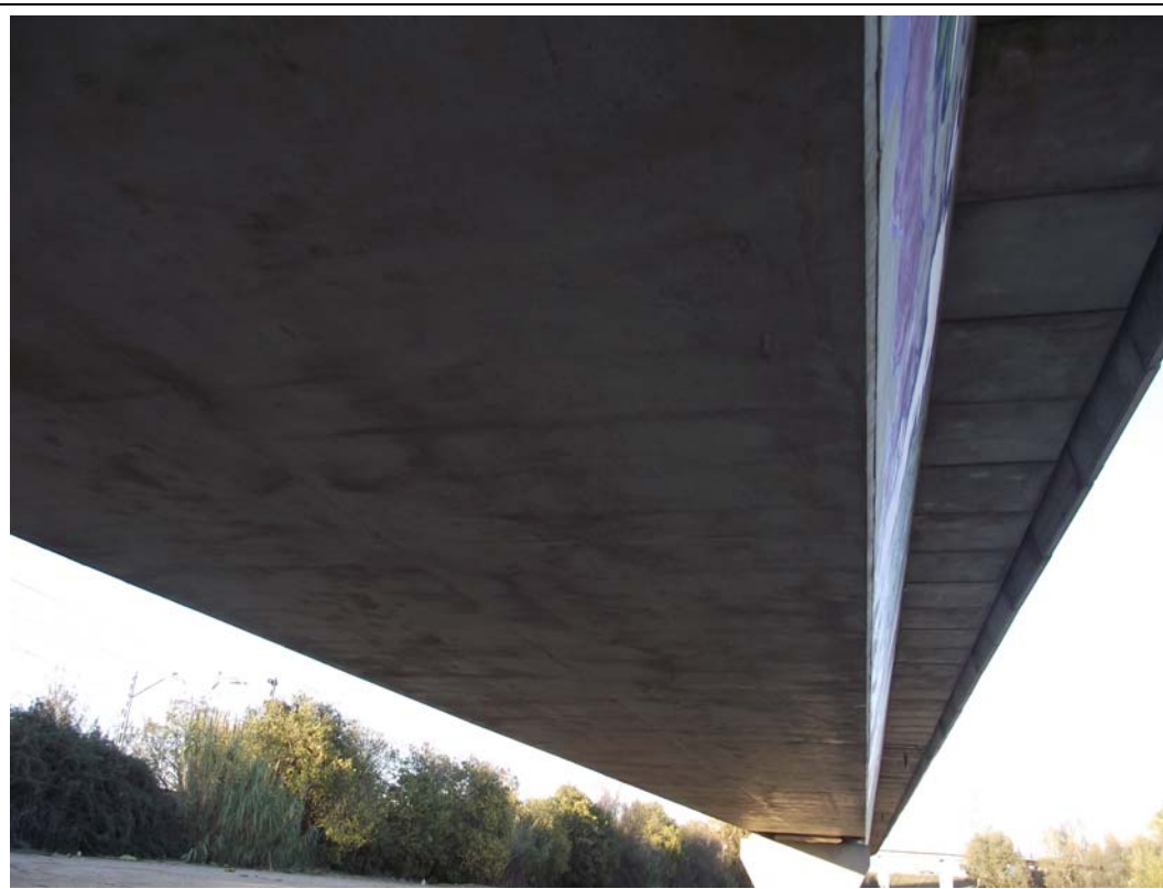
FOTOGRAFÍA N° 36: Fibra inferior del tramo X vista desde el lado izquierdo.
