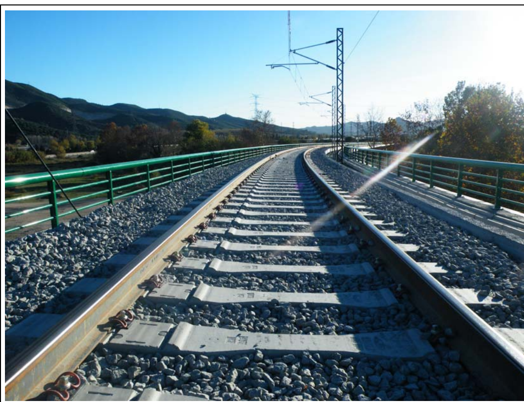
FOTOGRAFÍA Nº 83: Material de vía.
