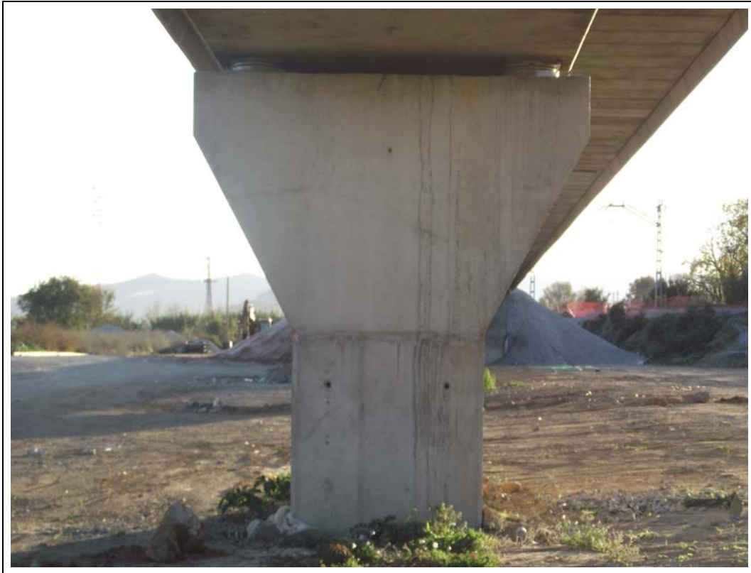
FOTOGRAFÍA N° 31: Pila 8 vista desde tramo VIII.
