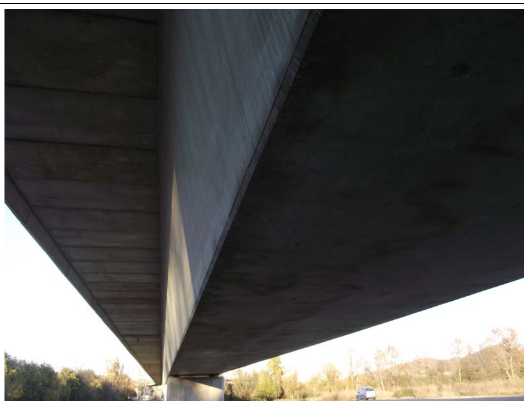
FOTOGRAFÍA N° 39: Fibra inferior del tramo XI vista desde el lado derecho.
