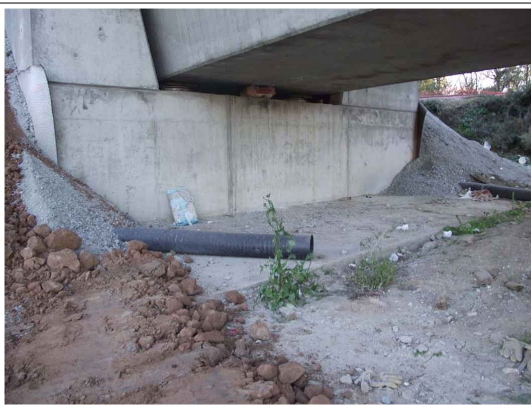
FOTOGRAFÍA Nº 8: Estribo de salida visto desde el lado izquierdo.
