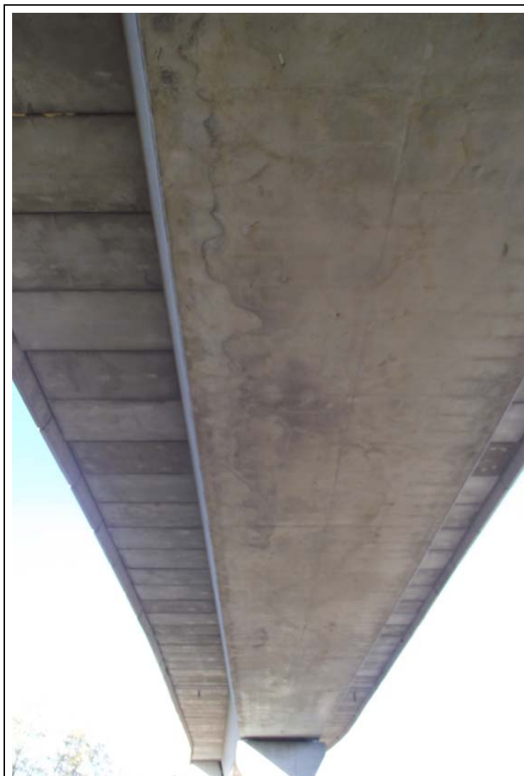
FOTOGRAFÍA Nº 12: Fibra inferior del tramo II vista desde el lado derecho.
