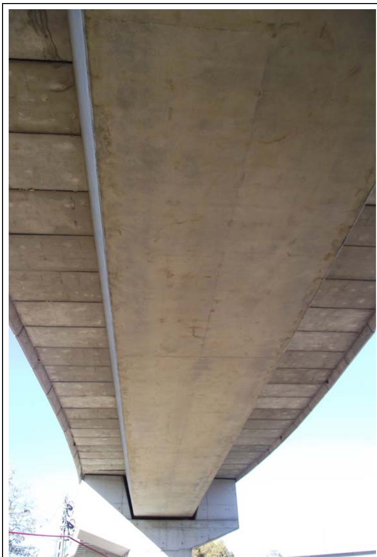
FOTOGRAFÍA Nº 9: Fibra inferior del tramo I vista desde el lado derecho.
