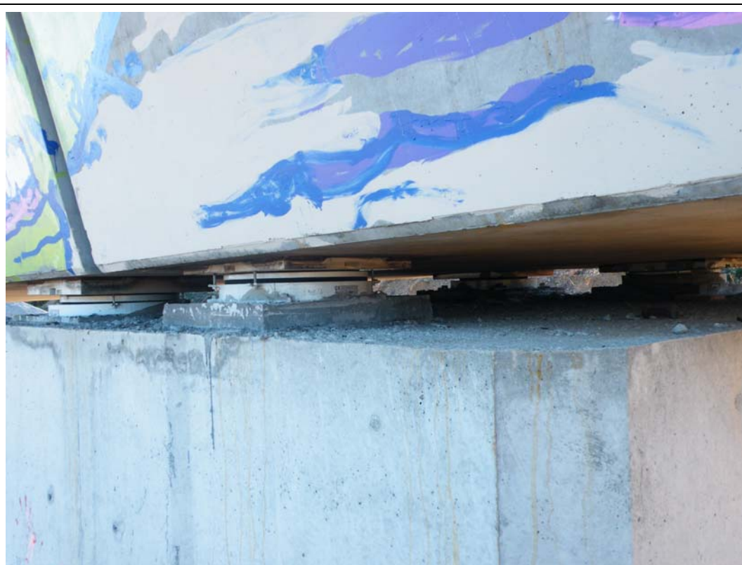
FOTOGRAFÍA N° 53: Apoyo en pila 10 visto desde tramo X.
