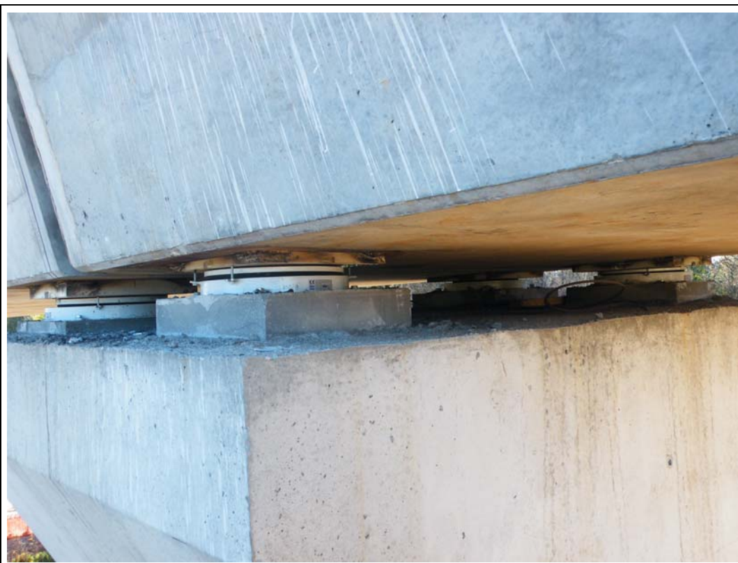
FOTOGRAFÍA N° 47: Apoyo en pila 4 visto desde tramo IV.
