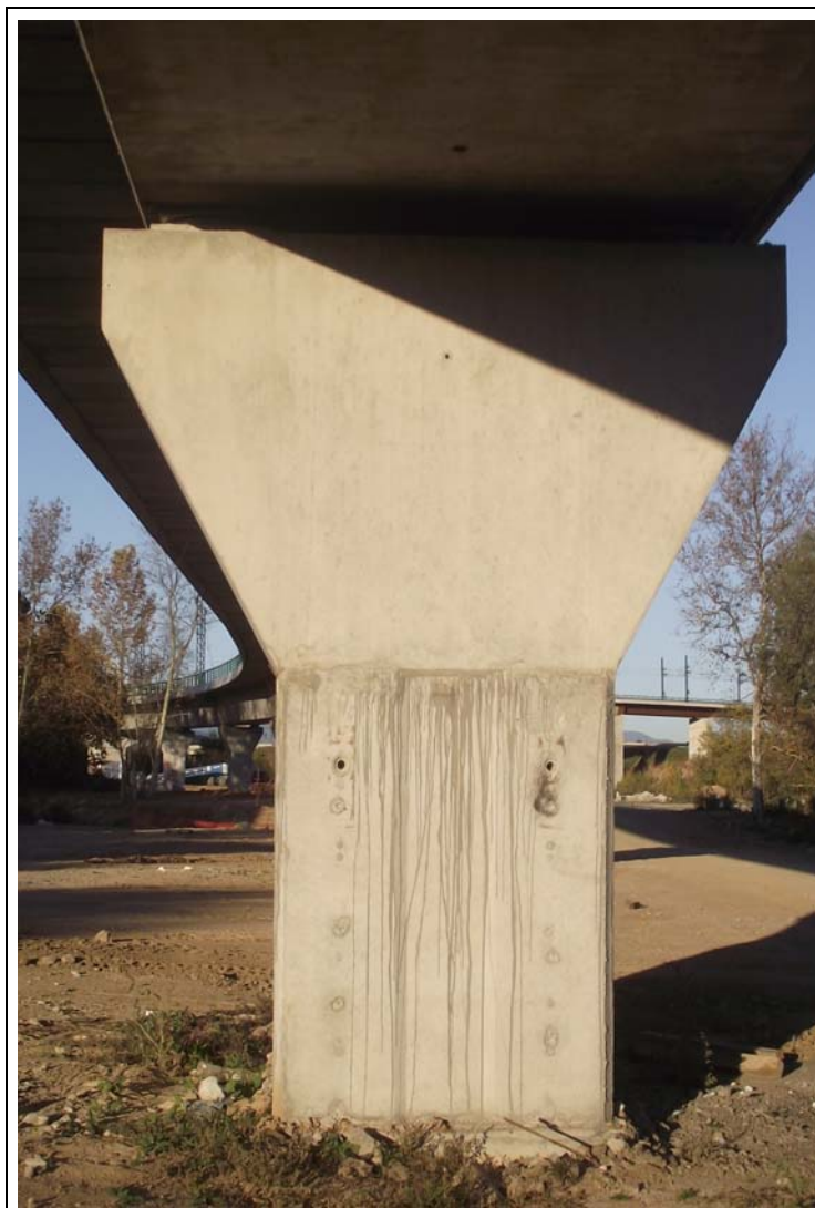
FOTOGRAFÍA Nº 29: Pila 7 vista desde el tramo VIII.
