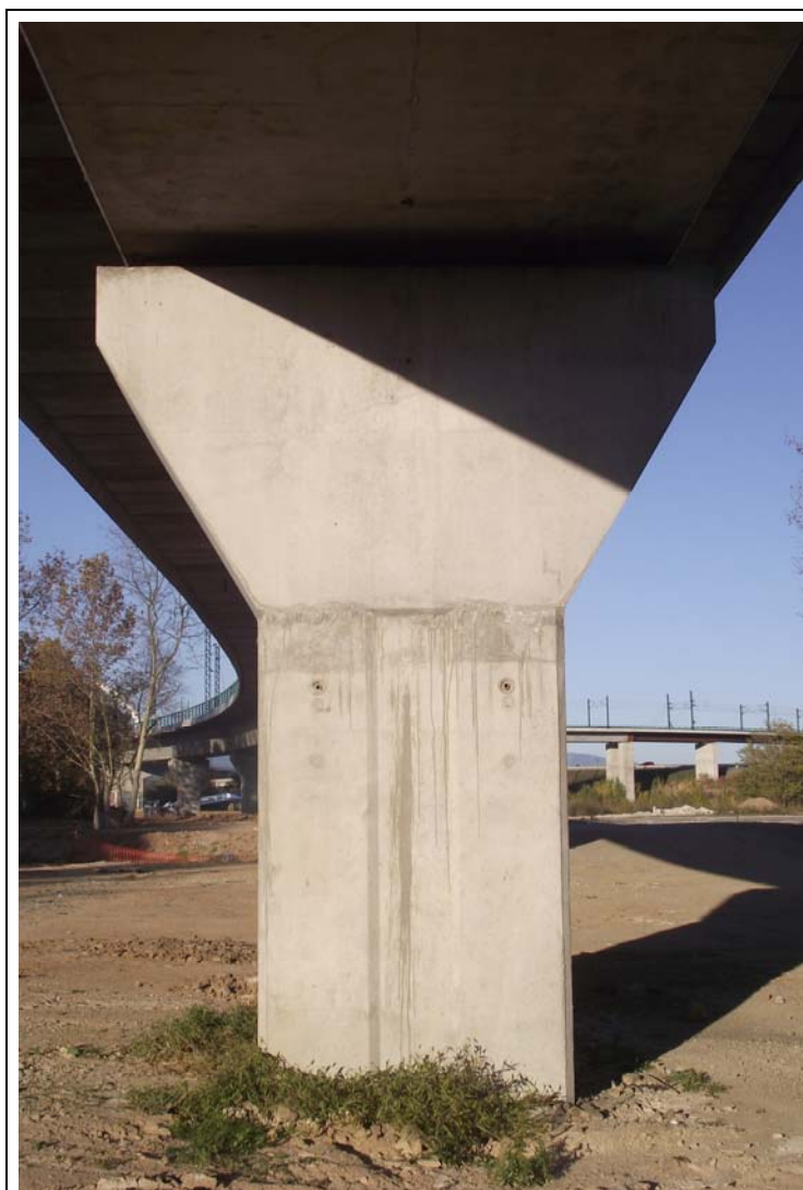
FOTOGRAFÍA Nº 26: Pila 6 vista desde el tramo VII.
