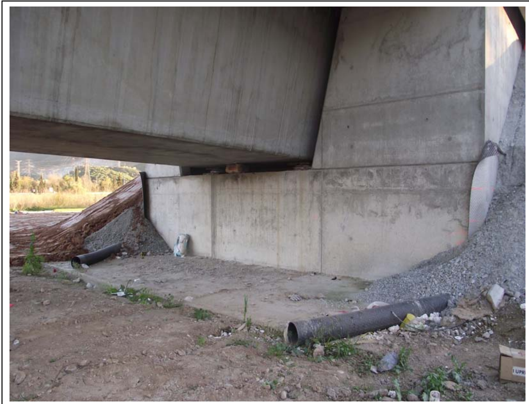
FOTOGRAFÍA Nº 7: Estribo de salida visto desde el lado derecho.
