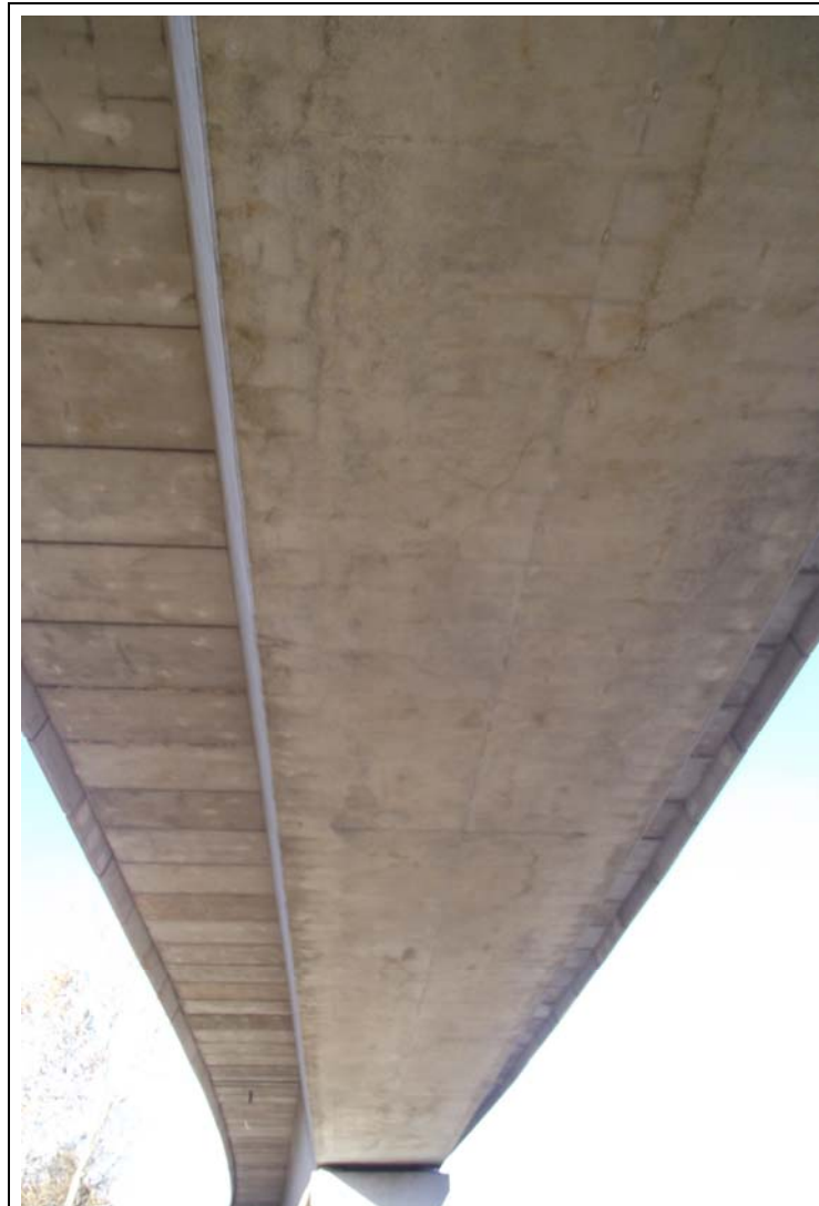
FOTOGRAFÍA Nº 21: Fibra inferior del tramo V vista desde el lado derecho.
