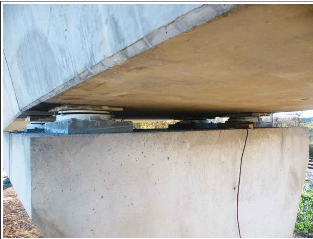
FOTOGRAFÍA N° 44: Apoyo en pila 1 visto desde tramo I.
