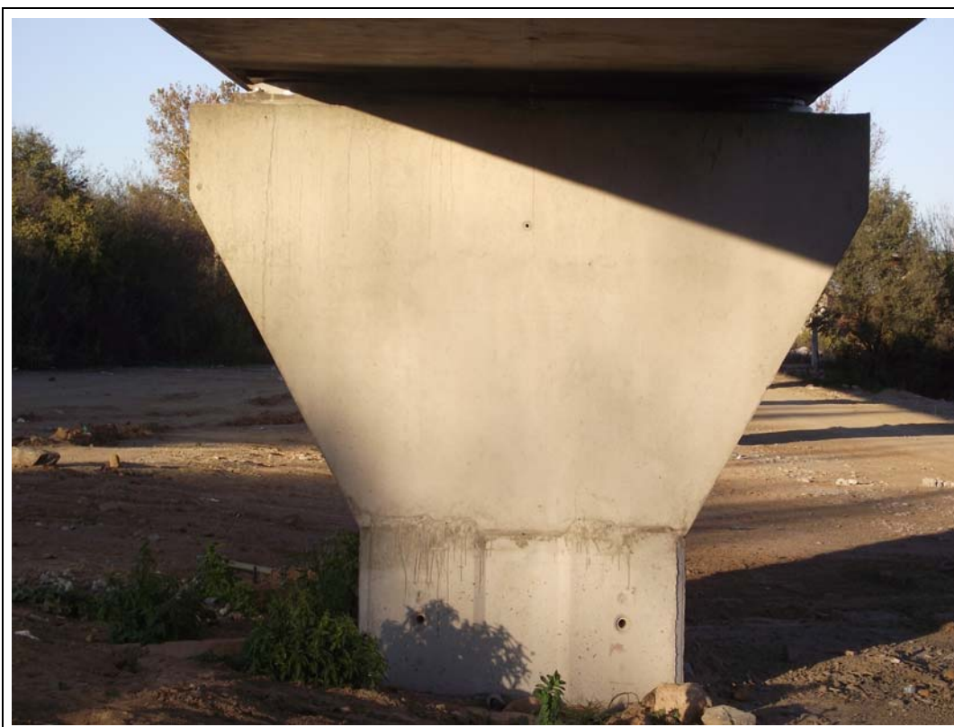
FOTOGRAFÍA N° 35: Pila 9 vista desde el tramo X.
