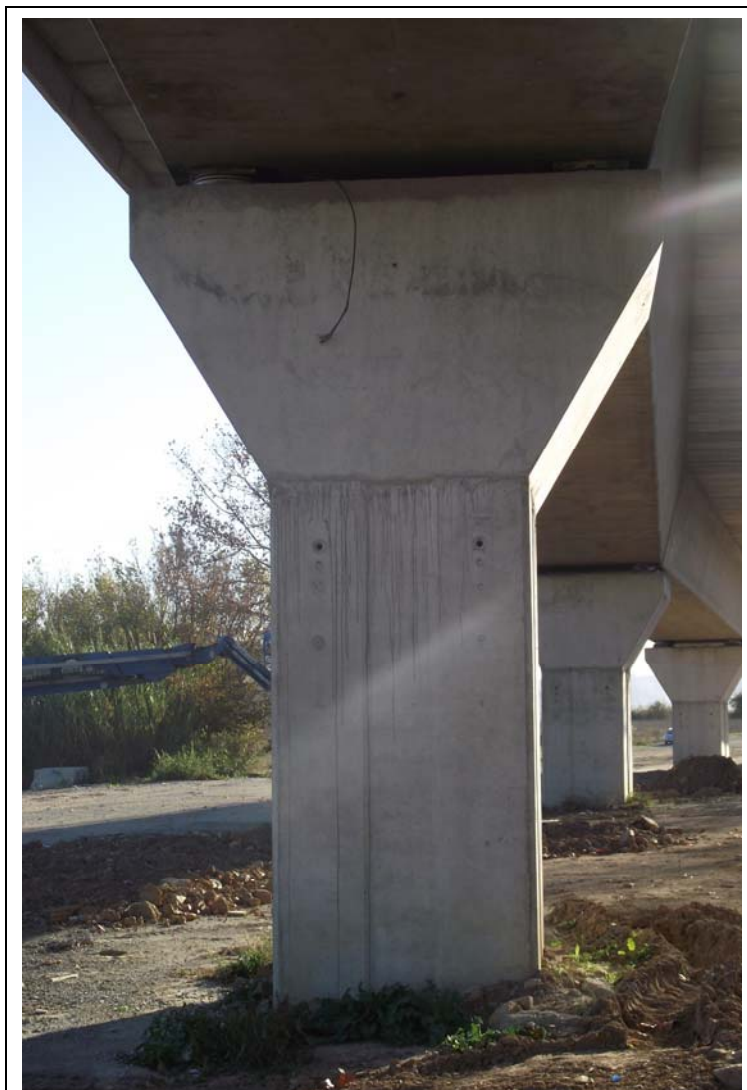
FOTOGRAFÍA Nº 13: Pila 2 vista desde el tramo II.
