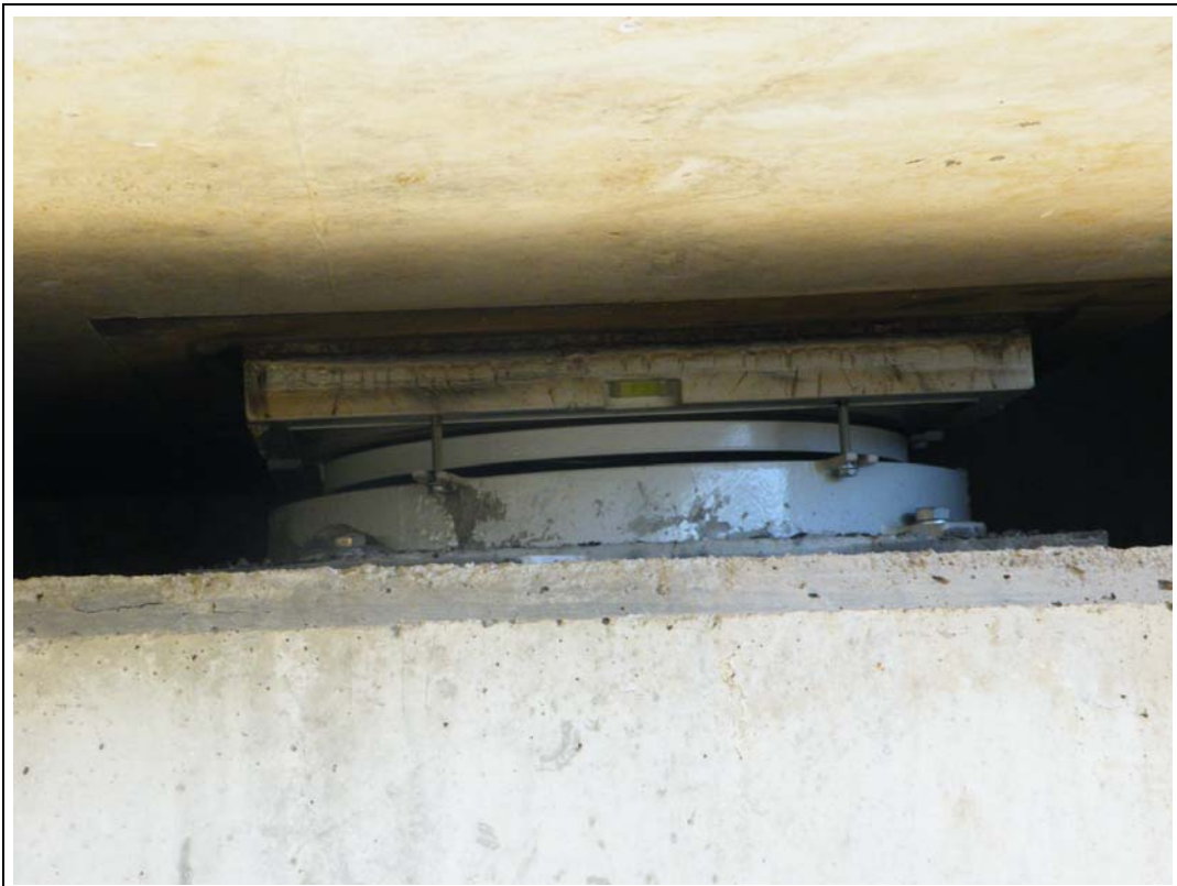
FOTOGRAFÍA N° 41: Apoyo en el estribo de entrada visto desde el lado izquierdo.
