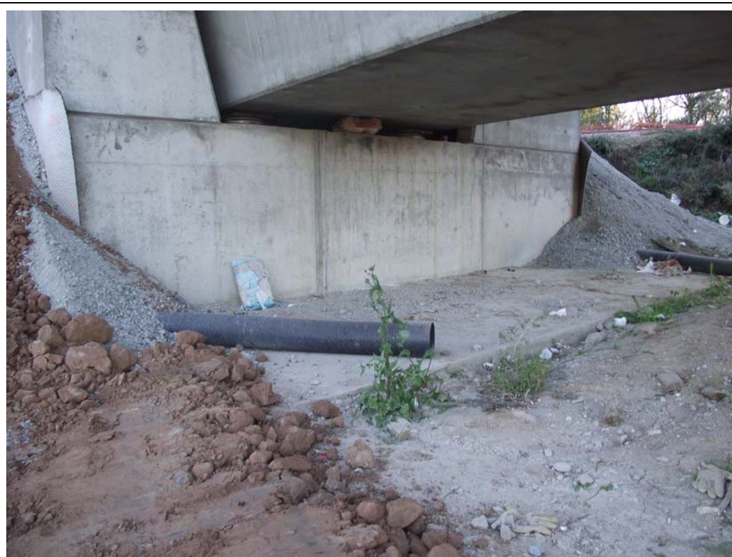
FOTOGRAFÍA N° 57: Cimentación vista en estribo de salida.
