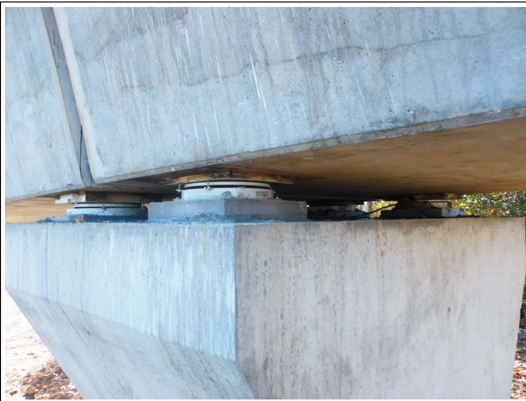
FOTOGRAFÍA N° 46: Apoyo en pila 3 visto desde tramo III.
