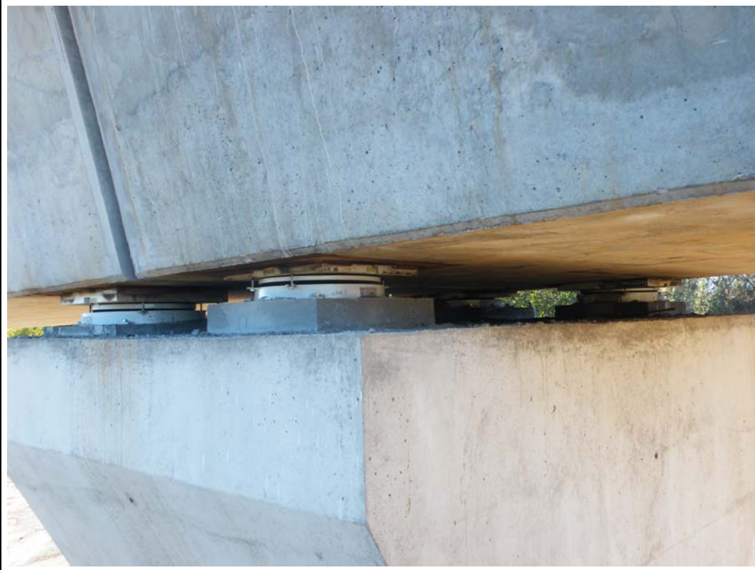
FOTOGRAFÍA N° 48: Apoyo en pila 5 visto desde tramo V.
