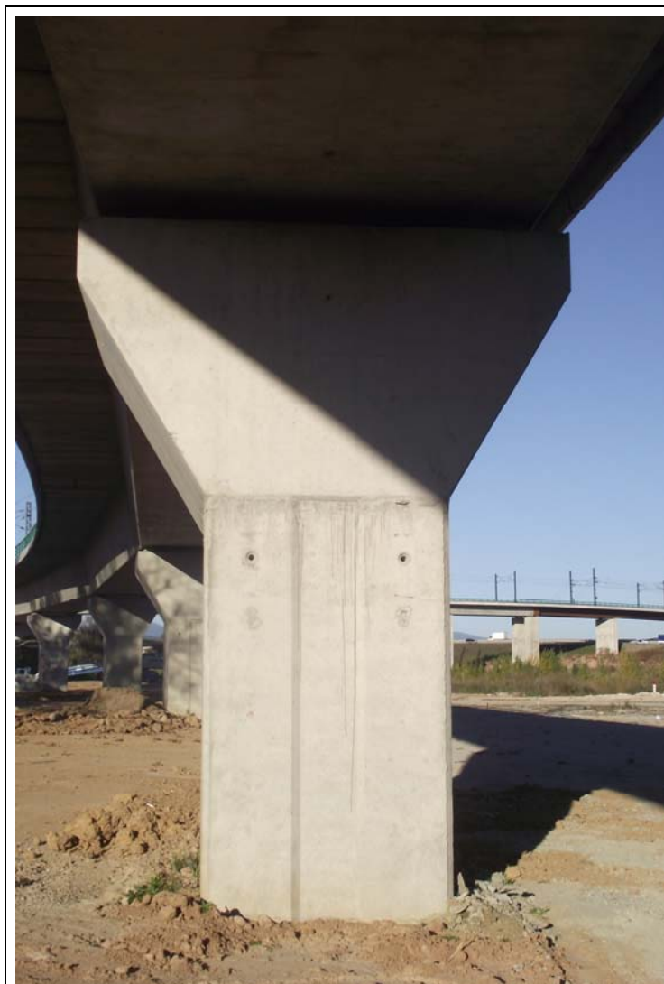
FOTOGRAFÍA Nº 20: Pila 4 vista desde el tramo V.
