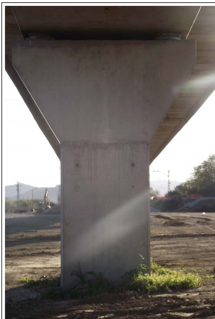
FOTOGRAFÍA Nº 25: Pila 6 vista desde el tramo VI.
