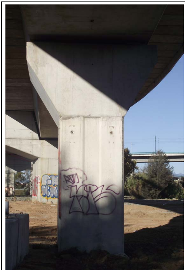
FOTOGRAFÍA Nº 11: Pila 1 vista desde el tramo II.
