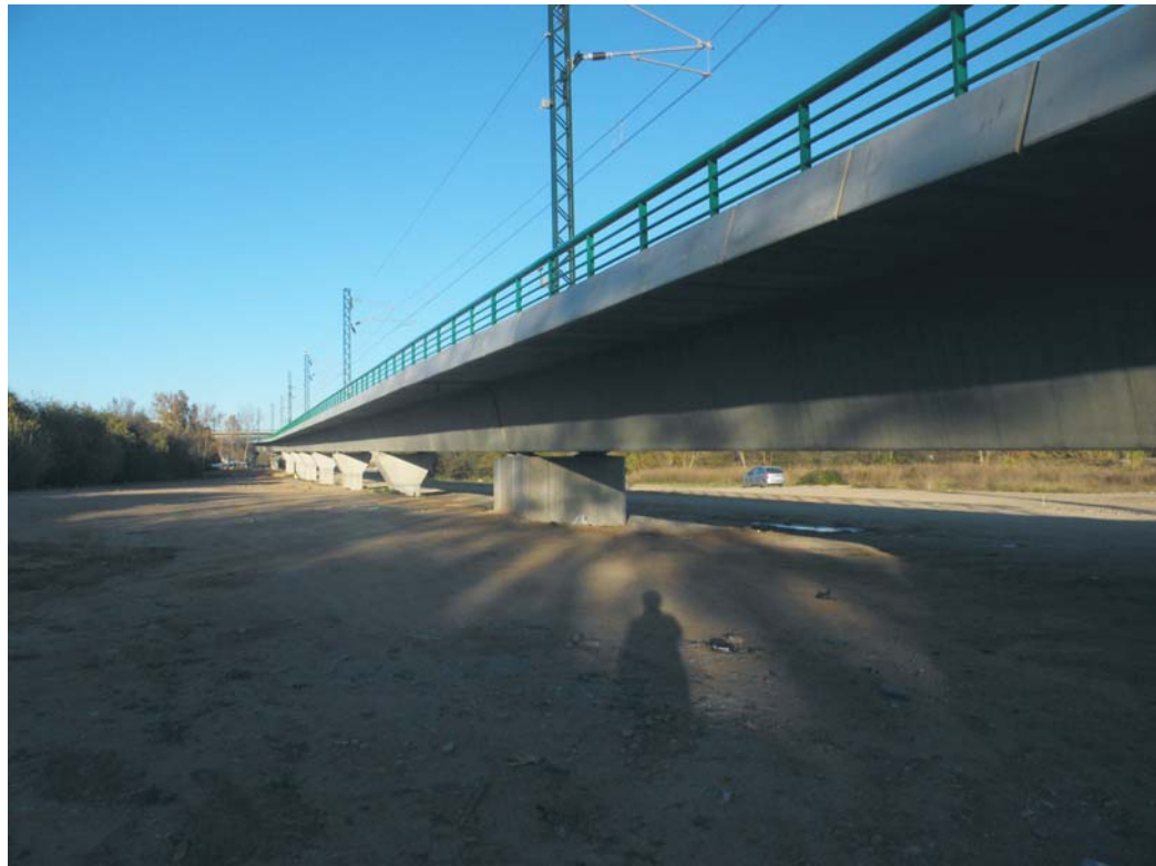
FOTOGRAFÍA Nº 1: Alzado derecho visto desde estribo de salida.
