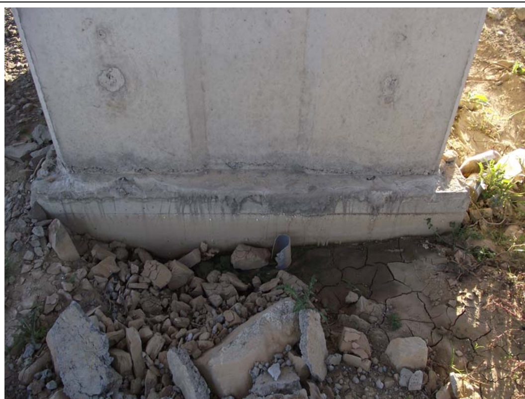
FOTOGRAFÍA N° 67: Cimentación vista en frente de pila 7 en tramo VII.
