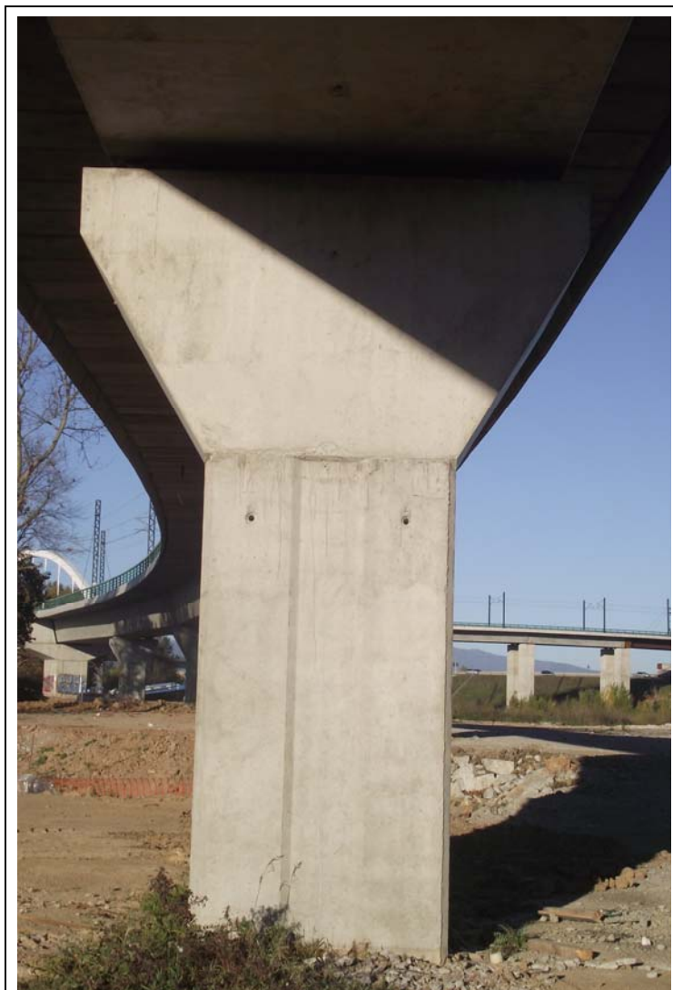
FOTOGRAFÍA Nº 23: Pila 5 vista desde el tramo VI.
