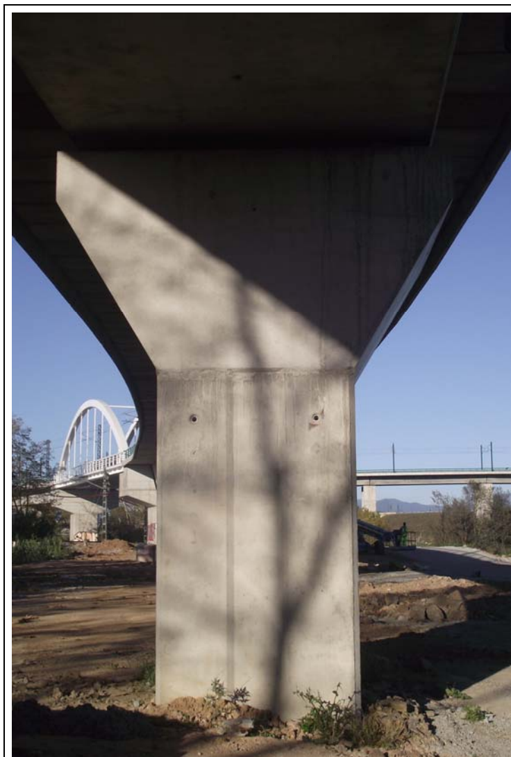
FOTOGRAFÍA Nº 17: Pila 3 vista desde el tramo IV.
