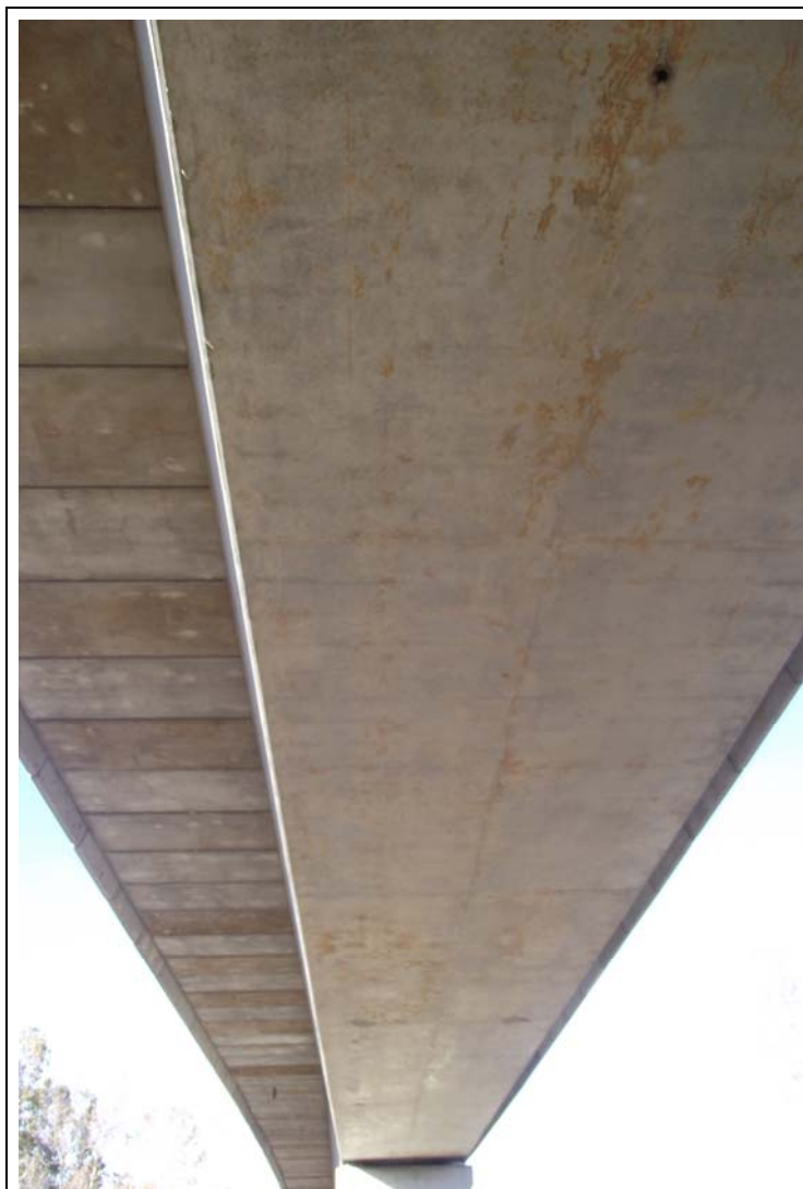
FOTOGRAFÍA Nº 24: Fibra inferior del tramo VI vista desde el lado derecho.
