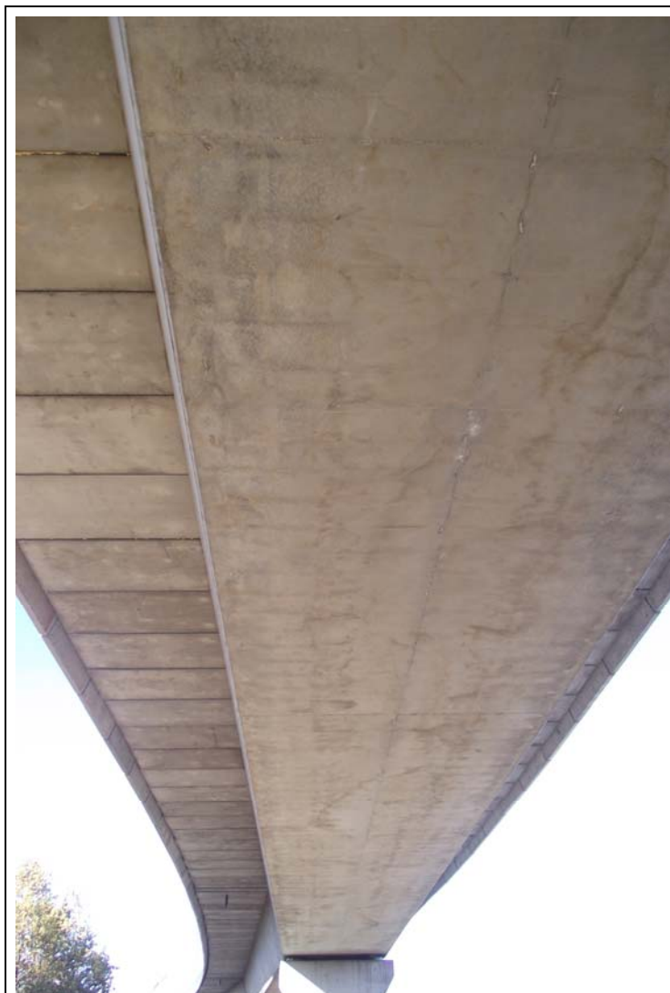
FOTOGRAFÍA Nº 18: Fibra inferior del tramo IV vista desde el lado derecho.
