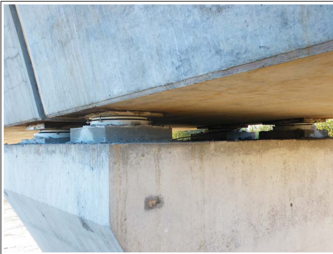
FOTOGRAFÍA N° 50: Apoyo en pila 7 visto desde tramo VII.
