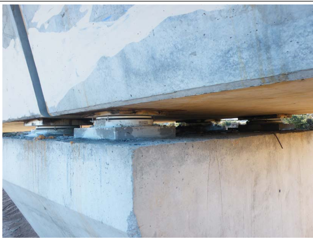
FOTOGRAFÍA N° 52: Apoyo en pila 9 visto desde tramo XI.
