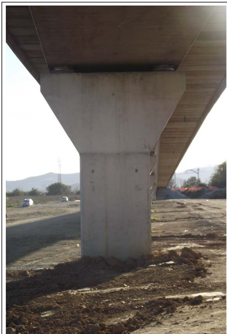
FOTOGRAFÍA Nº 19: Pila 4 vista desde el tramo IV.
