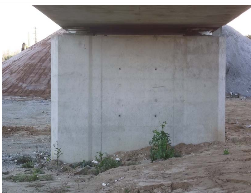
FOTOGRAFÍA N° 37: Pila 10 vista desde el tramo X.
