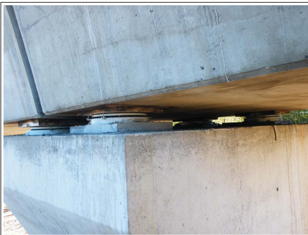
FOTOGRAFÍA N° 51: Apoyo en pila 8 visto desde tramo VIII.
