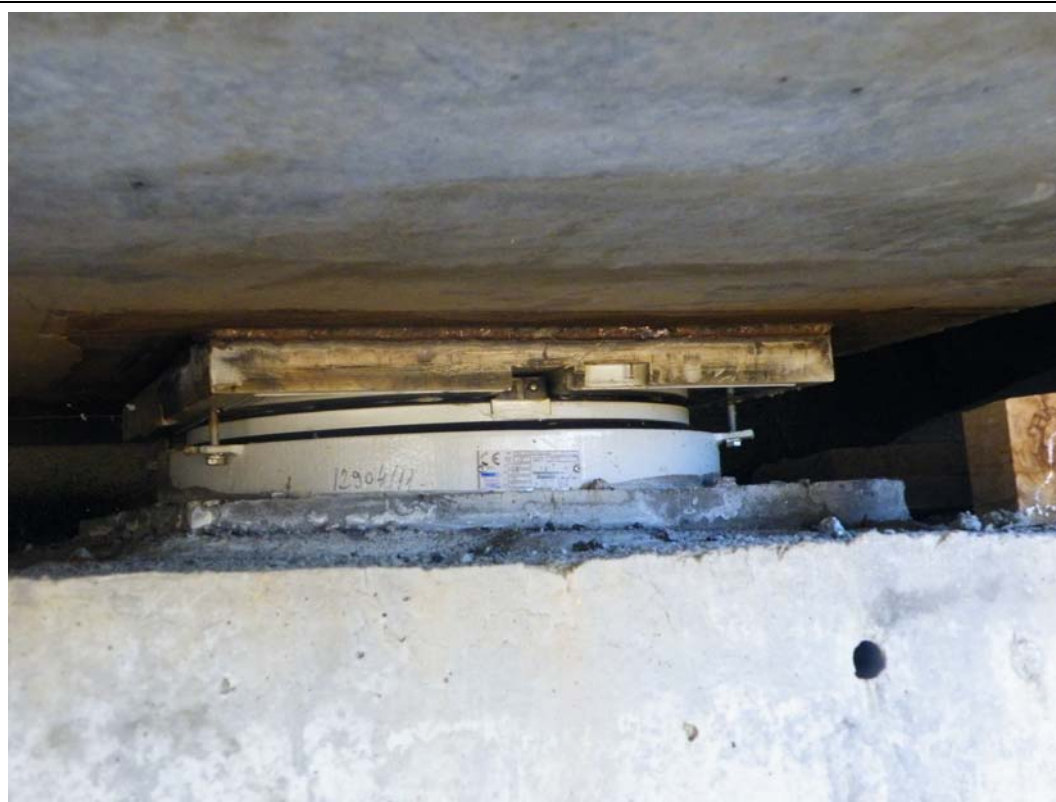
FOTOGRAFÍA N° 42: Apoyo en el estribo de salida visto desde el lado derecho.
