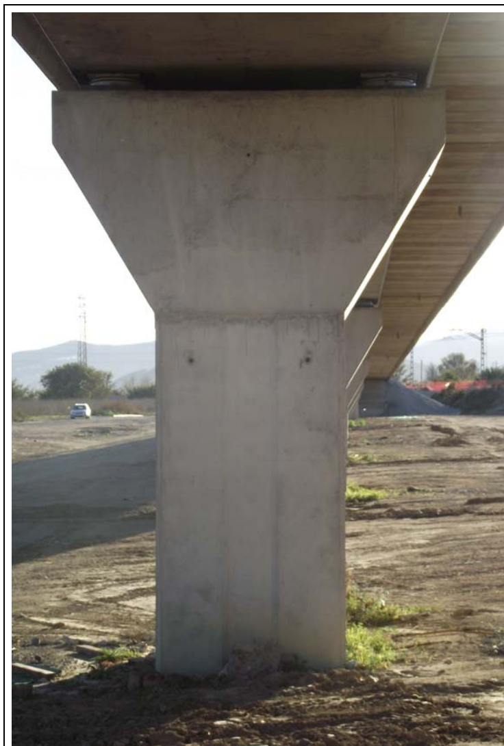
FOTOGRAFÍA Nº 22: Pila 5 vista desde el tramo V.
