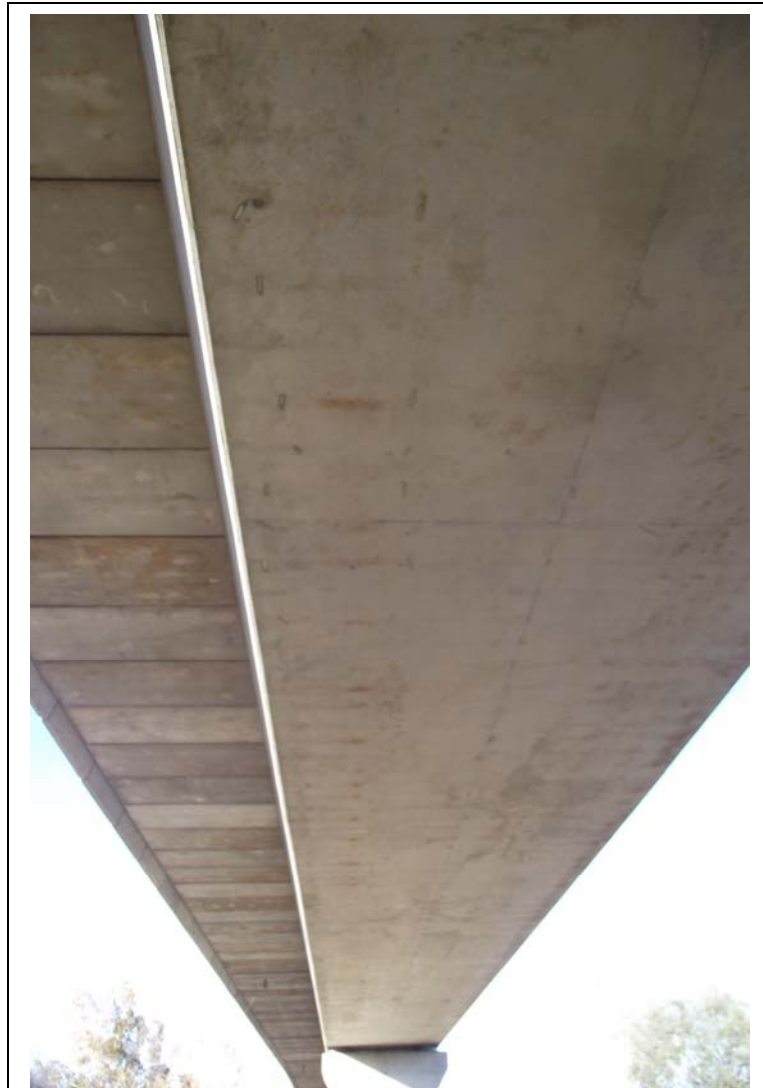
FOTOGRAFÍA Nº 27: Fibra inferior de tramo VII vista desde lado derecho.
