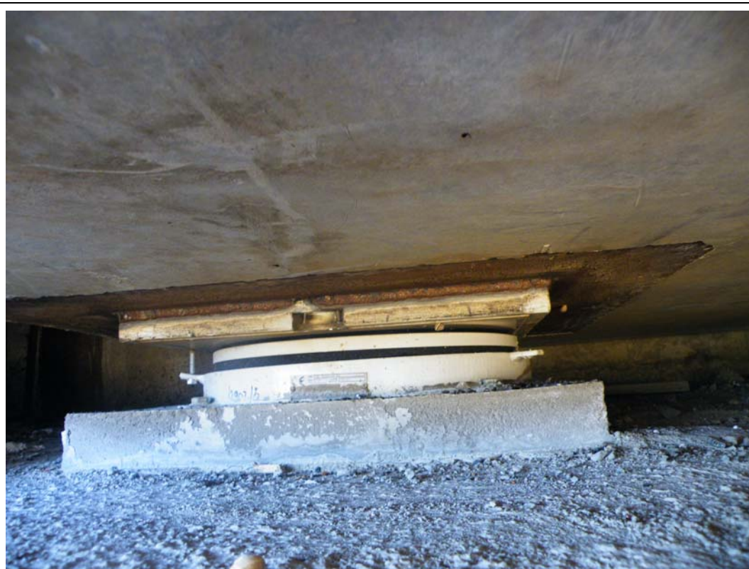
FOTOGRAFÍA N° 43: Apoyo en el estribo de salida visto desde el lado izquierdo.
