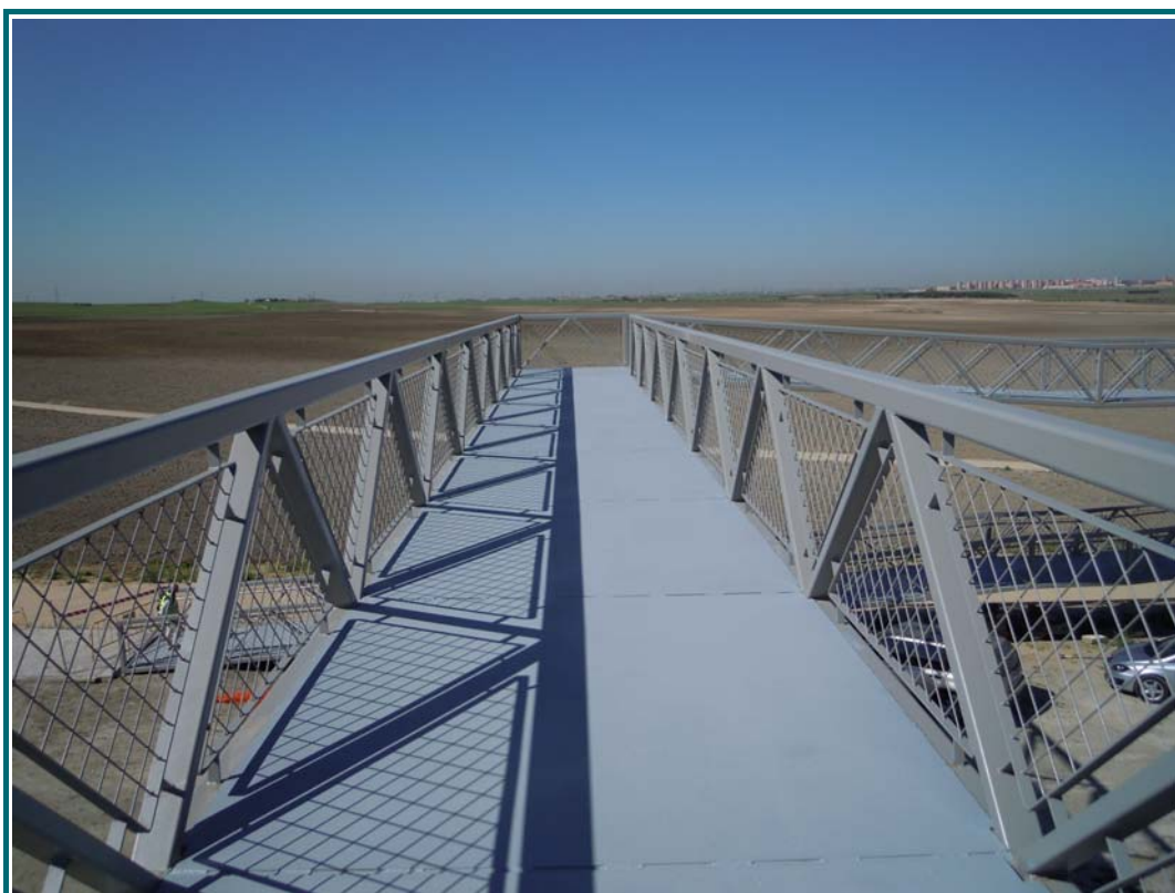
FOTOGRAFÍA N° 10: Vista superior de la pasarela, tramo de cruce.
