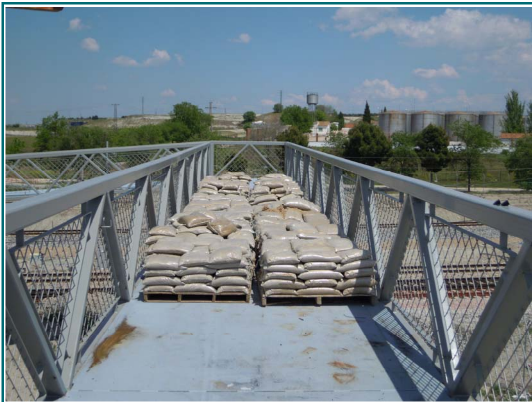
FOTOGRAFÍA N° 10: Carga del vano central
