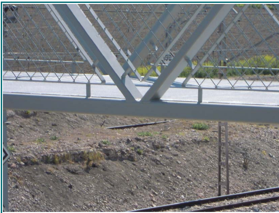
FOTOGRAFÍA N° 13: Detalle de nudos.
