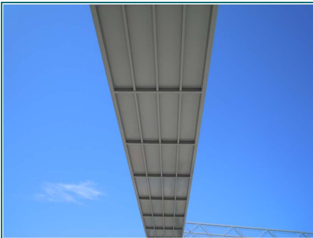
FOTOGRAFÍA N° 12: Vista inferior del tablero.
