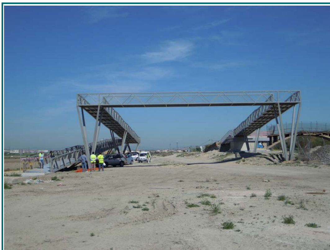
FOTOGRAFÍA N° 2: Vista general de la estructura desde lado izquierdo.
