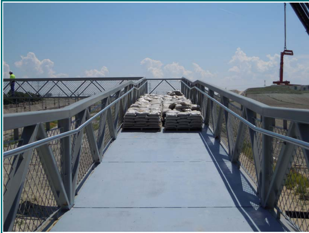
FOTOGRAFÍA N° 09: Carga de rampa de acceso.
