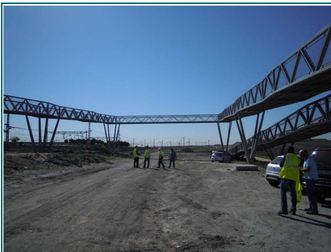
FOTOGRAFÍA N° 6: Alzado tramo cruce vías.
