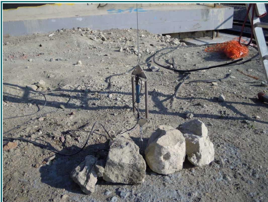
FOTOGRAFÍA N° 6: Detalle transductor desplazamiento en centro vano.
