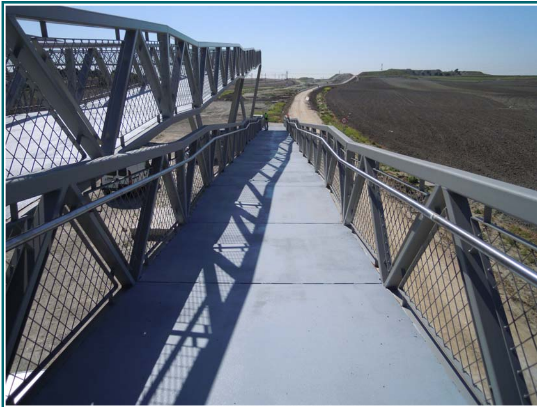
FOTOGRAFÍA N° 7: Vista superior de la pasarela, rampa 01.
