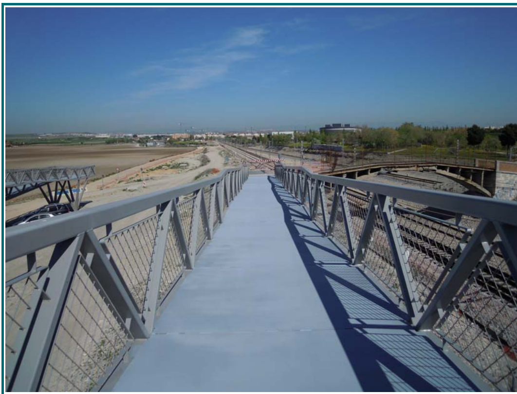
FOTOGRAFÍA N° 9: Vista superior de la pasarela, rampa 03.
