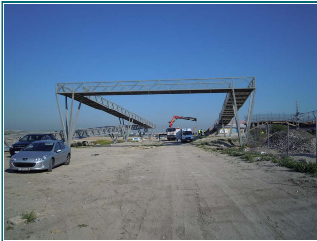
FOTOGRAFÍA N° 1: Vista general de la estructura.
