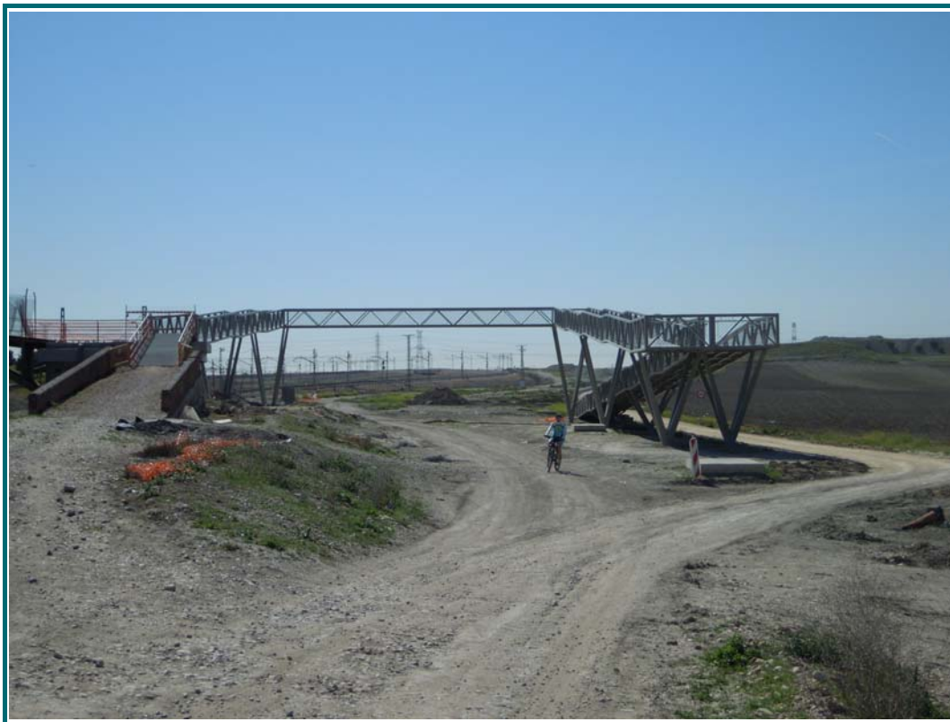
FOTOGRAFÍA N° 1: Vista general de la estructura desde lado derecho.
