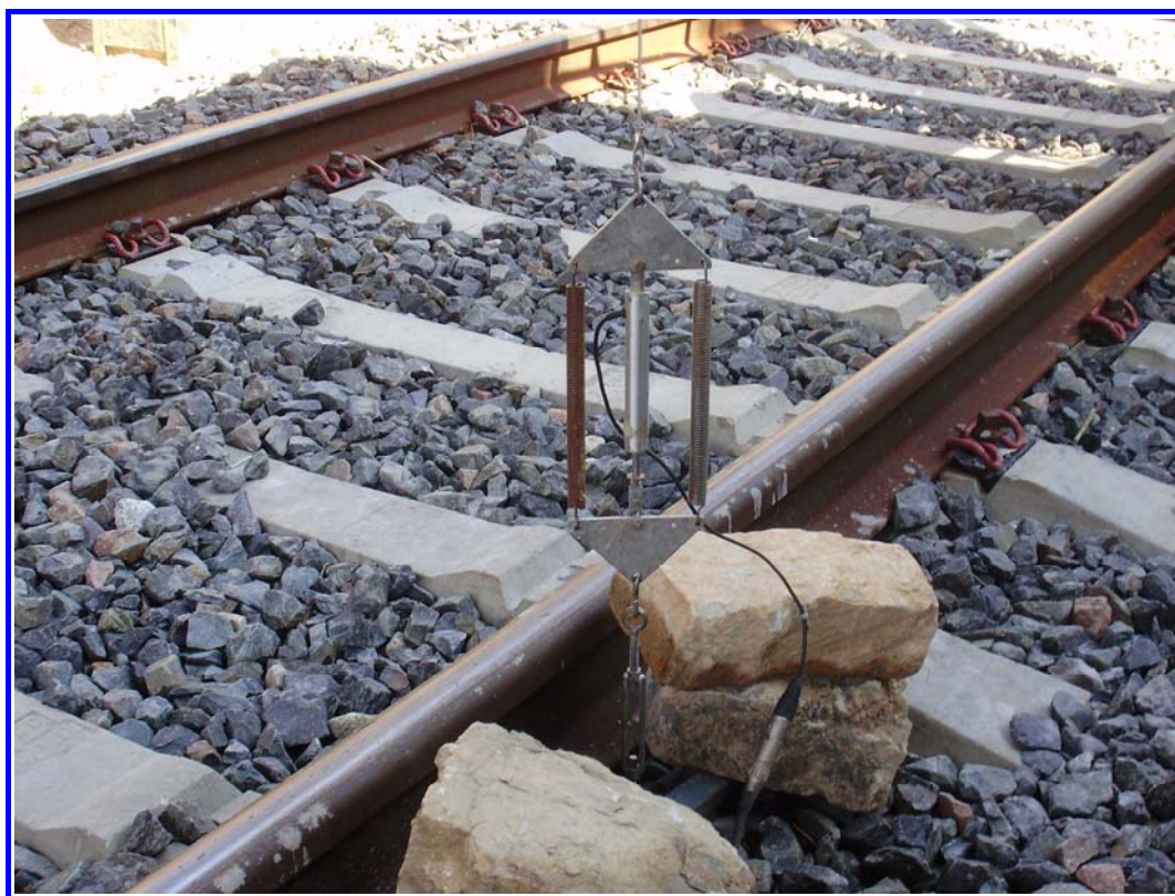
FOTOGRAFÍA N° 5: Detalle transductor desplazamiento en centro de vano.
