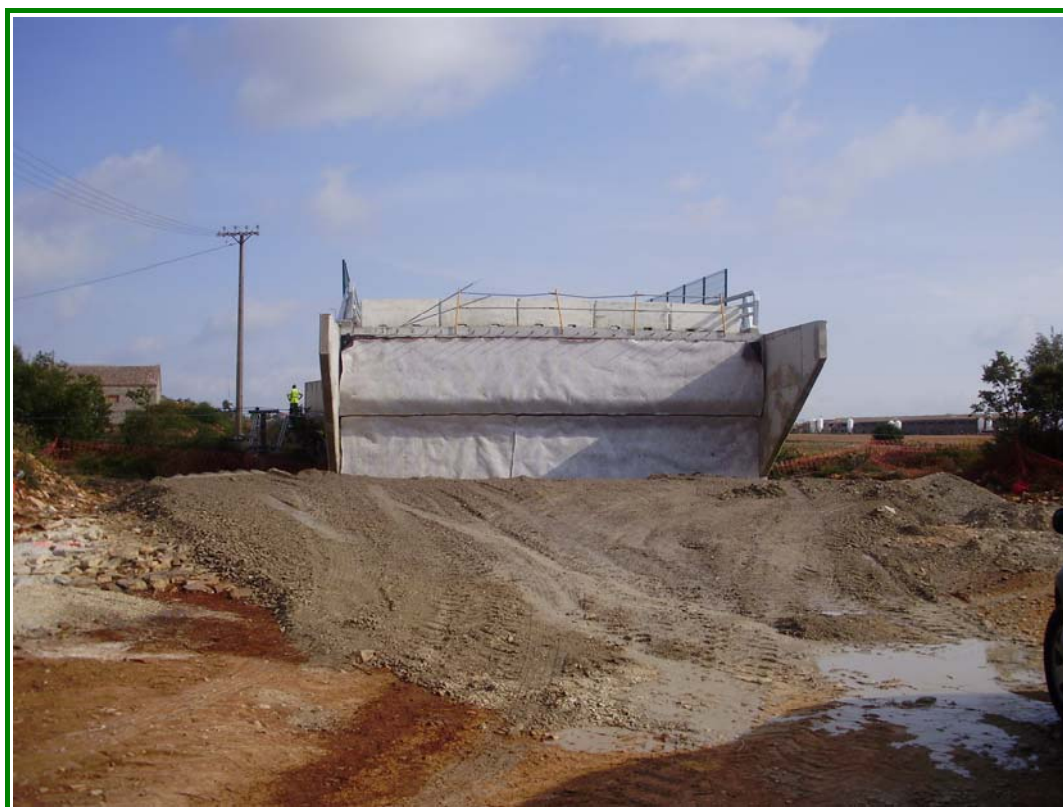
FOTOGRAFÍA N° 8: Vista superior desde estribo 01.
