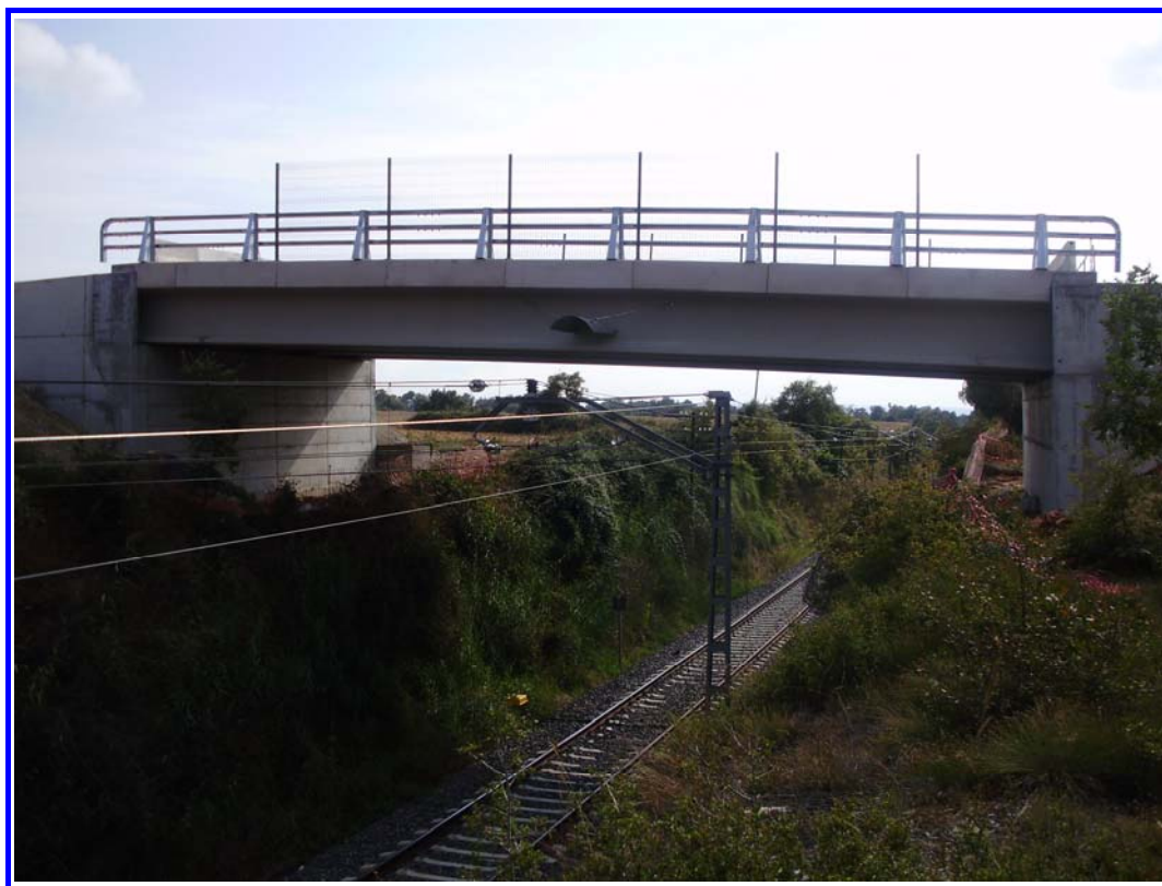
FOTOGRAFÍA Nº 1: Vista general de la estructura.
