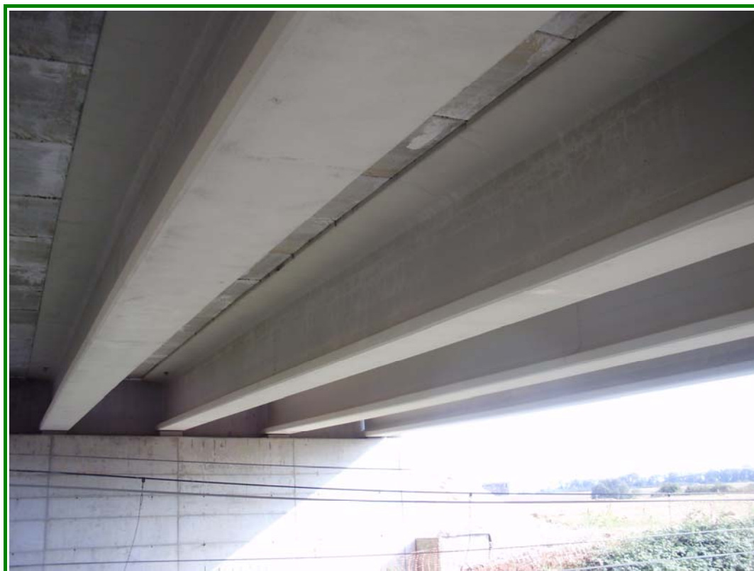
FOTOGRAFÍA N° 6: Vista inferior del tablero (Detalle).
