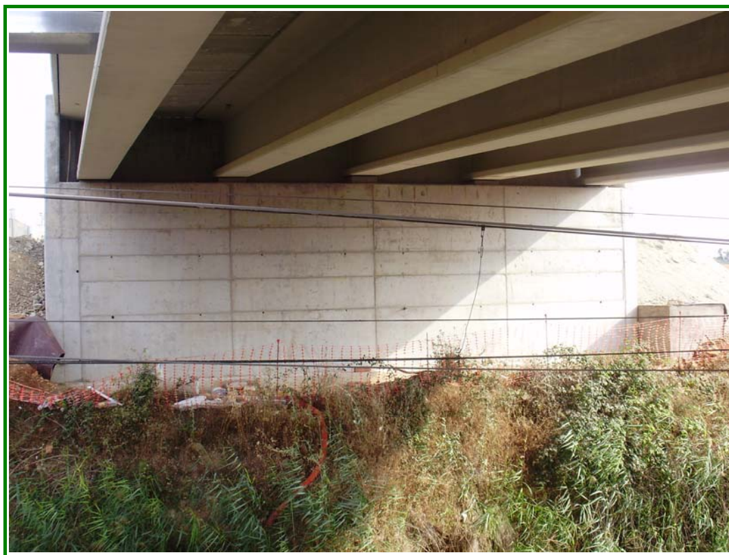
FOTOGRAFÍA N° 5: Vista inferior del tablero.
