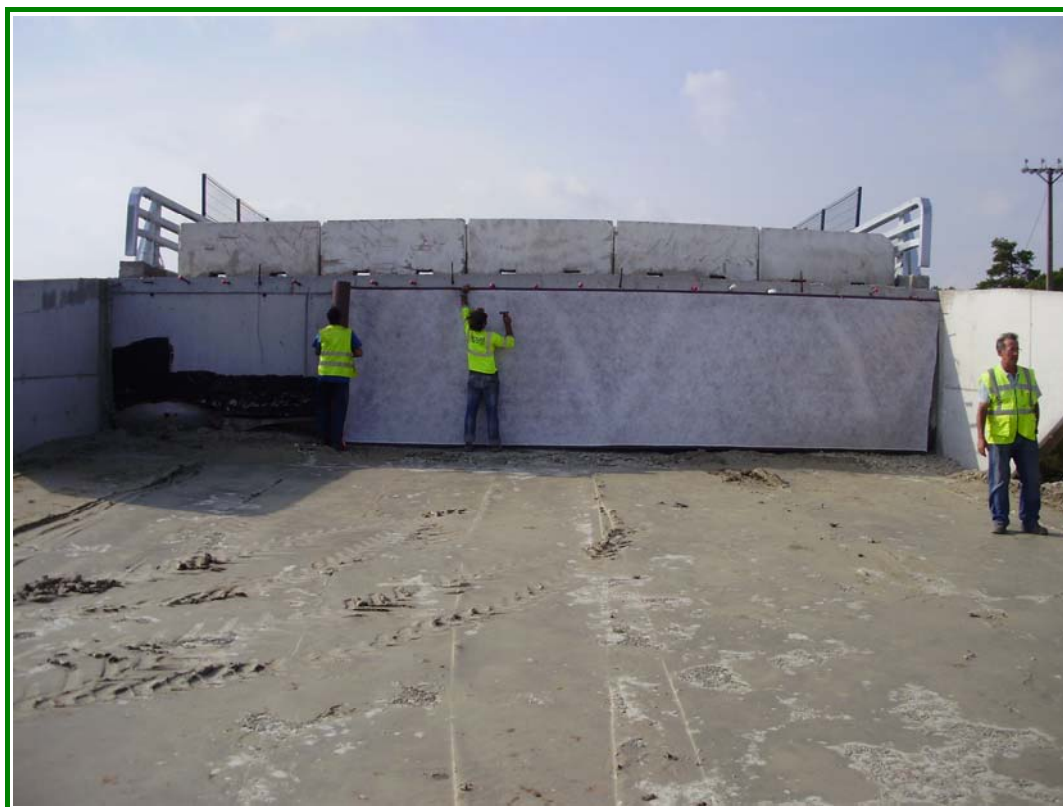
FOTOGRAFÍA N° 9: Vista superior desde estribo 02.
