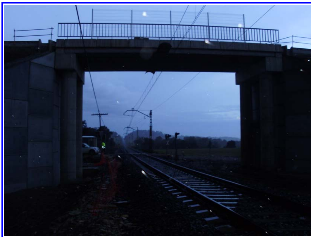
FOTOGRAFÍA Nº 1: Vista general de la estructura.
