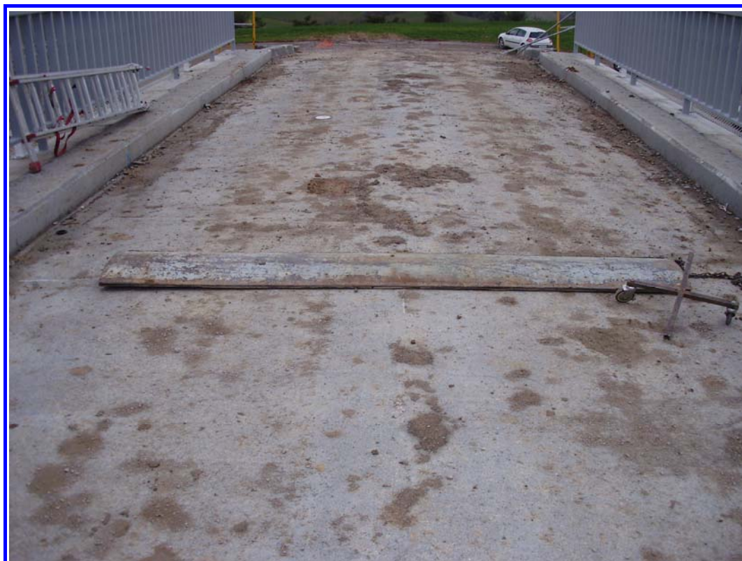
FOTOGRAFÍA Nº 12: Detalle tablón normalizado RILEM.
