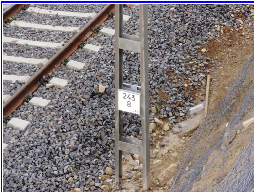
FOTOGRAFÍA N° 14: Punto kilométrico de la Estructura.
