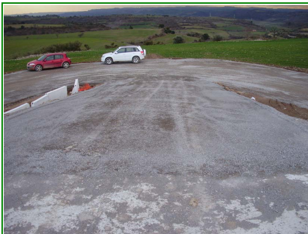
FOTOGRAFÍA N° 10: Rampa de acceso desde estribo 01.
