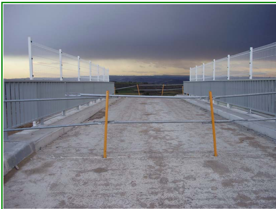
FOTOGRAFÍA N° 9: Vista superior desde estribo 02.
