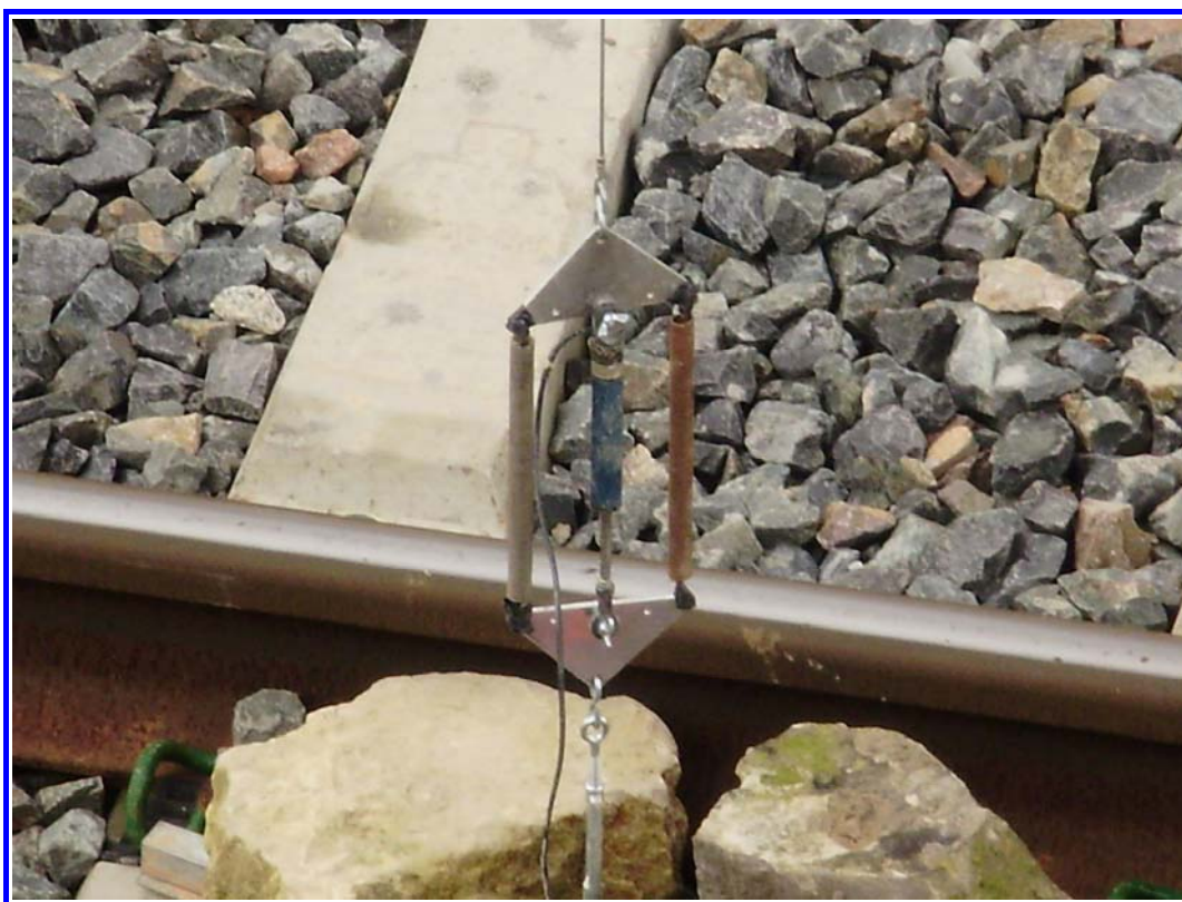
FOTOGRAFÍA N° 5: Detalle transductor desplazamiento en centro de vano.
