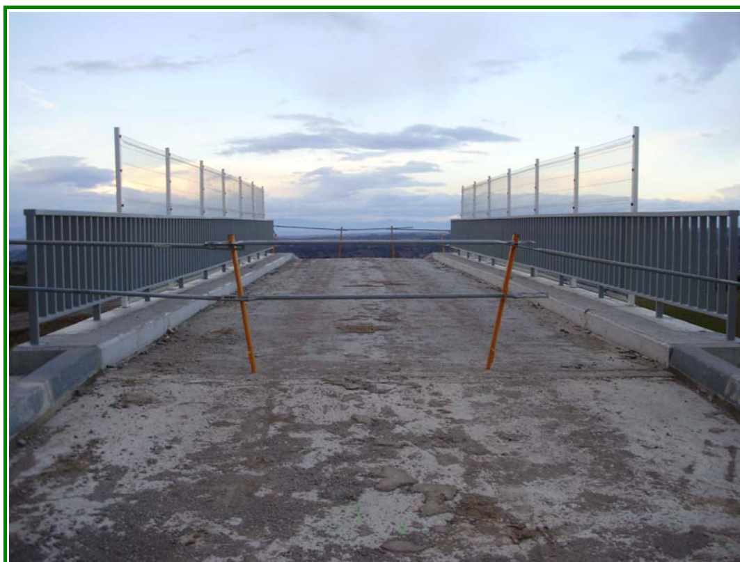
FOTOGRAFÍA N° 8: Vista superior desde estribo 01.
