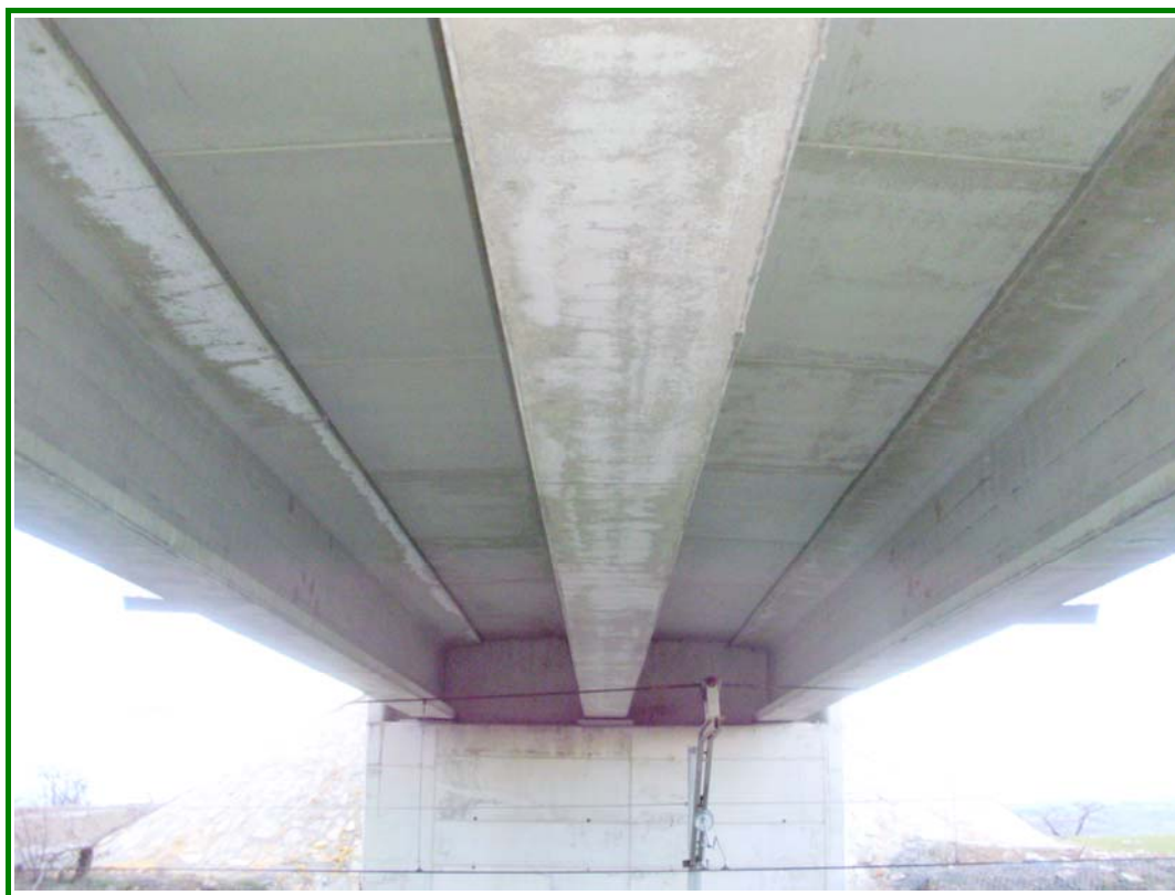
FOTOGRAFÍA N° 5: Vista inferior del tablero.
