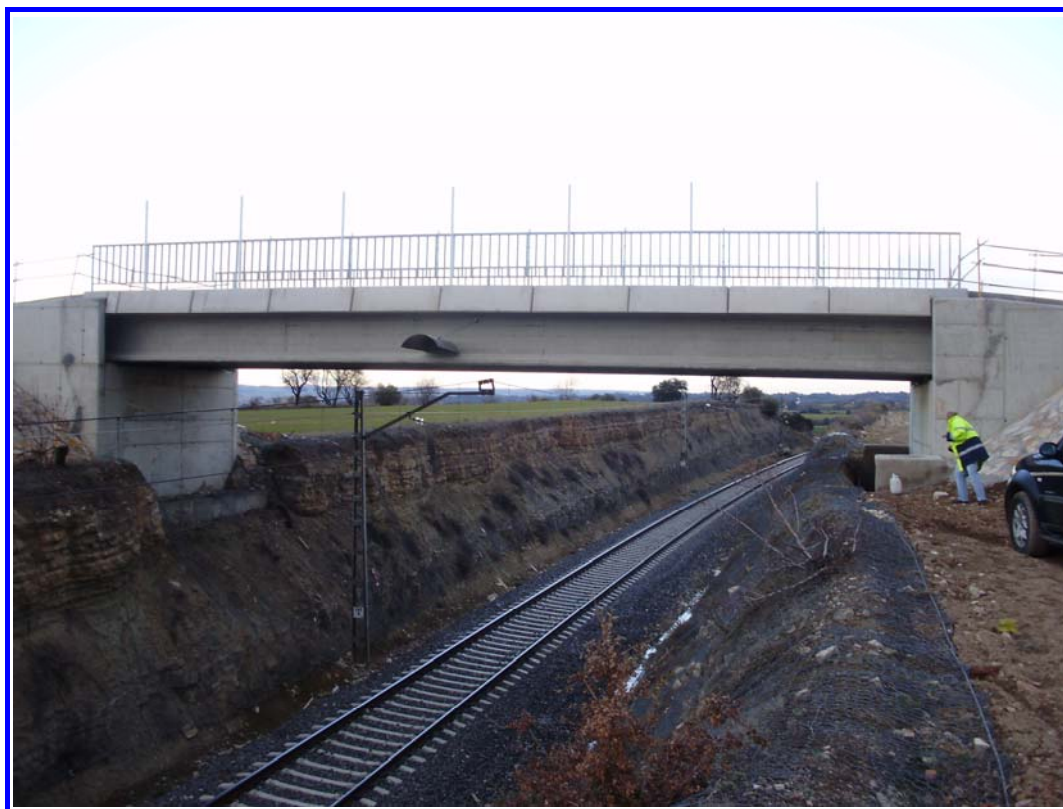
FOTOGRAFÍA Nº 1: Vista general de la estructura.
