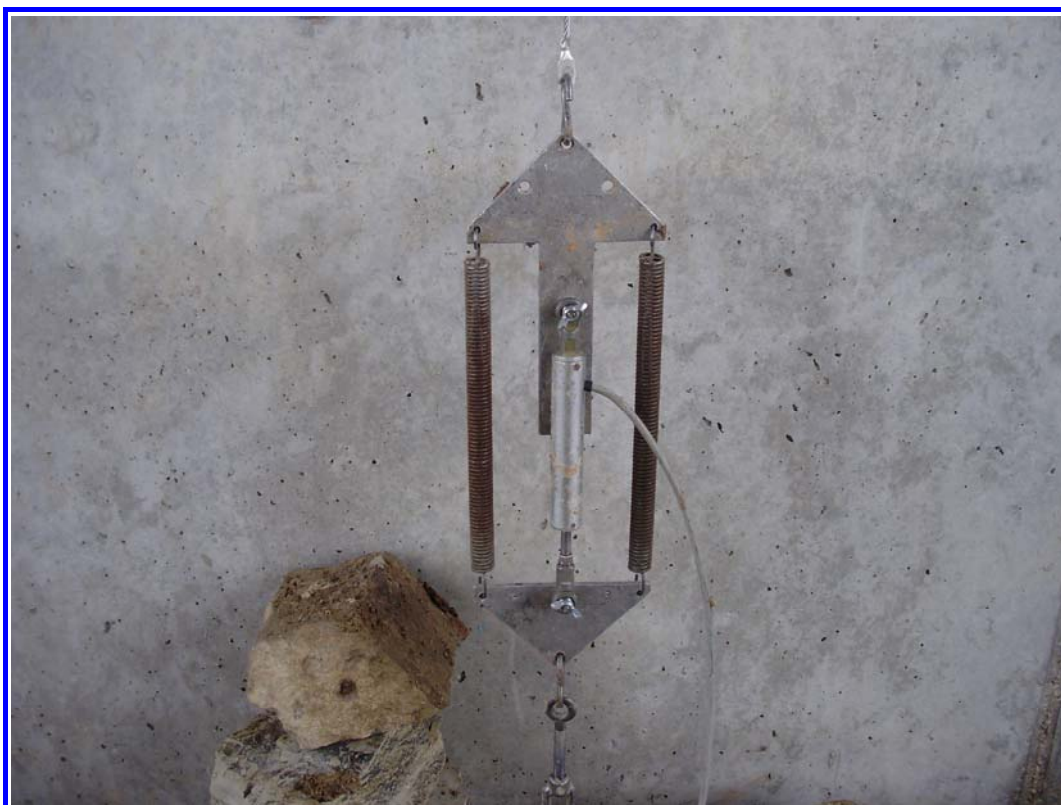
FOTOGRAFÍA N° 6: Detalle transductor desplazamiento en pila o estribo.
