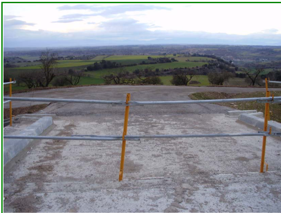
FOTOGRAFÍA N° 11: Rampa de acceso desde estribo 02.
