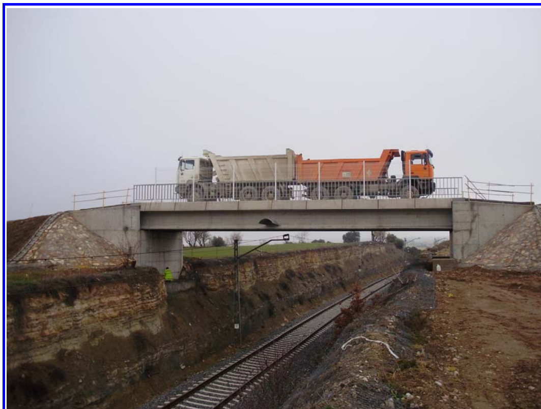
FOTOGRAFÍA N° 10: Prueba estática.
