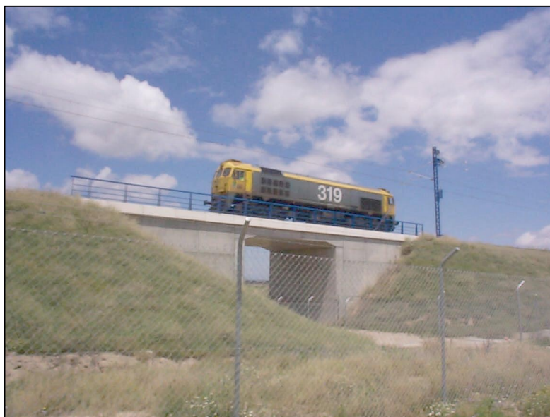
Nº 3.- Prueba de carga estática, con una locomotora, visto desde alzado derecho.
