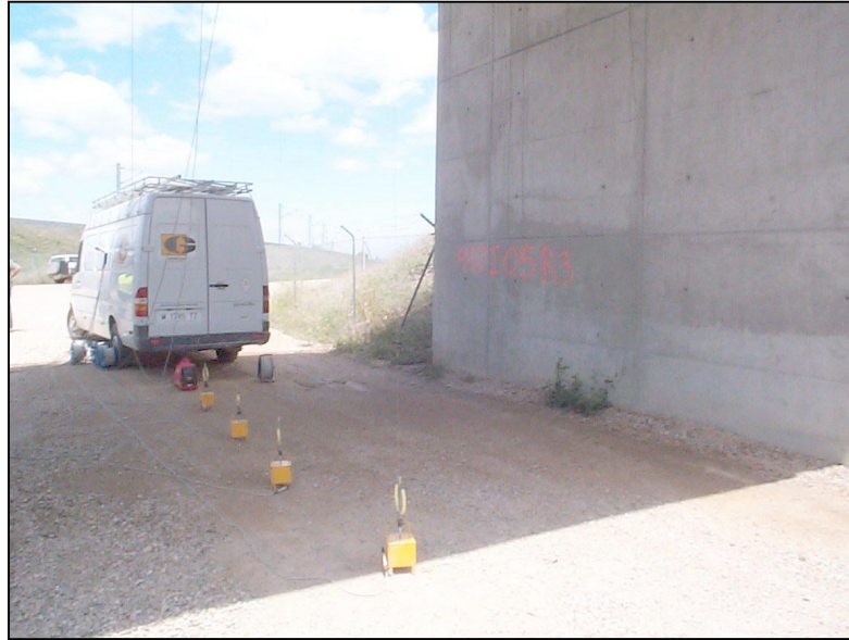
Nº 1.- Instrumentación mediante aros extensométricos de los puntos de flecha en el centro de luz.
