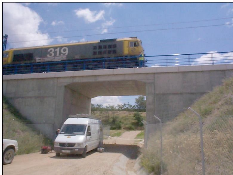
Nº 2.- Prueba de carga estática, con una locomotora, visto desde alzado izquierdo.
