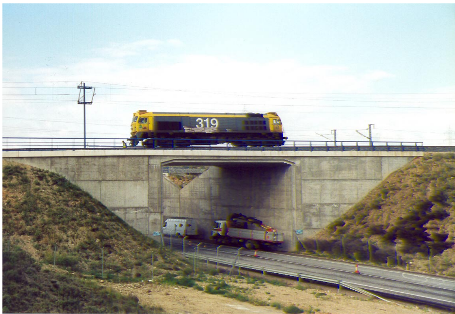
Nº 3.- Prueba de carga estática con una locomotora, visto desde alzado izquierdo.
