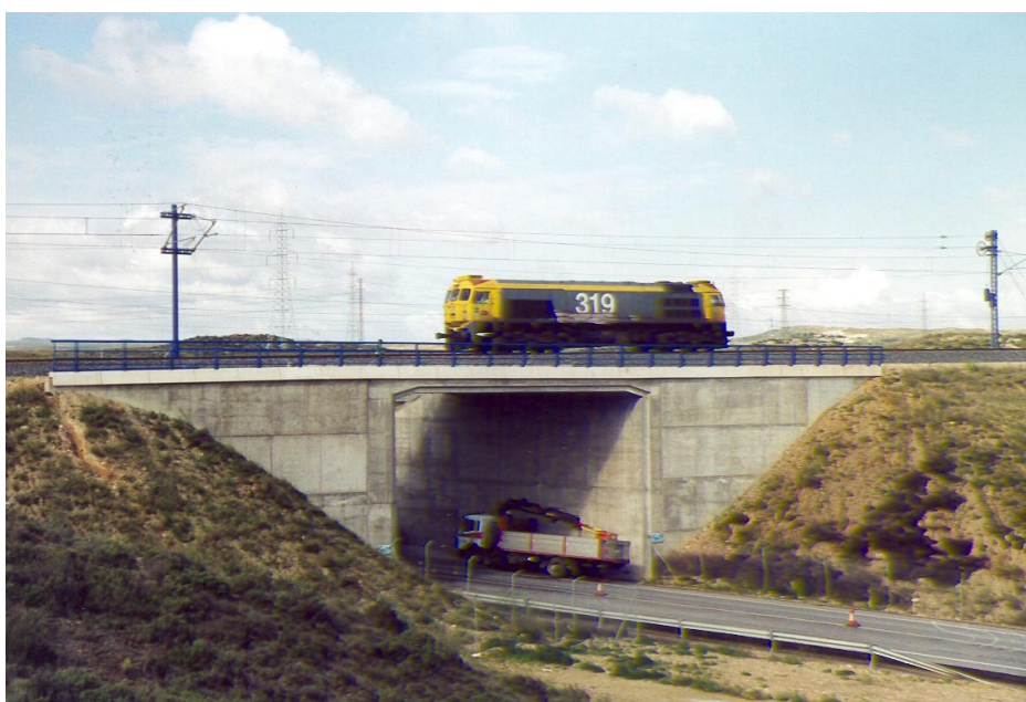
Nº 6.- Prueba de carga dinámica a 30 km/h con locomotora visto desde alzado izquierdo.
