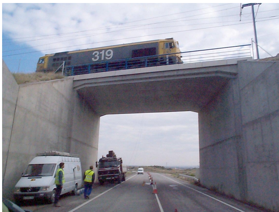
Nº 4.- Prueba de carga dinámica a 30 km/h con locomotora visto desde alzado derecho.
