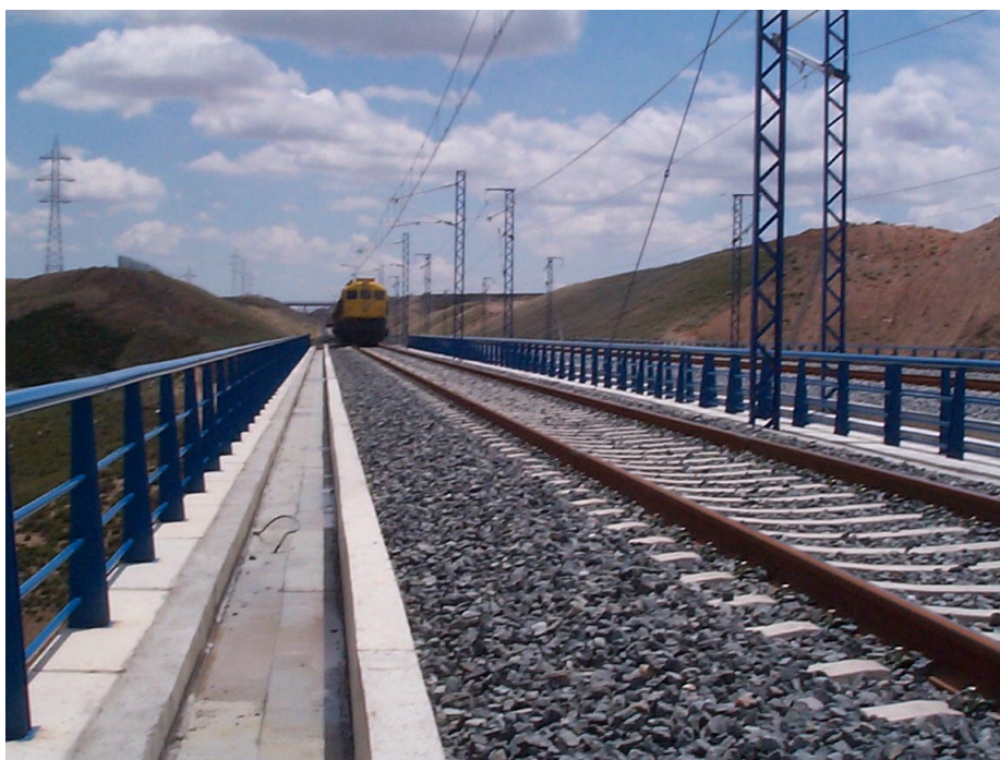
Nº 5.- Prueba de carga dinámica a 30 km/h con locomotora visto desde lado Lérida.
