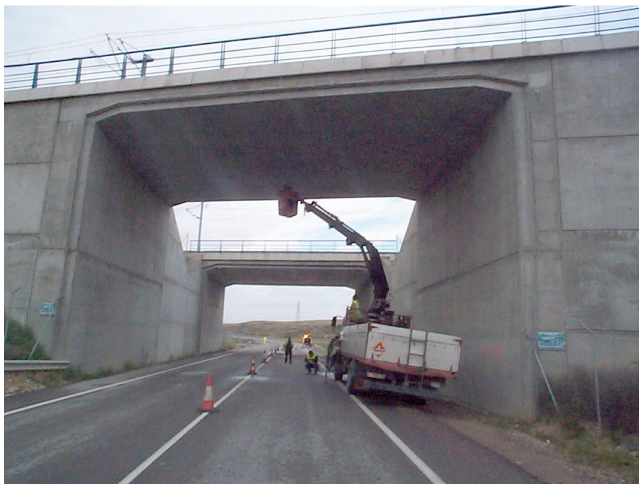
1.- Colocación de puntos de flecha en centro de luz mediante un camión grúa con cesta.
