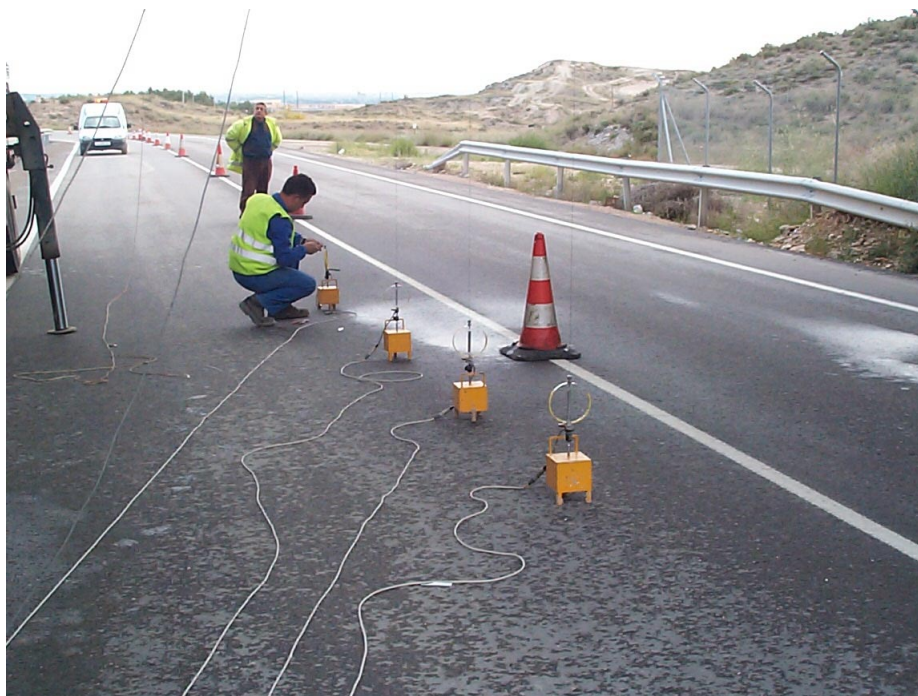
Nº 2.- Instrumentación mediante aros extensométricos de los puntos de flecha en centro de luz.
