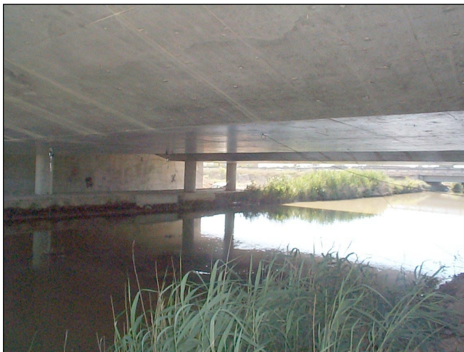
Nº 2.- Instrumentación mediante aros extensométricos de los puntos de flecha en centro de luz de vano 1.
