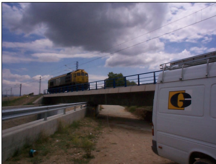
Nº 6.- Carga en vano nº 2.
