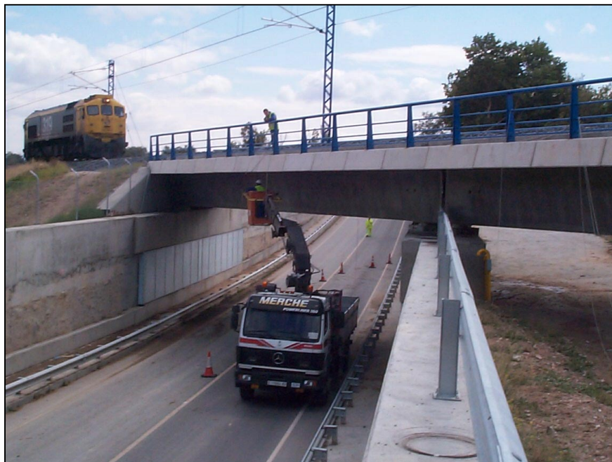
Nº 1.- Colocación de instrumentación
