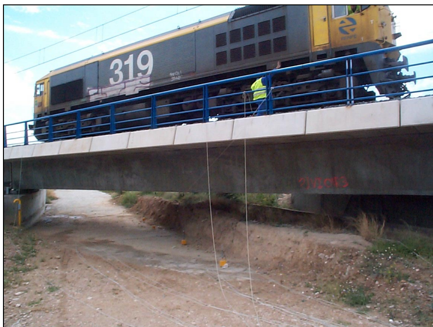
Nº 5.- Carga en vano nº 1.
