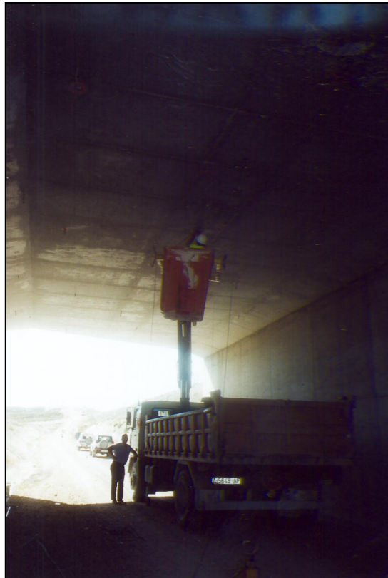
Nº 1.- Colocación de la instrumentación
