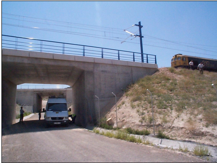
Nº 2.- Colocación de la instrumentación.
