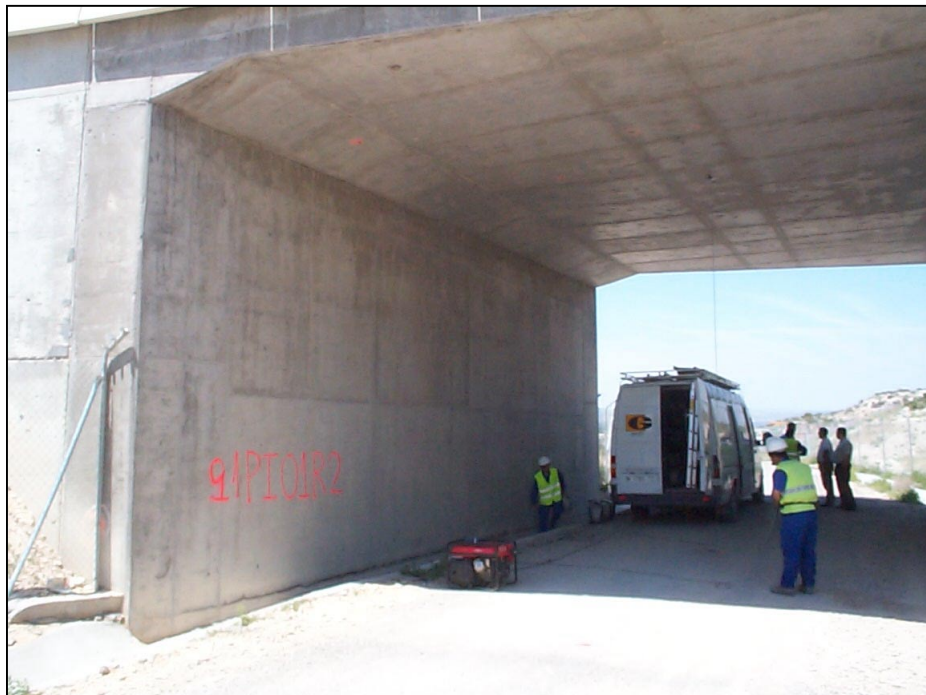
Nº 1.- Vista general de la instrumentación.
