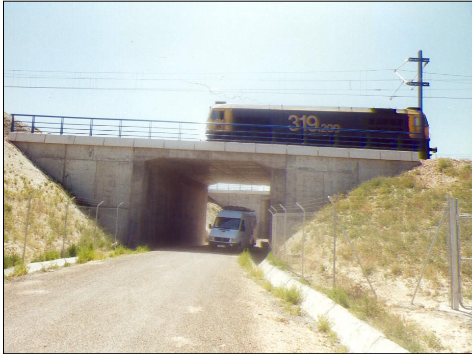
Nº 4.- Realización de las pruebas dinámicas a 5 Km/h.
