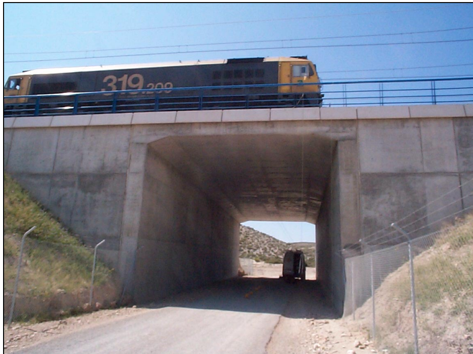
Nº 7.- Realización de las pruebas dinámicas a máxima velocidad.
