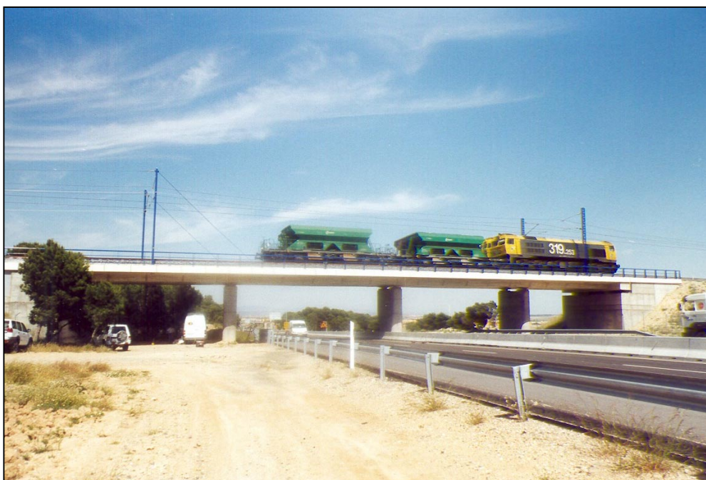
Nº 6.- Carga en vanos 2,3 y 4 (vista general)
