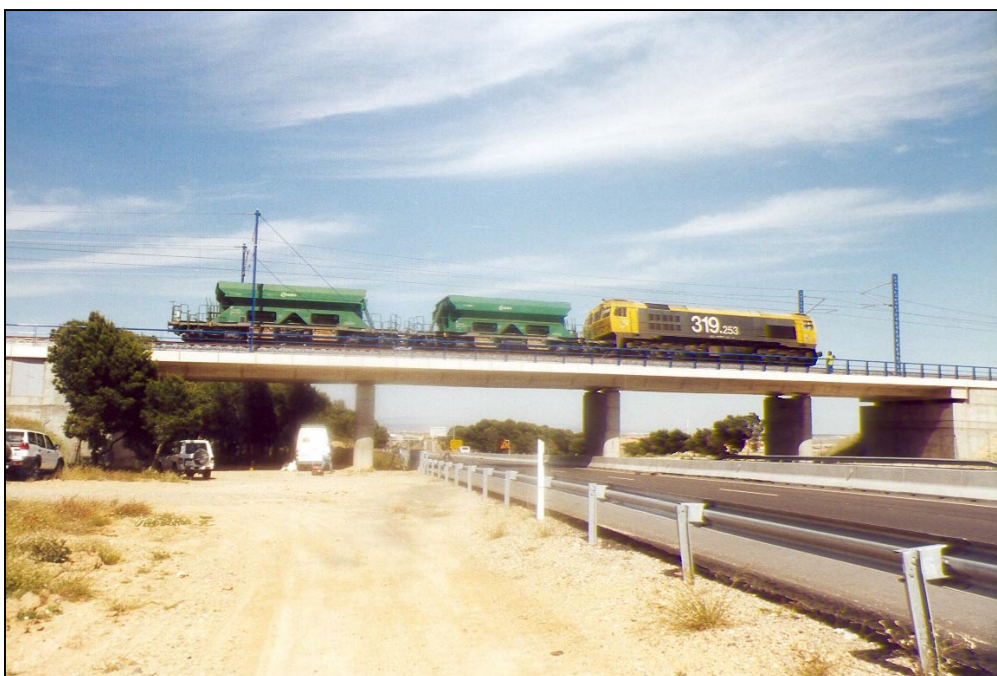
Nº 8.- Carga en vanos 2, 3 y 4 (vista general)
