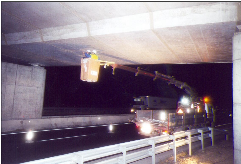
Nº 3.- Instrumentación con corte de tráfico nocturno
