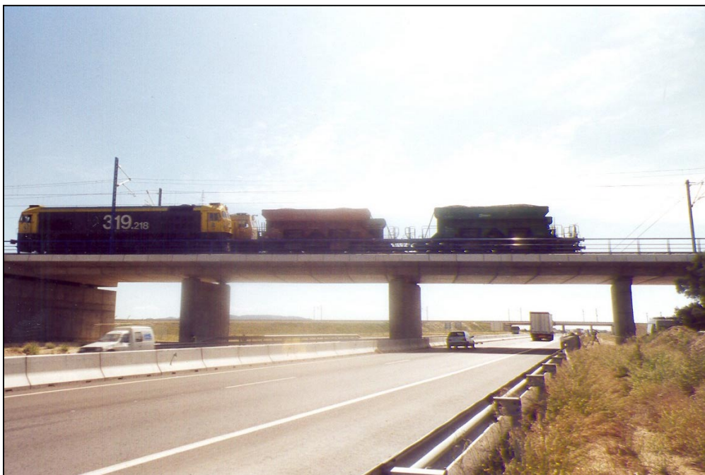
Nº 7.- Carga en vanos 2,3 y 4 (vista lateral)
