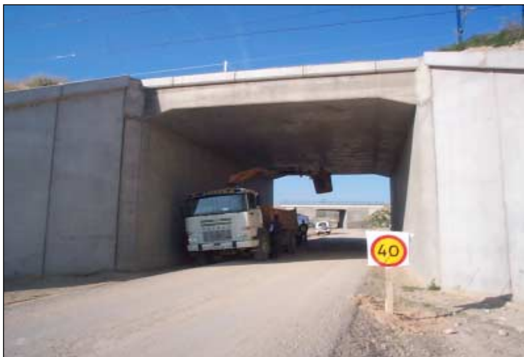
Nº 2.- Colocación de bandas en parte inferior del tablero
