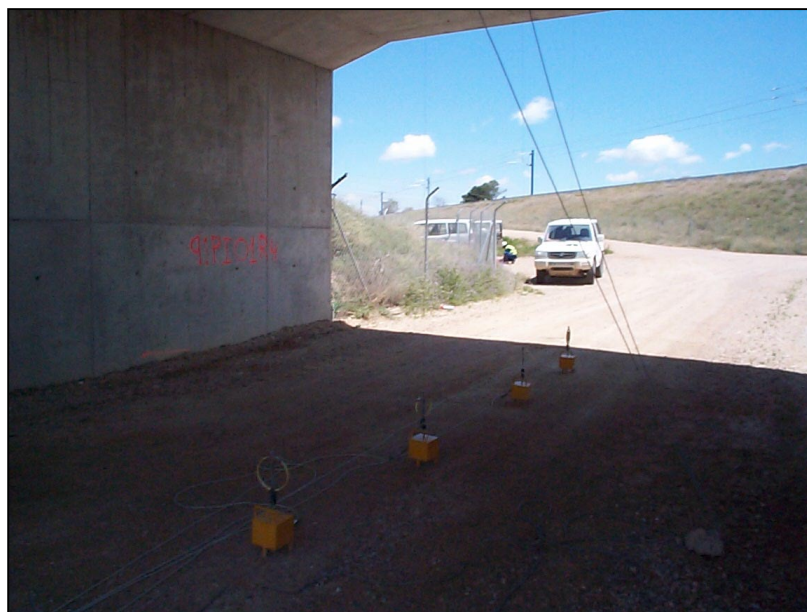
Nº 1. Colocación de la instrumentación
