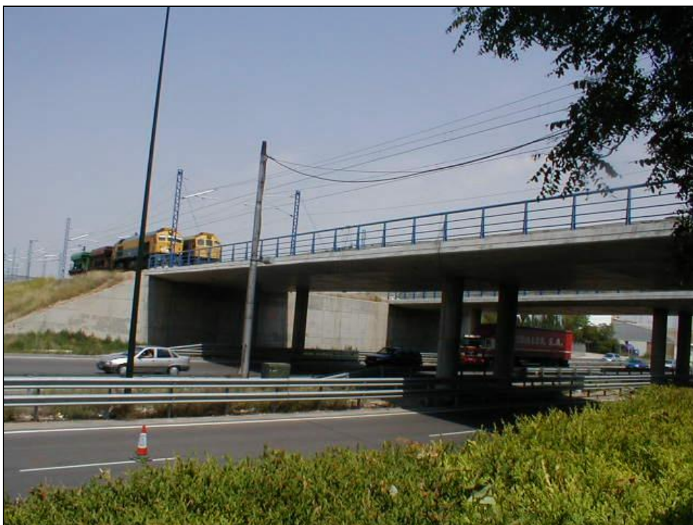
Foto 6: Estribo de salida (Zaragoza)
