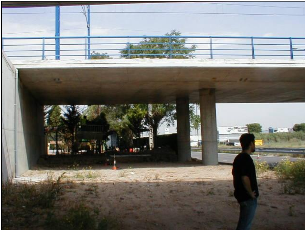
Foto 5: Estribo de entrada (Madrid)
