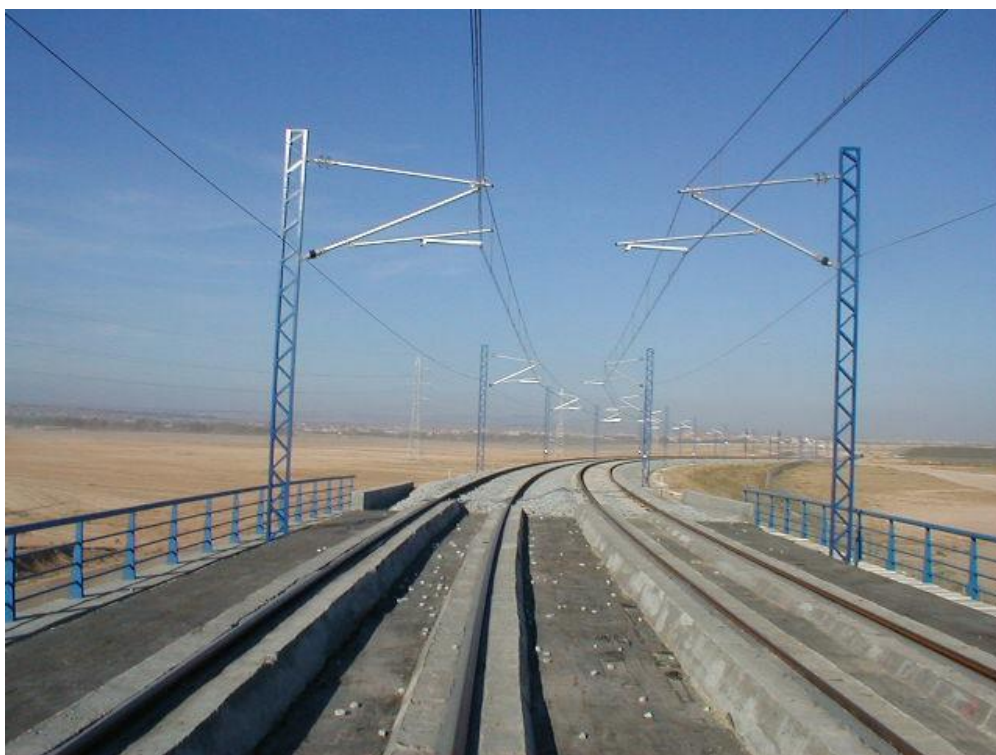
Foto 3: Vista superior desde entrada (Madrid)
