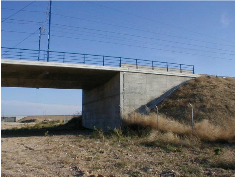
Foto 5: Estribo de entrada (Madrid)
