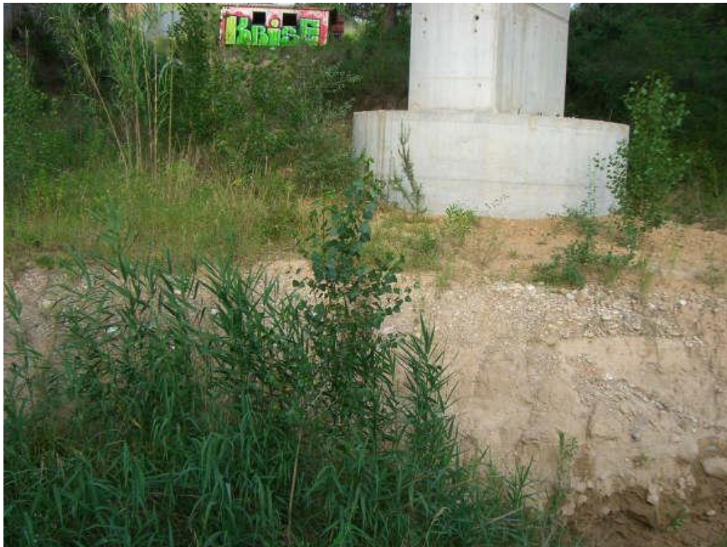
FOTOGRAFÍA Nº 8: PILA 1 DESDE EL MARGEN.
