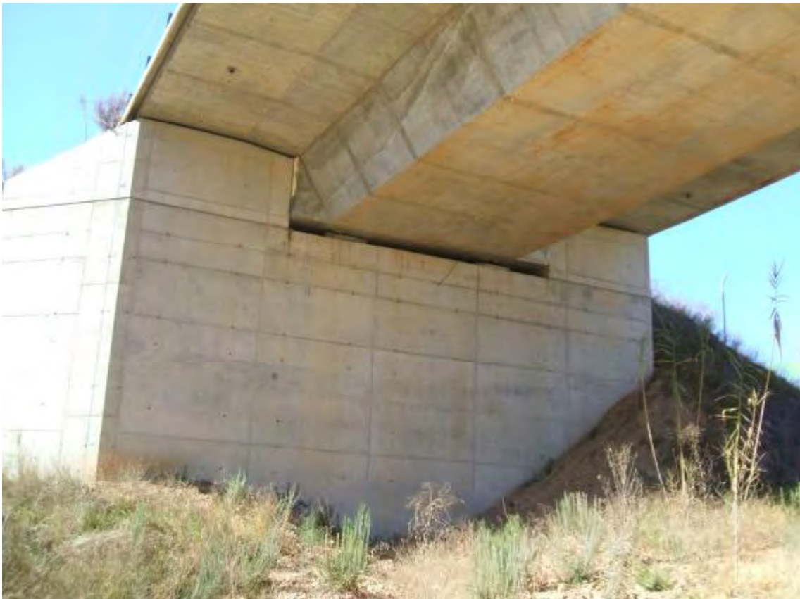
FOTOGRAFIA N°2: Estribo de entrada.
