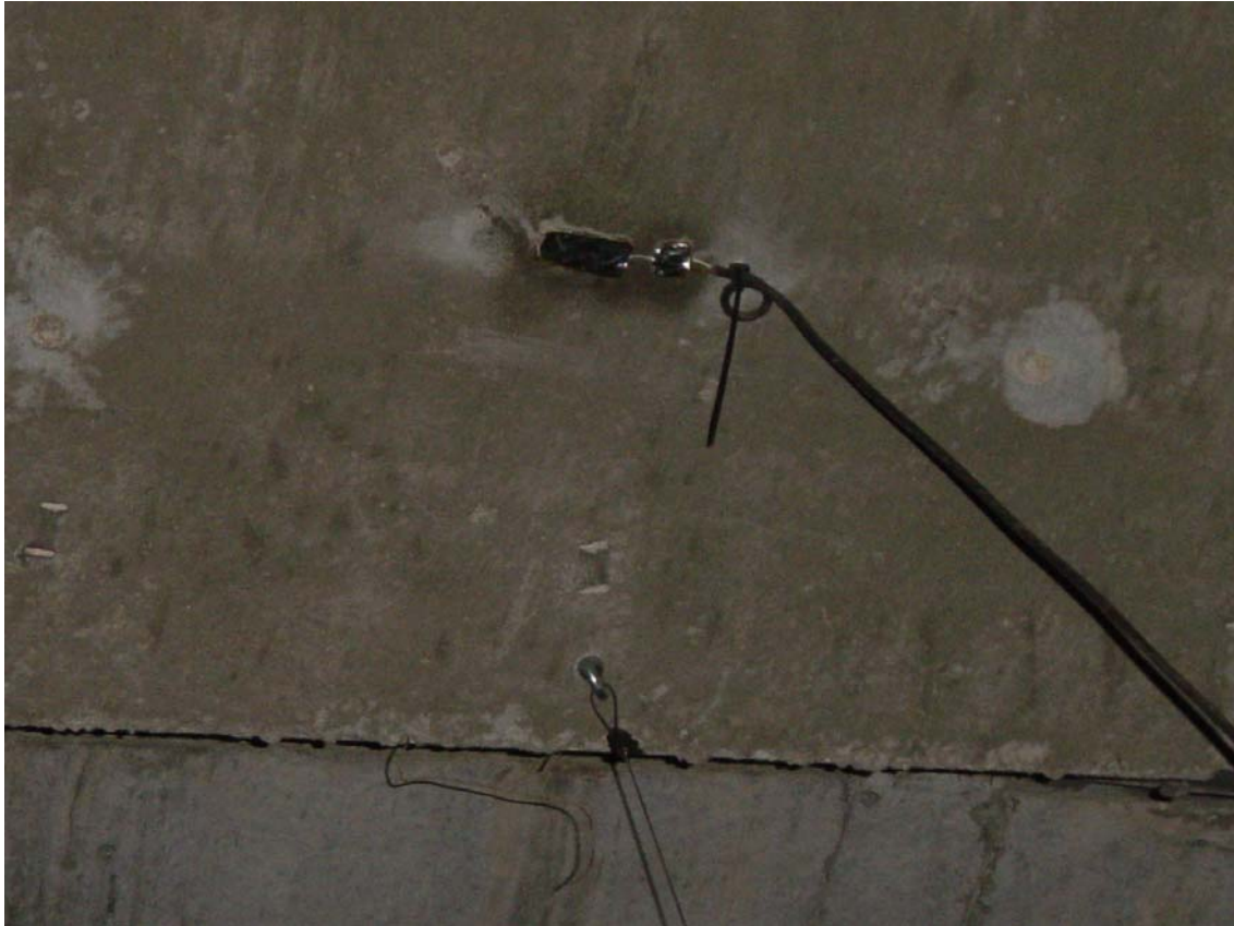
FOTOGRAFIA N°1: Vista de la instrumentación utilizada en el centro de vano
