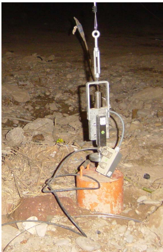
FOTOGRAFIA N°3: Instrumentación utilizada en el centro de vano.
