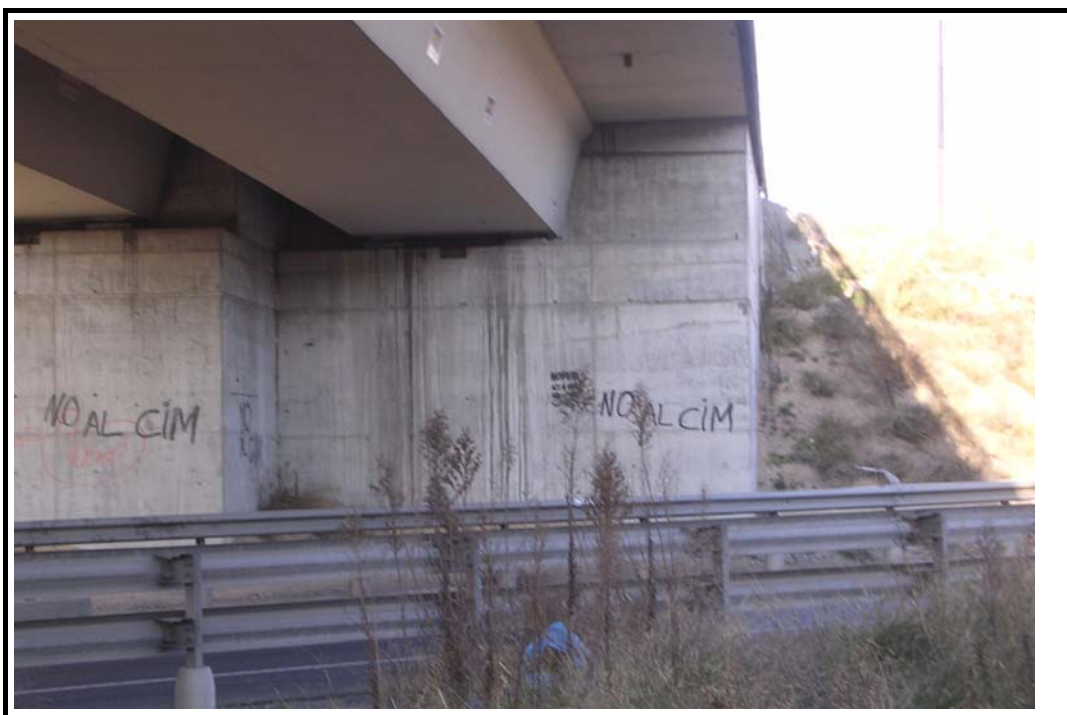
Foto 3: Estribo de salida
