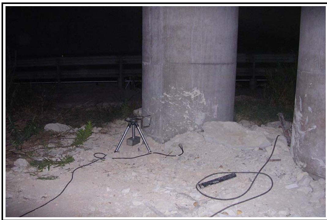
Foto 3: Ménsula para la medida de flechas en apoyos
