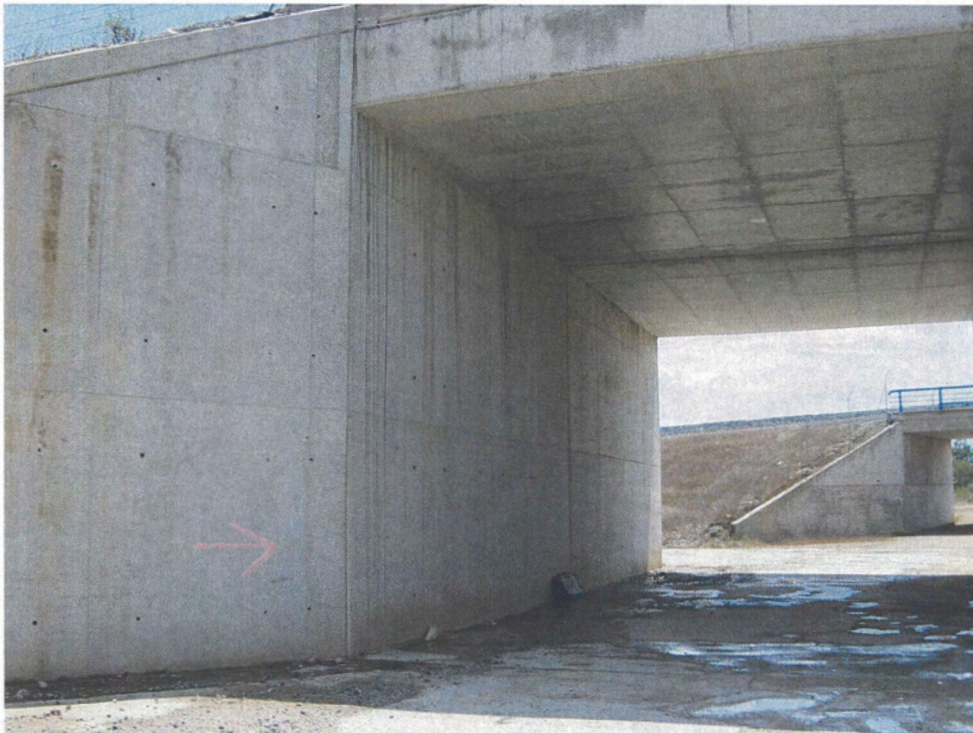
Foto 5: Estribo de entrada (Vilafranca)
