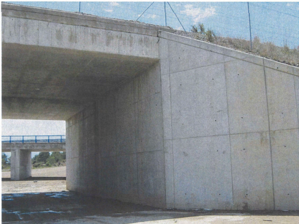
Foto 6: Estribo de salida (Lleida)
