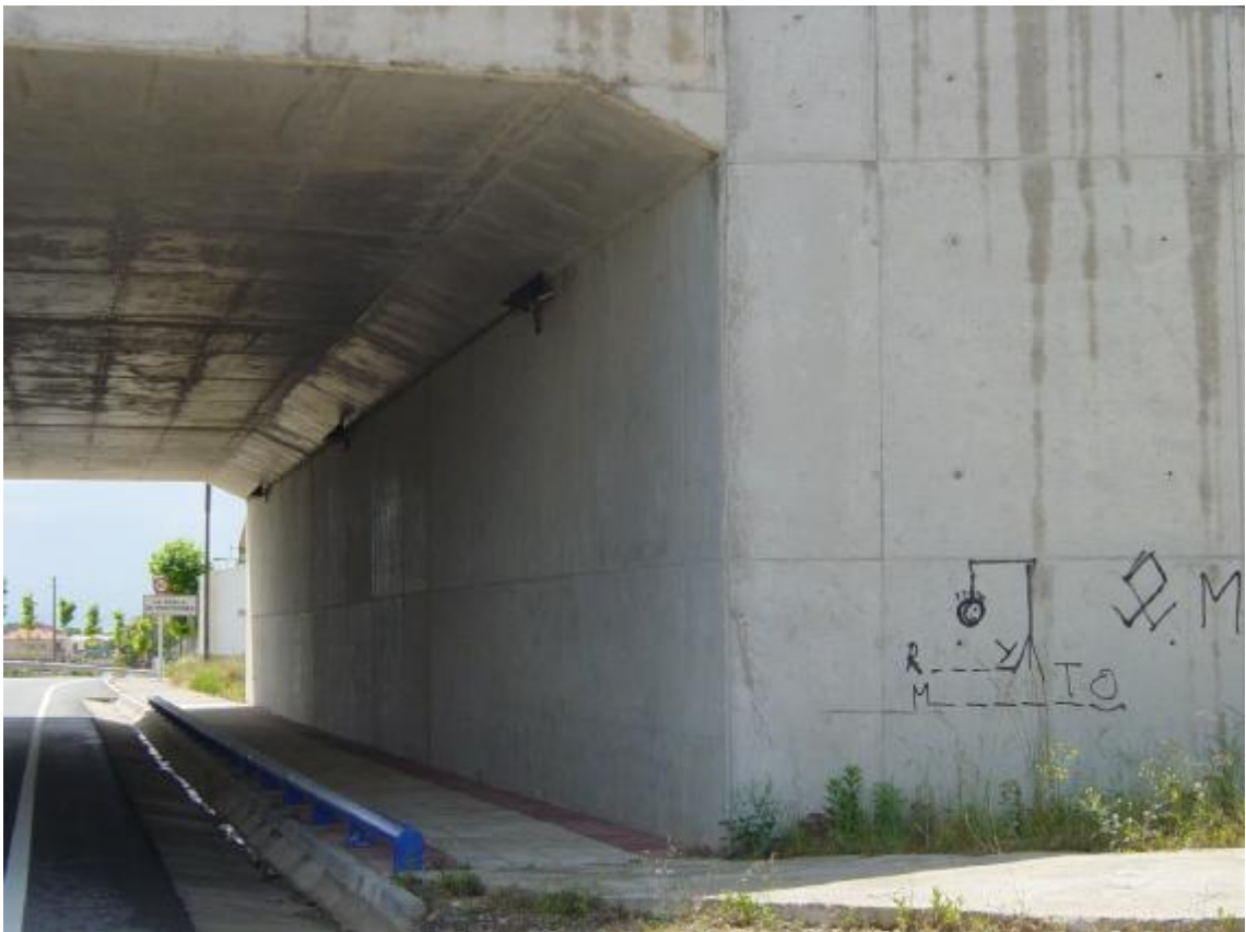
FOTOGRAFÍA N°6: Estribo de salida.
