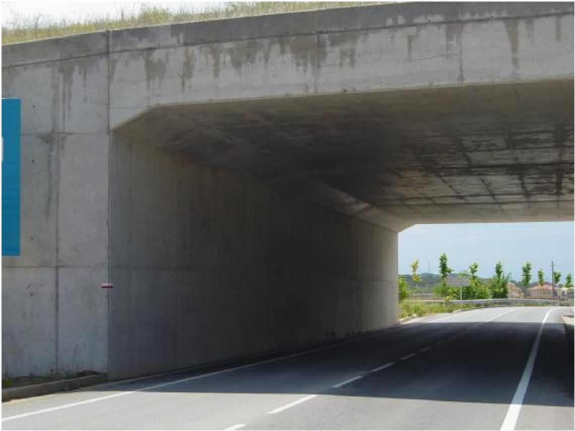
FOTOGRAFÍA N°5: Estribo de entrada.
