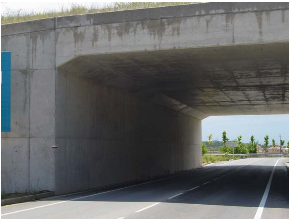
Foto 5: Estribo de entrada (Vilafranca)
