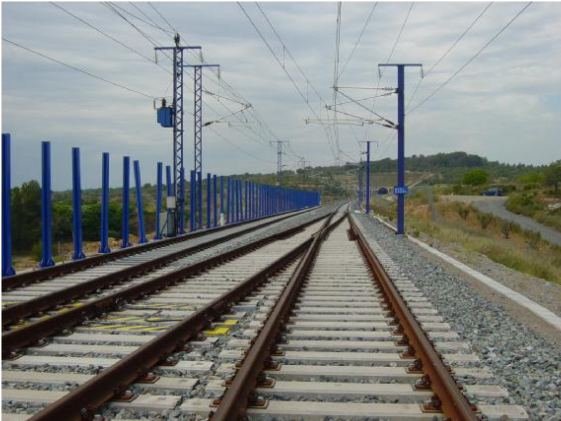
FOTOGRAFÍA N°3: Vista superior desde entrada.
