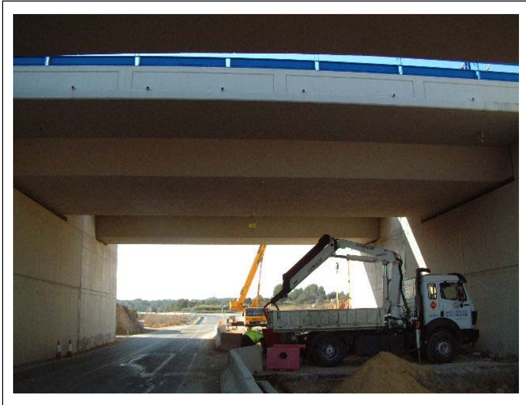
FOTOGRAFÍA 1: Vista general de la estructura
