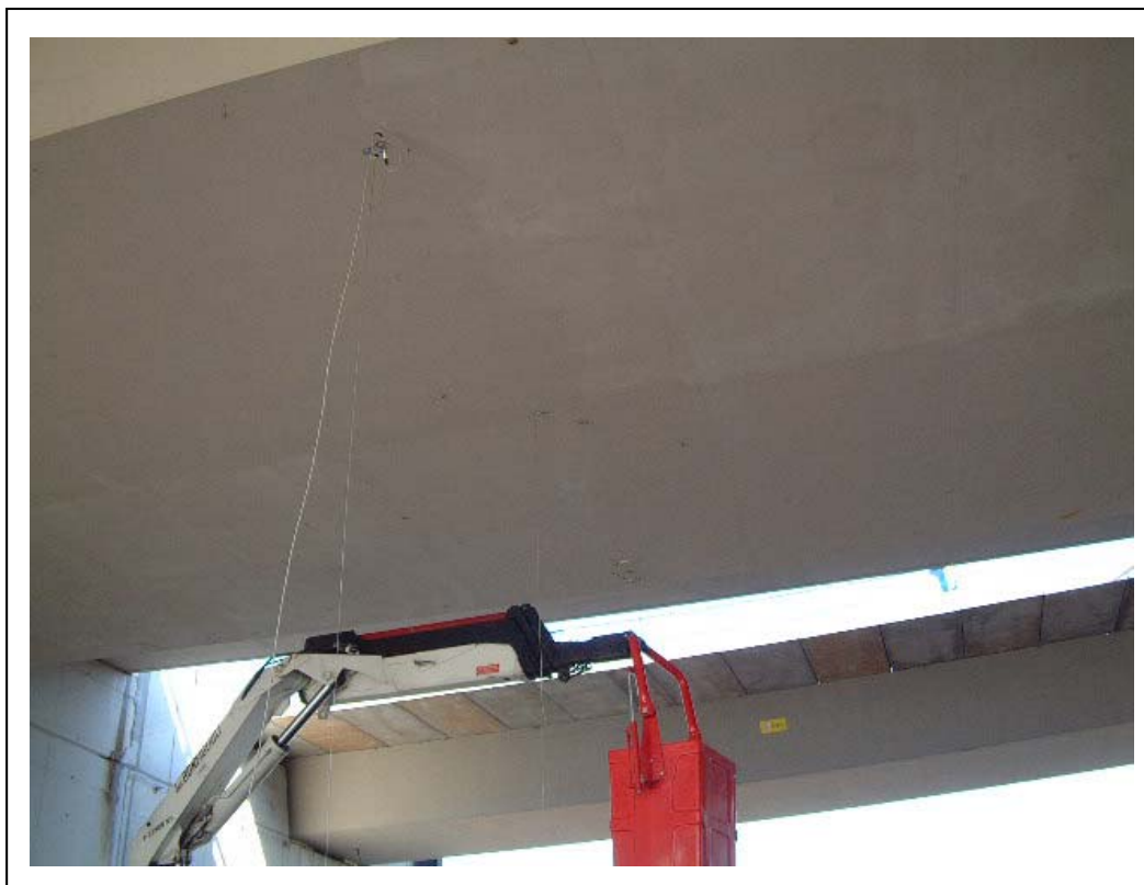
FOTOGRAFÍA 5: Detalle banda extensométrica y flecha a L/2
