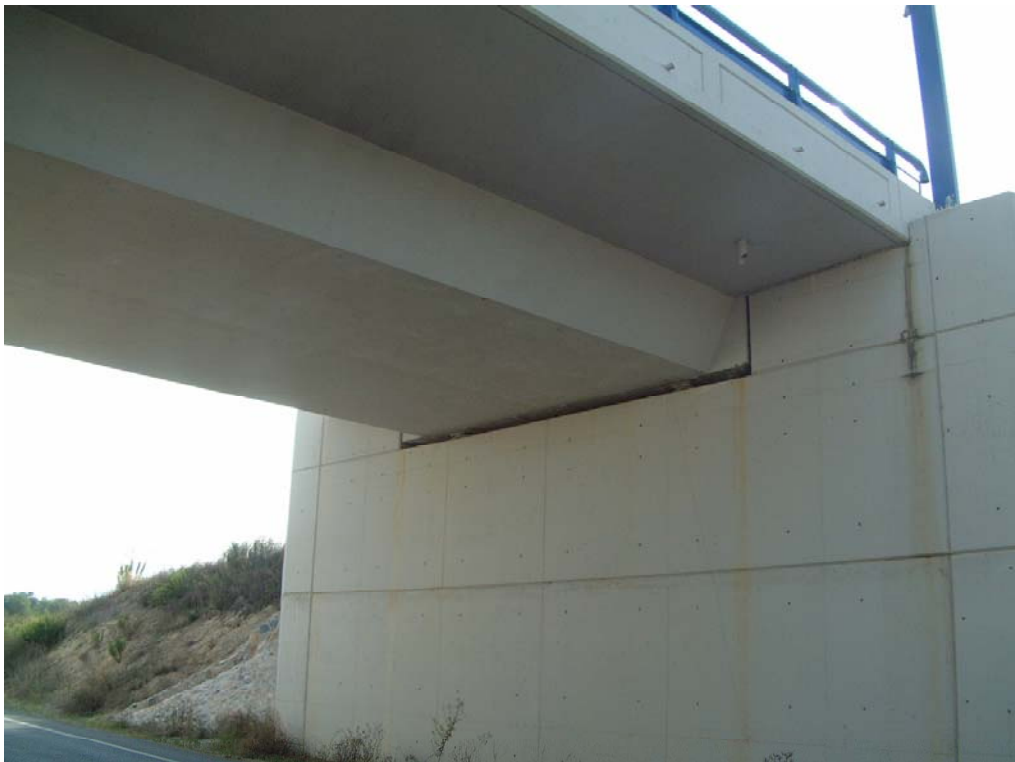
FOTOGRAFÍA Nº 2: ESTRIBO DE ENTRADA
