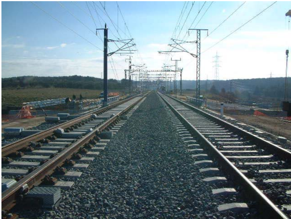
FOTOGRAFÍA N° 5: VISTA SUPERIOR DESDE ENTRADA
