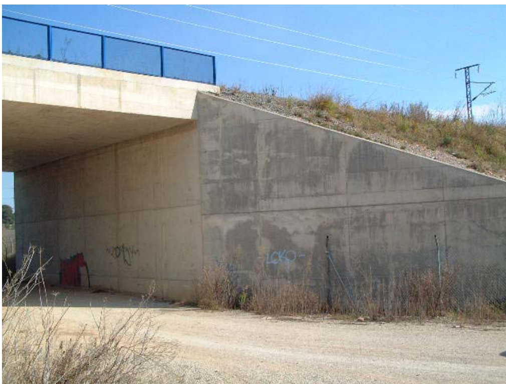
FOTOGRAFÍA N° 6: ESTRIBO DE SALIDA
