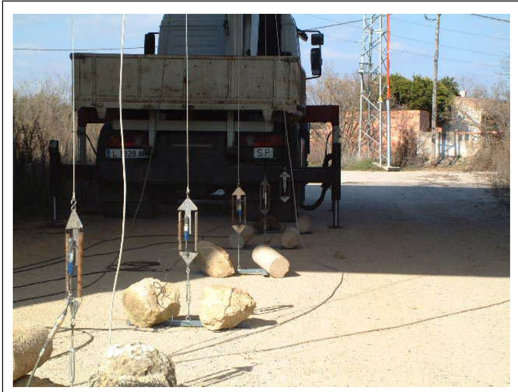
FOTOGRAFÍA 5: Transductores medida de flechas
