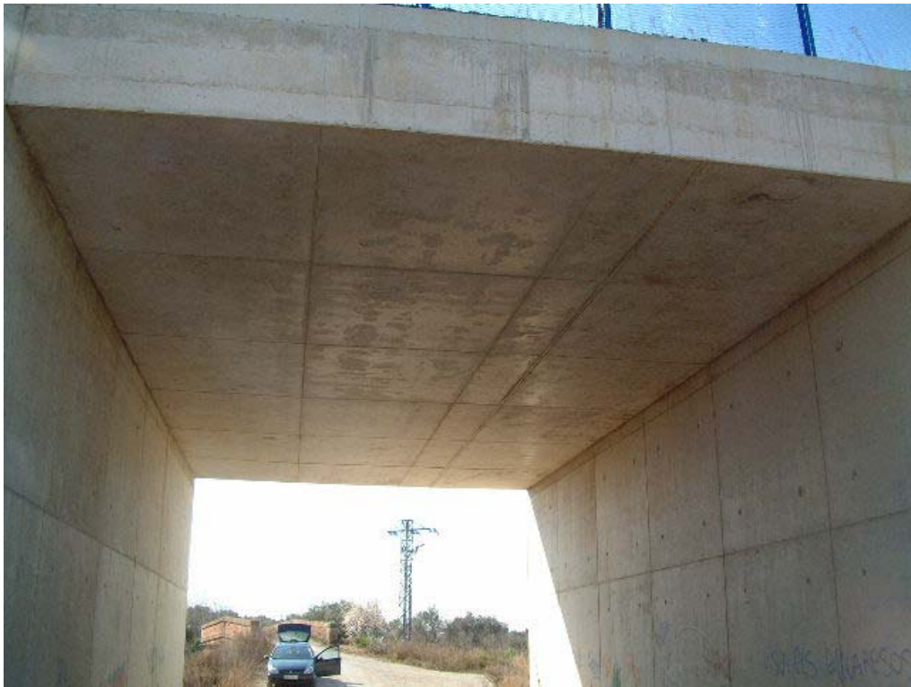
FOTOGRAFÍA N° 8: VISTA INFERIOR DE TABLERO
