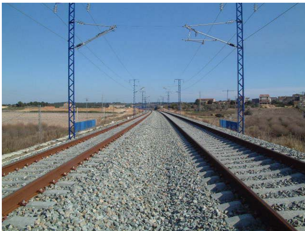
FOTOGRAFÍA N° 3: VISTA SUPERIOR DESDE ENTRADA
