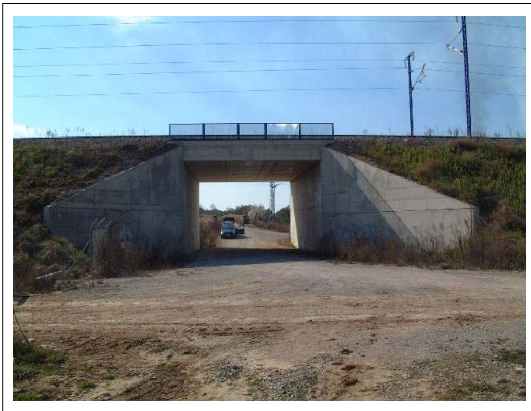
FOTOGRAFÍA 1: Vista general de la estructura
