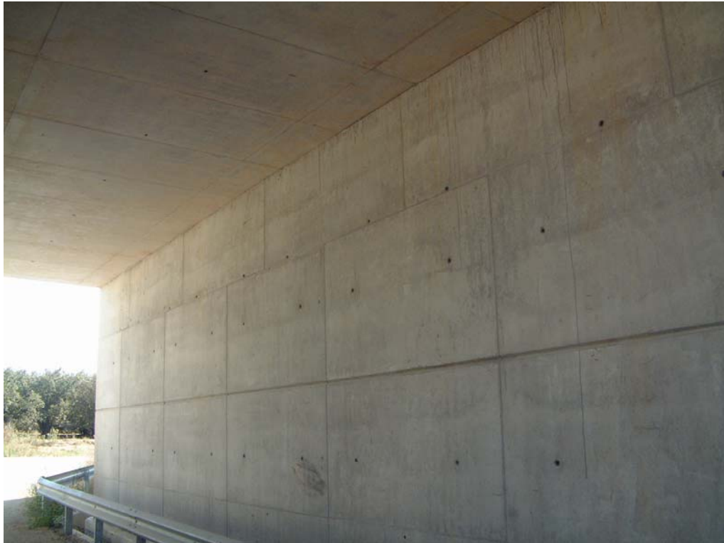
FOTOGRAFÍA N° 3: ESTRIBO DE SALIDA
