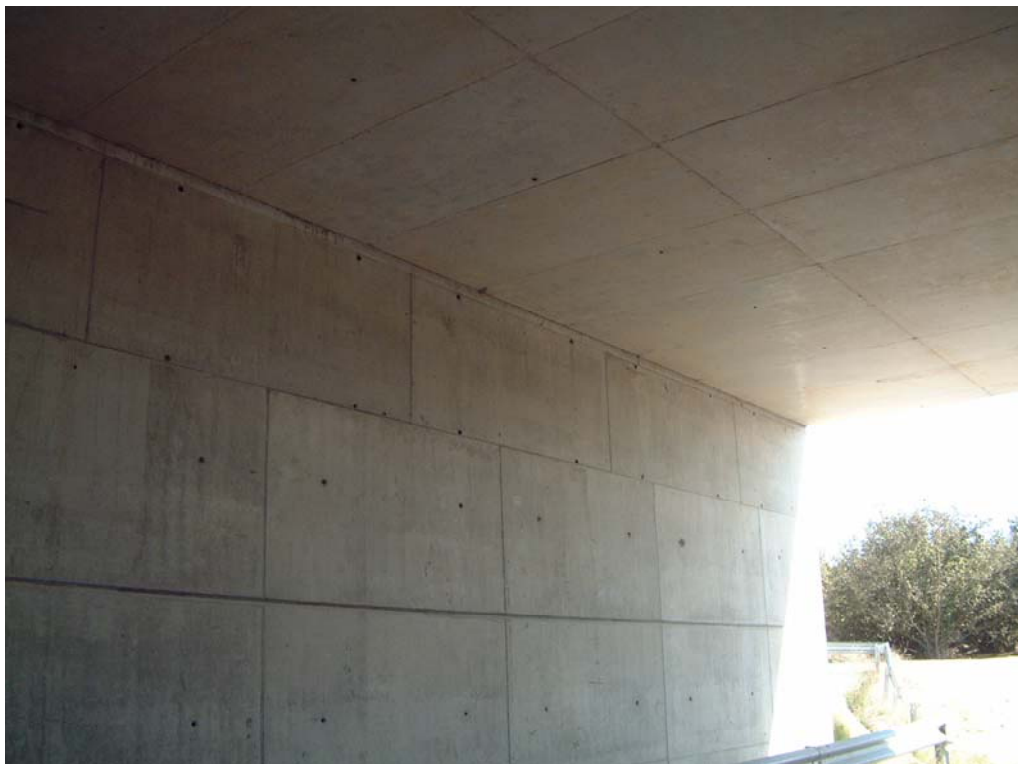
FOTOGRAFÍA Nº 2: ESTRIBO DE ENTRADA
