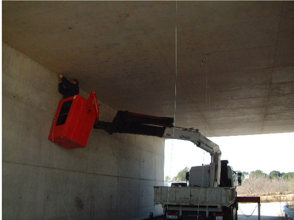
Fotografía 3: Colocación de sensores
