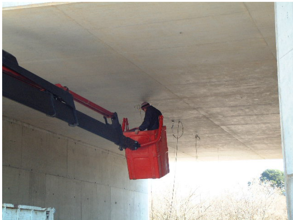
Fotografía 4: Colocación de sensores a L/2
