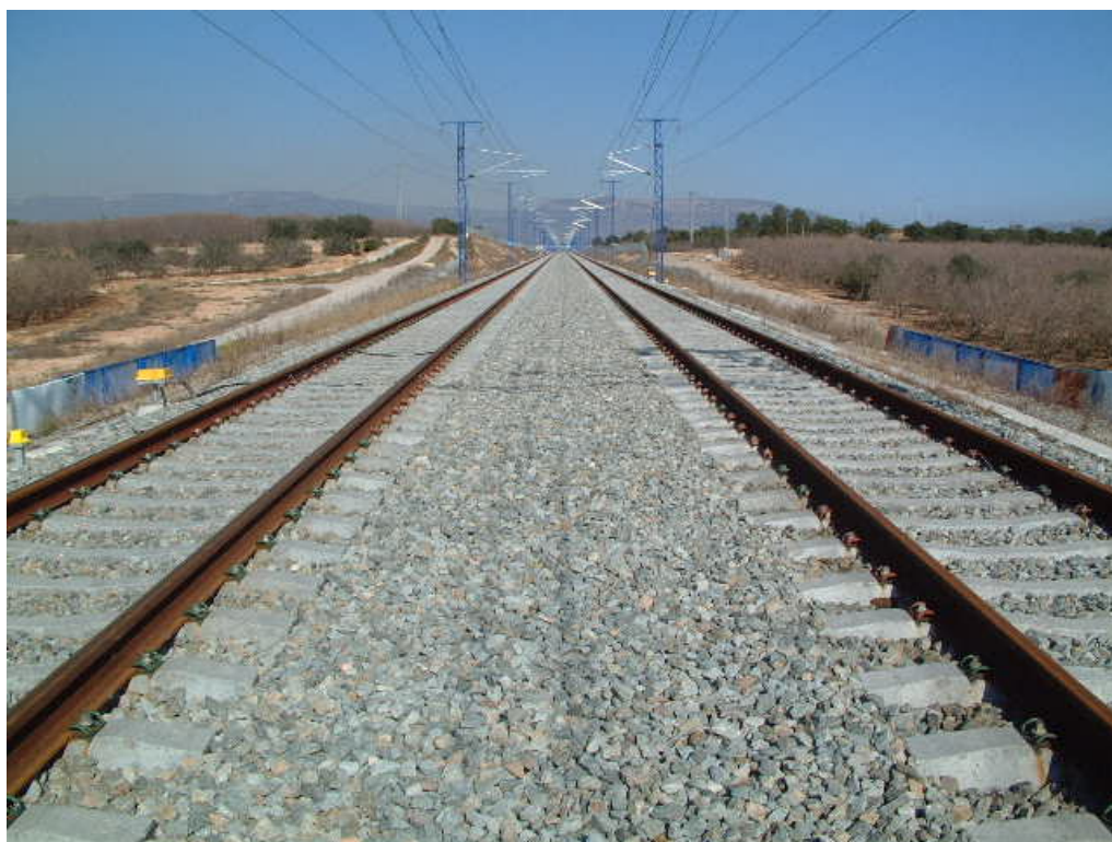
FOTOGRAFÍA Nº 6: VISTA SUPERIOR ESTRIBO BARCELONA
