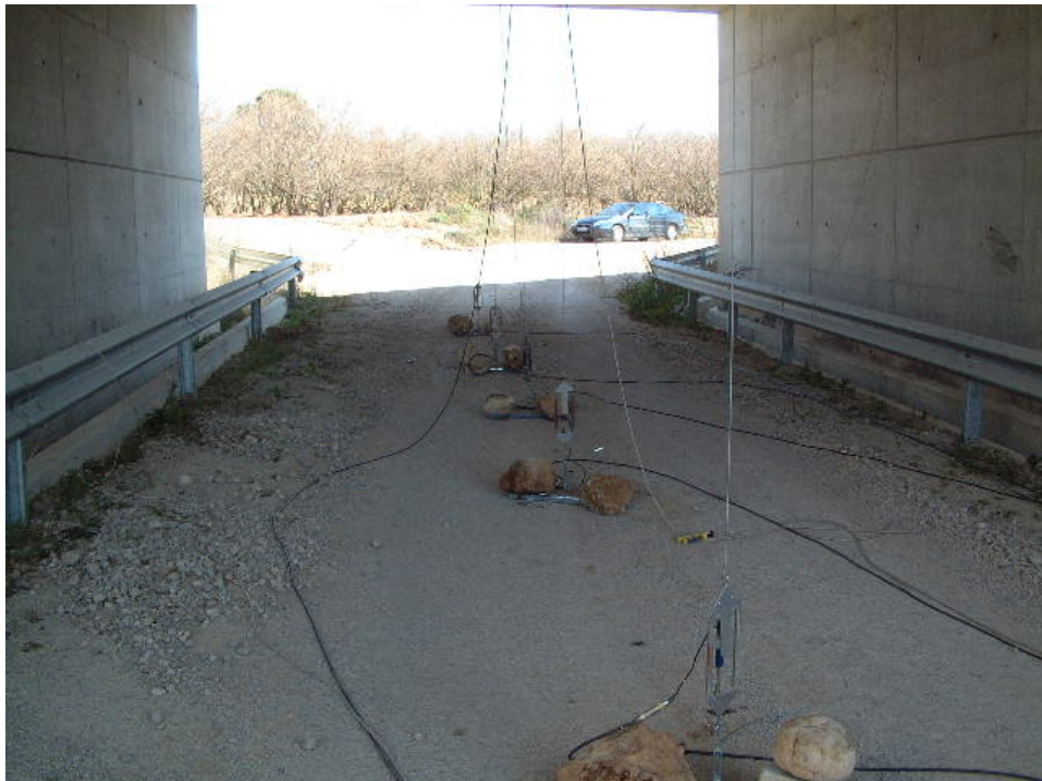
Fotografía 8: Transductores de desplazamiento
