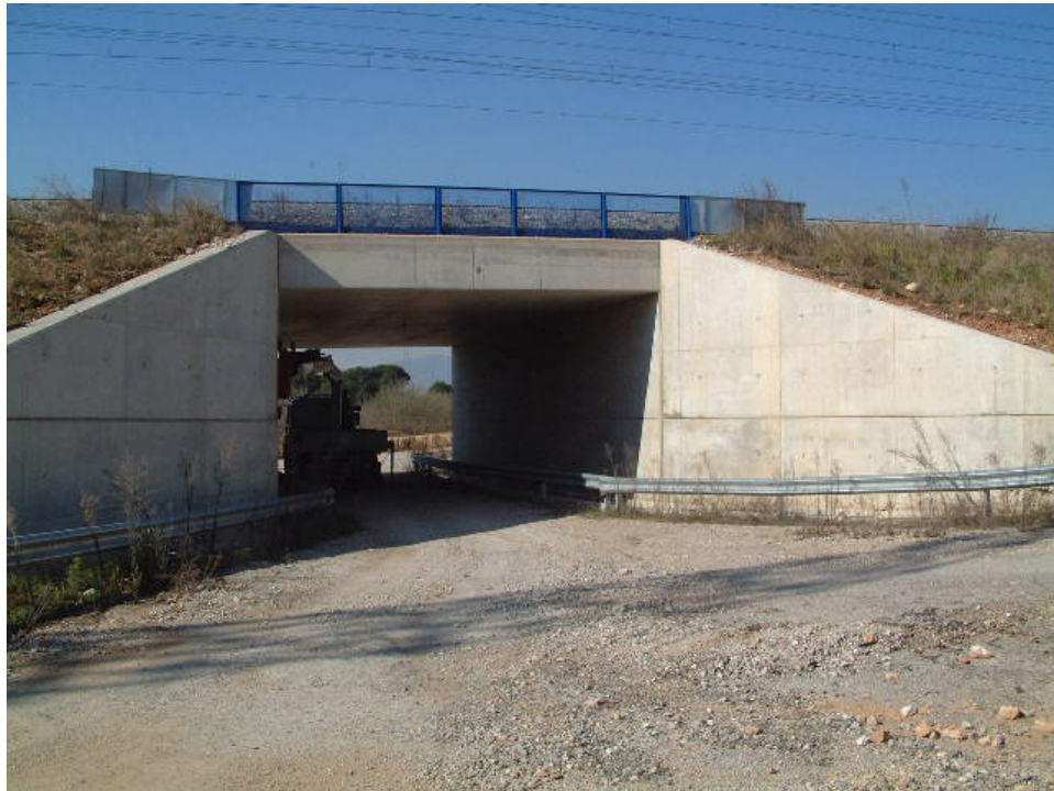
Fotografía 1: Vista general de la estructura
