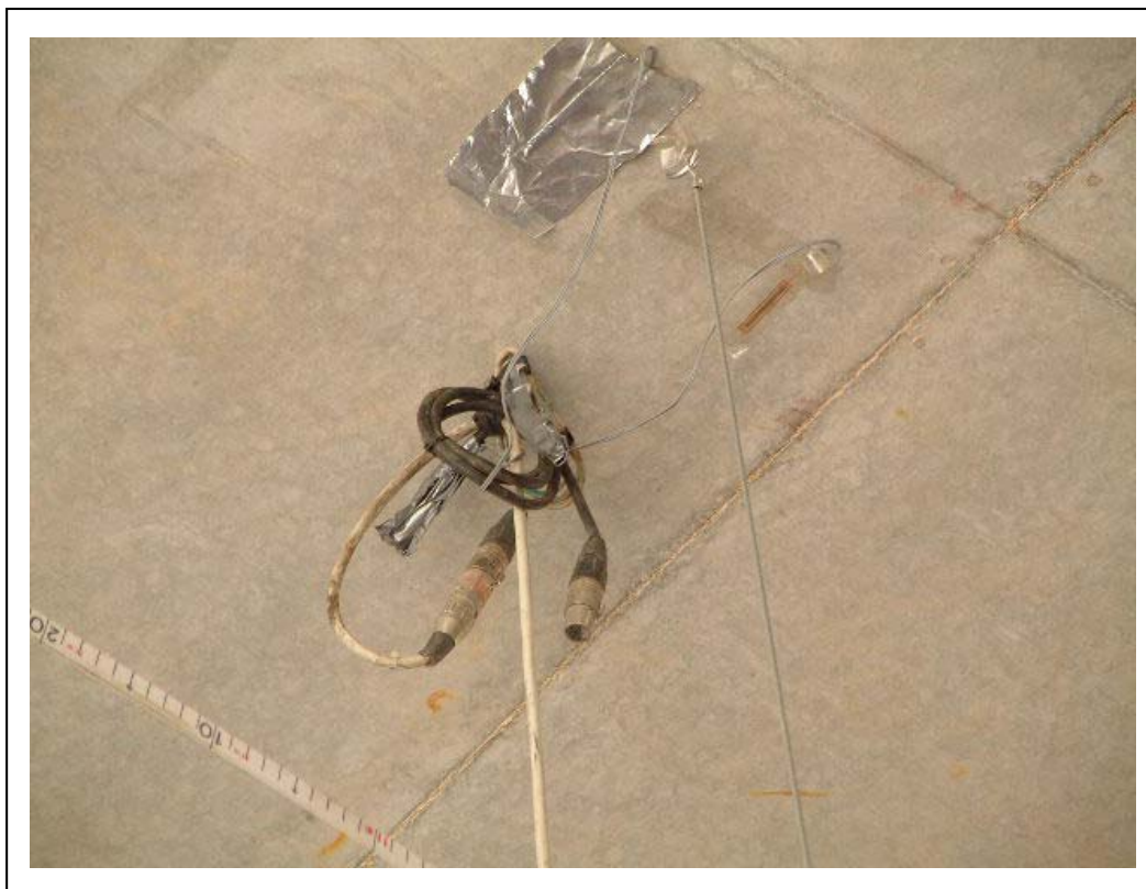
FOTOGRAFÍA 7: Detalle banda extensométrica y flecha a L/2
