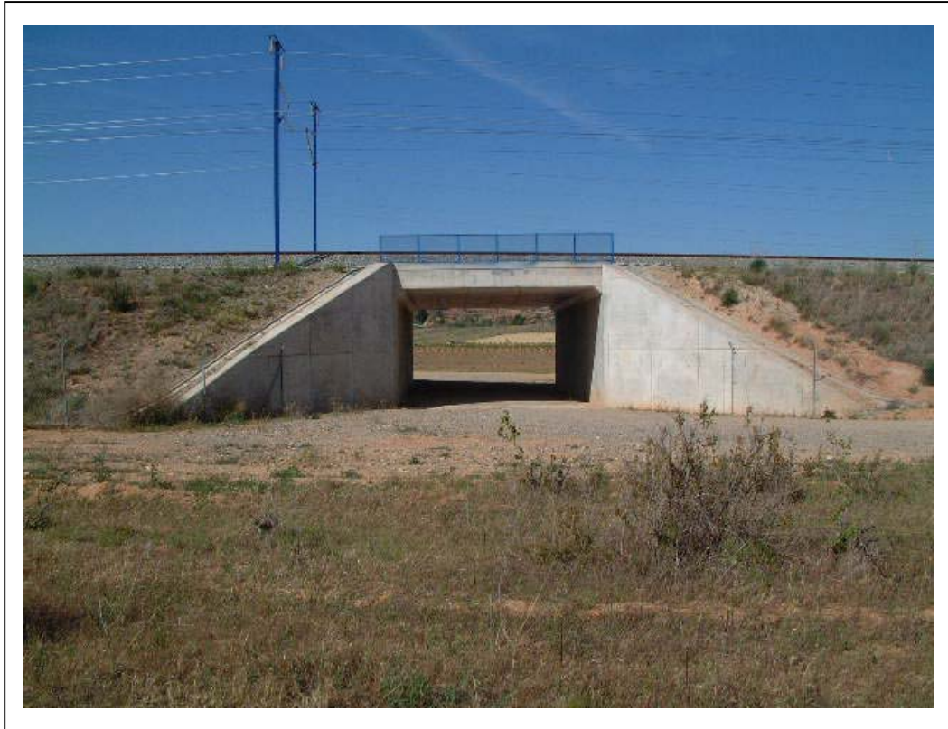
FOTOGRAFÍA 1: Vista general de la estructura
