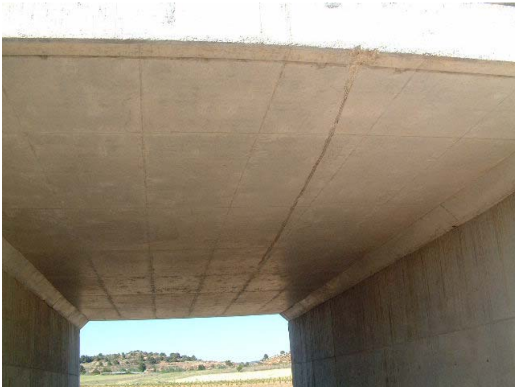
FOTOGRAFÍA N° 8: VISTA INFERIOR DEL TABLERO
