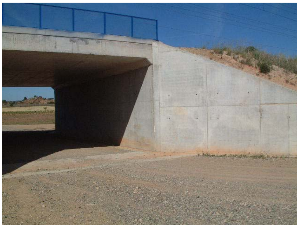
FOTOGRAFÍA Nº 6: ESTRIBO DE SALIDA
