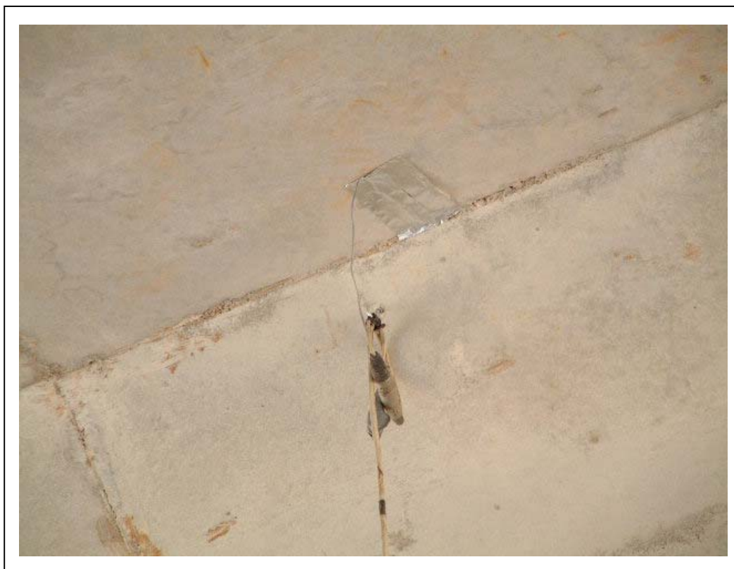
FOTOGRAFÍA 8: Detalle banda extensométrica en empotramiento
