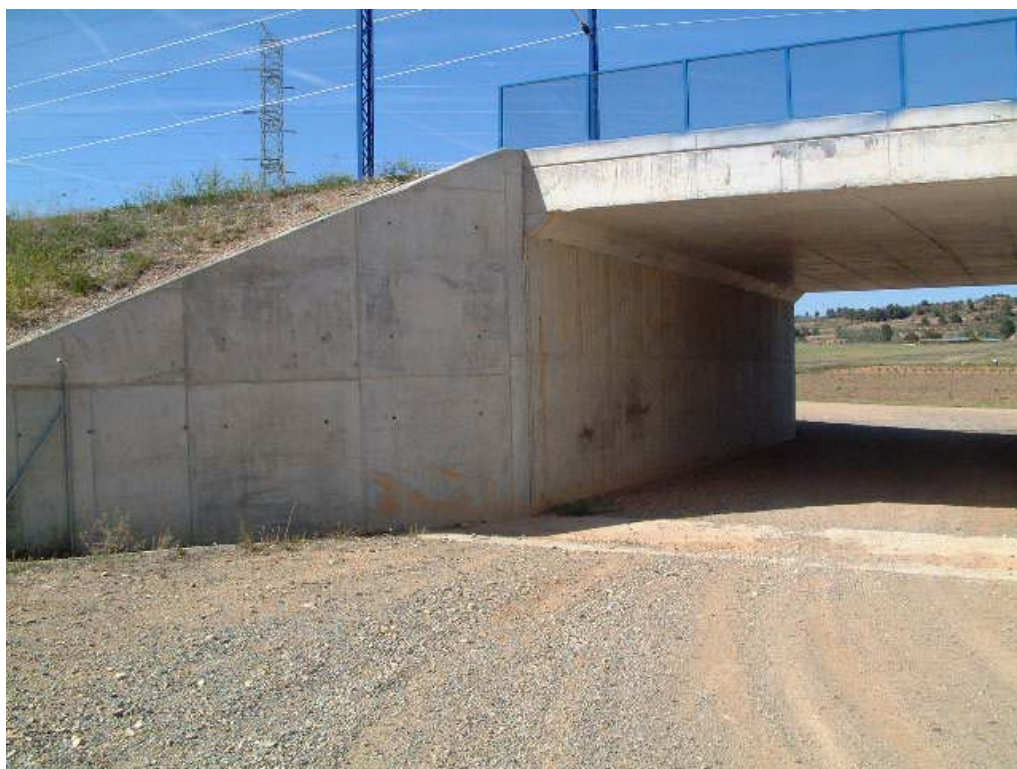
FOTOGRAFÍA Nº 5: ESTRIBO DE ENTRADA
