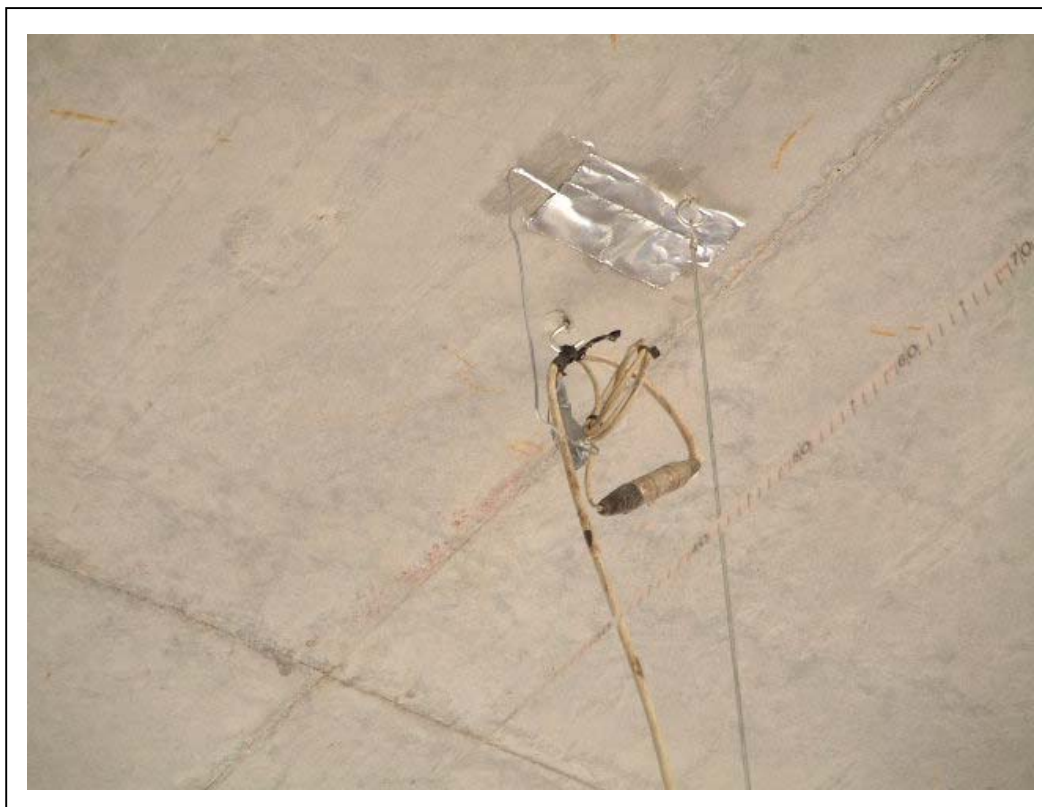
FOTOGRAFÍA 9: Detalle punto de instrumentación L/2
