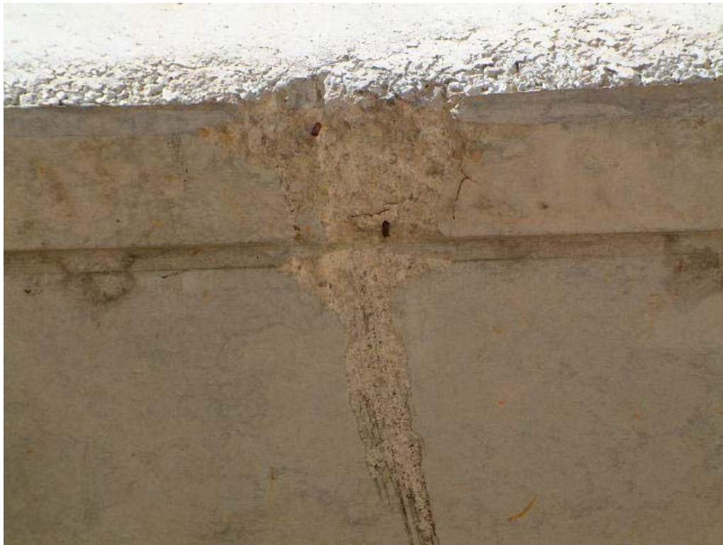
FOTOGRAFÍA Nº 11: ROZADURA TABLERO
