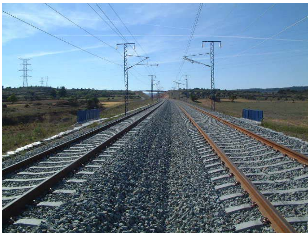
FOTOGRAFÍA Nº 4: VISTA SUPERIOR DESDE SALIDA
