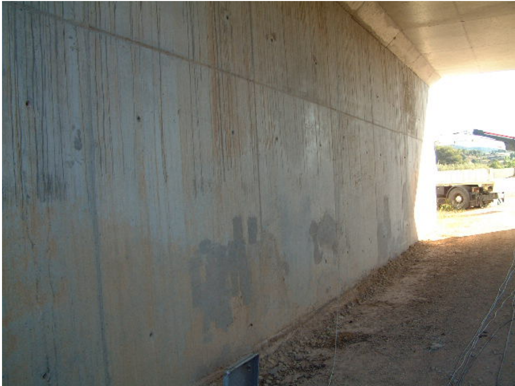
FOTOGRAFÍA N° 5: ESTRIBO DE ENTRADA
