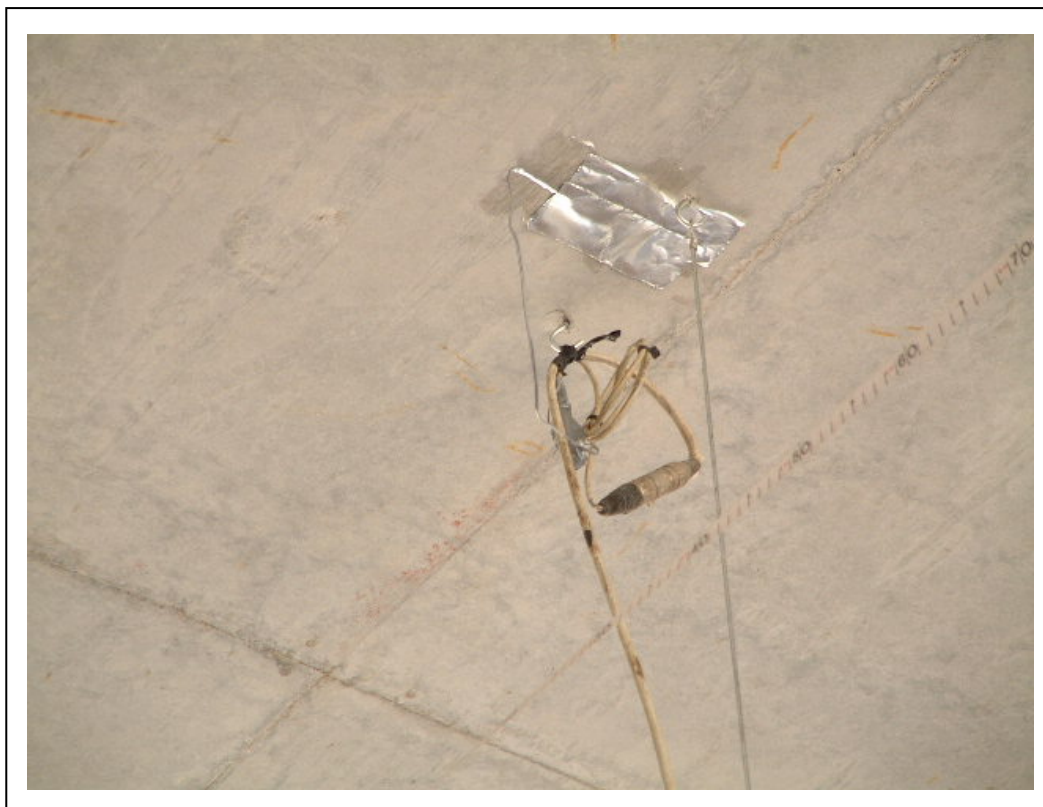
FOTOGRAFÍA 9: Detalle punto de instrumentación L/2
