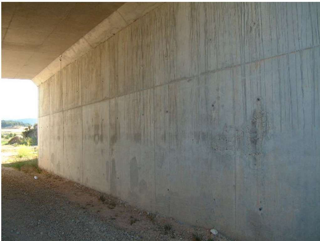
FOTOGRAFÍA N° 6: ESTRIBO DE SALIDA
