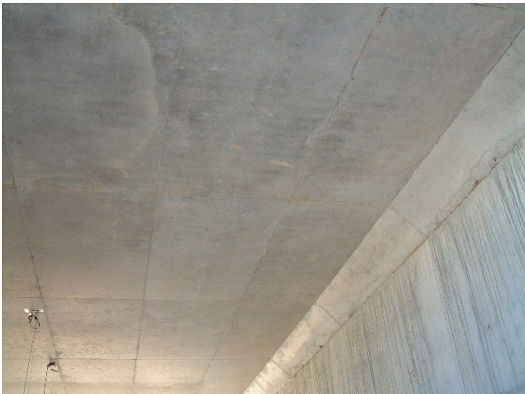
FOTOGRAFÍA N° 8: VISTA INFERIOR DEL TABLERO
