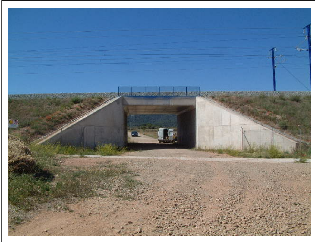
FOTOGRAFÍA 1: Vista general de la estructura
