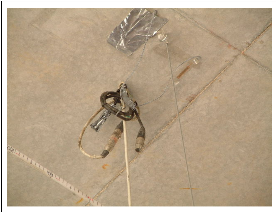
FOTOGRAFÍA 7: Detalle banda extensométrica y flecha a L/2
