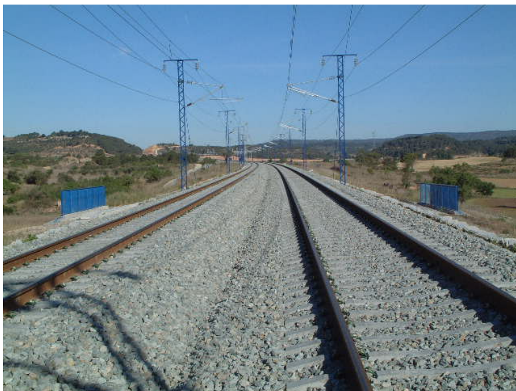
FOTOGRAFÍA Nº 4: VISTA SUPERIOR DESDE SALIDA
