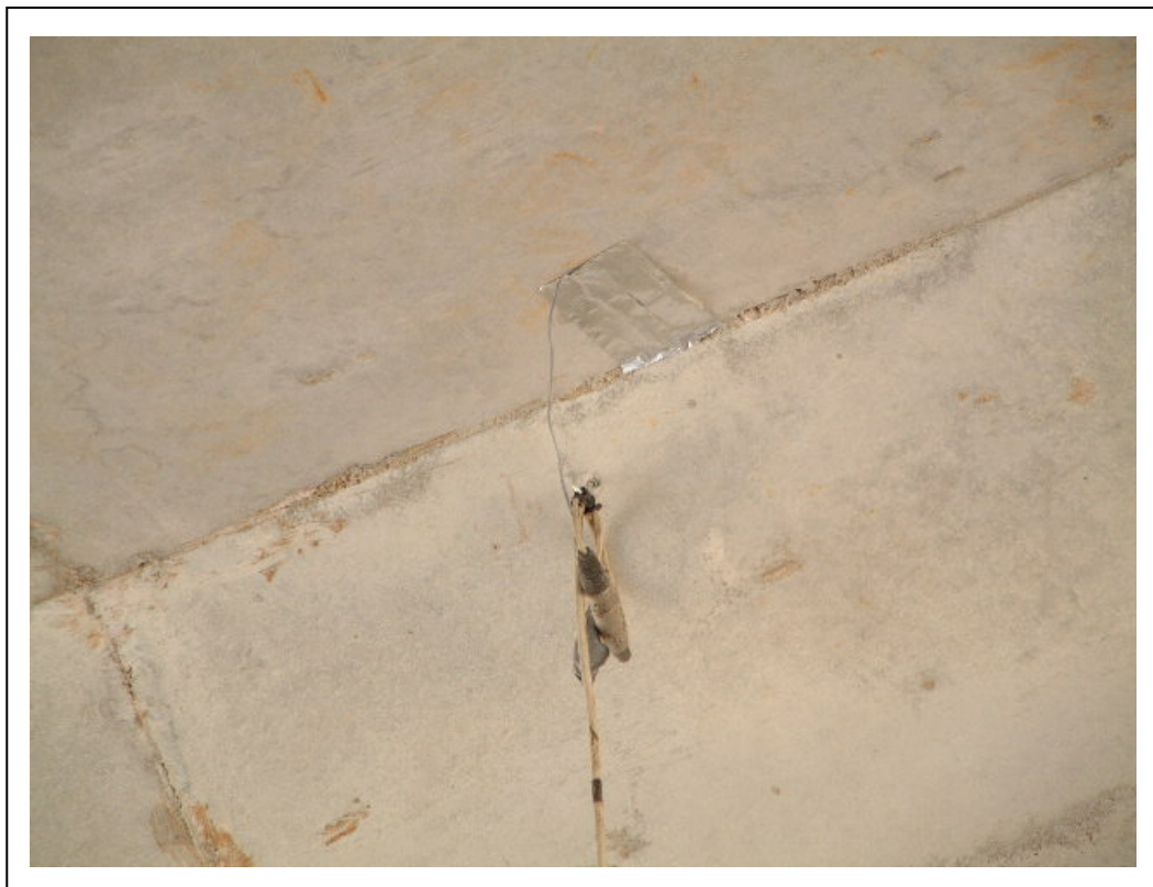
FOTOGRAFÍA 8: Detalle banda extensométrica en empotramiento
