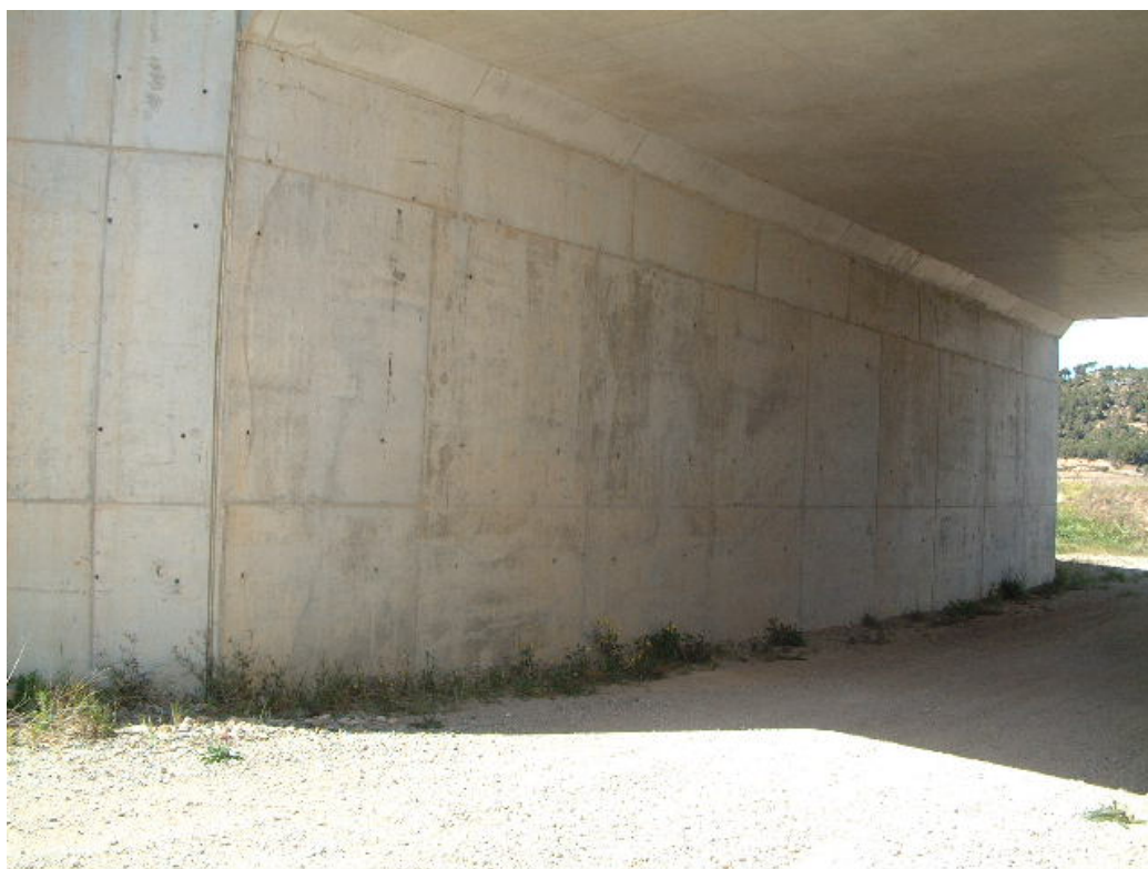
FOTOGRAFÍA Nº 5: ESTRIBO DE ENTRADA
