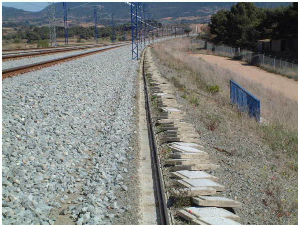
FOTOGRAFÍA Nº 9: PASEO DE SERVICIO DERECHO
