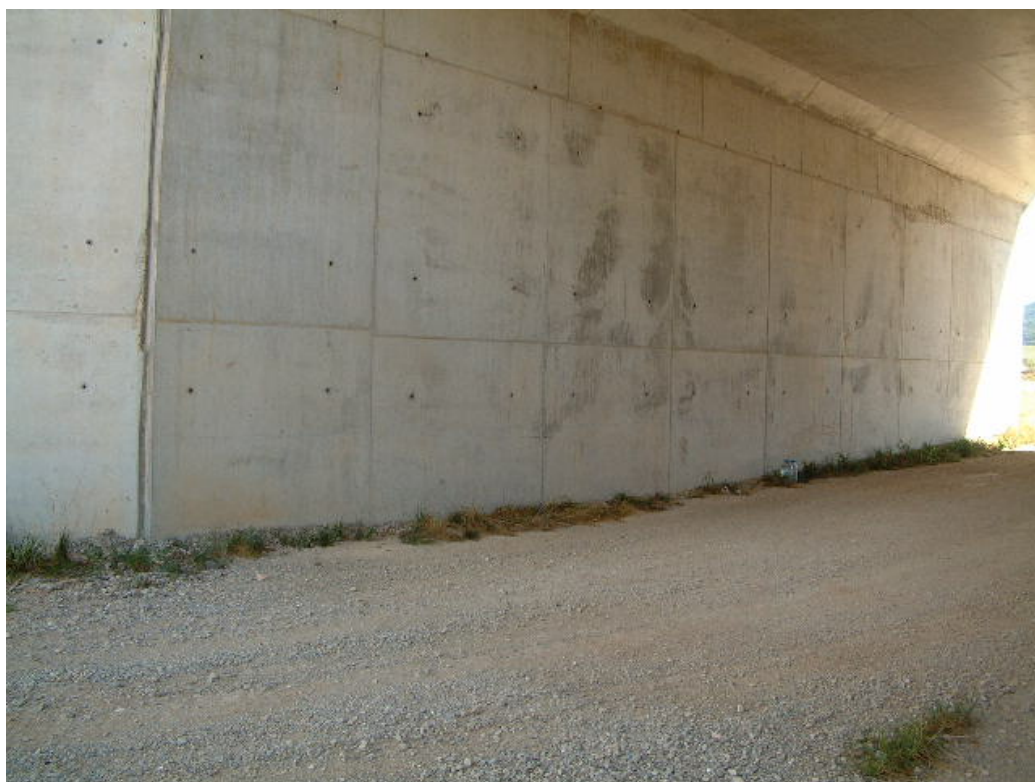
FOTOGRAFÍA Nº 6: ESTRIBO DE SALIDA
