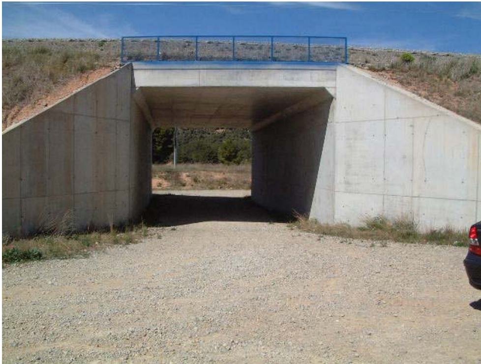
FOTOGRAFÍA 1: Vista general de la estructura
