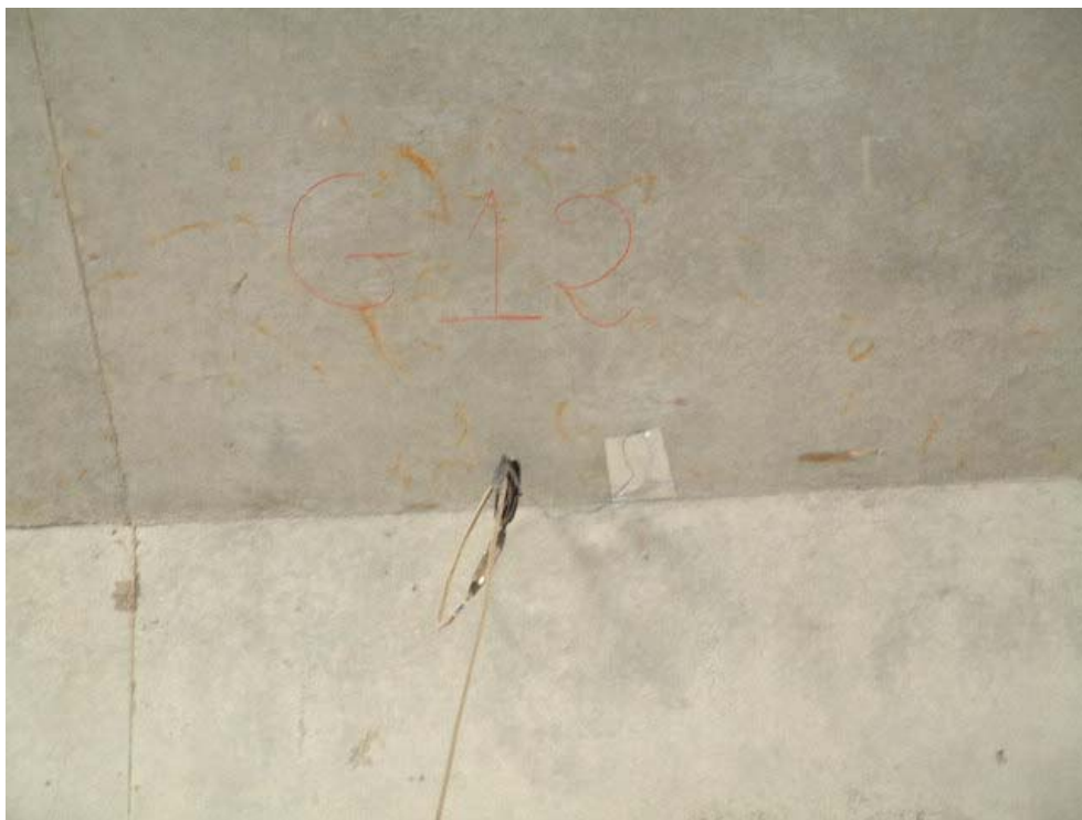
FOTOGRAFÍA 8: Banda extensométrica en empotramiento
