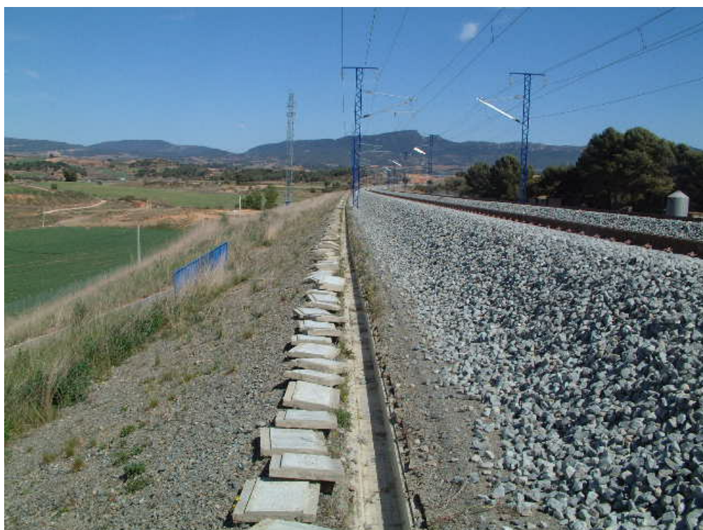
FOTOGRAFÍA Nº 10: PASEO DE SERVICIO IZQUIERDO
