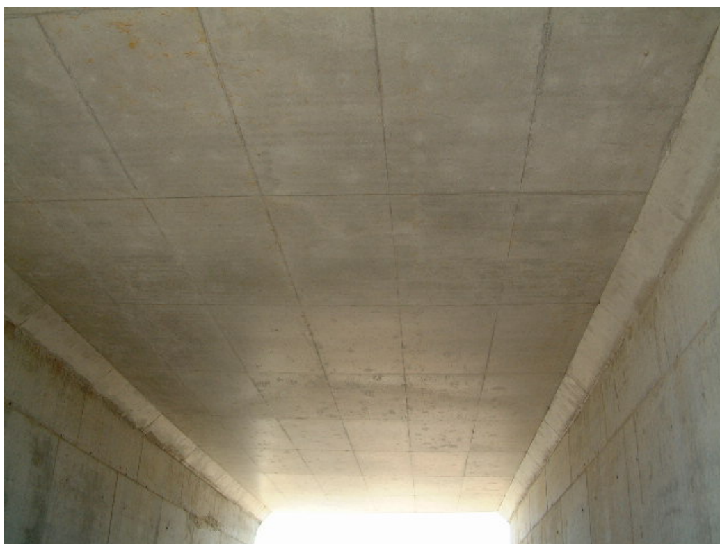
FOTOGRAFÍA N° 8: VISTA INFERIOR DEL TABLERO
