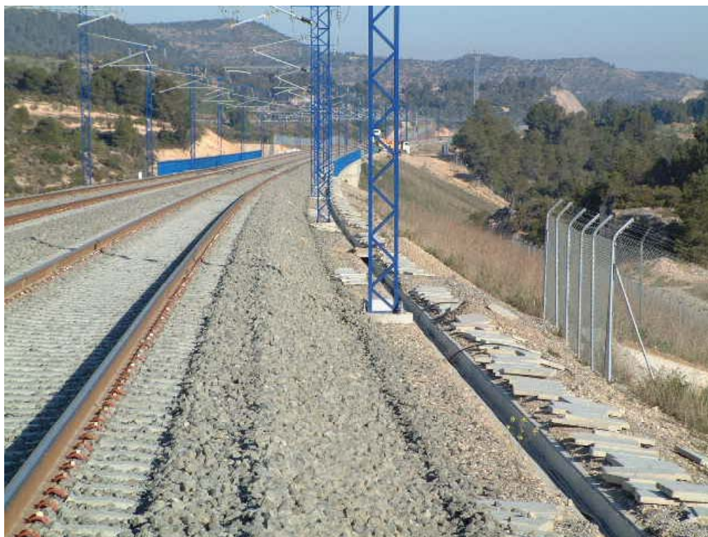
FOTOGRAFÍA N° 10: PASEO DE SERVICIO IZQUIERDO
