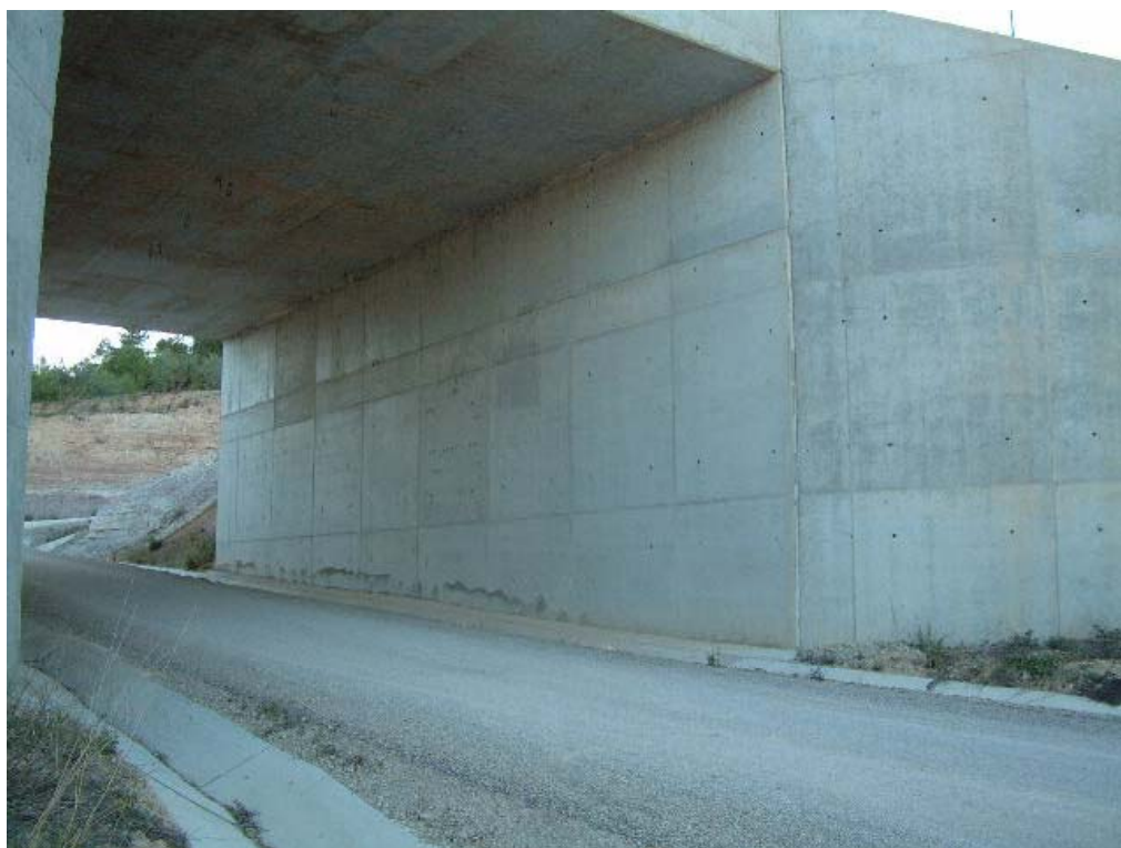
FOTOGRAFÍA N° 6: ESTRIBO DE SALIDA
