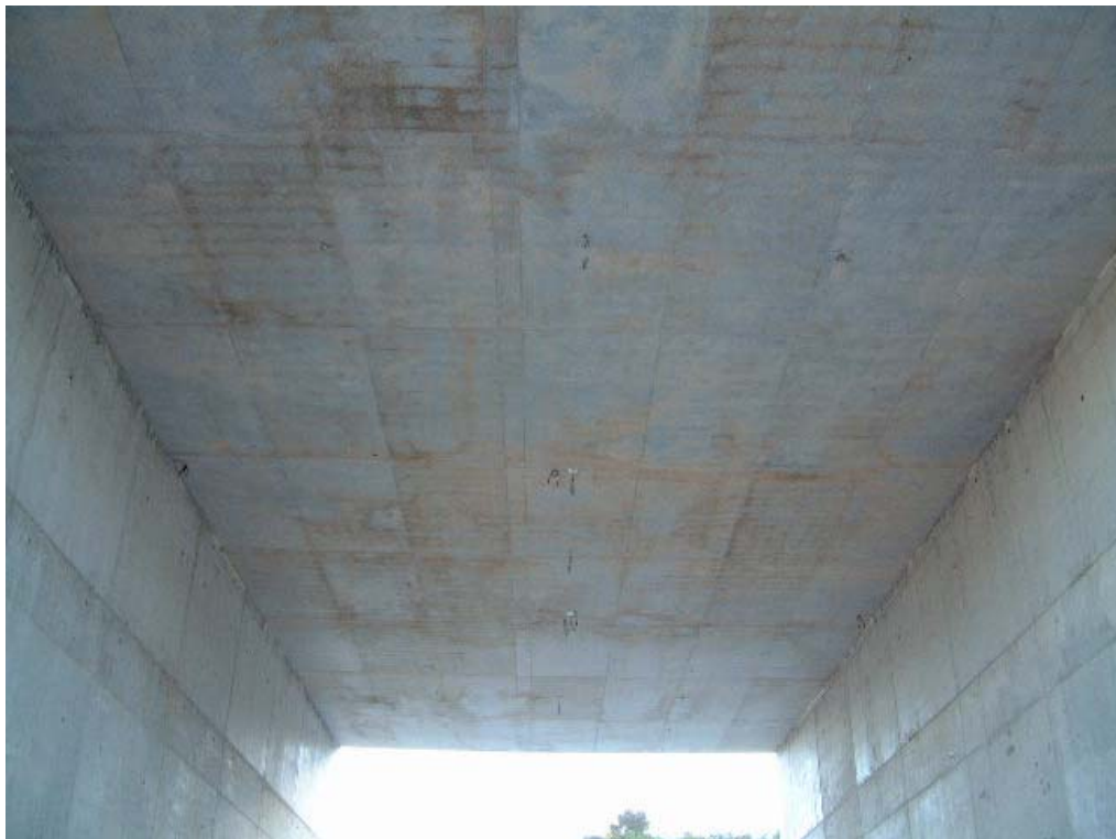
FOTOGRAFÍA N° 8: VISTA INFERIOR DEL TABLERO
