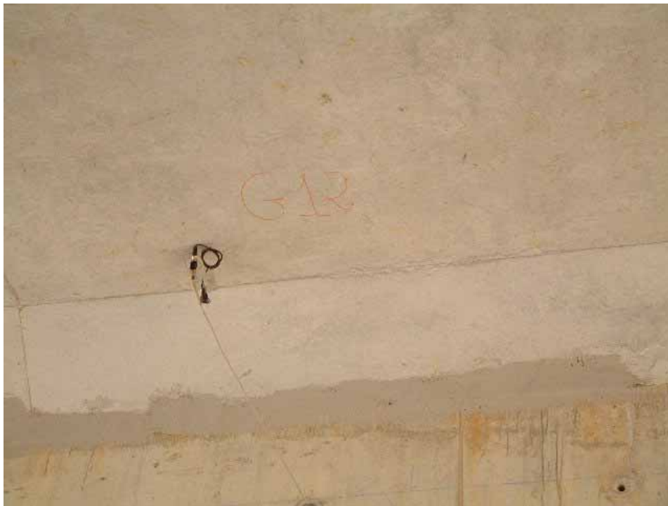
FOTOGRAFÍA 8: Banda extensométrica en empotramiento
