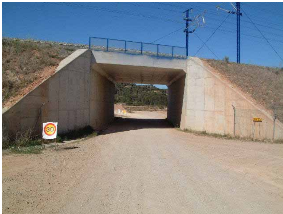
FOTOGRAFÍA 1: Vista general de la estructura
