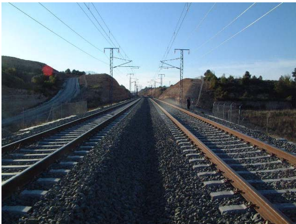
FOTOGRAFÍA Nº 3: VISTA SUPERIOR DESDE ENTRADA
