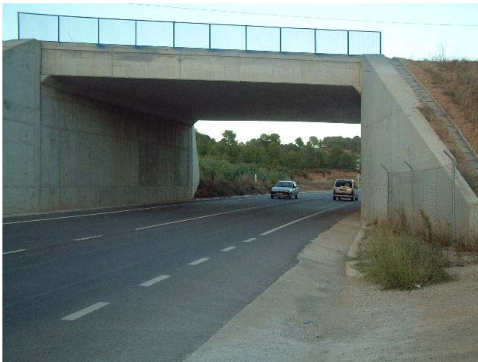
FOTOGRAFÍA 1: Vista general de la estructura
