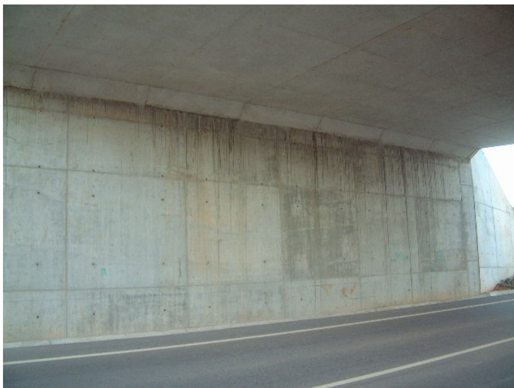
FOTOGRAFÍA N° 4: ESTRIBO DE ENTRADA
