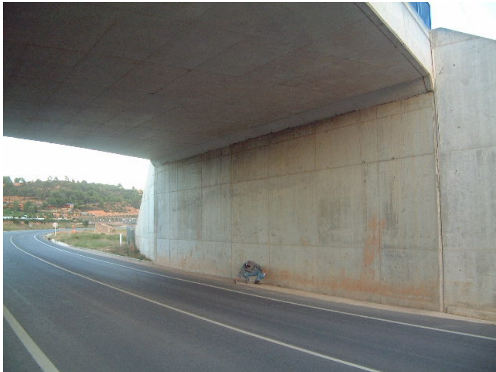
FOTOGRAFÍA N° 5: ESTRIBO DE SALIDA
