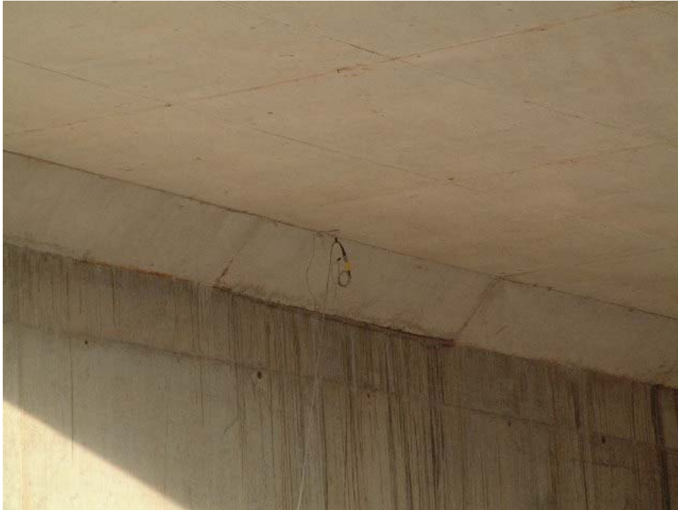
FOTOGRAFÍA 5: Banda extensométrica en empotramiento
