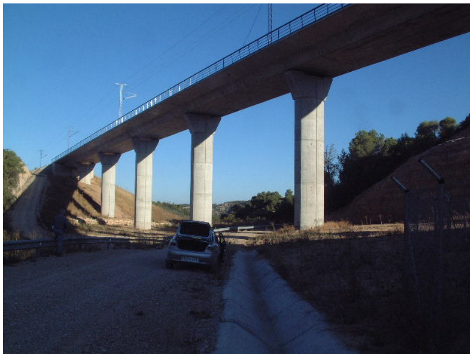
Fotografía 1: vista general de la estructura (Estribo Barcelona)
