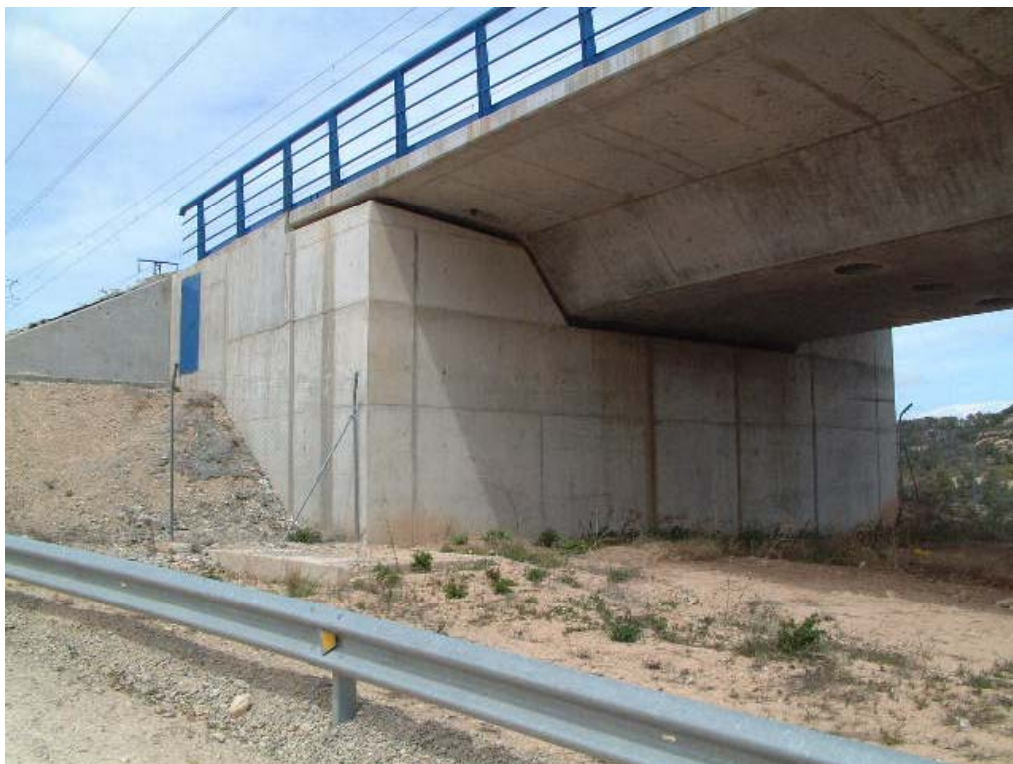
FOTOGRAFÍA N° 5: ESTRIBO DE ENTRADA
