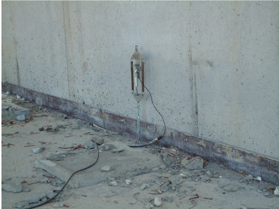
Fotografía 9: Transductor de desplazamiento (Apoyo)
