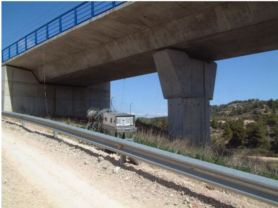
Fotografía 12: Equipos de adquisición de datos 2
