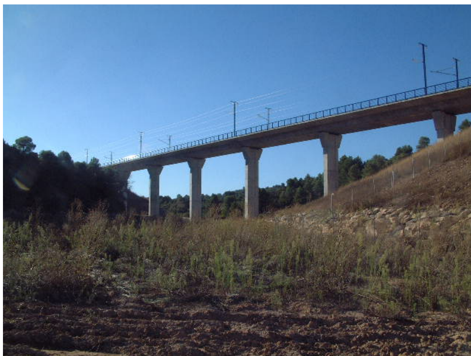
Fotografía 2: vista general de la estructura (Alzado)
