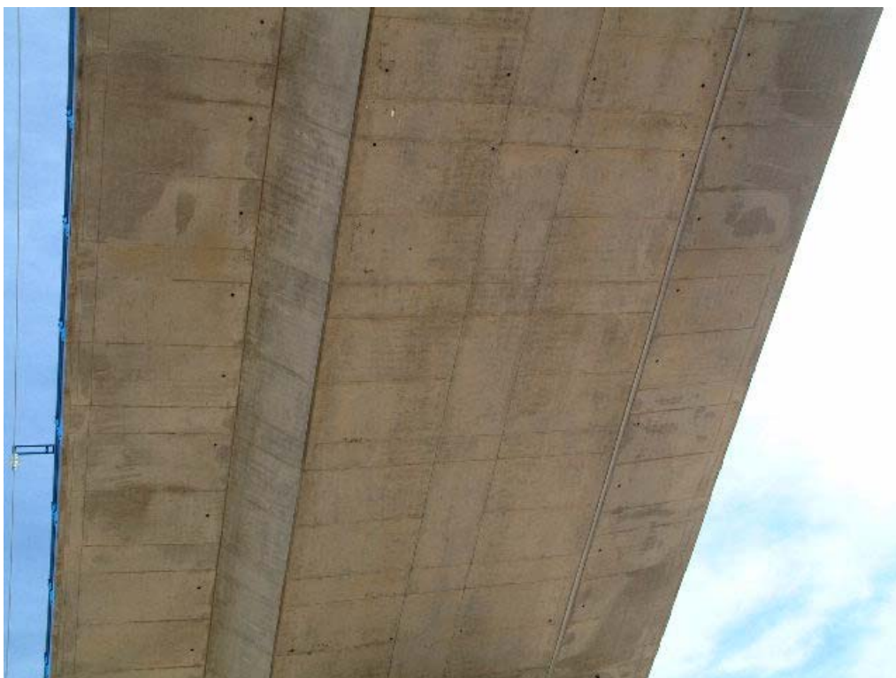
FOTOGRAFÍA N° 8: VISTA INFERIOR DEL TABLERO
