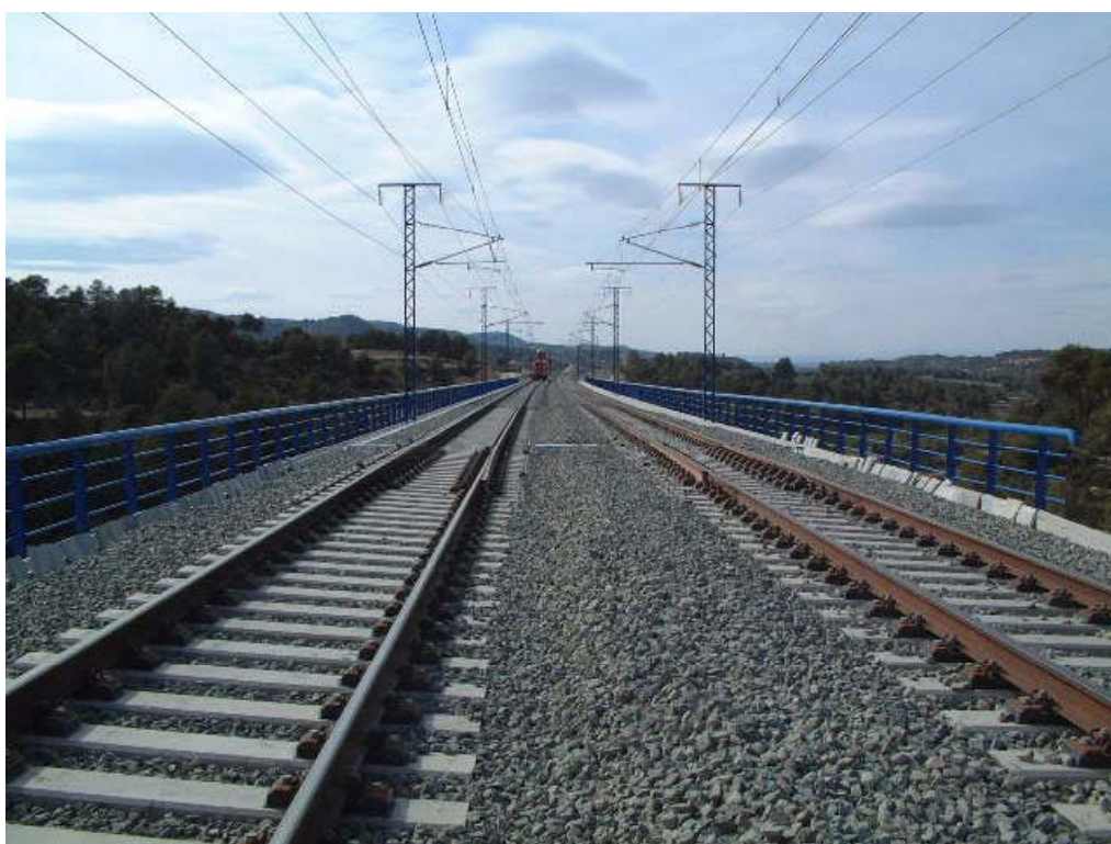
FOTOGRAFÍA Nº 4: VISTA SUPERIOR DESDE SALIDA
