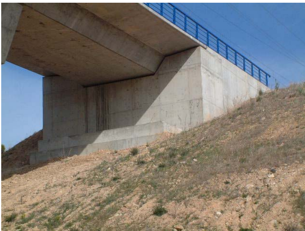
FOTOGRAFÍA N° 6: ESTRIBO DE SALIDA
