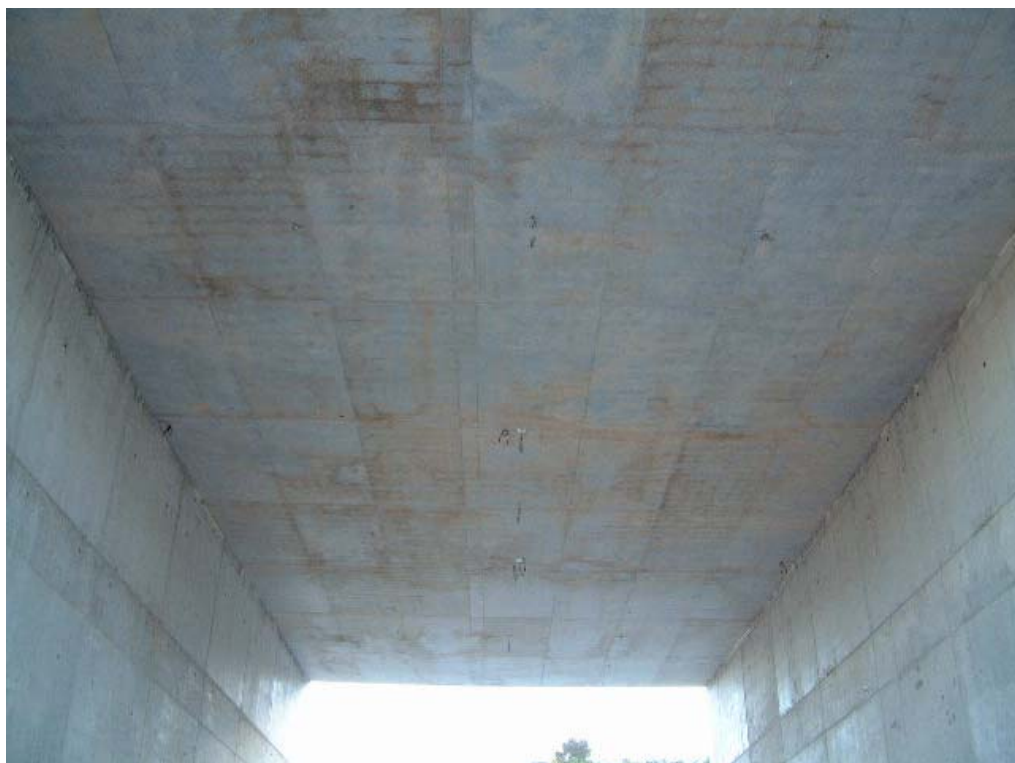
FOTOGRAFÍA N° 8: VISTA INFERIOR DEL TABLERO
