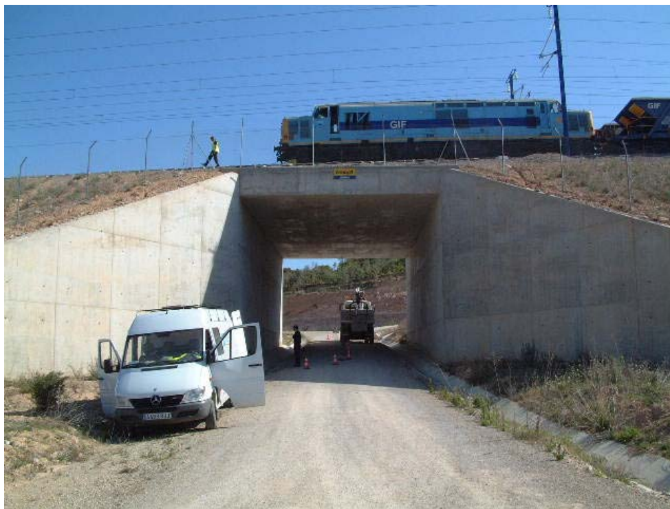
FOTOGRAFÍA 1: Vista general de la estructura
