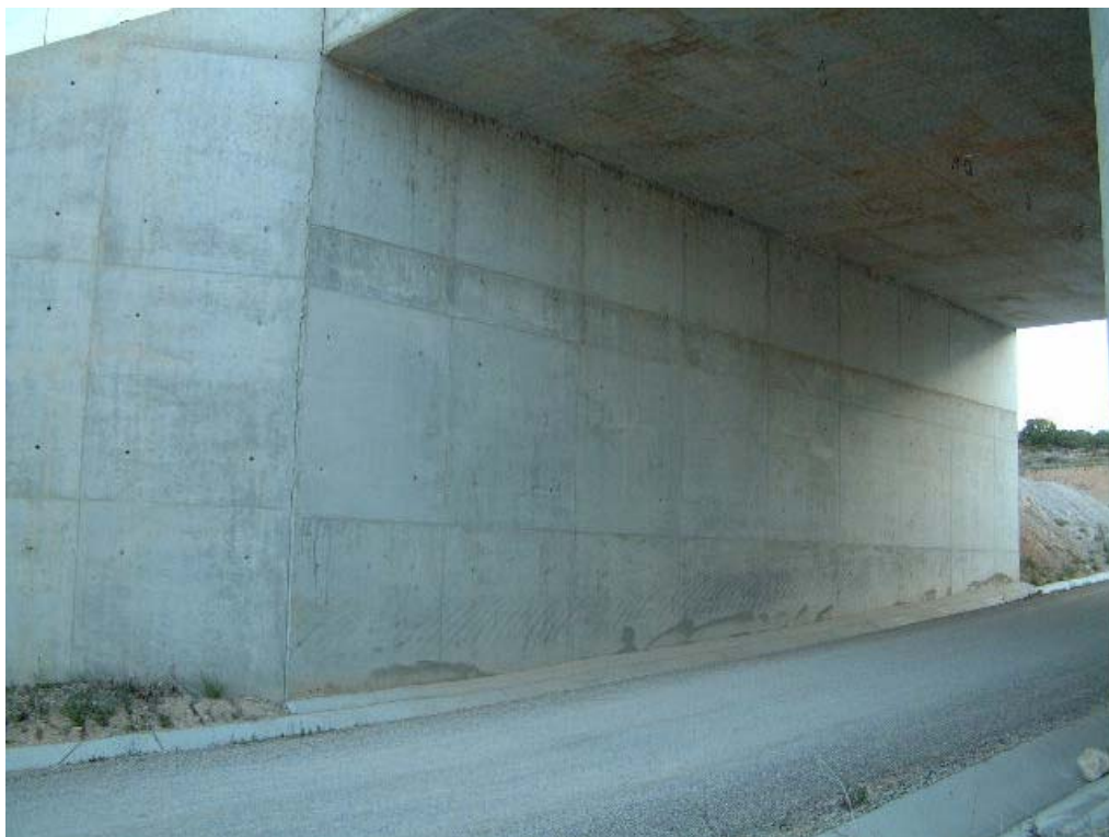
FOTOGRAFÍA N° 5: ESTRIBO DE ENTRADA
