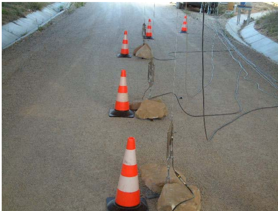
FOTOGRAFÍA 5: Transductores medida flecha
