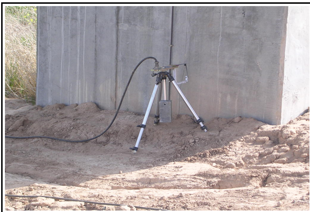
Foto 8: Detalle de ménsula para medida de descenso de apoyos
