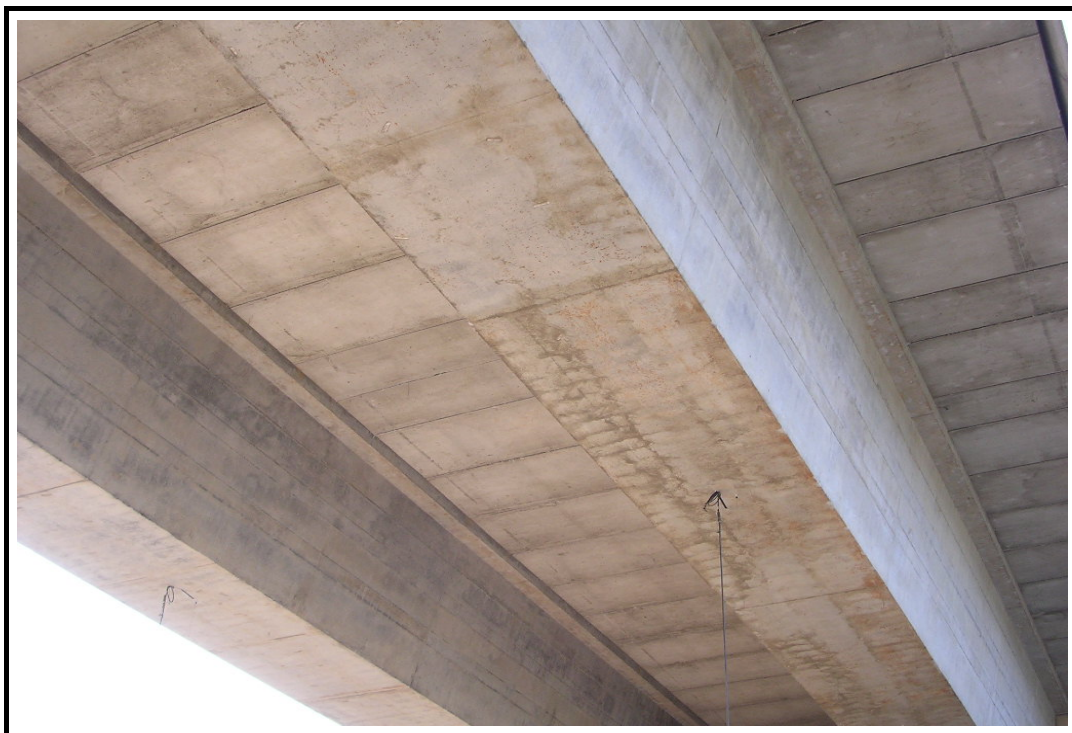
Foto 3: Vista inferior del tablero
