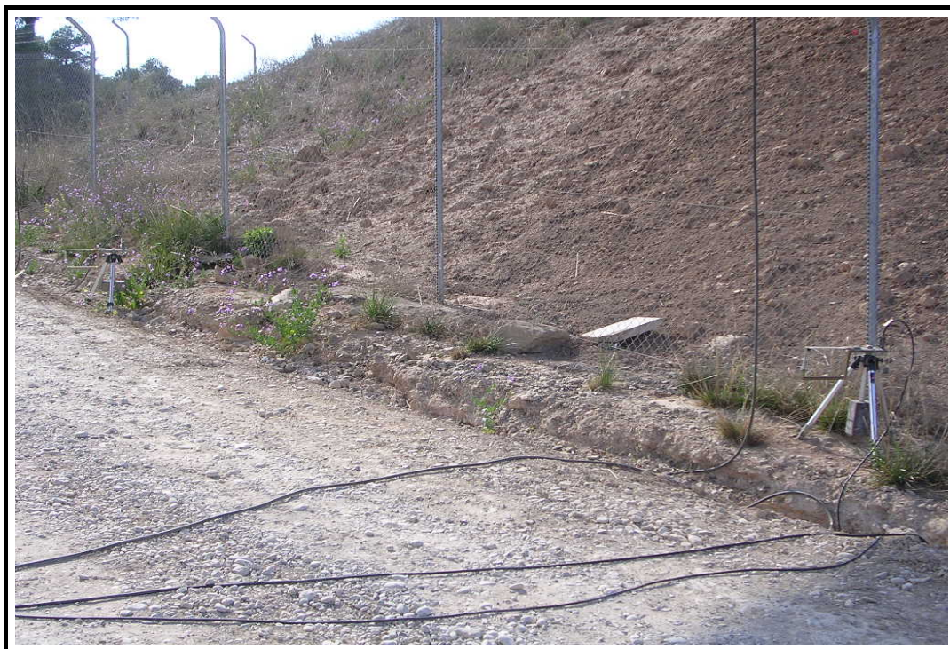
Foto 6: Línea de ménsulas para medida de flechas en centro de vano
