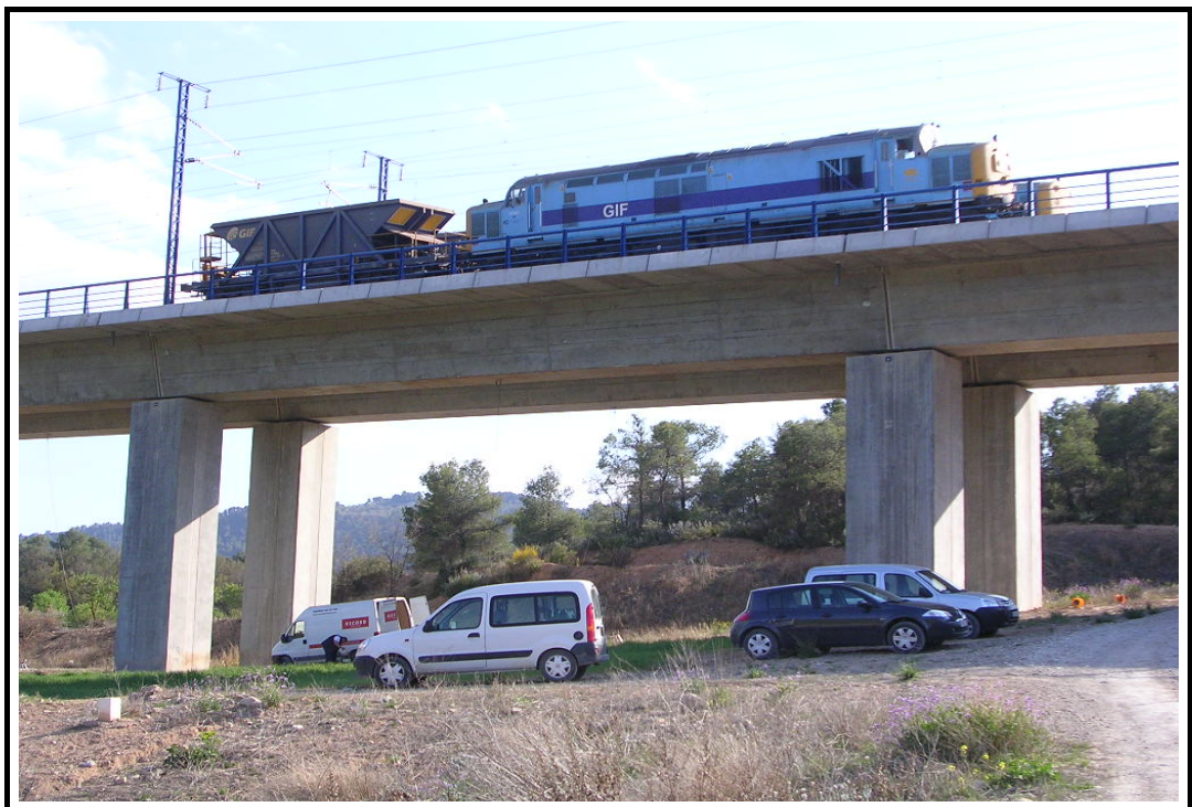
Foto 2: Vista superior de la estructura
