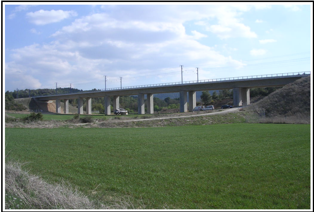
Foto 1: Vista general de la estructura
