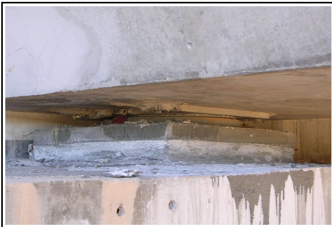
Foto 9: Detalle de apoyos
