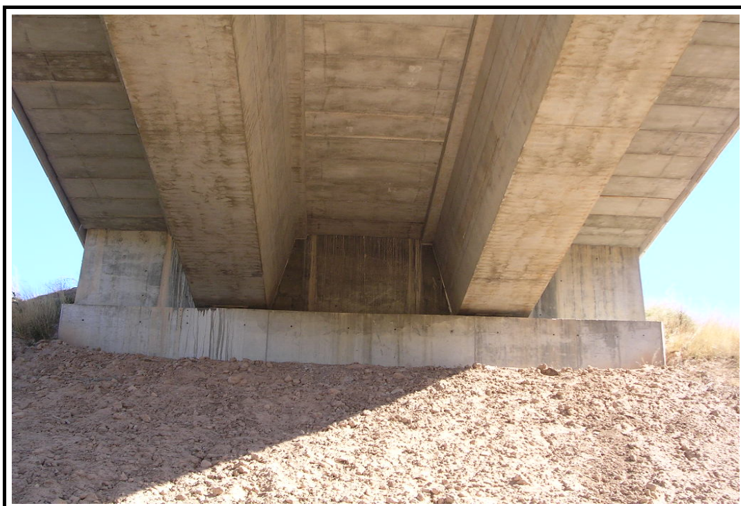
Foto 4: Estribo de salida
