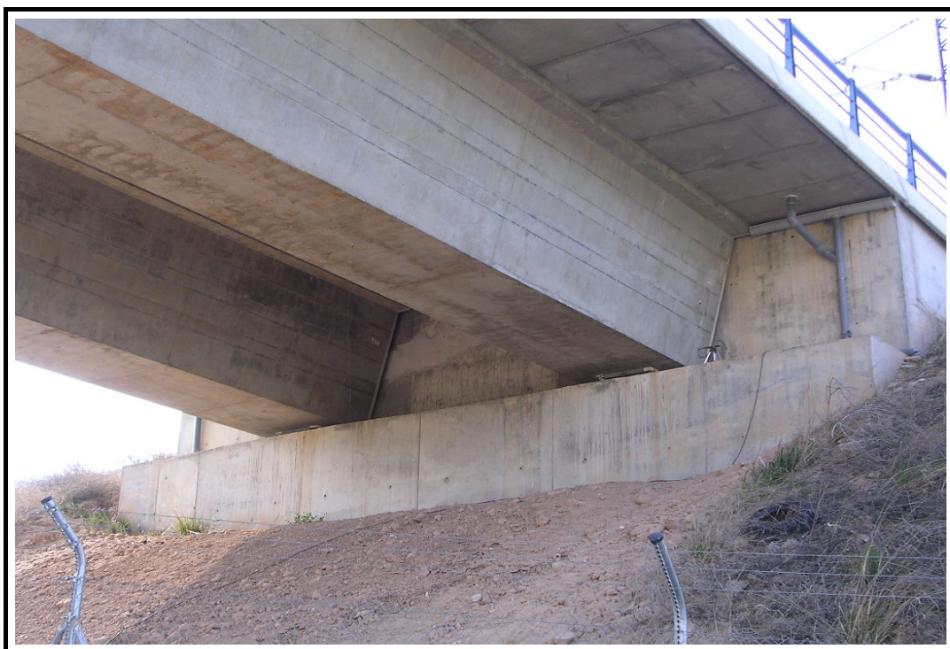
Foto 4: Vista general de estribo
